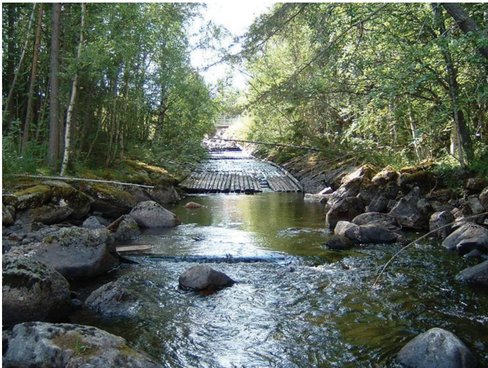
Figur 5. Slussgolv med tillhörande stenslänter i Arvåns 1:a distrikt mellan Övre-Nedre Arvträsket vilket även utgör vandringshinder idag. Foto Daniel Holmqvist
