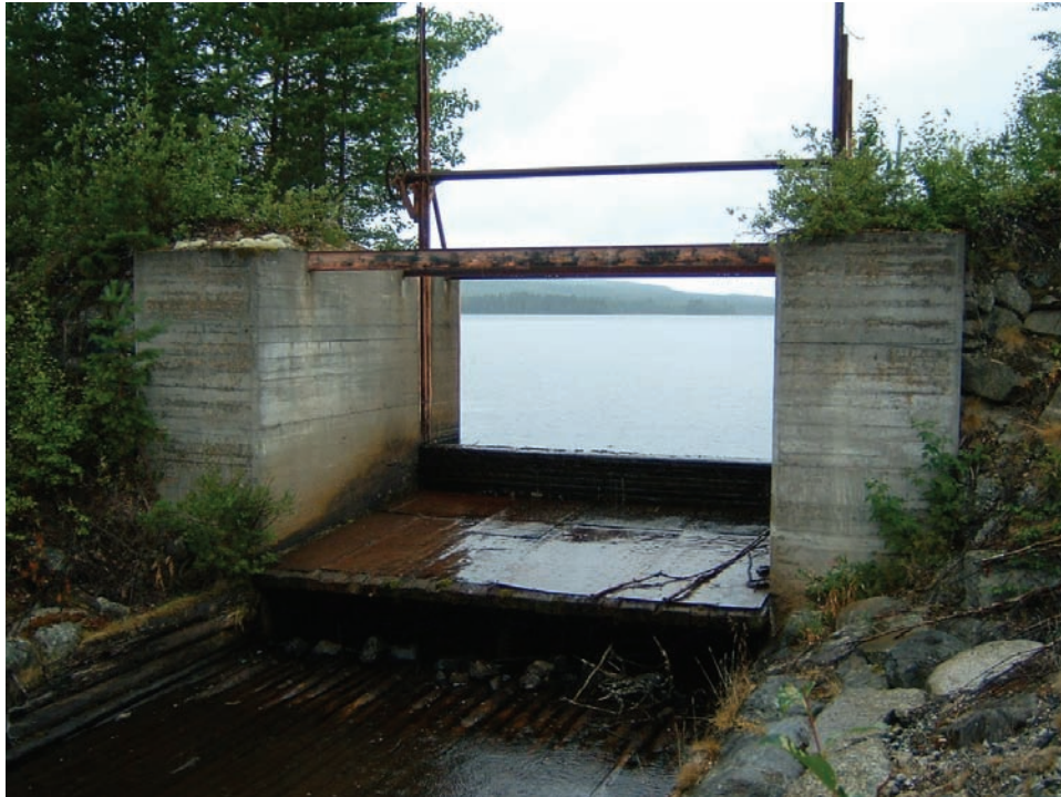
Figur 6. Flottledsdamm vid utloppet av Arvlidsjön som utgör definitivt vandringshinder för uppvandrande organismer. Foto Daniel Holmqvist
