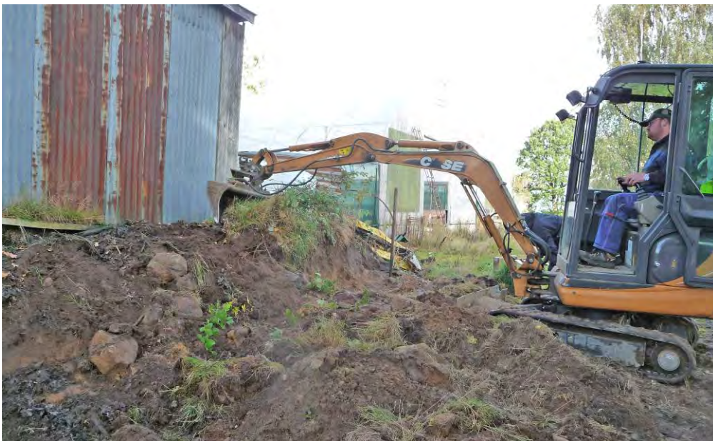
Figur 26. Delar av profilväggen togs bort med grävmaskin.
