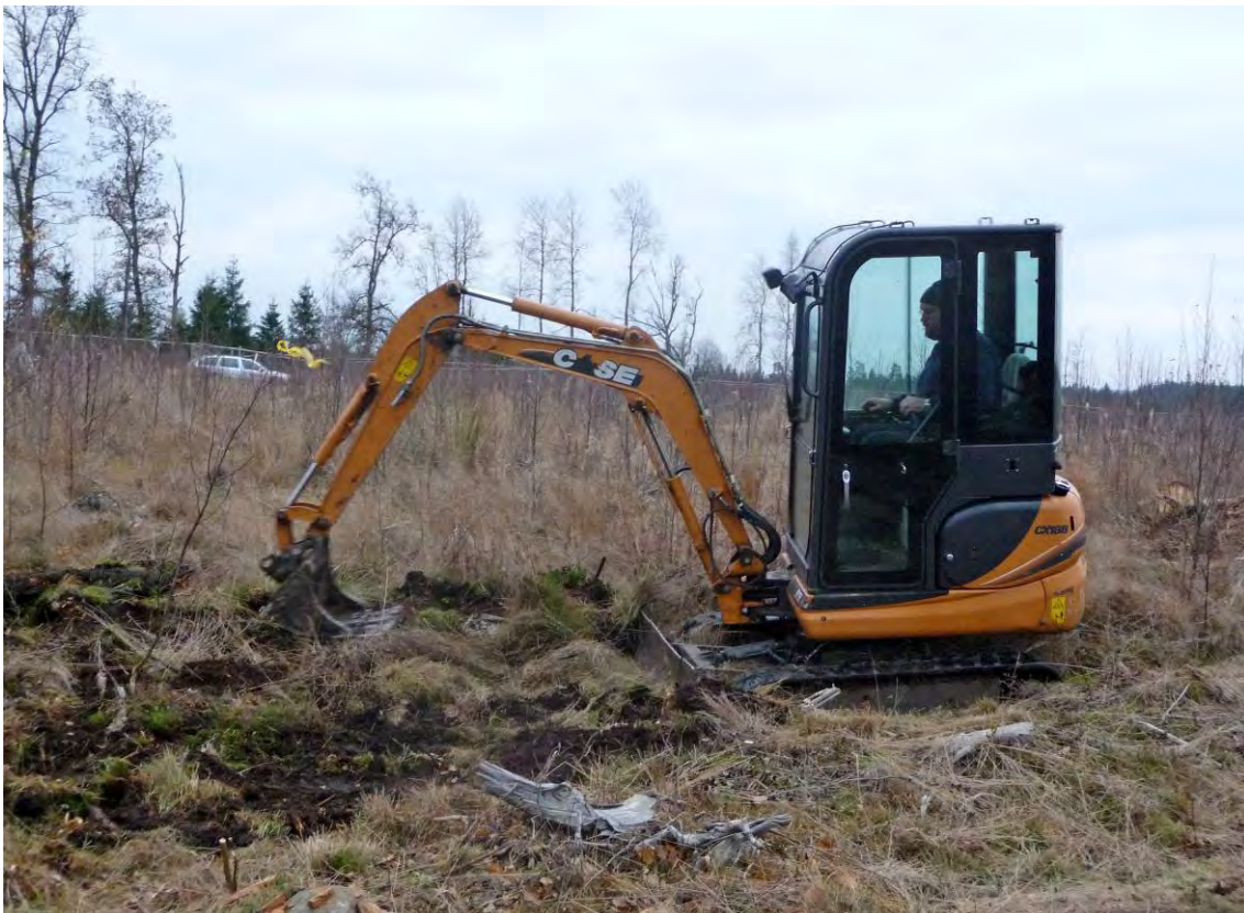
Figur 20. Markskador slätades ut med hjälp av grävmaskin.
