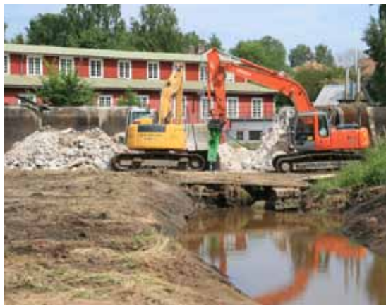
Dammen vid Spinnet i Hökesån. Utrivning pågår under sommaren 2010.
