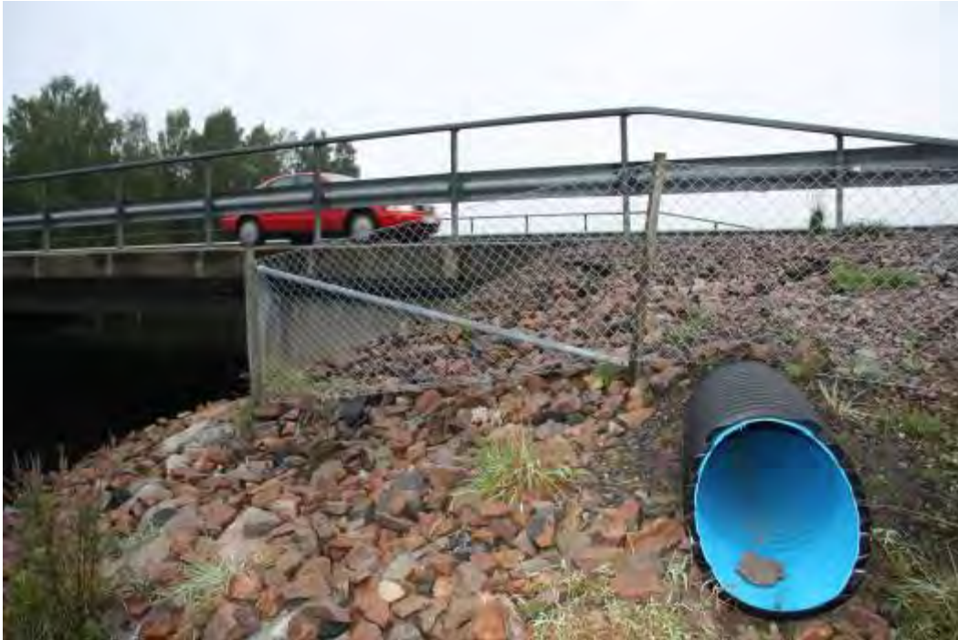
Bild 4: Anlagd torrtrumma i kombination med ett ledande finmaskigt stängsel vid Bolmån, Kronobergs län. Foto: Mia Bisther
