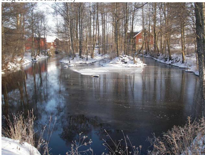
Figur 5. Nedströms dammen vid Lidboholm. I mitten skimtar torrfåran och på båda sidor om denna syns kraftverkskanalerna. Bilden är tagen från den nedströms liggande vägbron
