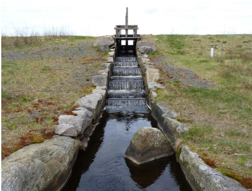
Figur 27. Fisktrappan vid Möllekulls damm.
