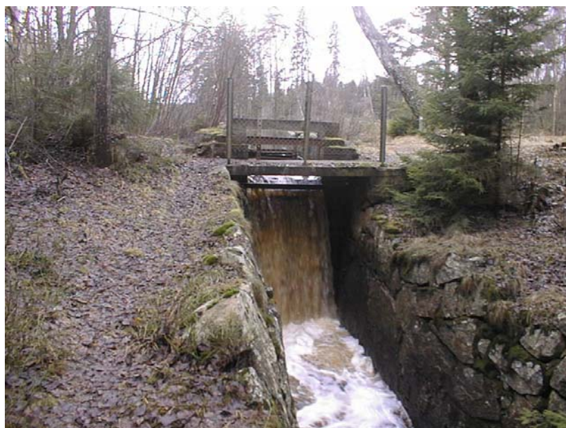
Figur 17. Regleringsanordning vid Drättingesjöns utlopp.
