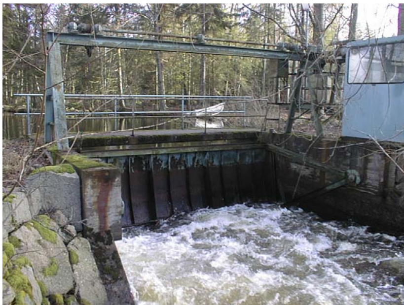
Figur 4. Det östra utskovet vid Madkrokens reglering.
