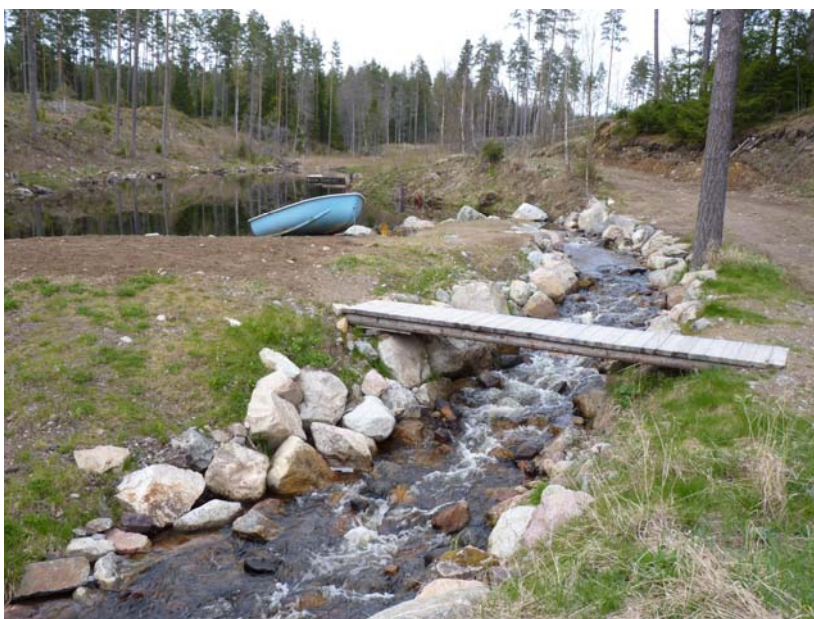
Figur 14. Dammen vid Sågen med det anlagda omlöpet.
