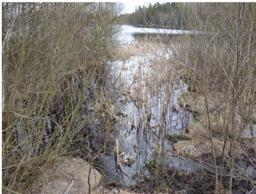
Figur 20. Igenväxningsproblematik i mynningsområdet nedströms vägtrumman.
