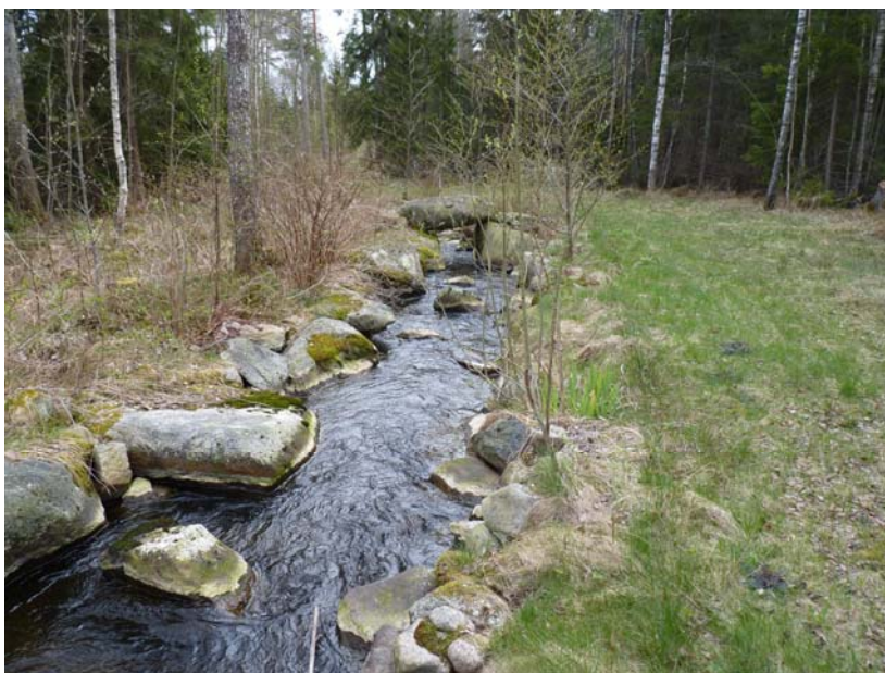
Figur 28. Omløpet som ansluter till fisktrappan vid Möllekulls damm.
