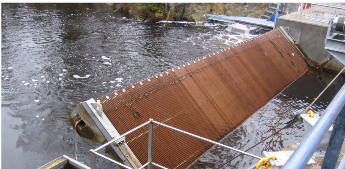
Figur 7. Justerbart fingaller i kompositmaterial med avledare och fångstanordning för utvandrande ål vid Granö kraftverk i Mörrumsån (foto: Niklas Nilsson, Jönköpings Fiskeribiologi AB).
