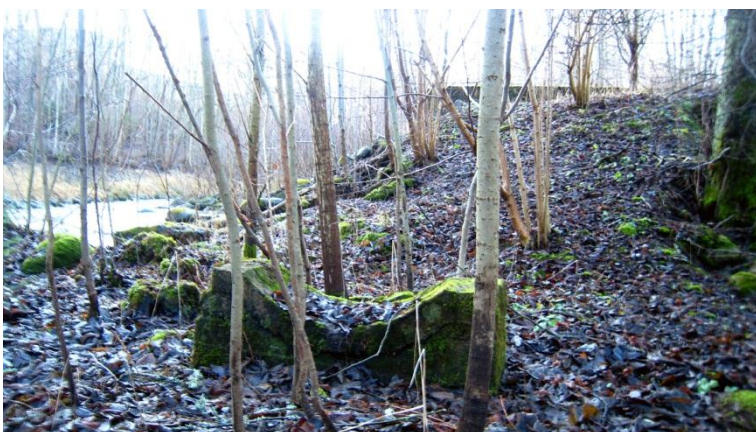
Betongvagg till vattentuben till laggkärlsfabrikens kraftstation. I bakgrunden skymtar rester av f.d. Laggaredammen i form av dammfäste på norra sidan av Hökesån. Foto från Ö.
