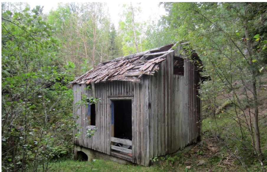
Karstorps f.d. kraftstation. Foto från NÖ.
