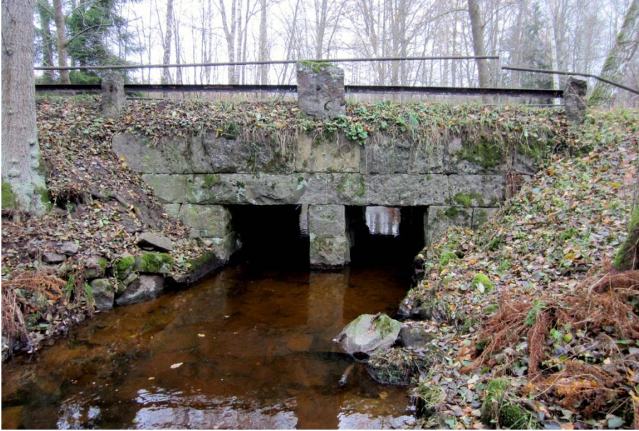
Stenbalksbro. Huggna granitstolpar för räcke. Bron troligen anlagd på 1870-talet. Bron med gamla landsvägen är i bruk idag som en mindre körväg till Kolaryd.
