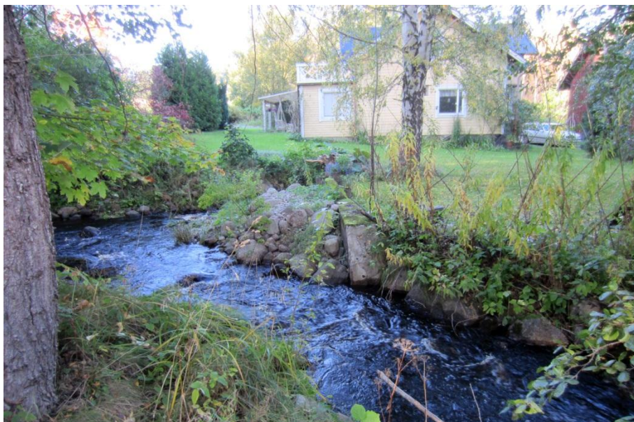
Utriven mindre damm vid Stensfors där ån delar sig i två grenar. Betongfundament på ömse sidor av åfåroma.
