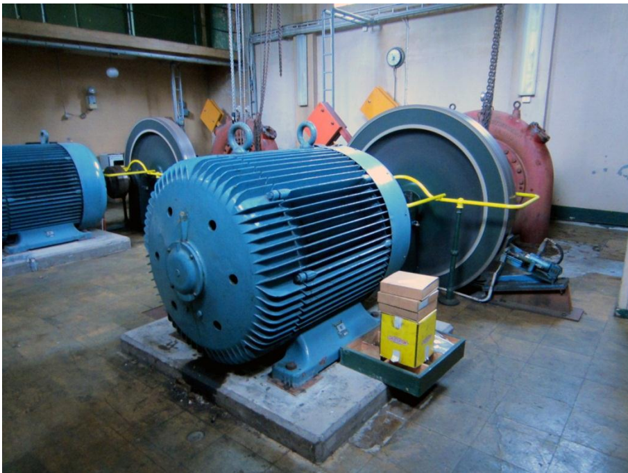
Två Francisturbiner i Hulebo kraftstation.
