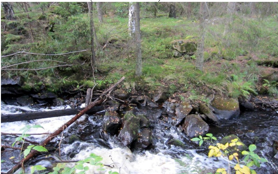
Rest av fördämningsmur. Foto från S.
