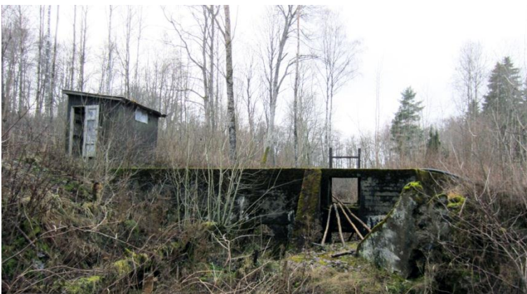
Lämningar efter fångstdamm till kraftstation och kvarn.
