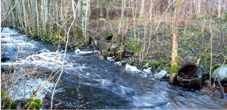
På norra sidan av Hökesån syns lämningar i form av betongrester efter kraftstationen till laggkärlsfabriken. Foto från SÖ.
