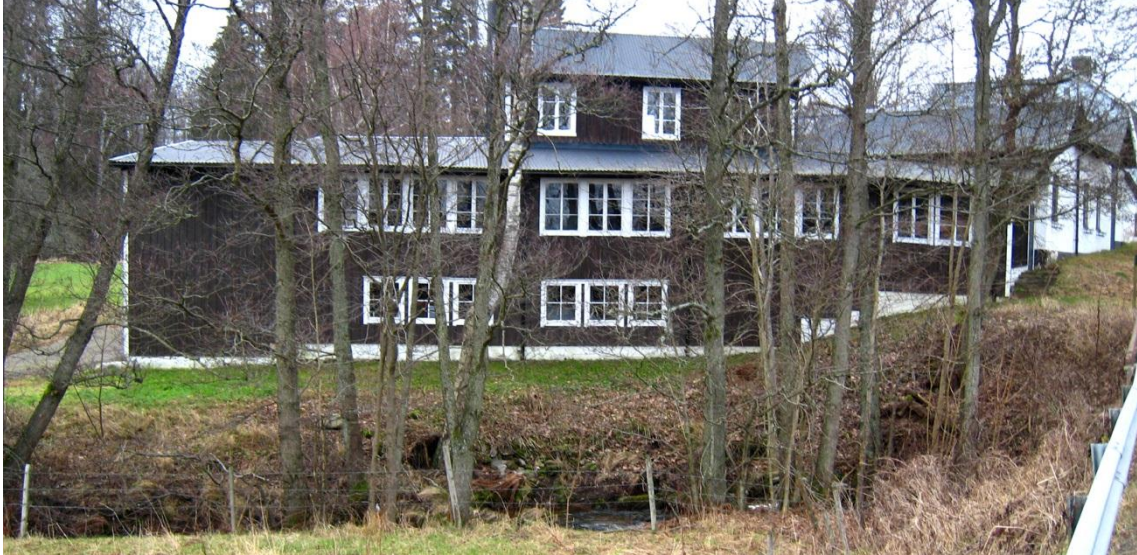
F.d. industribyggnader från epoken bröderna Miller vid Prinsfors. Foto 2012. Foto från S.
