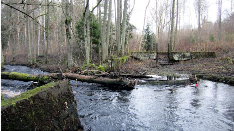
Hökesån. Rester efter betongfördämning för reglering av vattenintag in i ett ca 180 meter långt grävt dike som fört drivvatten till Stora Kärrs kvarn och kraftstation. Foto från SV
