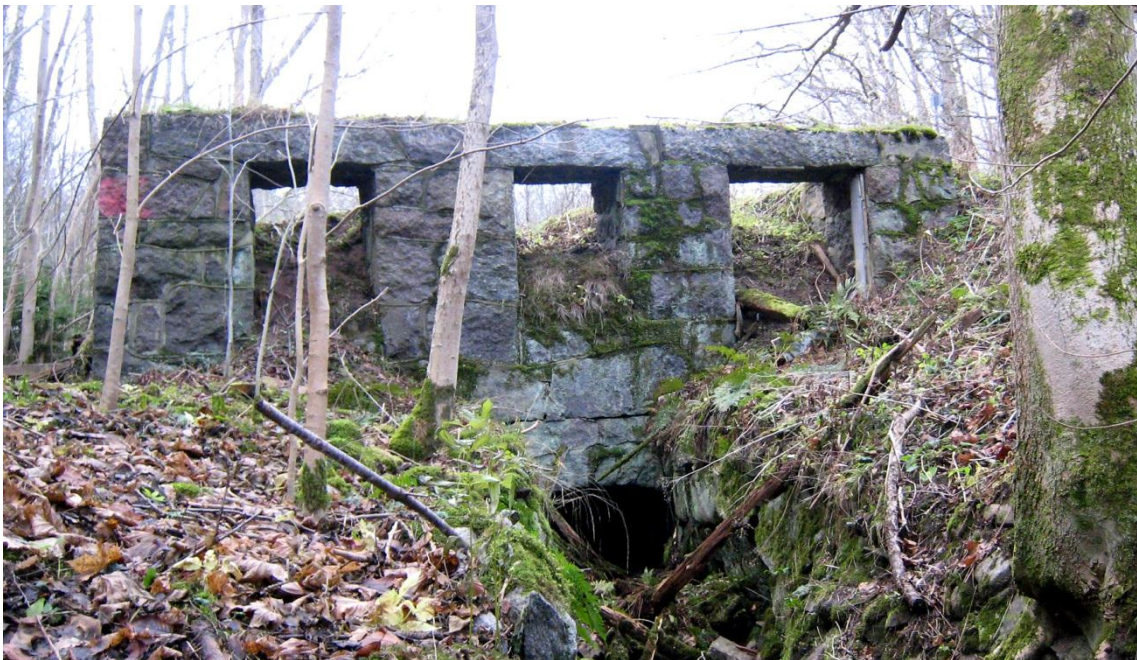
Ruinlämning efter Skänningsfors kvarn. Gavelsida mot Ö med utloppskanal. Väl utfört stenarbete, profilerade fogar. Foto från Ö.
