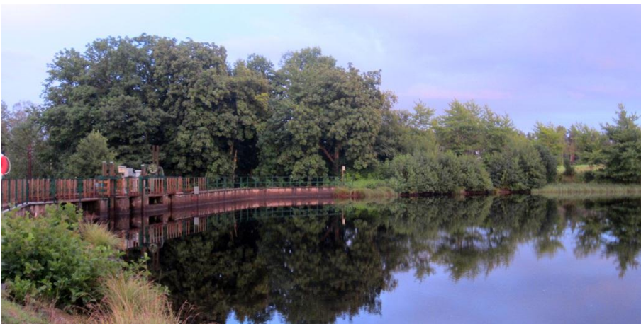
Lilla Klerebodammen/Hulebodammen. Vattenmagasin till Hulebo kraftstation. Foto från NV.
