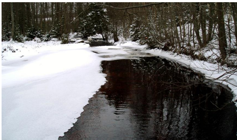
Källeäckens f.d. övre damm. Hornåns strömfåra. Dammen numera utriven i samband med fiskevårdsåtgärder. Foto från SÖ.
