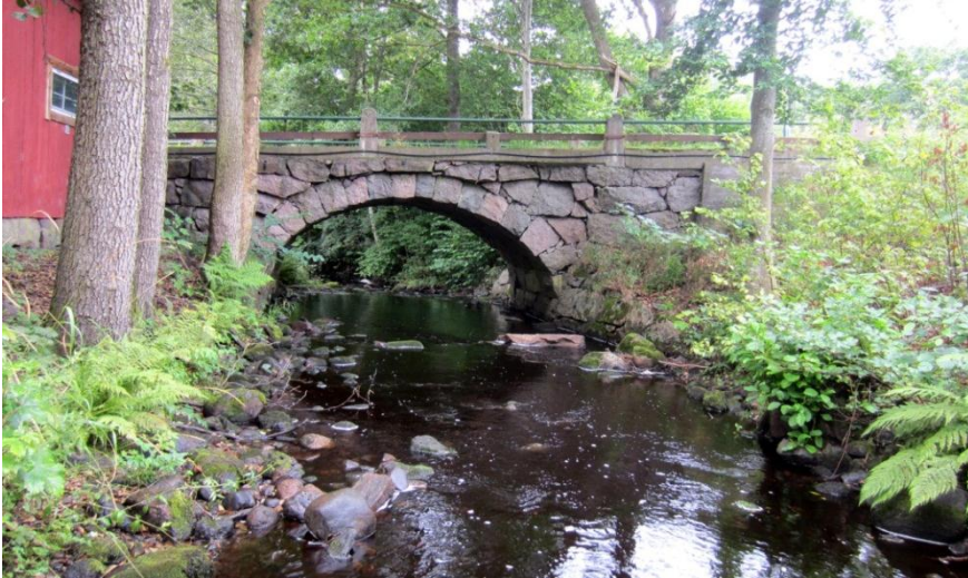
Stenvalvsbro över Domneån vid Aledal. Uppförd 1906, årtalet inhugget i slutstenen i valvet. Foto från Ö.
