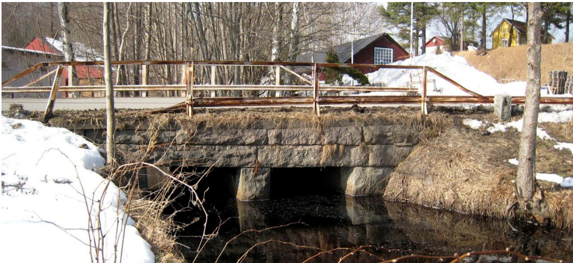
Stenbalksbro över Hornån strax nedströms gamla laggkärlsfabriken vid Källebacken vars byggnader skymtar i bakgrunden. Häröver går gamla landsvägssträckningen.
