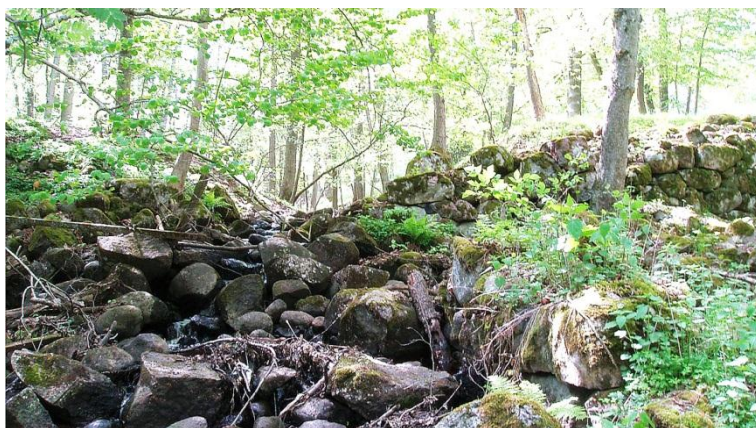
Fördämningmur till kvarn och såg vid Nykyrkebäcken. Fornlämning RAÄ Södra Fågelås 32. Foto från Ö.
