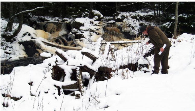
Hallefors småindustriområde med en del mekaniska detaljer under snötäcket. Foto från NÖ.
