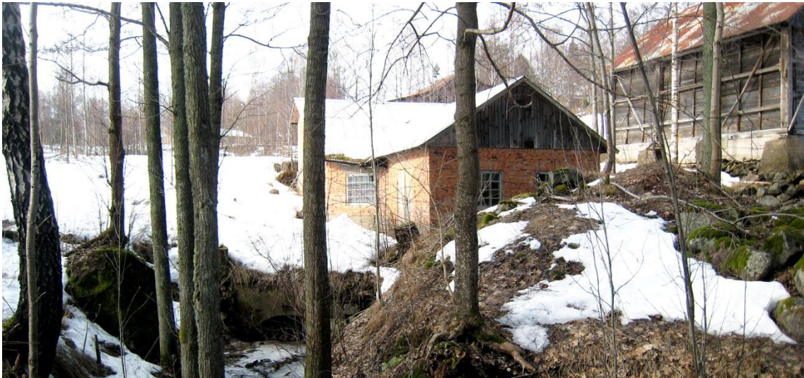
Kraftstationen vid Källebäcken. Foto från Ö. Dammiljön vid Källebäcken. I bakgrunden gamla laggkärlsfabriken. I förgrunden har järnslag påträffats efter den smedja som har varit förlagd längs ån sedan förmodligen 1600-talet. Foto från SÖ.
