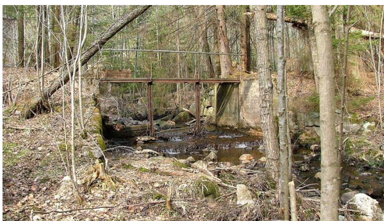
Utrangerad fördämning till Sibbatorpets kraftstation. Foto Leif Henriksson. Foto från S.
