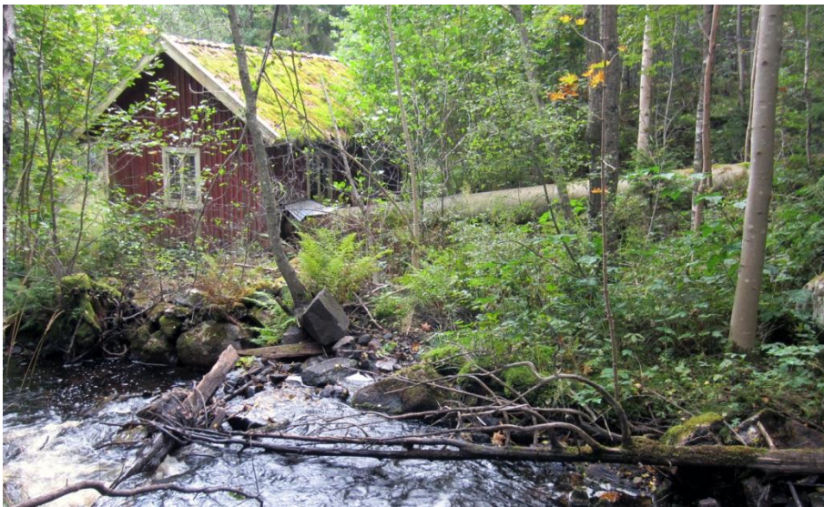
Inbäddad i grönska ligger Fagerhults kraftstation från 1920-talet. Foto från SSÖ.
