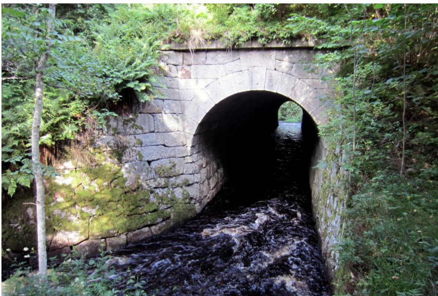
Järnvägsbron över Domneån vid Aledal.
