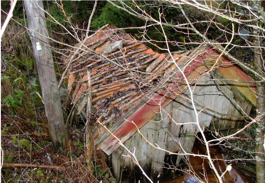
Alunda kraftstation vid Pirkåsadammen.
