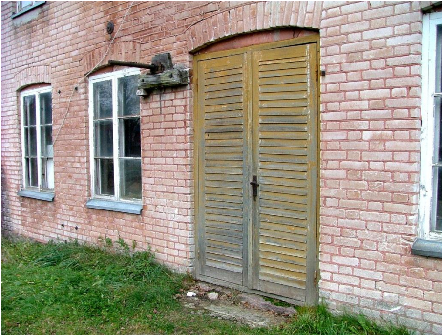
Kvills gamla träsnickerifabrik. Vid ingången sitter axeltapp till axelledning.
