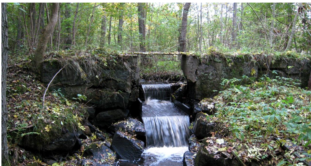
Fördämningsmur av huggen kvadersten, förstärkt med betong. Härifrån reglerades Skämningsforsåns vattenflöde till Skämningsfors kvarn. Troligtvis har här funnits en dammanläggning redan på 1600-talet varifrån vatten reglerades till kvarn och såg nedströms. Dammen är numera tömd i samband med fiskevårdsåtgärder och ån har i stort sett återgått till sin naturliga fåra. Foto från Ö.
