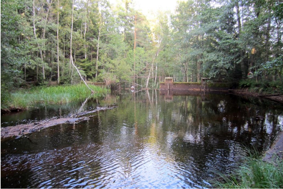
Regleringsdammen till Fagerhults kraftstation. Fördämningsmur i betong. Inga dammluckor i funktion. Dammen är nu självreglerande. Foto från NV.
