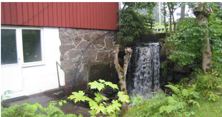
Vattenhjulsrännan på norra sidan av den f.d. kvarnbyggnaden. Foto från Ö.
