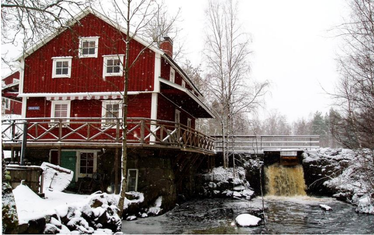
Julareds kvarn, ombyggd till bostadshus. Foto från SÖ.
