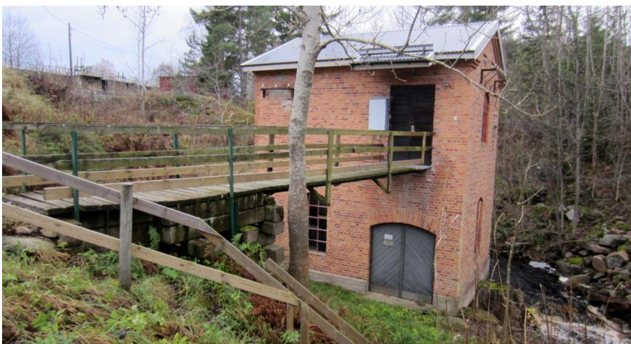
Klerebo kraftstation. Tegelbyggnad i två våningar. Den tornliknande byggnaden är väl anpassad till den branta terrängen. Upp till vänster (SV) i bild skimtar fördämningen till Klerebodammen. Foto från Ö.
