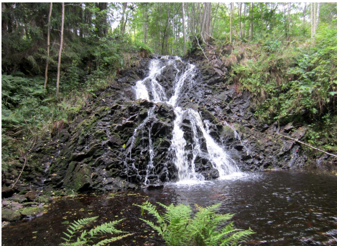
Det sköna Sågfallet vid Kvarnliden, dock i reglerad form, då Gagnåns vatten här nyttjas som drivvatten till Sågfallets kraftstation. Här nedanför fallet har i äldre tider funnits flera kvarnar, senare också sågkvarn med snickeri för tillverkning av pinnstolar och senare laggkärl. Foto från SÖ.
