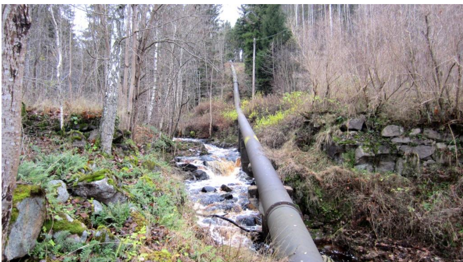
På ömse sidor av vattentuben är rester efter fördämningsmur i tuktad granitsten till Hulebo kvarn. Tuben leder drivvatten, 74 meters fallhöjd, från Lilla Klerebodammen/Hulebodammen till Hulebo kraftstation. Foto från Ö.
