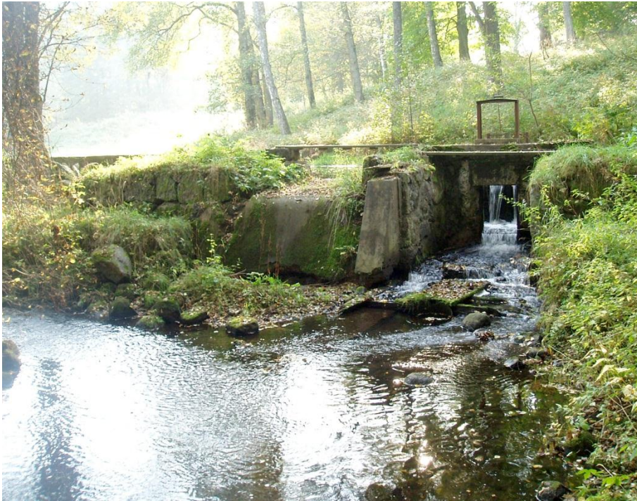
Fördämning till f.d. kvarnen som funnits här till Månseryd. Dammen är idag självreglerande. Foto fr. N.
