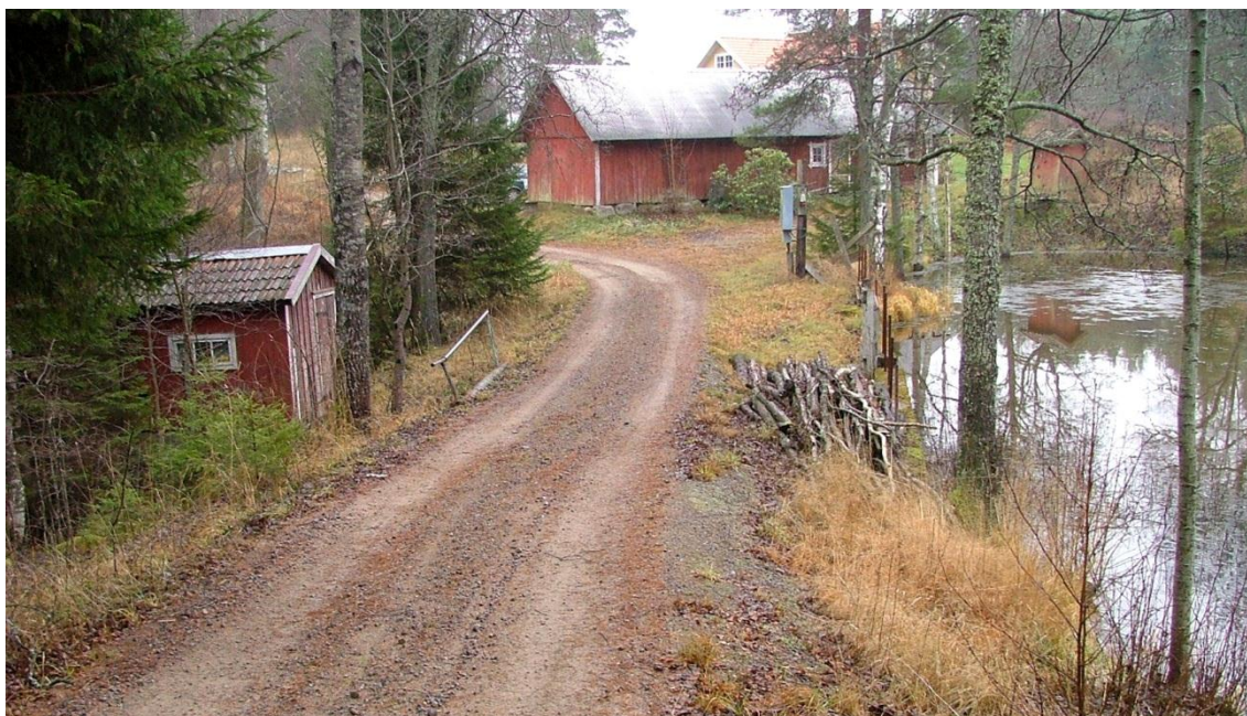
Pirkåsadammen och kraftstationsanläggningen f.d. Alunda/Pirkåsadammens elkraftverk. Foto från V.
