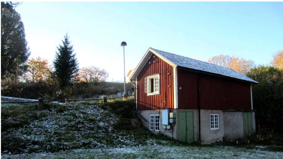
Aledals kraftstation. Ståltuben som leder drivvattnet skymtar till vänster i bild. Foto från S.
