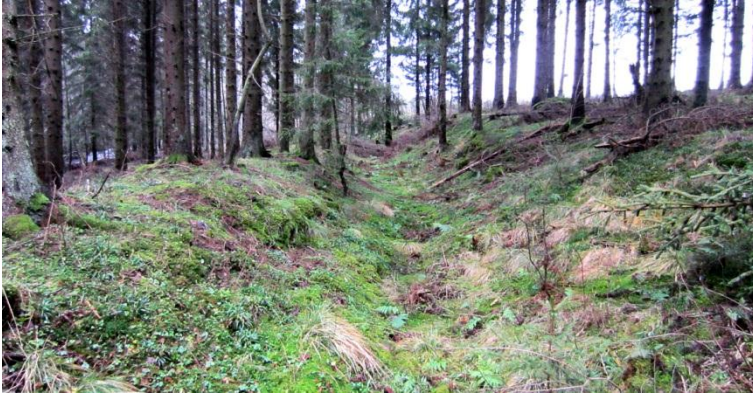
Grävt dike, drygt 250 meter lång har lett drivvatten till Tubbereds kvarn m.m. från Hökesån. Foto från SV.
