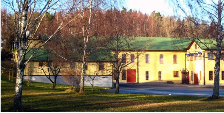
Kulturhistoriskt värdefulla industribyggnader från tiden med AB Svenska Naxos. I huvudsak härrör byggnaderna från tiden 1920–1930-talen. Foto från SÖ.
