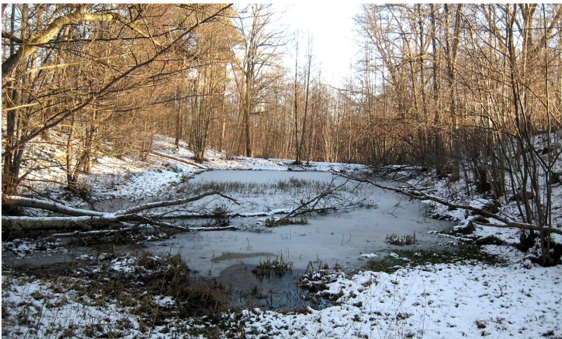
Dammanläggning med anor från 1600-talet i herrgårdsparken till Skänningfors. Foto från V.
