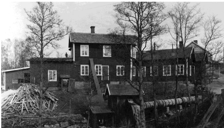
Bröderna Millers metallvarufabrik, grundad 1903. På bilden syns industribyggnad och vattentub. Arkivbild. Foto från Boken om Bankeryd av Bill Landén, 2006.
