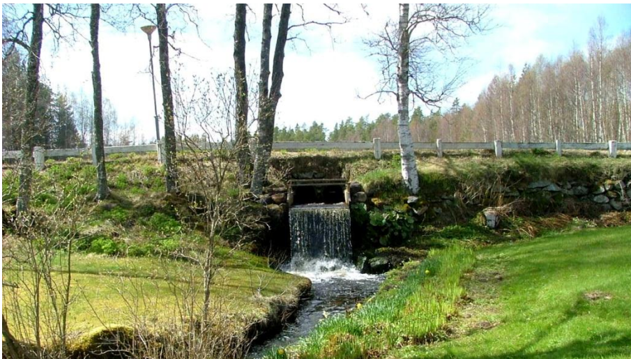
Kopparhults dammfall. Foto Leif Henriksson. Foto från SÖ.
