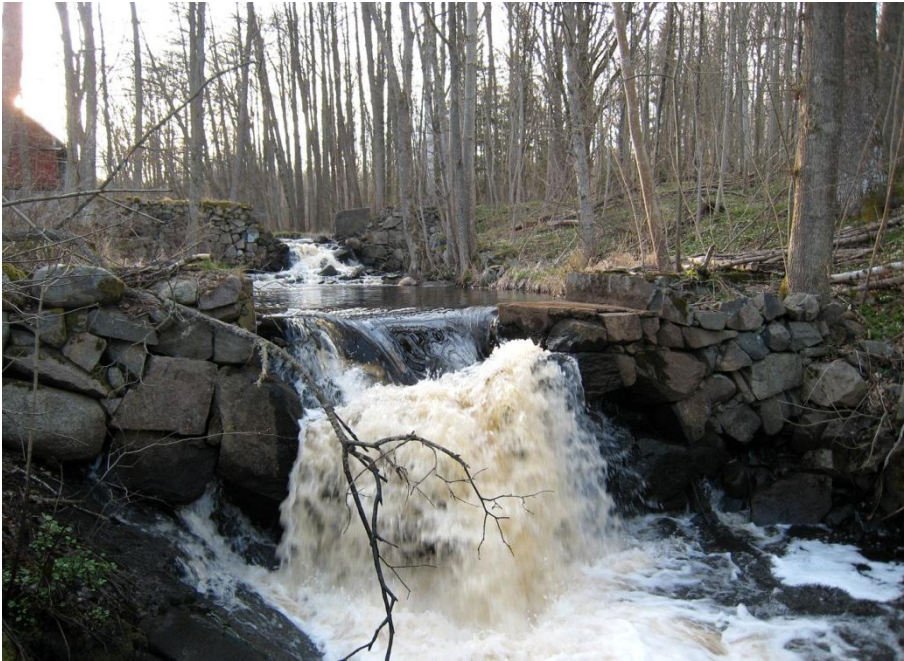
Två nivådammar med fördämningsmurar av tuktad sten i Knipån vid Kvarnekulla. Foto från Ö.
