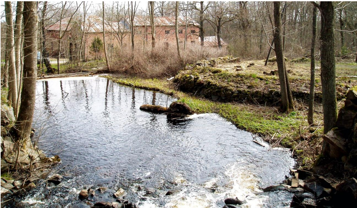
Damm vid fallnacken vid Kvarnekulla. I bakgrunden skymtar den kvarvarande industribyggnaden till Habo Trämassefabrik. Delar av byggnaderna återuppfördes efter en brand 1916. Foto från V.
