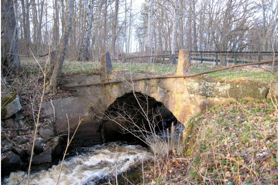
Stenvalsbro över Knipån vid Kvarnekulla. Räckeståndare av huggen sten. Här över gick gamla landsvägen. Foto från Ö.
