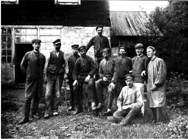
Alefors saxfabrik. Äldsta industribyggnaden från 1882 som nu finns att beskåda som välvårdad ruinlämning (RAÄ Bankeryd 152). Till höger om huvudbyggnaden syns en mindre tillbyggnad som inrymde vattenhjulet. Foto: Från Boken om Bankeryd av Bill Landén, 2006. Alla personer på bilden finns namngivna i Landéns bok.
