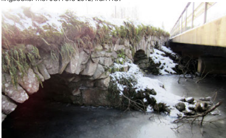
Kungsbro mot nordväst dold för vägfarande av nuvarande vägbro. Foto 2012, från NNÖ.
