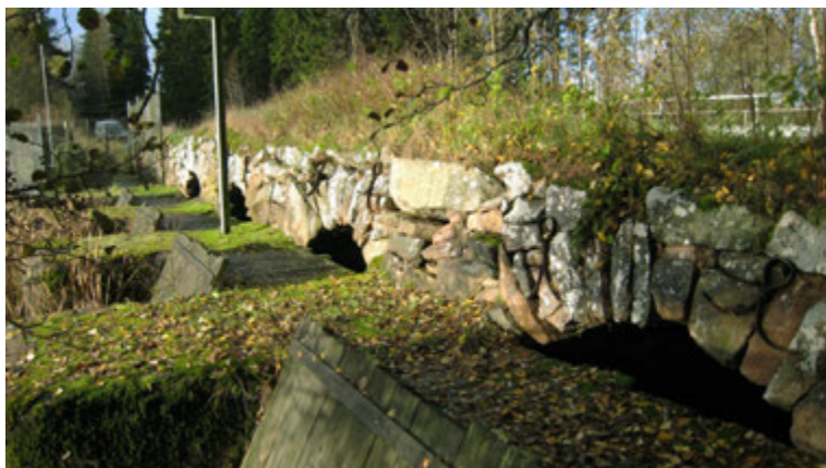
Kungsbro vid sjön Ylens utlopp i Huskvarnaån. Stenvalvsbro med ursprungligen sex spann. Förbyggd med regleringsluckor mot SÖ. Foto 2012, från NÖ.
