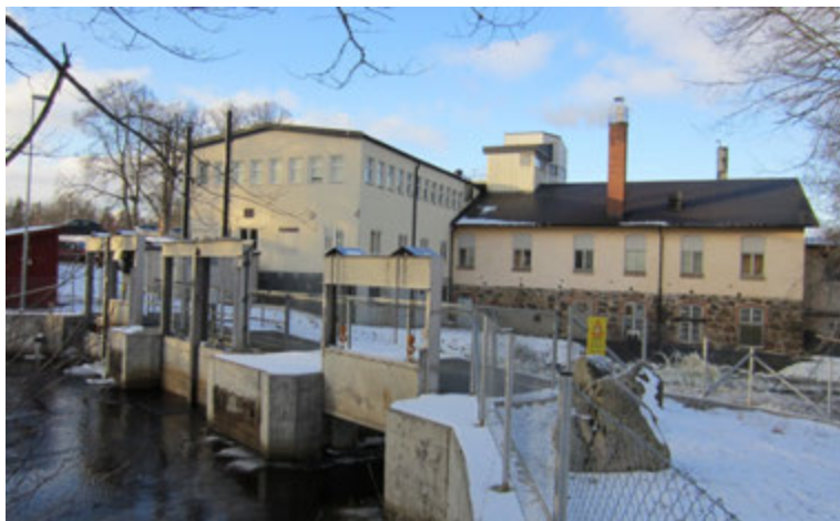
Regleringsdammen vid Stensholm. Ingen elkraftsutvinning förekommer idag vid Stensholms Bruk. Fördämningen byggdes om till nuvarande utseende med nya luckor och automatreglering omkring år 2008. Dammen regleras av Jönköping Energi. Foto 2012, från Ö.
