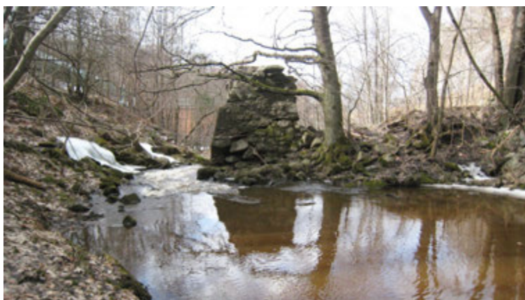
Rest av fördämning i Huskvarnaån, strax Ö om och uppströms Ebbes kraftstation. Foto 2011, från Ö.
