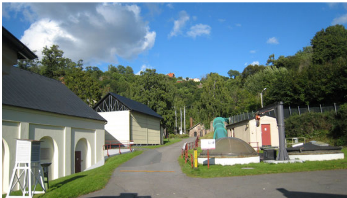
Huskvarna kraftstation uppförd 1968–1969 för Husqvarna AB. Sedan 1979 ägd av Jönköping Energi. Fallhöjden från Ebbesdammen är 116 meter. Drivvattnet förs via en i berget sprängd bergtunnel och vidare i ståltub till aggregaten under jord. Driften sköts från en separat byggnad ovan mark. Foto från V.
