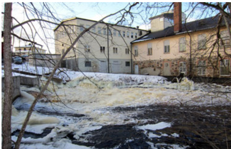
Stensholm. I stenfoten är byggnadssten som antas ha förts hit som byggnadsmaterial från det närbelägna – på motsatt sida av Huskvarnaån – medeltida Stensholm. Foto 2012, från NÖ.
