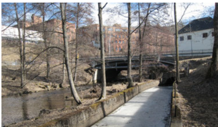
Utlopp för drivvattnet från gamla kraftstationen. Foto 2011, från SV.
