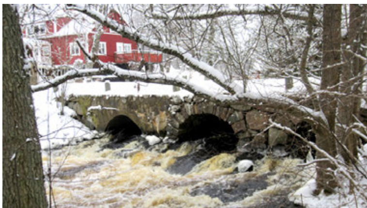
Stenvalvsbro med tre spann över Huskvarnaån vid Ramsjöholm. Foto från SÖ.
