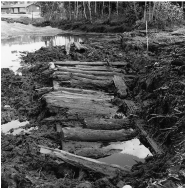
Medeltida kavelbro som framkom i samband med schaktningsarbeten år 1964 i det s.k. "Tippenkärret" på Huskvarnaåns norra sida. Foto Jm 90/2: 2570.
