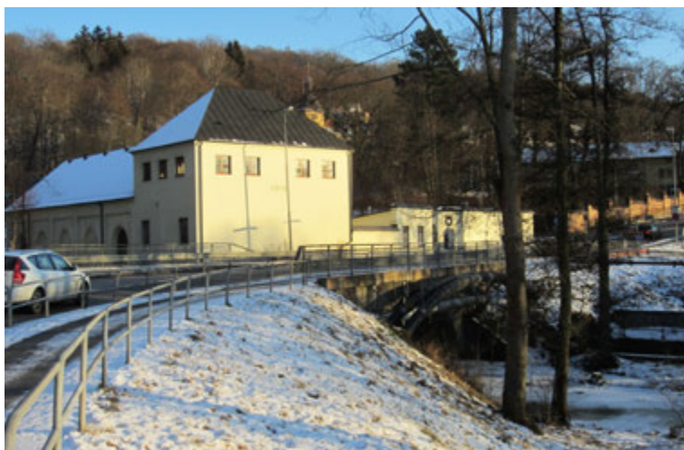
Husqvarna kraftstation 1914 -1969. Foto 2012, från NV.
