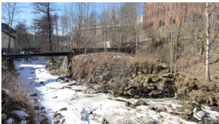
Stenfundament och murlämningar längs Huskvarnaån vid Fabrikmuseet. Foto från Ö.
