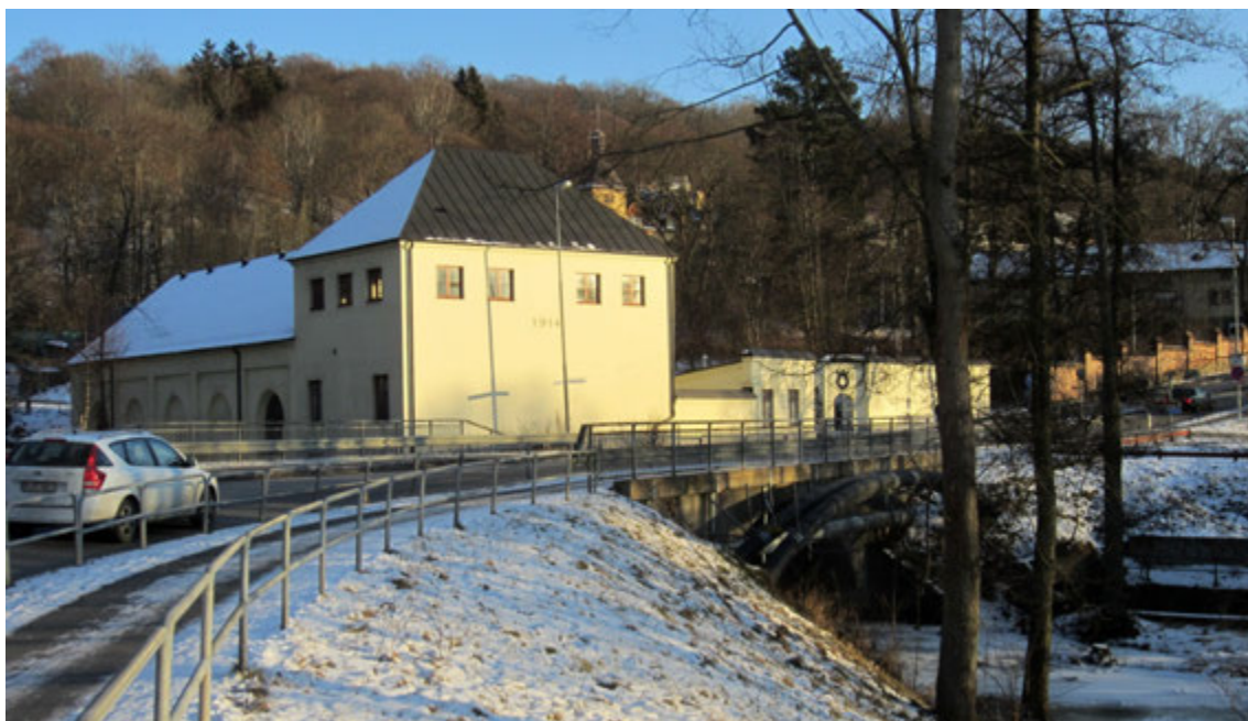
Husqvarna Vapenfabriks kraftstation från 1914. Foto från NV.
