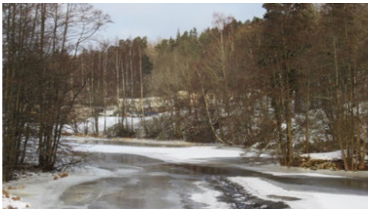
Brofästen, utskjutande brofästen efter gamla vägbron på ömse sidor av ån, 60 meter nedströms Hakarpsvägen och nuvarande bro över Huskvarnaån. Foto 2012, från S.
