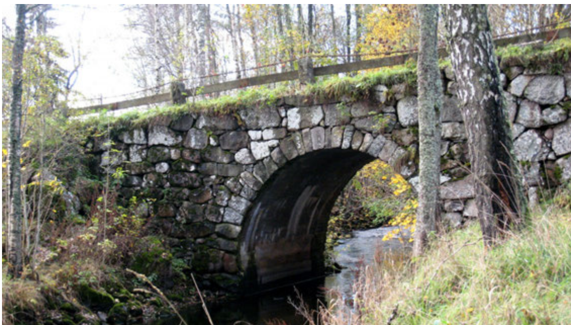
Restaurerad stenvalvsbro vid Strömsholm. Foto från NÖ.
