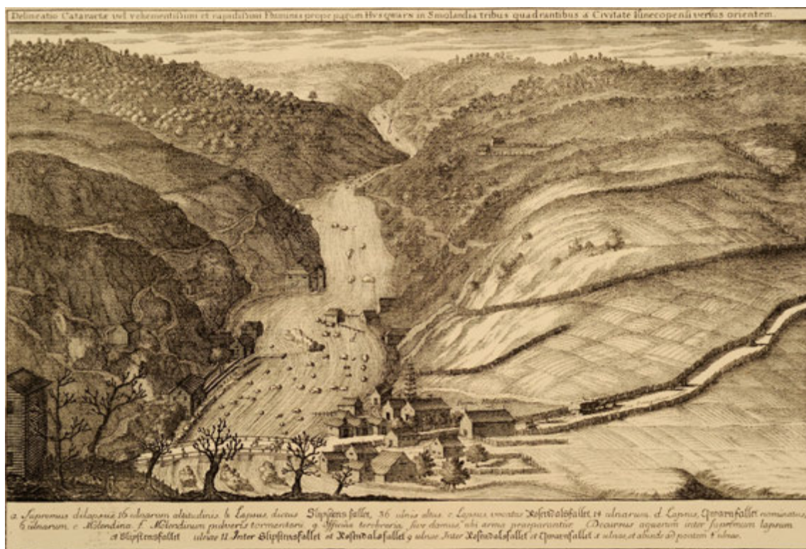
Kopparstick, Erik Dahlbergs Suecia Antiqua. Tryckt 1708. "Fallen eller den häftigt forsande floden vid byn Huskvarna i Småland tre fjärdedels mil öster om staden Jönköping". a) översta fallet, 16 alnar högt; b) det s.k. Slipstensfallet, 36 alnar högt; c) ett fall, som benämnes Rosendalsfallet, 14 alnar; d) kvarnfallet, 6 alnar; e) kvarnar (molendina); f) krutstampkvarnen (molendina pulveris tormentarii); g) borrhuket. Vattenloppet mellan översta fallet och Slipstensfallet är 11 alnar; mellan detta och Rosendalsfallet är 9 alnar och mellan det sistnämnda och Kvarnfallet 5 alnar. Därifrån till bron 4 (?) alnar. 64
