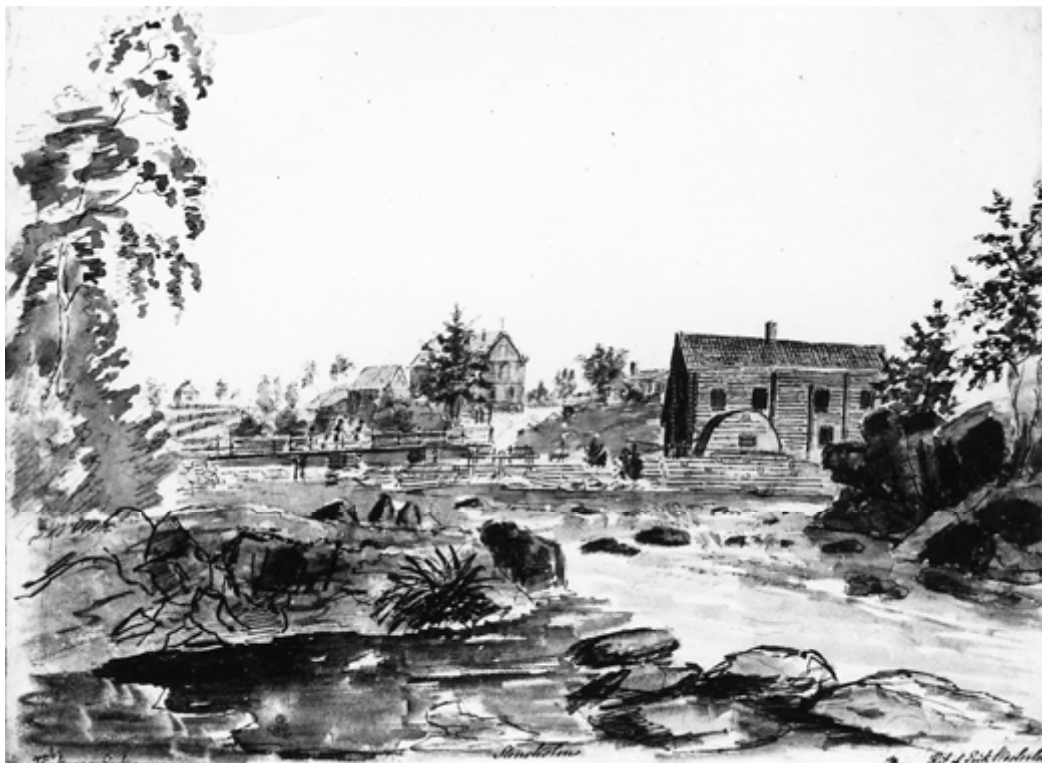
Stensholms pappersbruk på 1800-talet. Det stora vattenhjulet drev industrins maskiner genom remdrift. Tuschlavering av Erik Westerling. Arkivbild, Jm 86/1:434. Original: Uppsala universitetsbibliotek.
