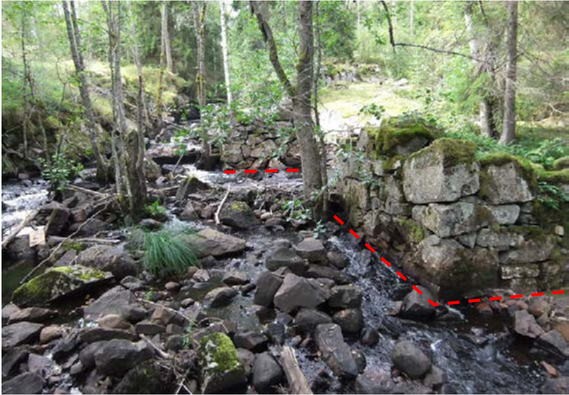
Figur 25. Bruzaån 3. Stenfötter väster om kvarngrunden som uppburit träränna fram till kvarnen. Markerade med streckade linjer. Foto taget mot väst.
