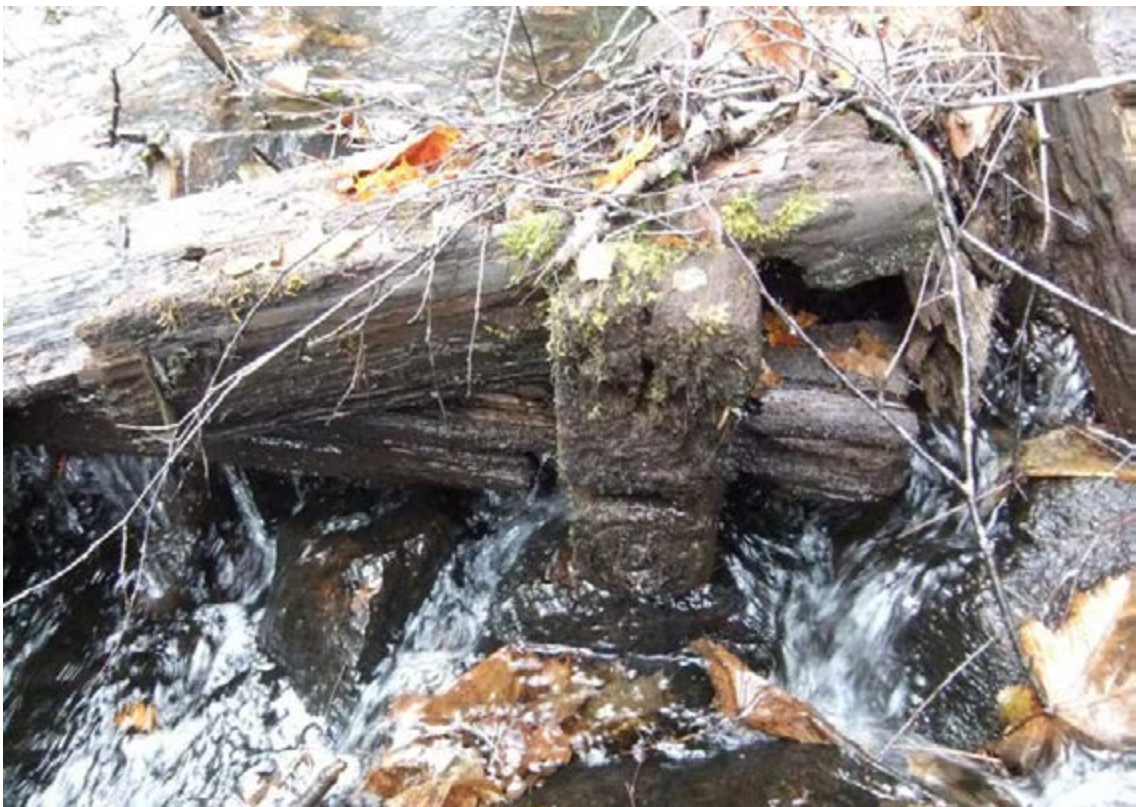
Figur 290. Detalj på ålkistans nordöstra hörn. Fotot är taget från östsydöst.
