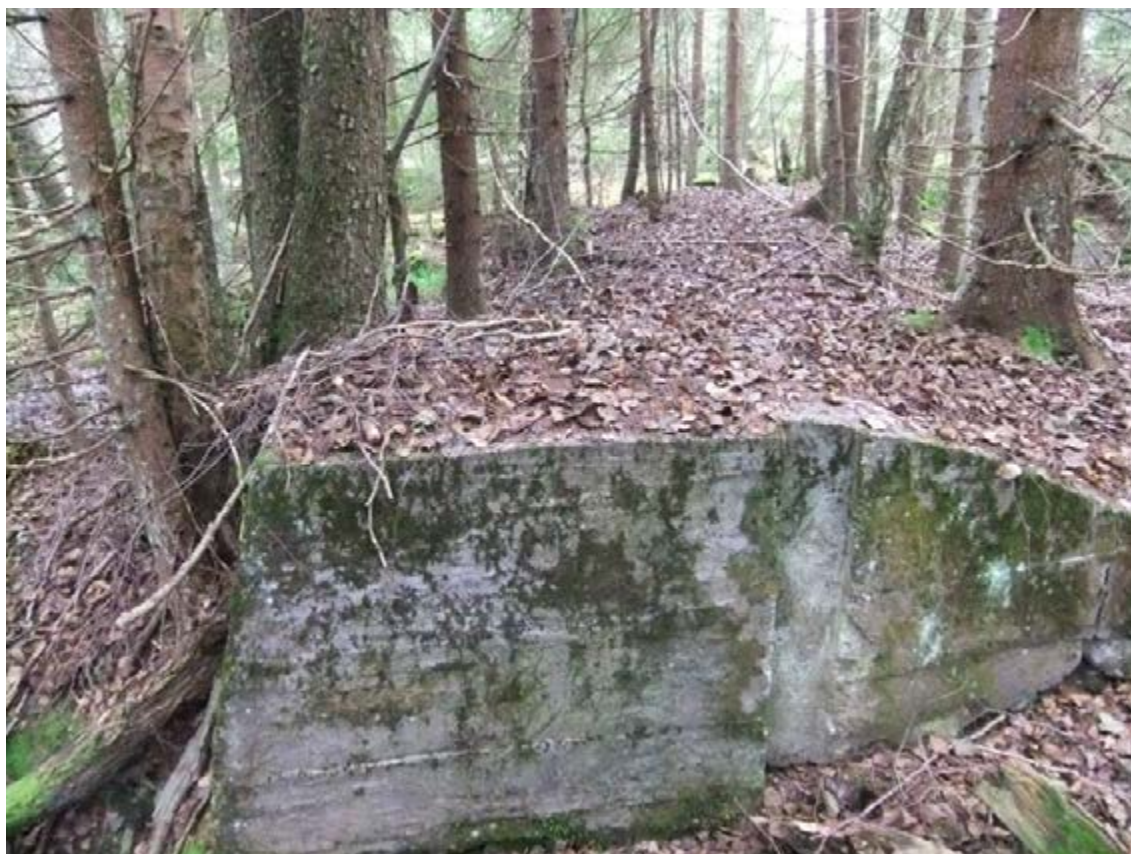
Figur 282. Gnyltån 1, regleringsdammen sedd från utskovet och längs dammvallen västerut. Ett mindre breddutskov finns i dammvallens västra del. Fotot är taget från sydsydöst.
