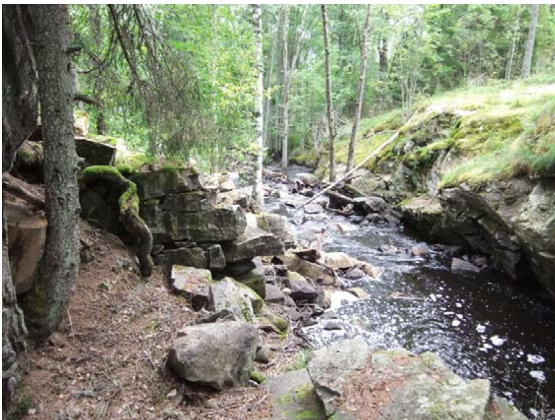
Figur 29. Bruzaån 3. Den södra delen av dammvallen, raserad där dammluckan satt. Idag finns timmerrester kvar och utgör en tröskel/vandringshinder för öring m m. Foto taget mot öst.
