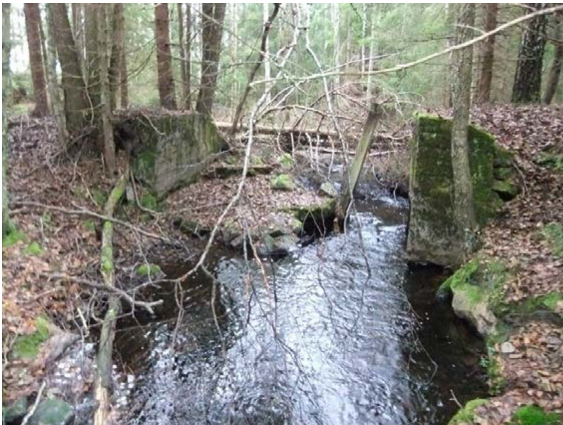
Figur 281. Gnyltån 1, regleringsdammen tillhörande kraftstationen vid Vedermödan. Anläggningen byggdes i början av 1920-talet. Här det centrala utskovet i betong. Fotot är taget från sydsydöst.
