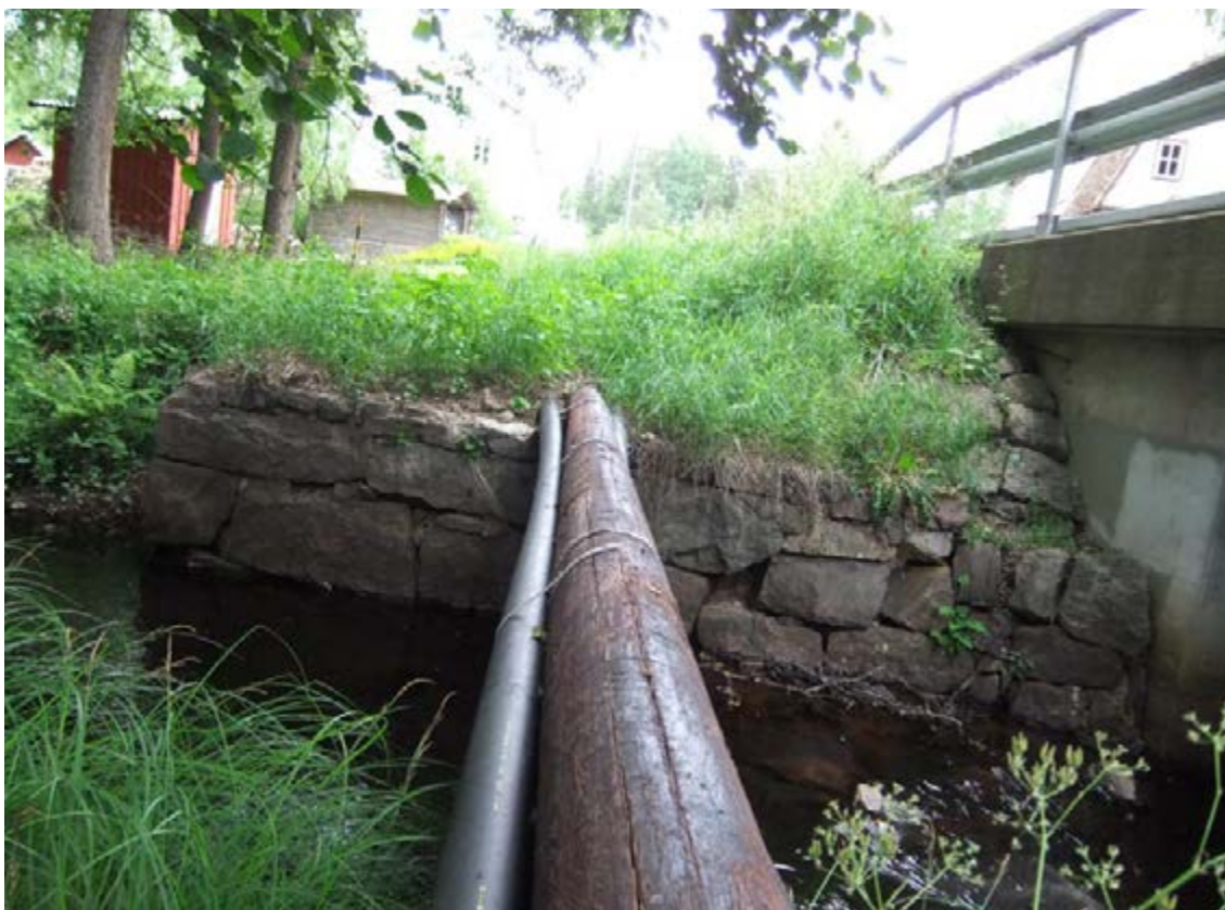
Fig 384. Sällevadsån 18, delar av den äldre bron intill dagens betongbro, använd som stöd för en ledning. Fotot är taget från sydväst av Emma Christensen.
