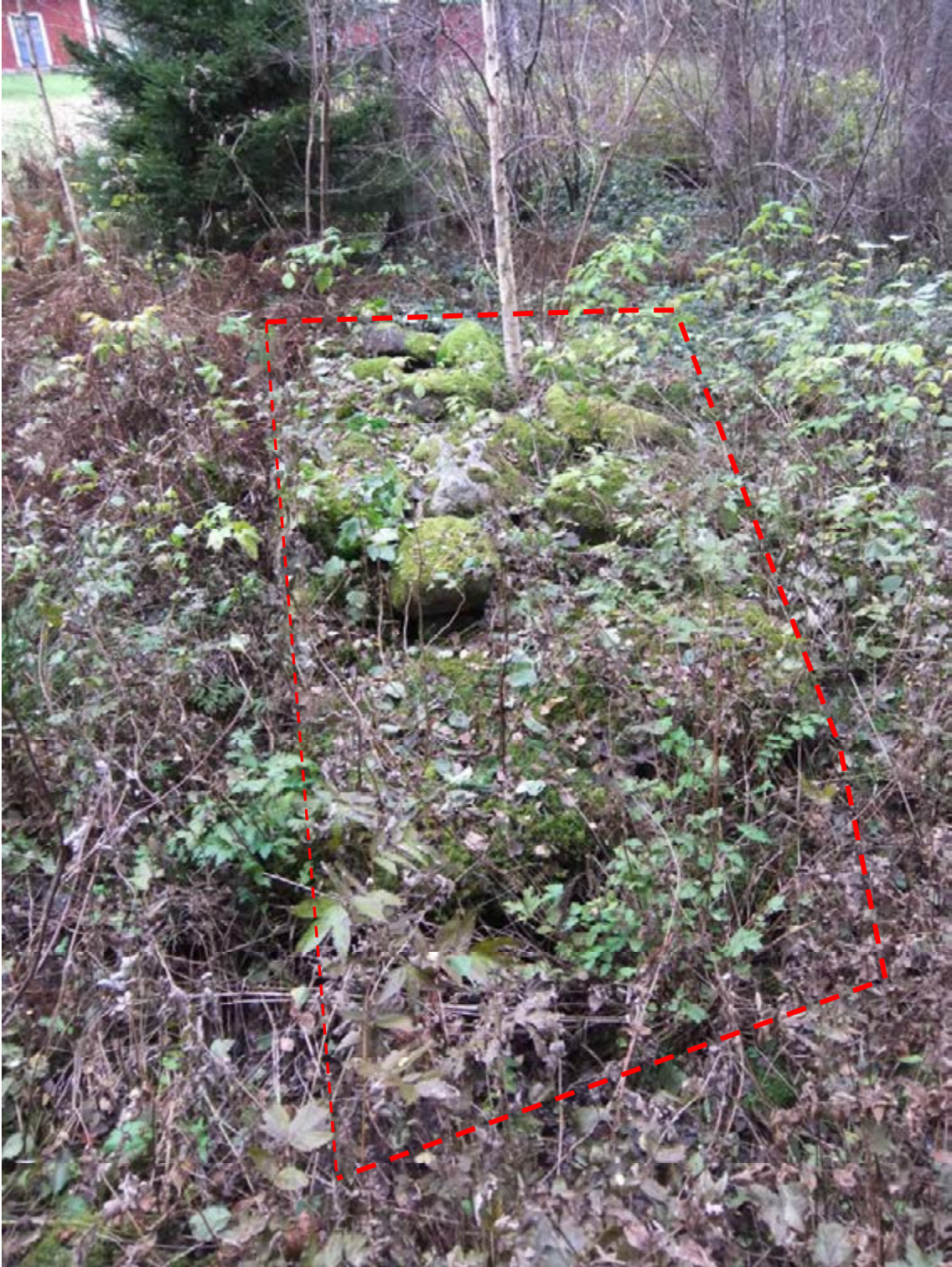
Figur 159. Bruzaån 93, Mittsektionen där dammvallsarmarna sammanstrålade och där utskovet fanns. Varken platsen för dammvallen eller kvarngrunden hyser några pedagogiska värden i den kraftig igenvuxna terrängen. Fotot är taget från sydöst.
