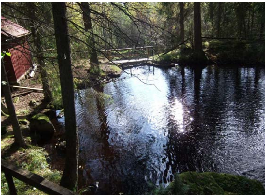
Figur 60. Dammen med pumphuset till vänster i bild. Idag är dammens utskov betongförstärkt. Fotot är taget från nordväst.
