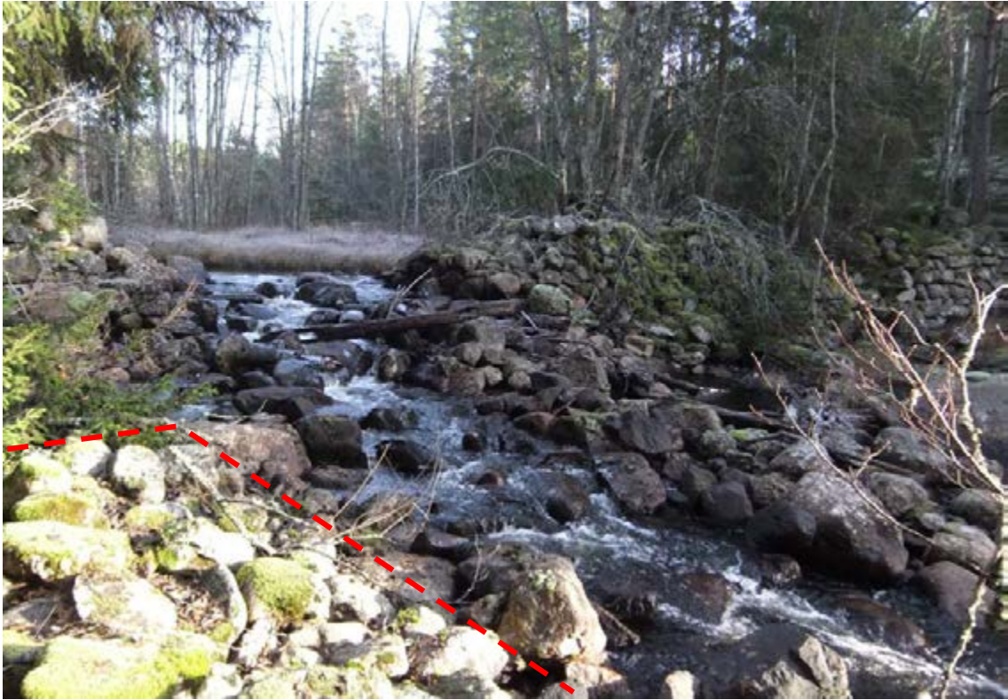
Fig 424. Sällevadsån 40, Häggarps såg. Idag finns dammvall, såggrund och diverse timmer från byggnaden vid och i åfåran. I det nedre vänstra hörnet skymtar delar av såggrundens. Fotot är taget från sydväst.
