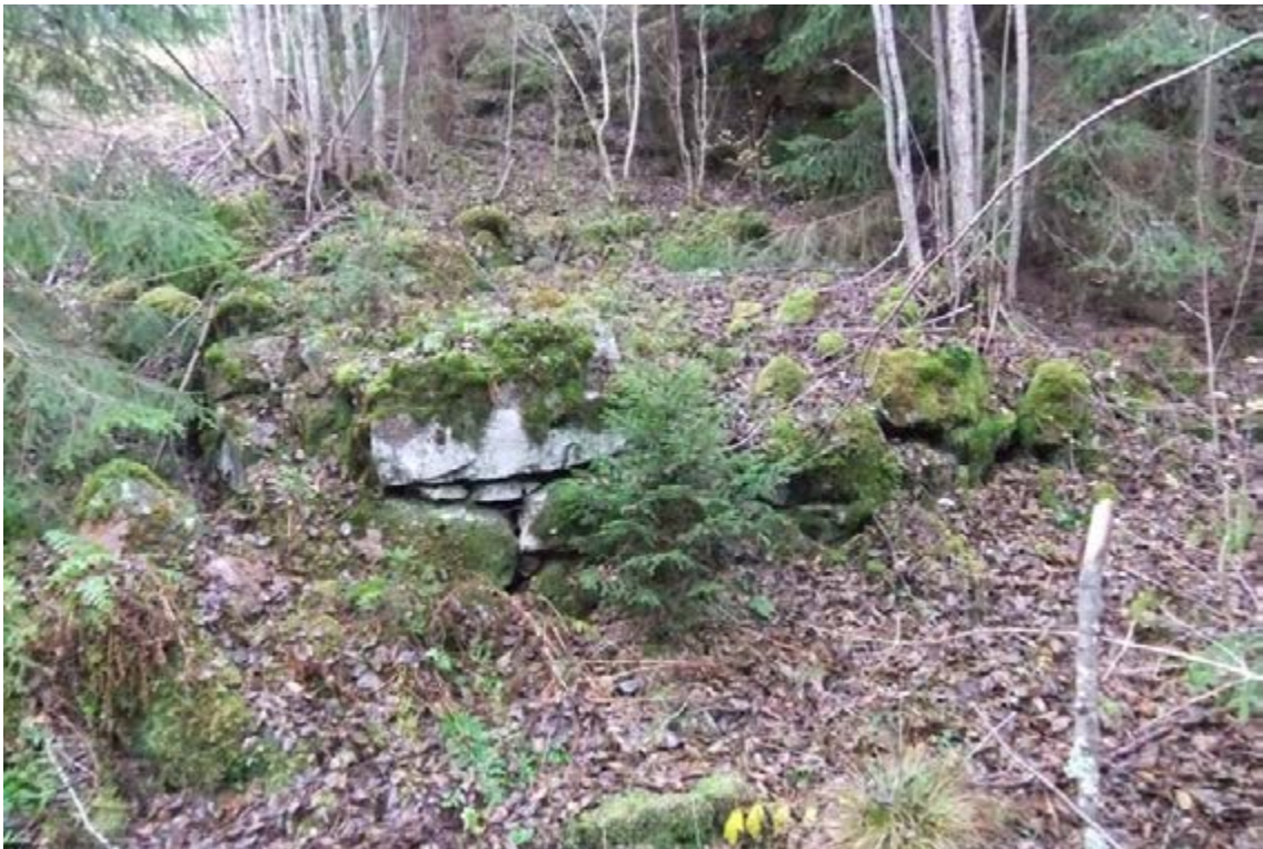
Figur 333. Gnyltån 27, kvarngrunden på den sydvästra sidan av Gnyltån direkt nedan dammvallen. Enligt äldre kartor gick troligen en träränna fram till kvarnen. Fotot är taget från nordöst.
