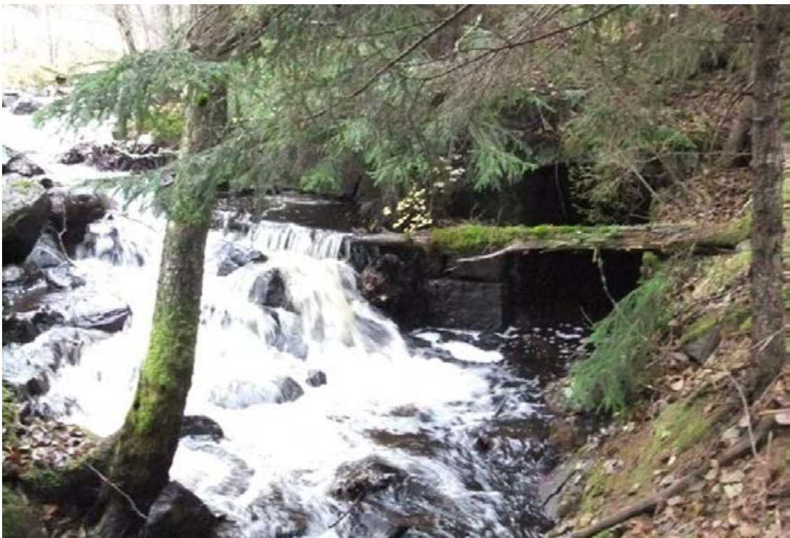
Figur 327. Vedermödan, fundament för kraftstationen, med kallmurning och betong. Här planeras åtgärder för att förbättra det partiella hindret till ett mer passerbart parti för öring. Fotot är taget från syd.
