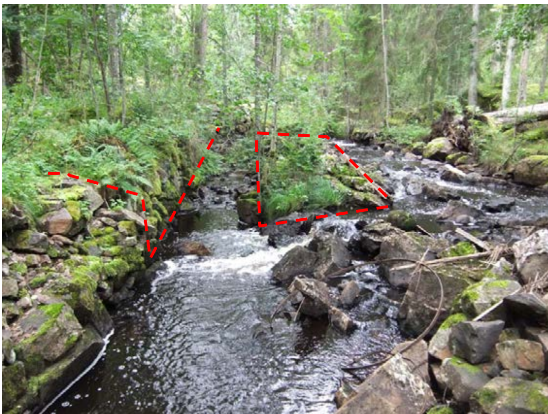
Figur 24. Bruzaån 3, småindustriellt område med kvarn och såg. Foto taget från brofundament mot grunderna till kvarnen, här markerat med röda streckade linjer. Ränna eller hjulgrav löper mellan dessa. Foto taget mot väst.
