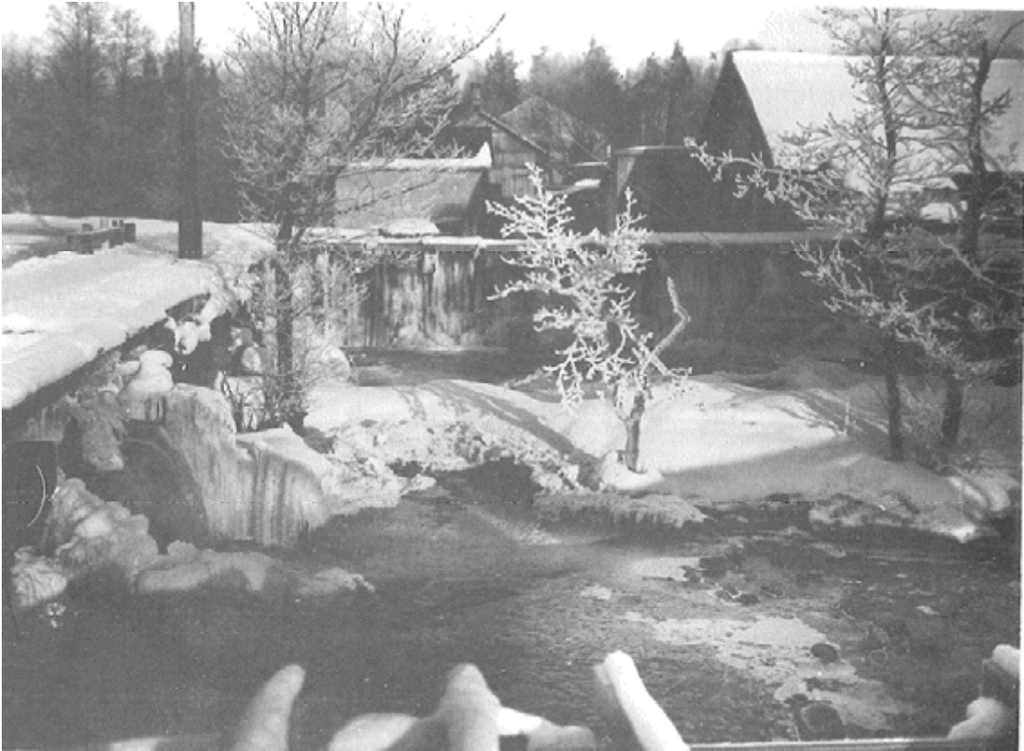
Figur 197. Platsen för fabriken då såg och stamp fanns kvar innan år 1920, höger i bild. Sågen och även senare fabriken hade egen vattenförsörjning från dammen via en ränna. Längst ned i bild skymtar en träränna som ledde vatten till ett oljeslageri söder om Bruzaån. Även den byggnaden tillhörde Sjöbergs snickerifabrik men brann ned år 1947. Fotot är hämtat ur Mariannelunds och Hässleby's Hembygdsförenings utgåva Mariannelund – från stationssamhälle till köping (Pettersson 2000, sidan 74). Fotot är taget från sydväst.
