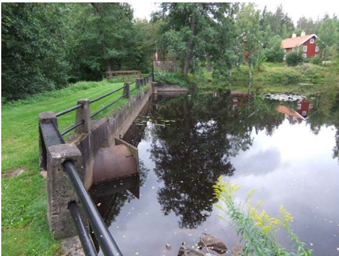
Figur 41. Den nedre dammvallen i Nedre dammen idag. Försedd med järnräcken och betongförstärkningar, troligen från sekelskiftet 1800-1900. På bilden syns även ett rör i vallen där trätuben till kraftstationen anslöt. I bakgrunden skimtar det som med tiden kom att bli arbetarbostäder, den så kallade Smedjebacken. Fotot är taget mot sydväst.
