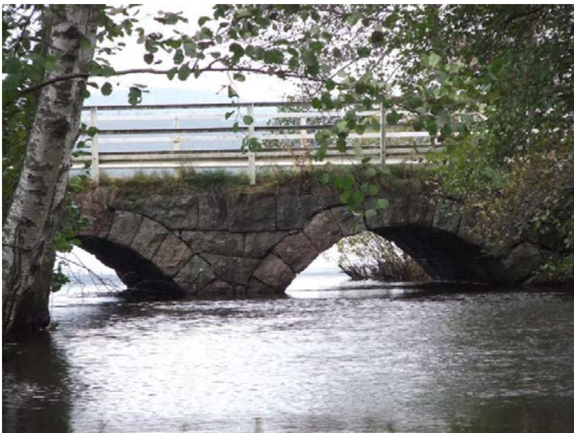
Figur 70. Bruzaån 36, stenvalsbron vid sjön Hjältens utlopp i samhället Hjaltevad. Bron är byggd i en ålderdomlig teknik, och har haft flera föregångare på platsen. Det är oklart om bron är från 1800-talet eller en förbättrad version från första halvan av 1900-talet. Fotot är taget från öst.
