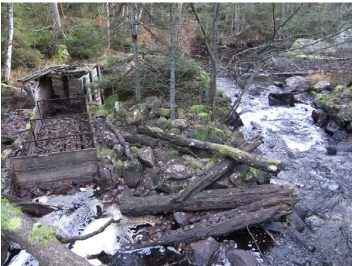
Fig 411. Sällevadsån 33, Damm med ålkista söder om Kapellet. Dammens centrala utskov, till höger i bild, är troligen använd för flottning. Syftet med dammen är sannolikt kopplad till flottningen och ska ses som en flottningsslämning. Vid dammen finns lösa timmerstockar, möjligen har det funnits ett skibord eller ränna av trästockar i åns riktning för att förhindra brötar och för att underlätta timrets färd. Fotot är taget från norr.
