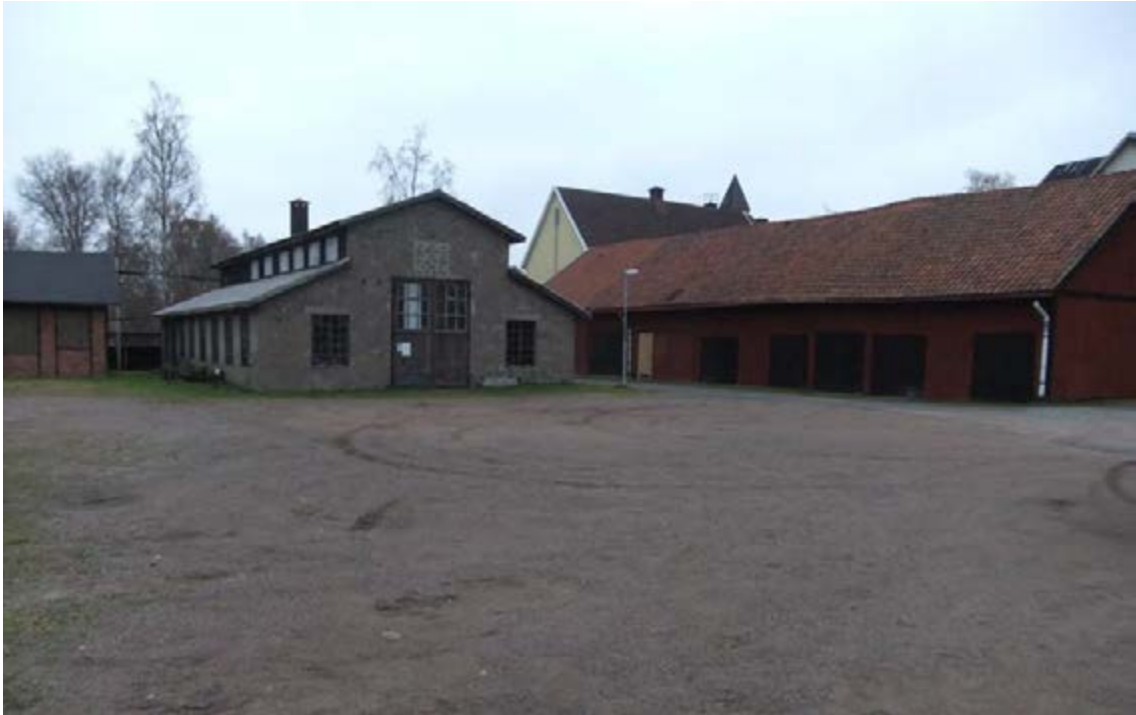
Figur 204. Bruzaån 108, Jules Mekaniska Verkstad, en välbevarad anläggning med byggnadsminnesmärke. Gjuteriet, en cementbyggnad centralt i fotot och en lagerbyggnad till höger. Fotot är taget från norr.
