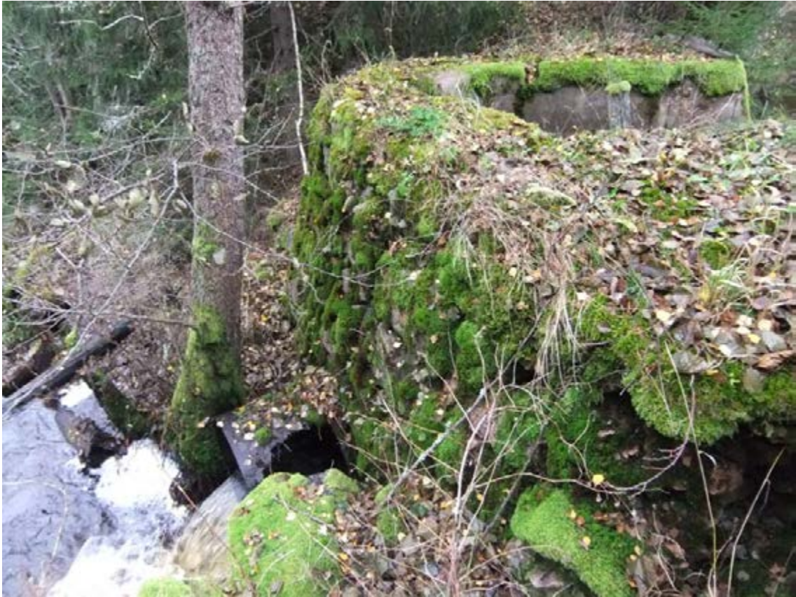
Figur 326. Gnyltån 25, Vedermödan. En kallmurad, betongförstärkt dammvall finns kvar av kraftstationens anläggningar. Ett omlöp öster om fördämningen är planerat av Emåförbundet. Fotot är taget från öst.
