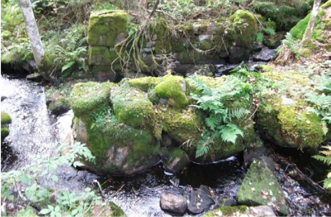
Figur 117. Bruzaån 62, kvarngrunden med de båda stenfötterna, fotot är taget från norr.
