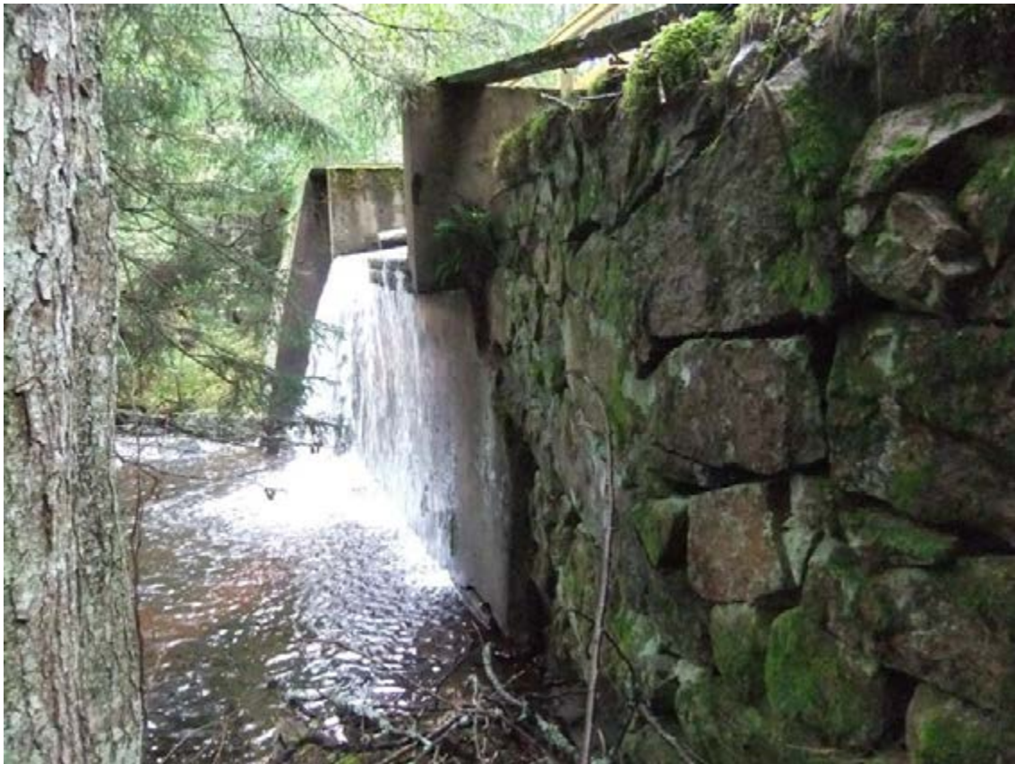
Figur 63. Bruzaån 30. Regleringsdammvallen vid Lövsjön. Den äldre kallmurade delen har sin härkomst i 17-1800-tal. Fotot är taget frånsydost.
