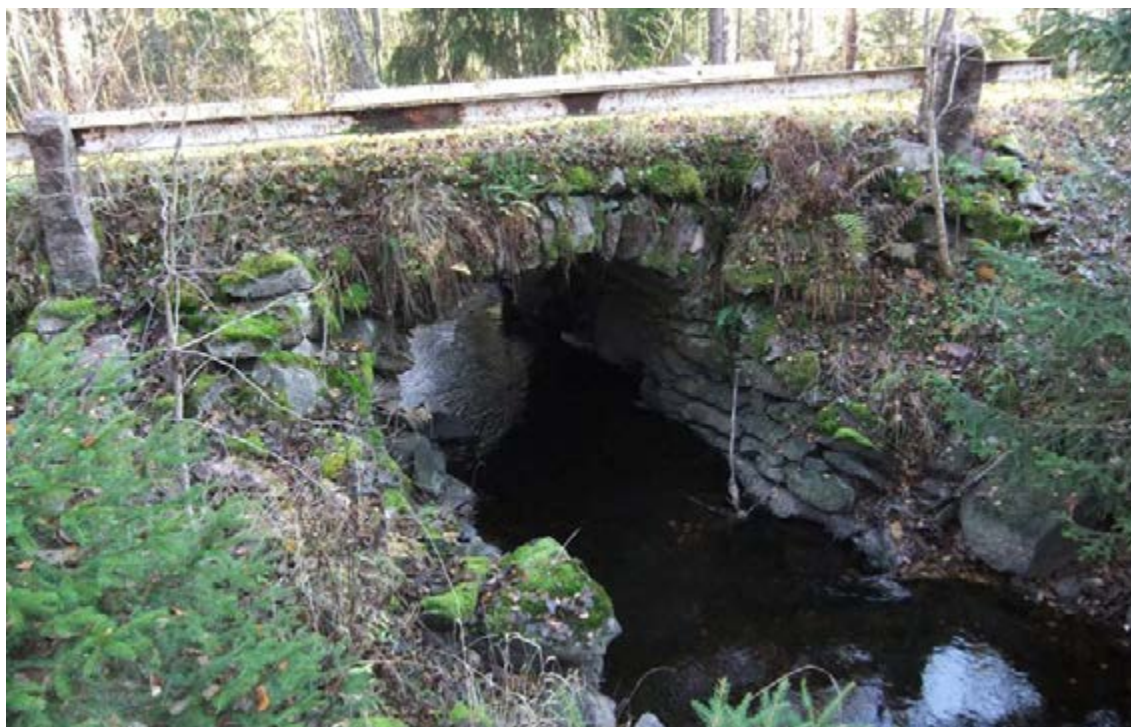
Fig 398. Sällevadsån 24, en äldre stenvälsbro eller trumma i ett valv. Brons uppbyggnad av natursten talar för en trolig ålder eller ursprunglig tillkomst under 1600- till 1800-tal. Detta kan dock inte bekräftas i äldre kartor. Fotot är taget från väst.
