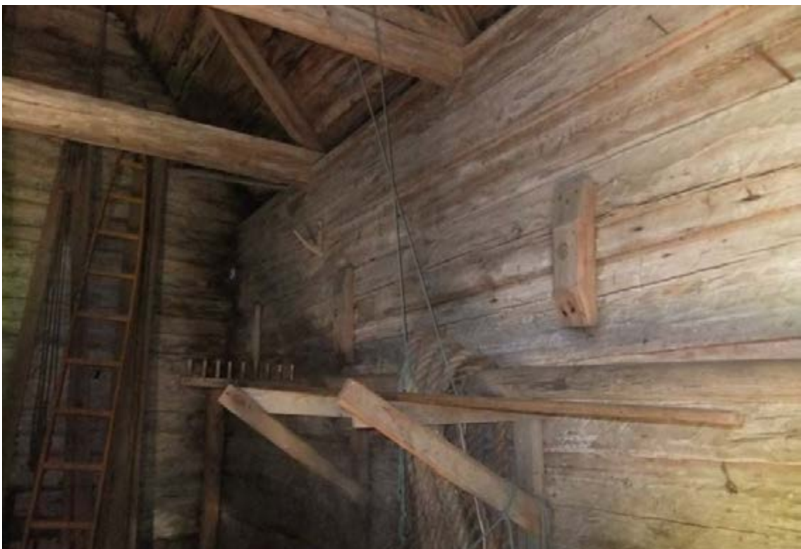
Figur 93. Bruzaån 51. Interiör av kyrkbodens norra sida samt takstolar. Fotot är taget från sydöst.
