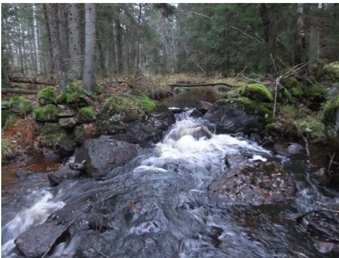
Figur 319. Dammvallen vid det gamla kvarnläget, Gnyltån 16. Fotot är taget från sydöst.
