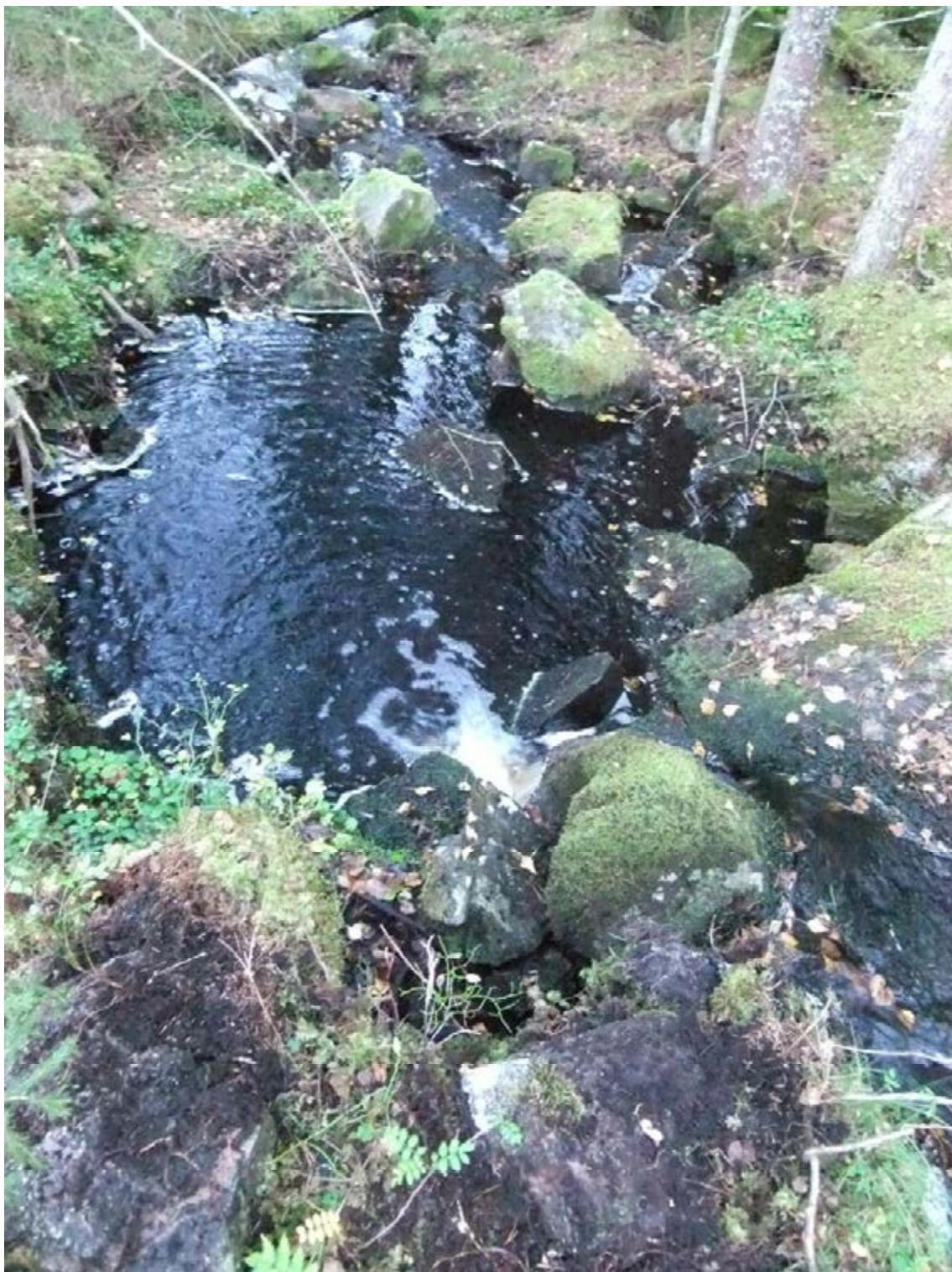
Figur 66. Bruzaån 32. Kvarnplatsen nedströms dämnet. Enstaka stenfundament med tuktade stenar har utgjort grund för en enkel skvaltkvarn. Fotot är taget från norr.
