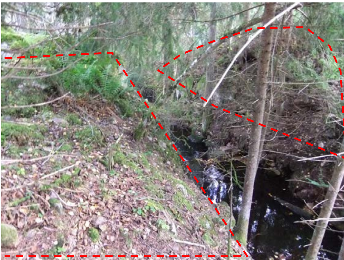
Figur 120. Bruzaån 63, en stor dammvall belägen mellan två mindre berg och branta bäckravinslutningar. Vallen är markerad med röd streckad linje, på höger sida i sin genomskärning. Fotot är taget från nordväst.
