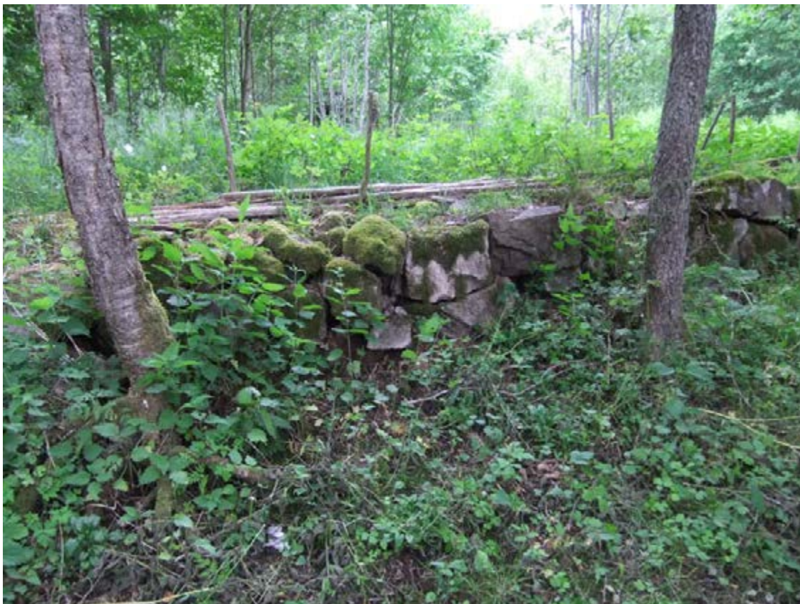
Fig 383. Sällevadsån 17, dammvallens kallmurade östra sektion, idag mer i funktion som en förbättrad gärdesgård intill en hustomt. Fotot är taget från söder av Emma Christensen.
