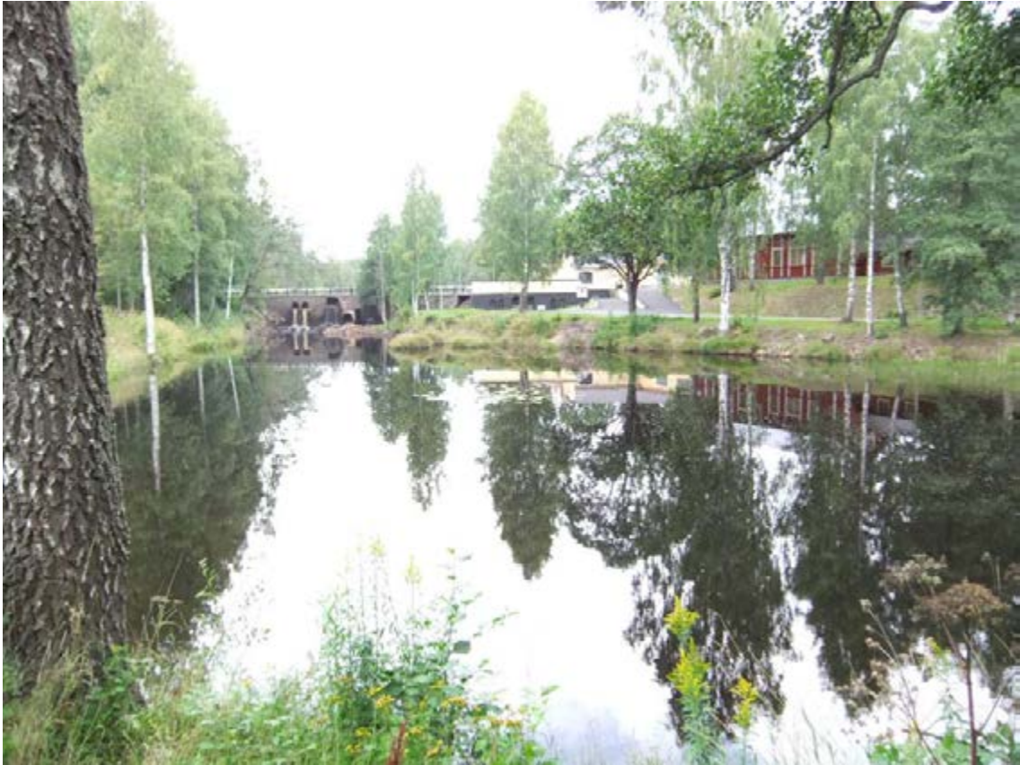
Figur 35. Nedre dammen i Bruzaholm. Mitt över denna damm låg tidigare en mindre dammvall. Bruzaån 7 syns i bakgrunden. I denna dammvall finns ett större antal utskov, bland annat ett som ledde en tub med vatten fram till kraftstationen i Bruzaholm bruk. Tuben gick i sin förlängning även genom dammvallen vid Nedre dammens slut (se figur 36 nedan).
