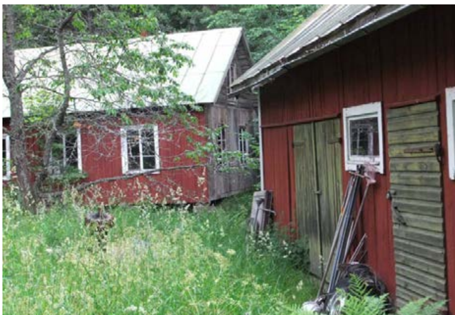
Fig 389. Sällevadsån 20. Ena gaveln på snickeriverkstaden visar detaljer i uppbyggnad och fasad. I förgrunden en samtida ekonomisk byggnad som tillhör miljön. Foto från sydväst av Emma Christensen.
