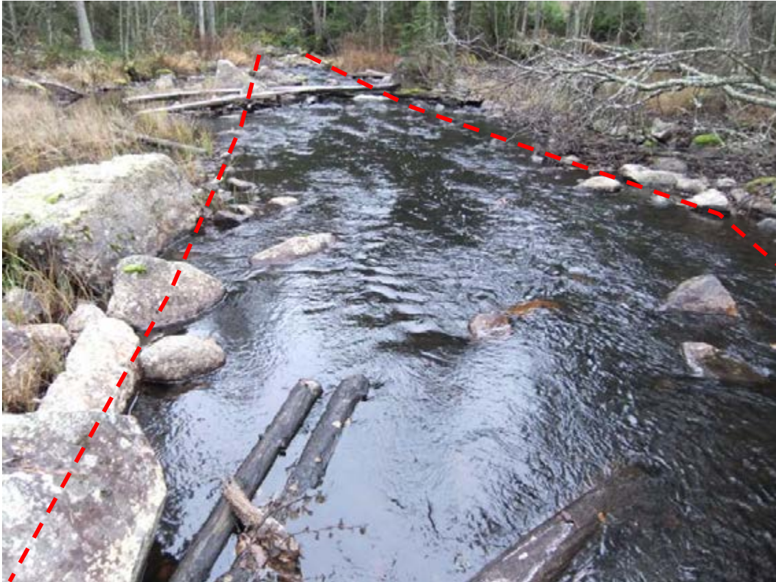
Fig 410. Sällevadsån 32, den flottledsrensade sträckan som delvis är återställd genom att block lagts ut till förmån för fisken. Idag finns stensatta kanter och kanaliseringar i den västra kanten av Sällevadsån. Timmer från eventuella enkla träkistor finns kvar, men framför allt stenpackningar visar var de en gång legat. Fotot är taget från nordöst. Vid inventeringstillfället var flödet relativt högt och kanalens kanter är inte lika tydliga på bild.
