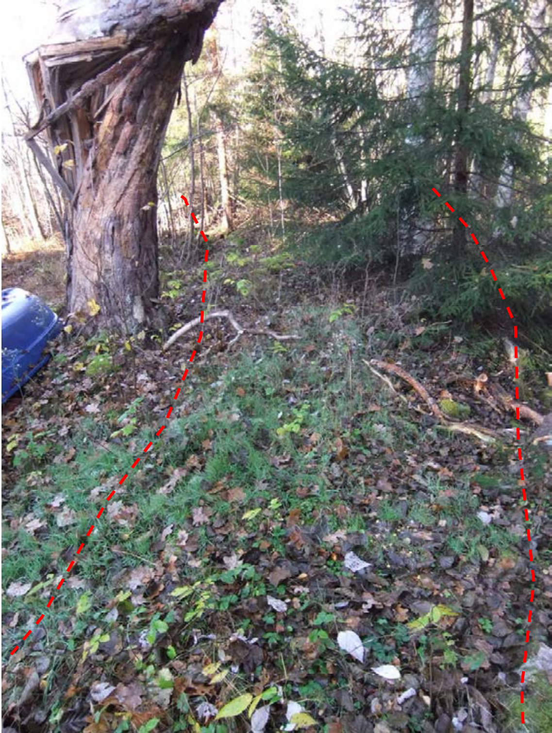
Fig 394. Sällevadsån 23, äldre fördämning vid Riddersbergsviken. Vallen är av flack och övervuxen karaktär, sten och jordfylld, och kan vara den dammvall som en gång reglerade flödet för Flenshults kvarn och såganläggning. Fotot är taget från sydöst.
