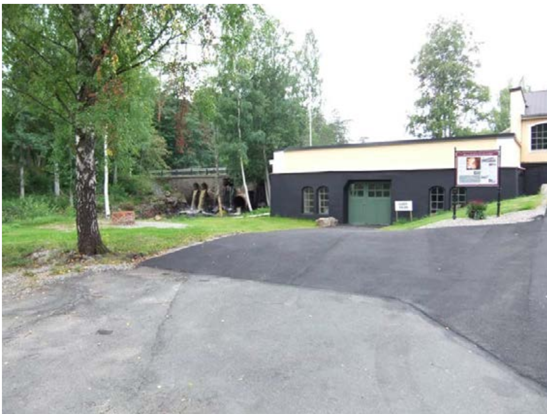
Figur 37. Mekaniska verkstaden och den intilliggande dammvallen vid Nedre dammen. Idag museum i lokalerna. På platsen vid mekaniska verkstaden fanns på 1700-talet även en stång- och en kniphammare som drevs av underfall. Smedjan, numrerad 11 på den äldre kartan, bör ha legat mycket nära vattnet, möjligen förankrad i vattnet på en stenfot. I närheten av mekaniska verkstaden, ungefär från platsen där fotot är taget ifrån, låg även en stångjärnsmedja och tidigare även en såg och en kvarn, numrerad 13 på den äldre kartan från 1745.
