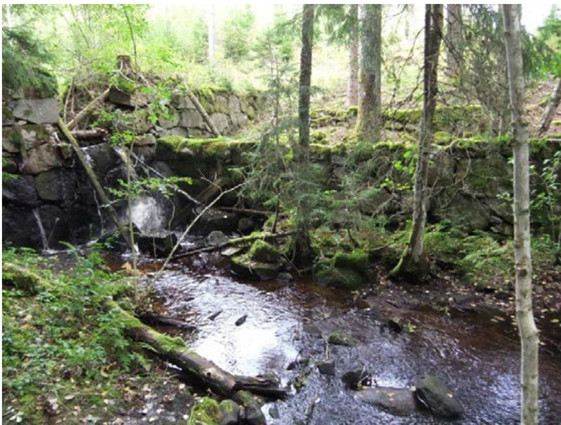
Figur 73. Bruzaån 38 med vattenförande utskov, dammvall och murar/stenfötter till kvarnen. Fotot är taget från sydväst.
