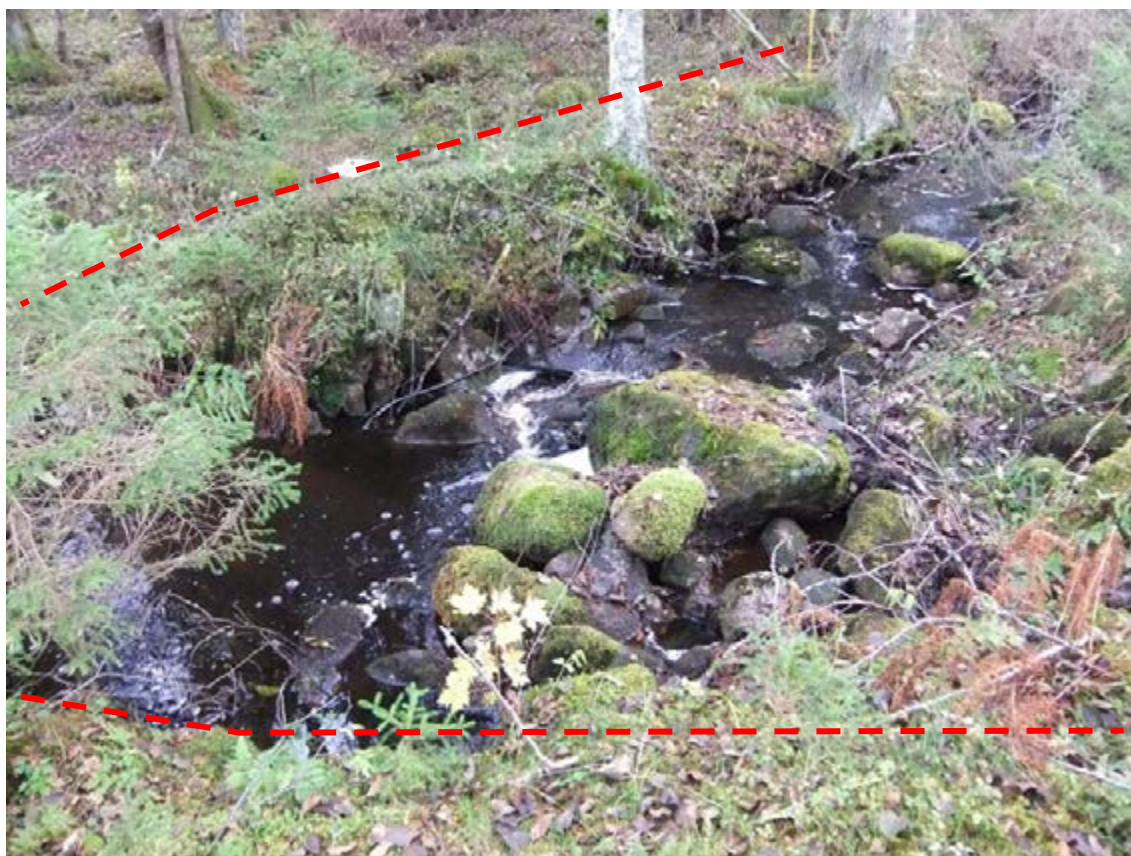
Figur 140. Bruzaån 86, med en mycket flack V-formad dammvall. Fotot är taget från öst med vallens utskov och spets vänster i bild.
