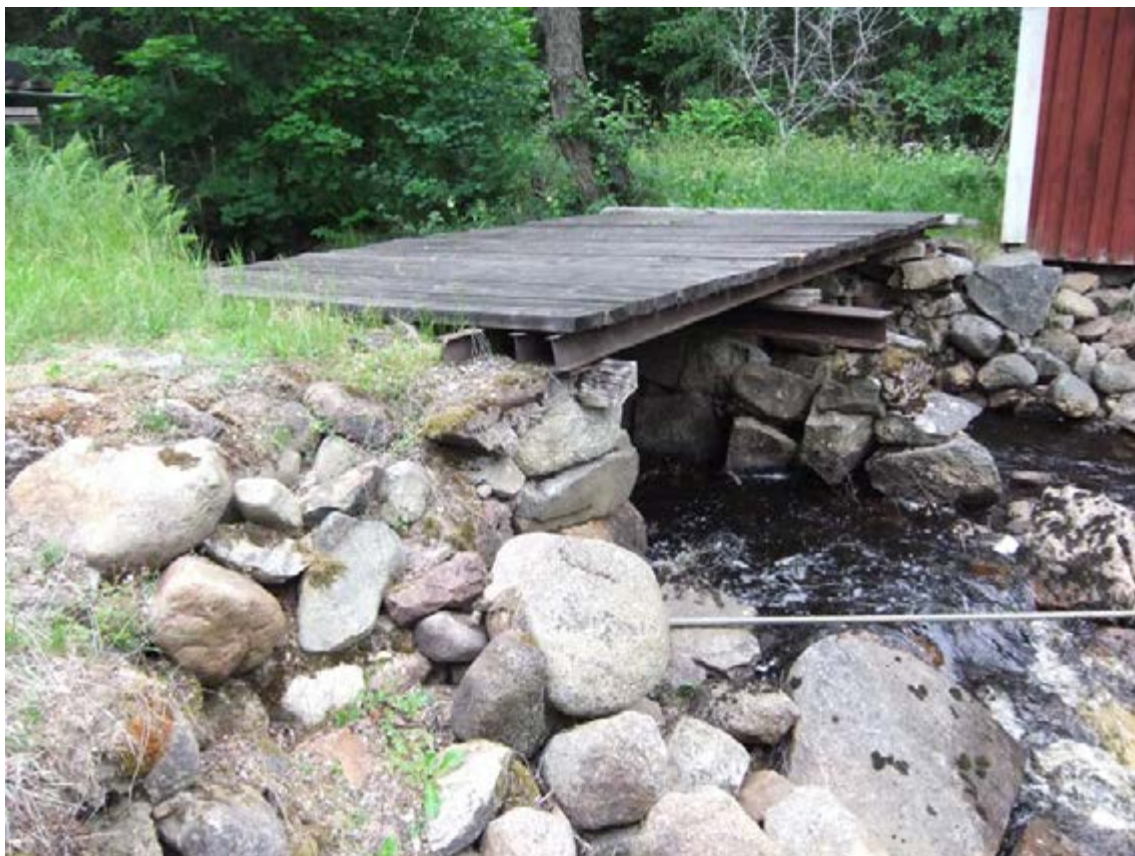
Fig 391. Sällevadsån 21, som utgörs av en bro, vars fundament av kallmurad natursten har äldre hävd trots vissa ombearbetningar sedan 1700-talet. Fotot är taget från söder av Emma Christensen.
