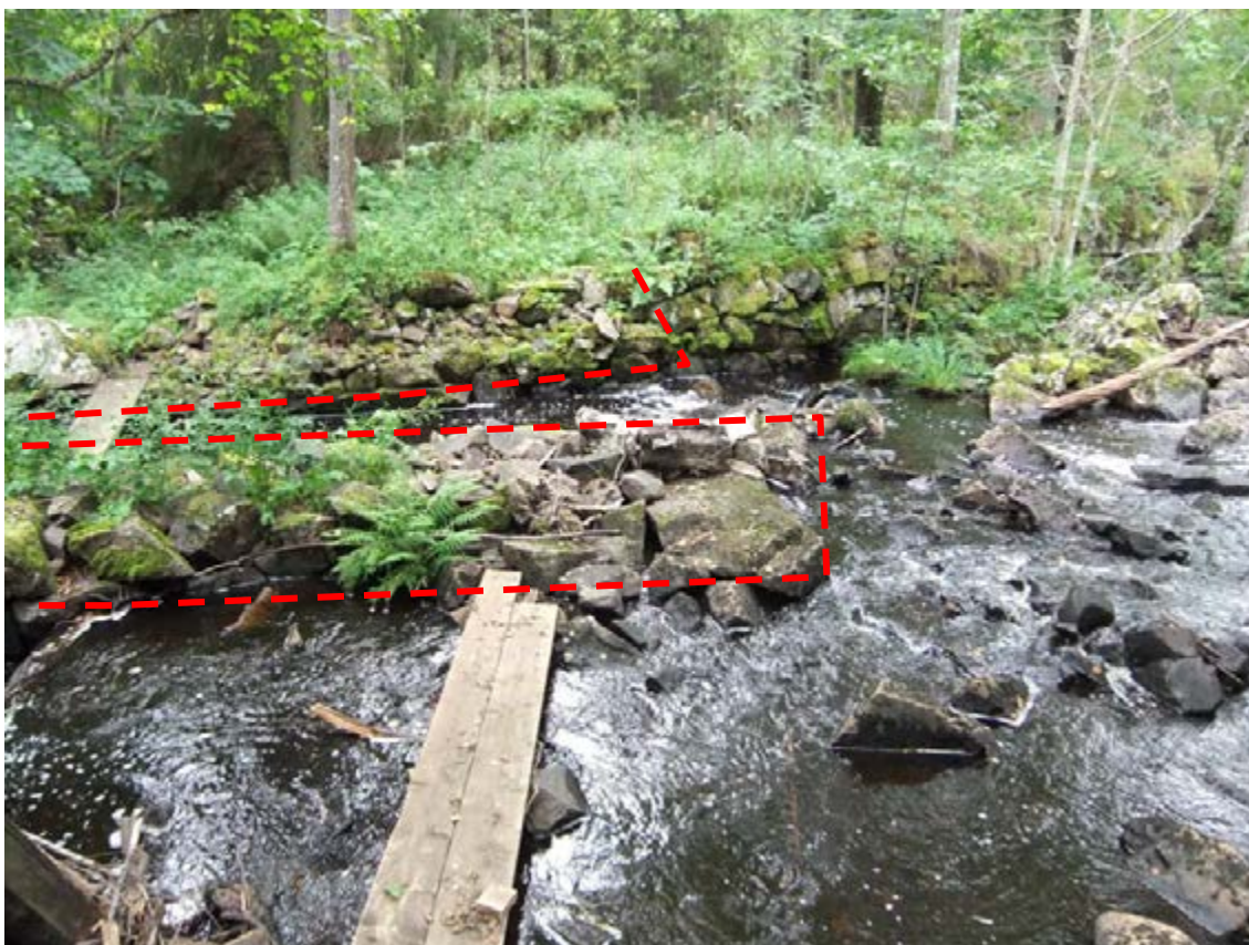
Figur 31. Bruzaån 4, brofundament, delvis något raserade. Markering visar mittfundamentet och det södra fundamentet. Idag finns enstaka plank för torrkodd övergång på platsen. Foto taget från norra brofundamentet mot syd. I övre högra hörnet i bild finns kallmurningen till kvarngrunden och kvarnfåran tillhörande Bruzaån 3.
