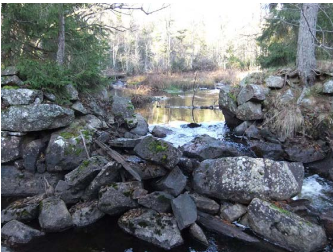
Fig 407. Sällevadsån 30, det raserade utskovet med diverse plank- och timmerrester från luck- eller rännkonstruktion. Fotot är taget från söder.
