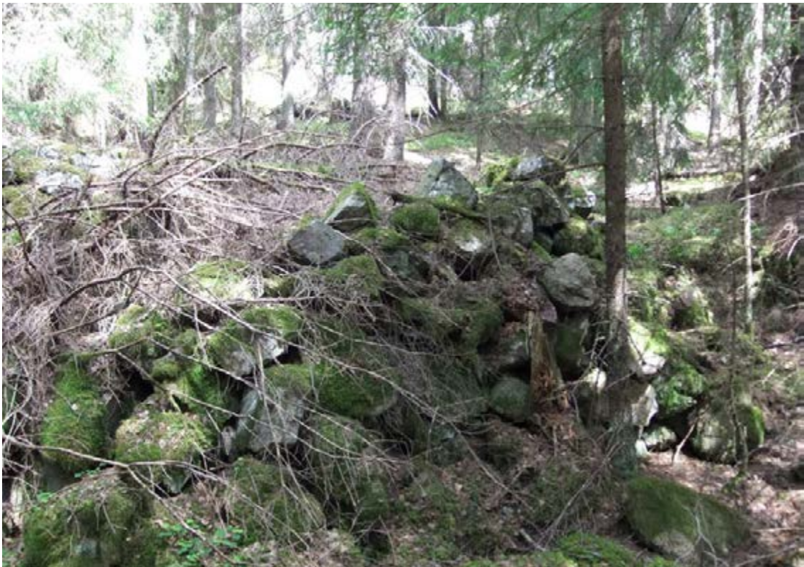
Fig 373. Sällevadsån 14. Del av dammvallen. Dammvallen har två öppningar; ett till kvarnen och ett breddutskov längre söderut som idag består av en torrlagd fåra. Fotot är taget från sydöst.
