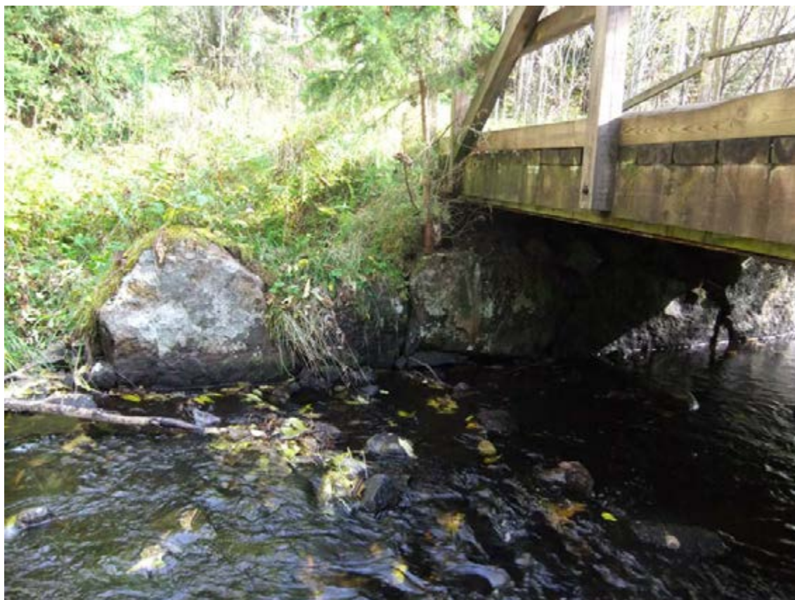
Figur 55. Bruzaån 25, kallmurad grund, delvis med tuktade stenar. Ligger exakt där enligt uppgift ska ha funnits en manufaktursmedja. Idag finns en enklare träbro över vattendraget. På den norra sidan av vattendraget har man utnyttjat smedjegrunden som brofäste. Foto taget från sydväst.
