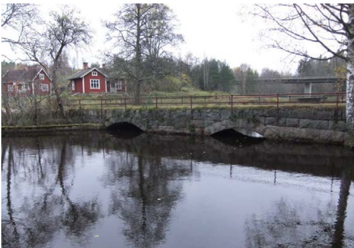
Figur 147. Bruzaån 89, Högebros stenvälsbro, östra sektionen, med två lägre valv jämfört med den västra sektionen. Fotot är taget från norr.
