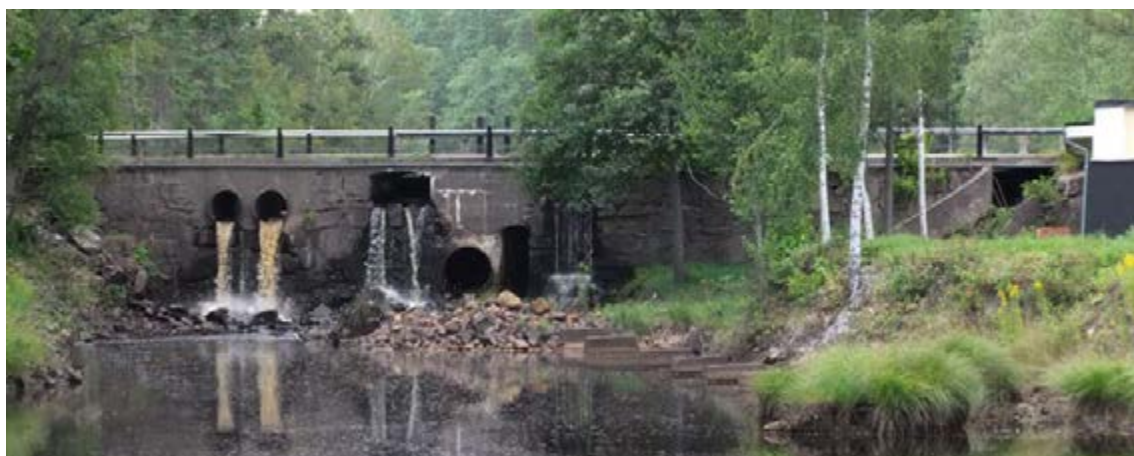
Figur 34. Dammvallen som fördämmer Övre bruksdammen, anlagd åren 1721-1722. Sedan dess har dammvallen förstärkts och omarbetats med bland annat betong. Foto taget från öster.
