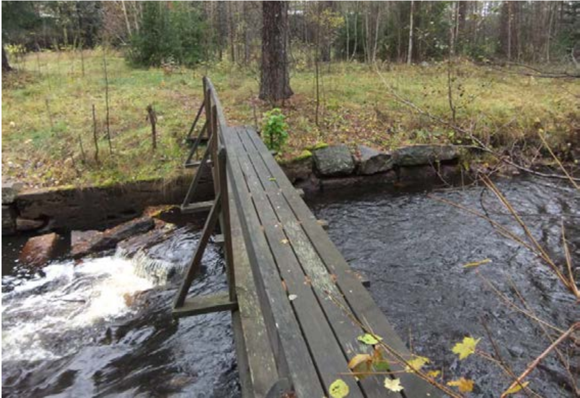
Figur 209. Bruzaån 110, kallmurad sektion vid kvarnfallet, delvis betongförstärkt. Fotot är taget från öst.
