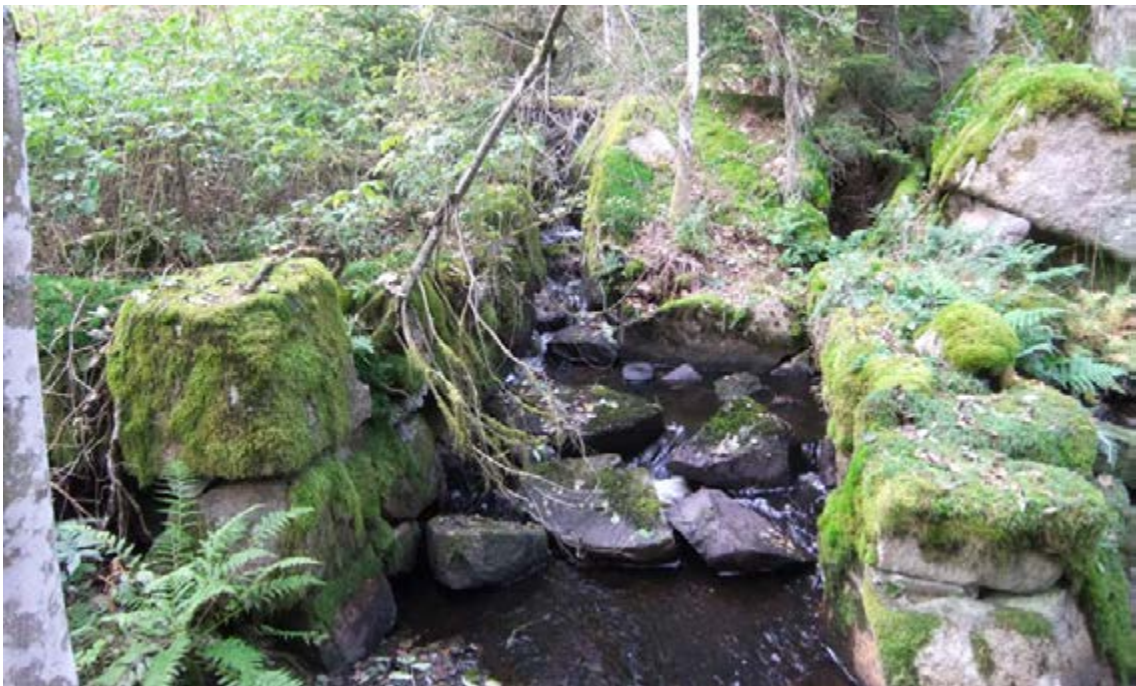
Figur 118. Bruzaån 62, kvarngrunden med ränna. Fotot är taget från öst.
