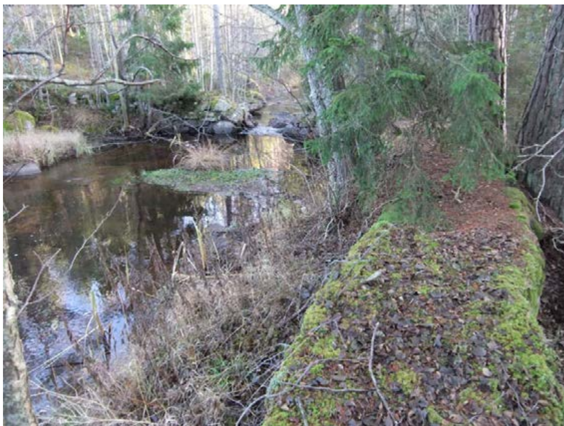
Fig 405. Sällevadsån 30. Dammvall norr om Tjustängsfällan, vars syfte troligen kan kopplas till flottningsverksamheten i ån. Den kan även haft reglerande funktion för nedströms liggande anläggningar. Fotot är taget från norr.
