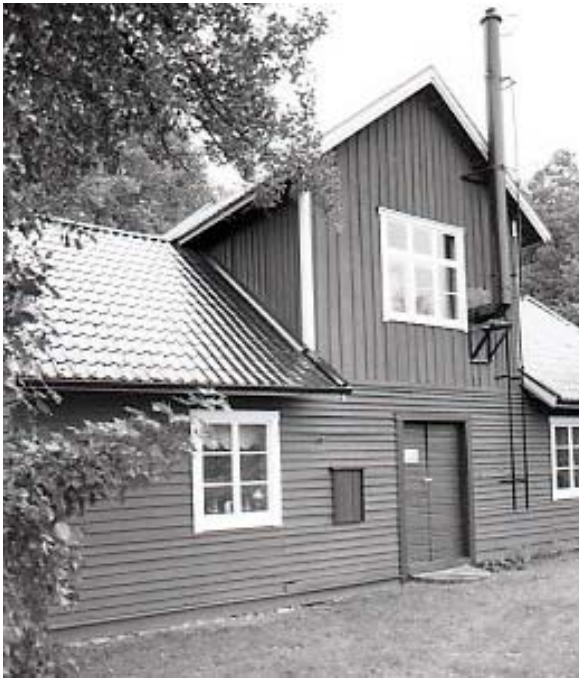
Fig 400. Sällevadsån 26 och 27, kvarnbyggnaden enligt foto från industriminnesinventeringen. Fotot är taget från sydväst av Jesper Kallhed.
