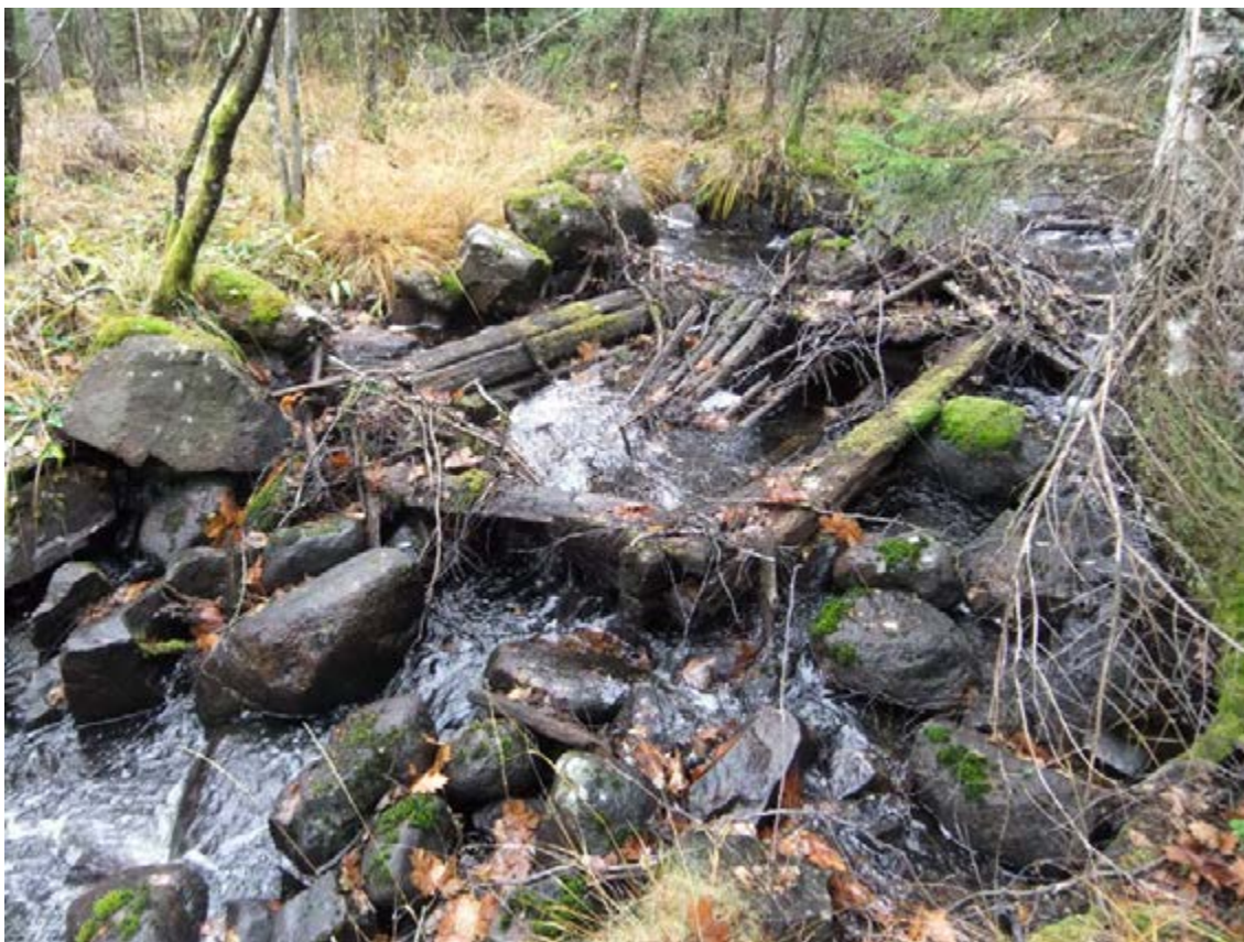
Figur 288. Gnyltån 4, resterna av den ihoprasade ålkistan vid Hästhagen. Klassat som vandringshinder enligt biotopkarteringen. Fasta fisken utgör ingen vanlig förekomst i vattendragen, och bör därför bevaras om de ligger på etablerade fiskeplatser med äldre hävd. Fotot är taget från öster.
