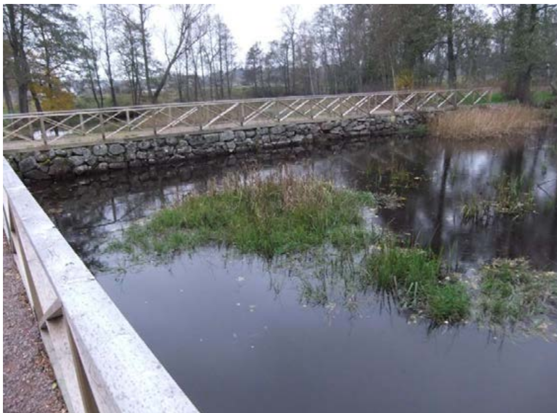
Figur 167. Bruzaån 98, en kallmurad sektion som övergår till färdväg på fast mark till bränneriets gamla tomt väster om stenvälsbron i Mariannelund. Sektionen är att betrakta som en annorlunda typ av bro i kontext med välsbron, dock en senare tillkomst i dess historia. Idag kantas bron av samma typ av träräcken som flankerar välsbron. Bruzaån 98 ledde fram till den herrgårdsliknande byggnaden Holmen. Fotot är taget från nordöst.
