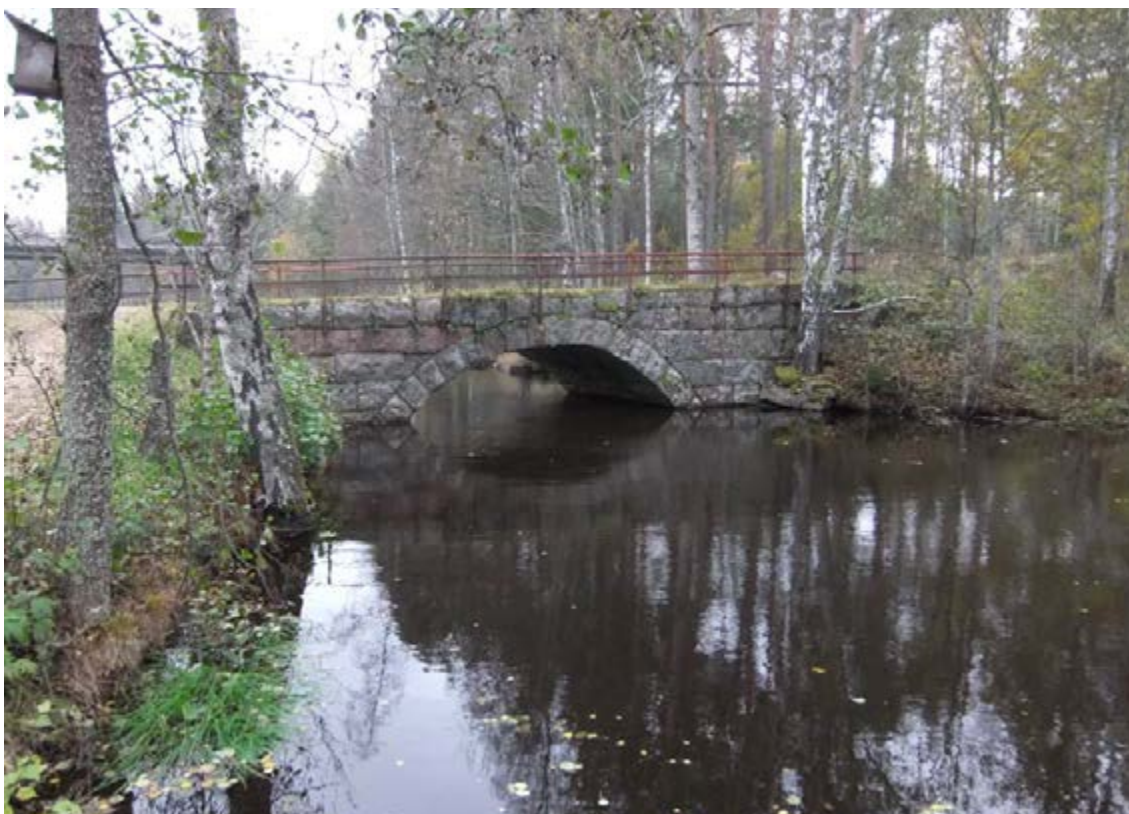
Figur 146. Bruzaån 89, Högebros stenvälsbro, västra sektionen med ett valv. Fotot är taget från nordöst.
