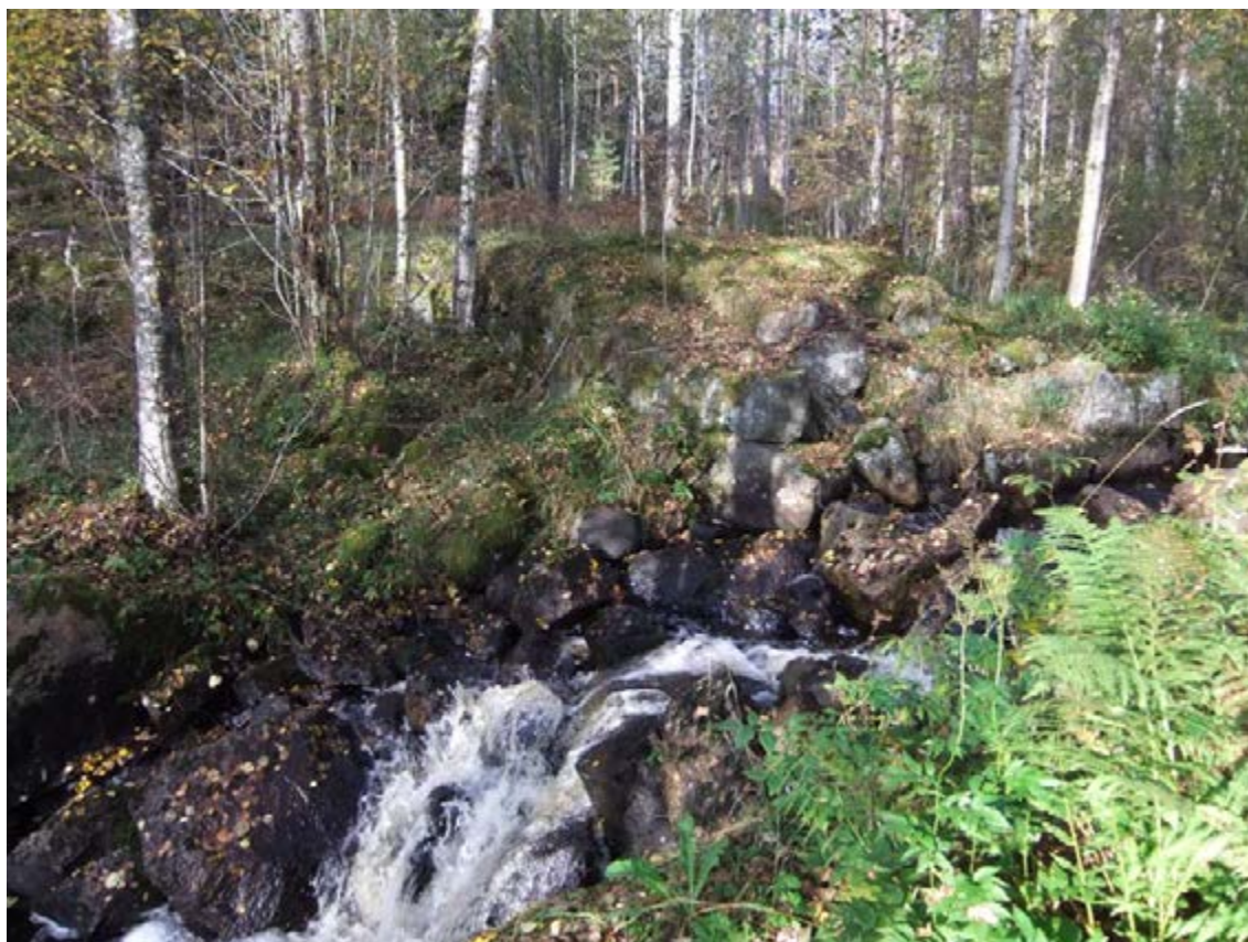
Figur 54. Bruzaån 24. Den kallmurade dammvallen till spiksmedjan finns till stora delar bevarad. Foto taget från sydöst.
