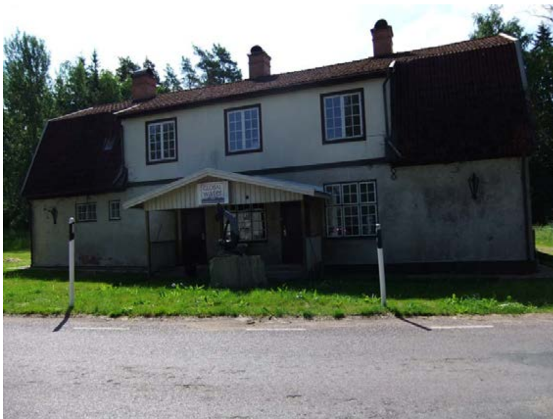
Figur 363. Karlstorp mejeri, intill Sällevadsån. Sedan industriminnesinventeringen har byggnaden ändrats något. Idag är en andra våning tillbyggd med brutet sadeltak med rött tvåkupigt taktegel. Fotot är taget från nordnordväst.
