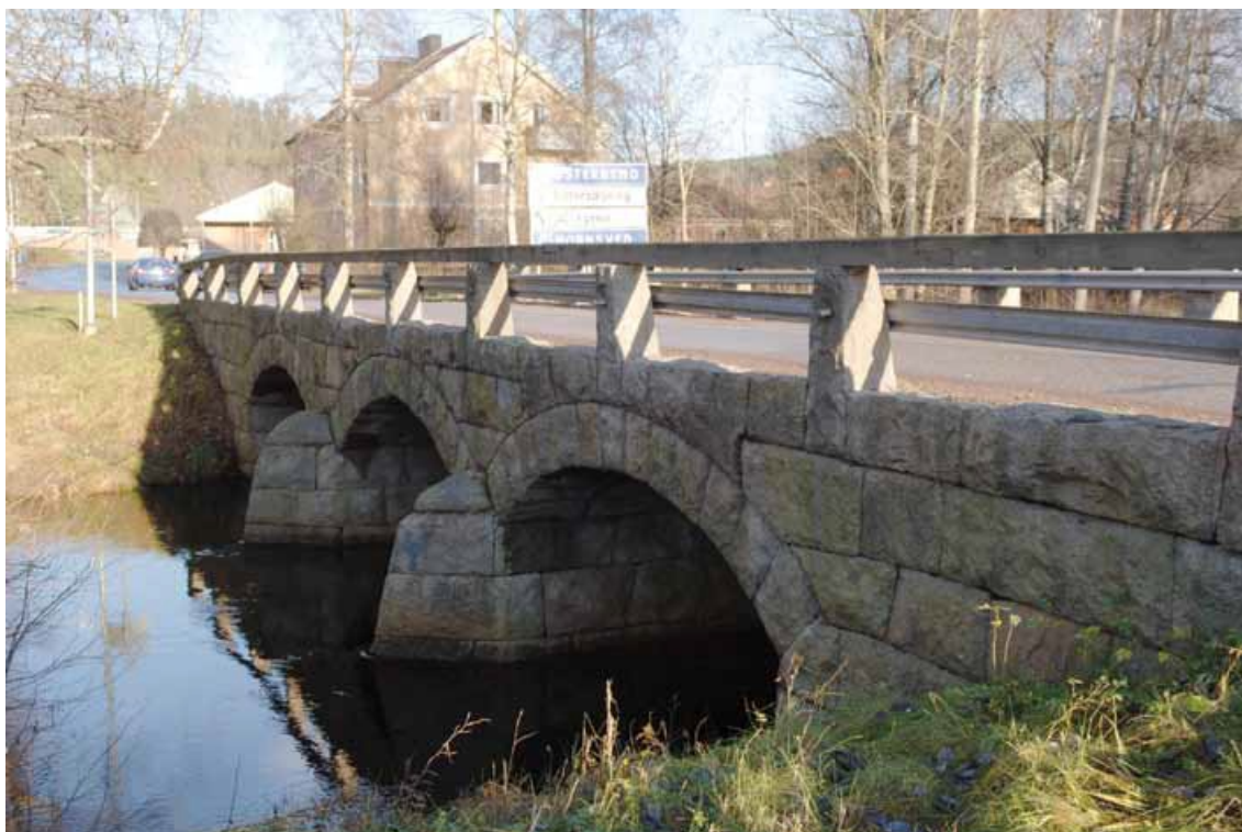
Figur 90. Bruzaån 48, stenvalvsbron i Ingatorp byggd år 1912, är en högt värderad bro inom länet, vilket även ger höga omdömen inom projekt Kultur Aqua. Karaktäristiskt för bron är pelarnosarna som tillsammans med valven ger ett örnliknande utseende. Fotot är taget från sydväst av Sven Olof Ahlberg från Kulturbymråden (Vägverket publikation 2009:29, sidan 34).
