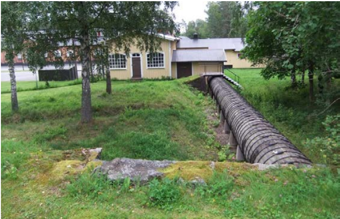
Figur 36. Trätuben från den nedre dammvallen till den gamla kraftstationen som byggdes år 1907.
