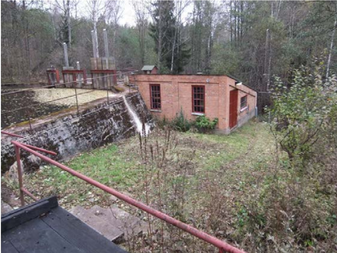
Figur 153. Bruzaån 92, Högebro kraftverk år 2011. Tidstypisk tegelbyggnad med engelskt rött på dörrar och fönster, med byggnadsår 1926. Snetaket är annorlunda för den tidens takkonstruktioner. Fotot är taget från syd.
