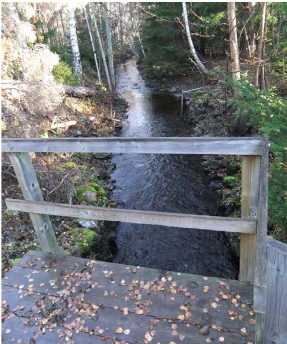
Fig 397. Sträckan nedströms Sällevadsån, sett från dagens moderna dammkonstruktion. Vattendraget är i allmänhet kraftigt rätat och rensat från sjön Flen och nedströms med mindre kanaler. Fotot är taget från sydväst.
