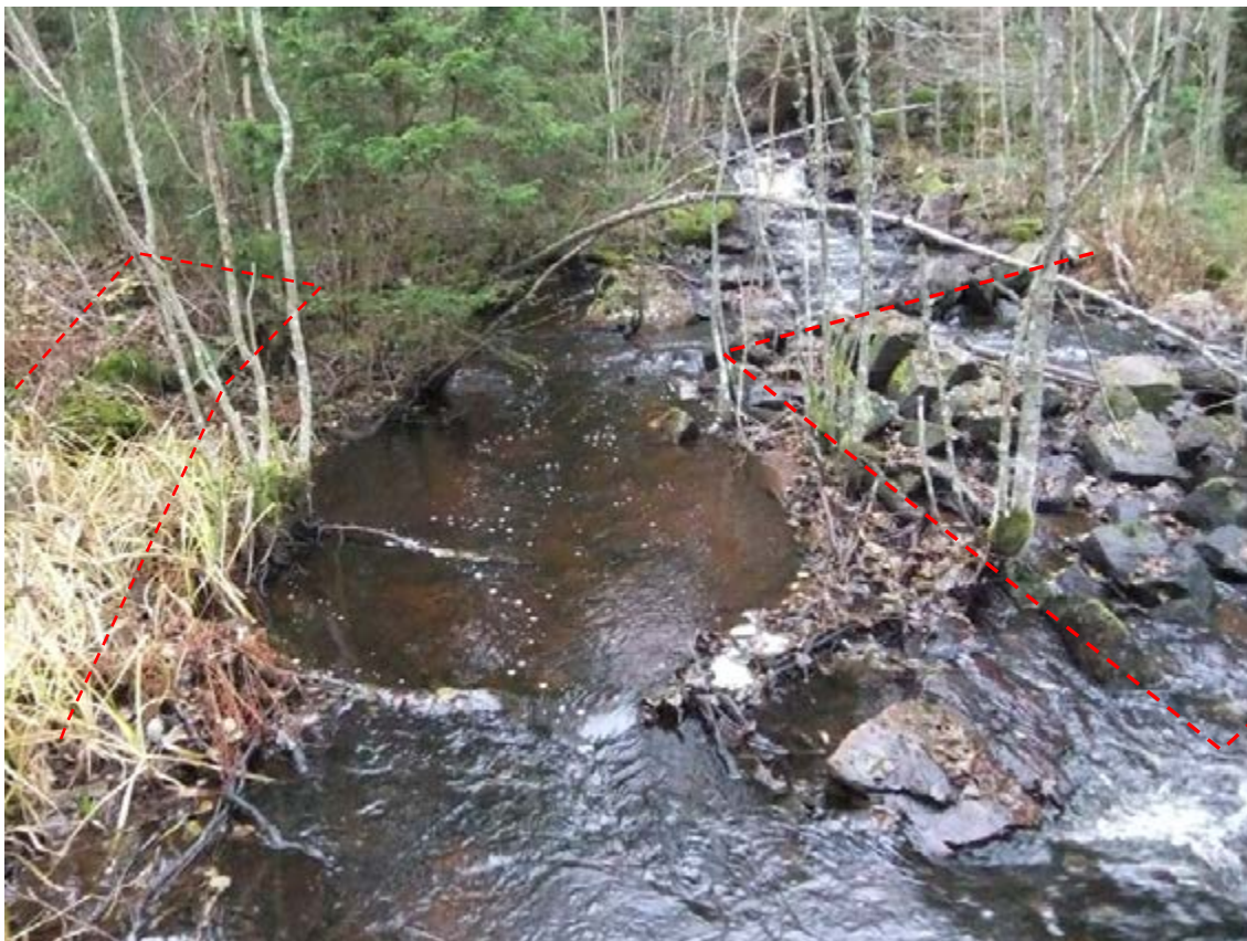
Figur 334. Gnyltån 27. Resterna av såggrunden är delvis raserade och material är troligen använt till biotopåterställande åtgärder. Tolkningen av sågens utbredning kan därför vara behäftad med fel. Streckade linjer markerar område med stensatta partier vid sågens position. Fotot är taget från sydöst.
