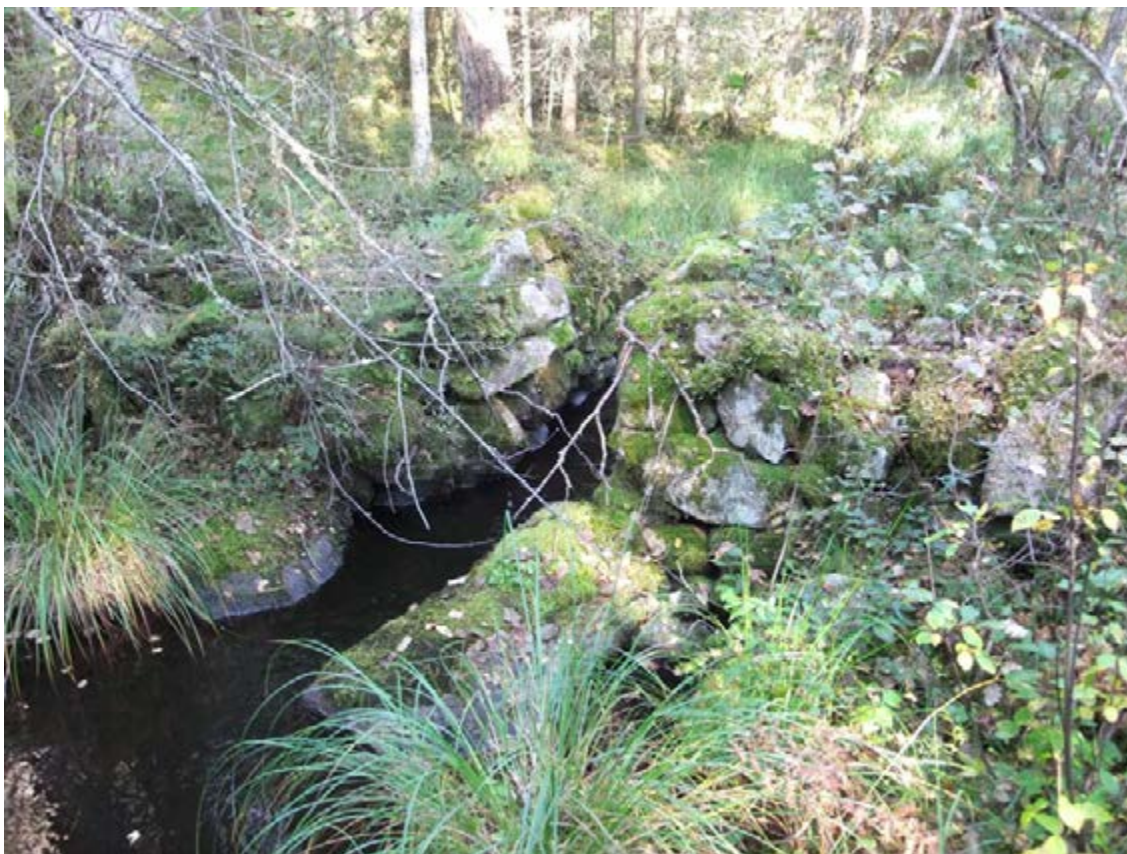
Figur 126. Bruzaån 66, kallmurad dammvall som inte kan identifieras på historiska kartor. Troligen av äldre härkomst. En igenvuxen dammyta finns norr om dammvallen. Fotot är taget från syd.
