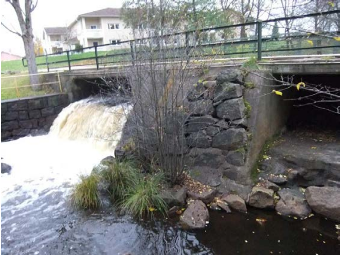
Figur 185. Bruzaån 103, dammvallen vid nedre bruksdammen har genomgått många moderniseringar sedan 1700-talet och är idag till stora delar en betongkonstruktion endast med enstaka inslag av tuktad sten. Fotot är taget från östnordöst.
