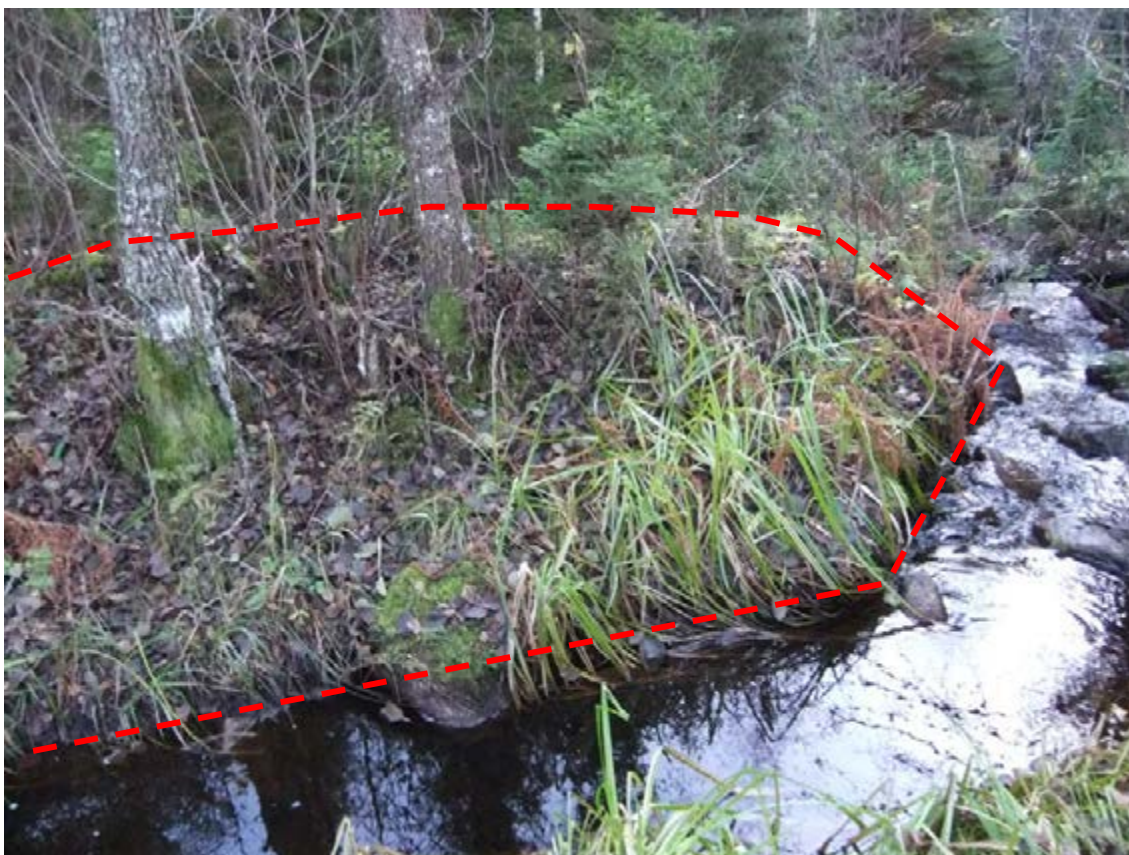
Figur 134. Bruzaån 84, en större V-formad dammvall är idag till stora delar övervuxen och svårfotograferad. Här den östra armen och ett öppet utskov. Fotot är taget från norr.
