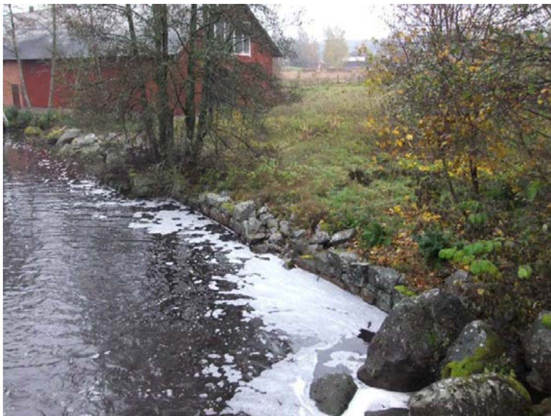
Figur 181. Bruzaån 102, plats och grundrester av sågen. Tidigare fanns även ytterligare äldre ladugårdar på platsen vilket försvårar tolkningen av dimensionen av grunden. Sågen hade ett eget utskov/fåra från dammvallen, idag är denna dock igenlagd med stenblock. Fotot är taget från nordväst.
