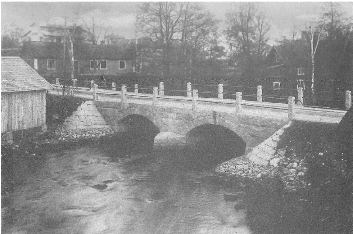
Figur 202. Prästebron under byggnadsåret 1924 med tidstypisk pelarnos och räcken. Fotot är taget från väst och är hämtat ur Mariannelunds och Hässleby's Hembygdsförenings utgåva Kvarnar och broar – invid och över vattenflöden i Hessleby och Mariannelund (Pettersson2002, sidan 20).
