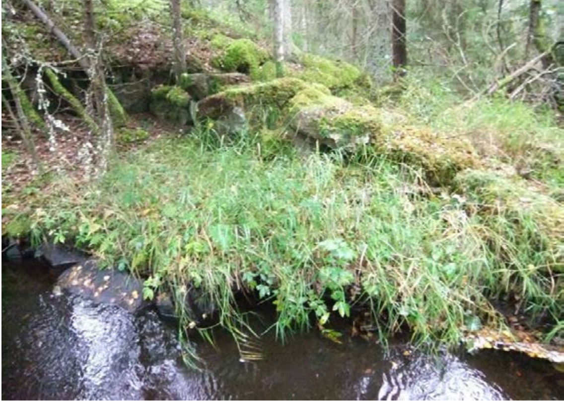
Figur 107. Bruzaån 56, dammvallen på den östra sidan av bäcken visar en övermossad kallmurad sektion. Nedanför dammvallen finns en fallhöjd på ett par meter ned till kvarnläget. Fotot är taget från väst.
