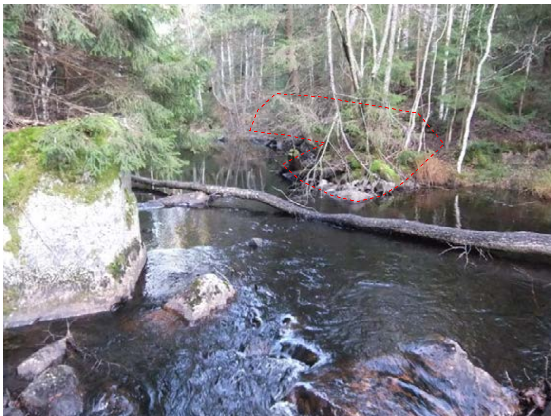
Fig 415. Sällevadsån 35, en äldre dammvall med något osäker funktion, möjligen rester av en äldre flottningsdamm/hålldamm. Idag är stora delar av det centrala dammpartiet utraserat och endast landfästena återstår. Den östra delen av dammen är markerad med streckad linje. Fotot är taget nedan dammen från sydväst.
