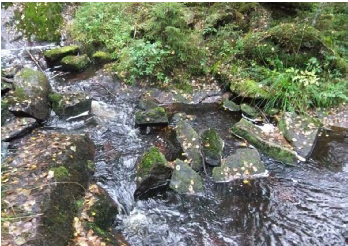
Figur 108. Bruzaån 56, De stenfötter som bar kvarnöverbygganden är idag utrasade i Kvarnbäcken. Fotot är taget från söder. På denna plats stod kvarnen tvärs över bäcken, förmodligen en enkel skvaltkvarn.
