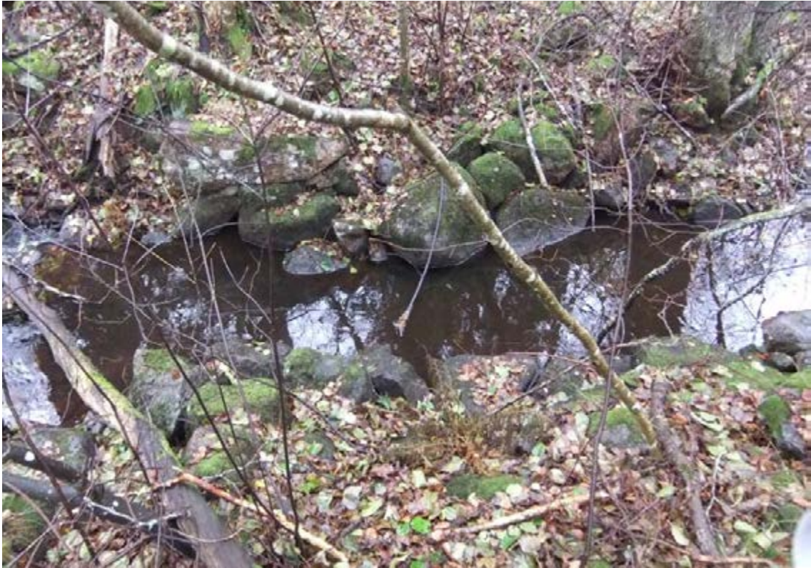
Figur 164. Bruzaån 96. Utskovet som via en vattenränna ledde vatten till vattenhjulhuset i bränneribyggnaden. Enligt den äldre kartan tycks två träluckor ha reglerat flödet till vattenhjulet. Fotot är taget från nordöst.
