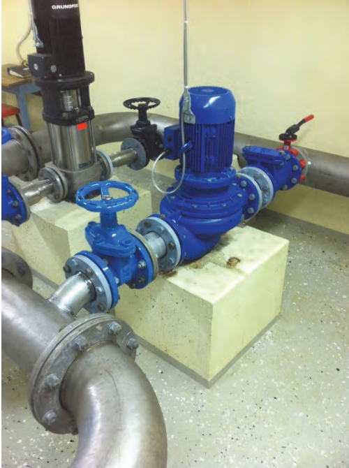
Nyinstallerad vattenpump
