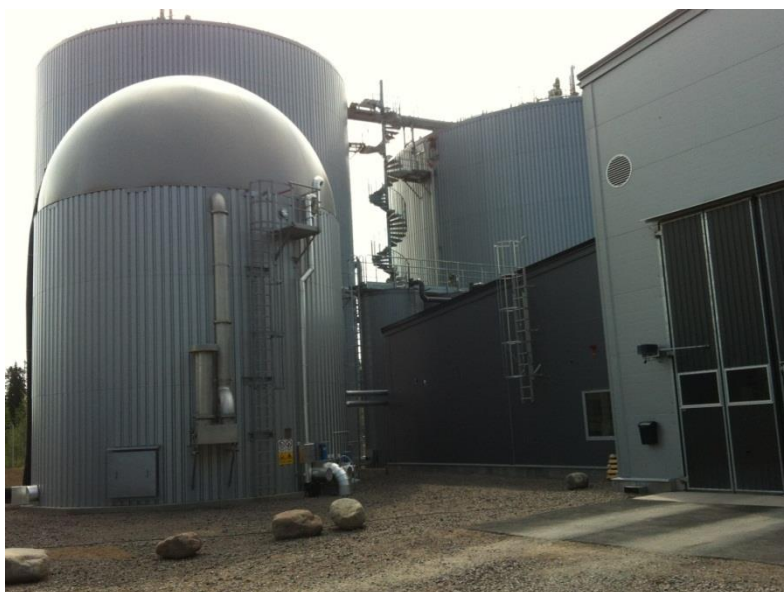
Bild 2. Rötkammaren på Sävsjö biogas.
