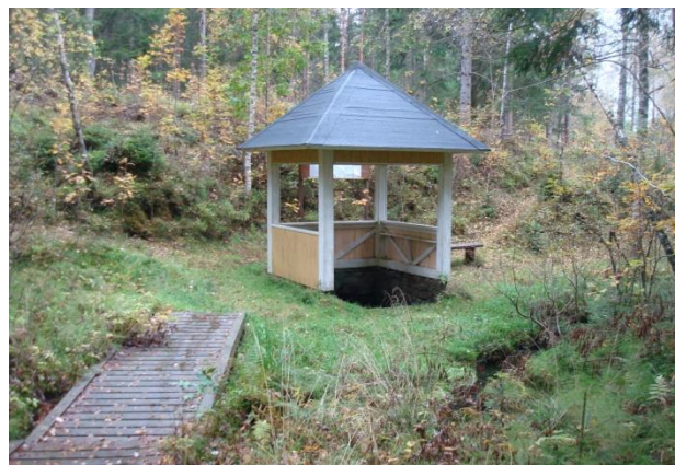
Fig. 7-6 Huvudkällan vid Villstads brunn är stensatt och överbyggd med ett brunns hus 3,5x3 m. (Foto H. Kinnerberg 2014)
