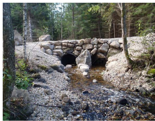
Foto Per Ingvarsson, Naturcentrum. Vägtrumma vid Södragårdskvarn före och efter.
