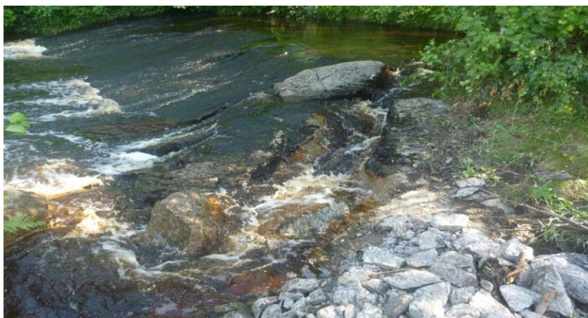
Figur 7. Foto över fiskvägen som "mejslats ut" i en del av en naturlig håll i Hökesån.
