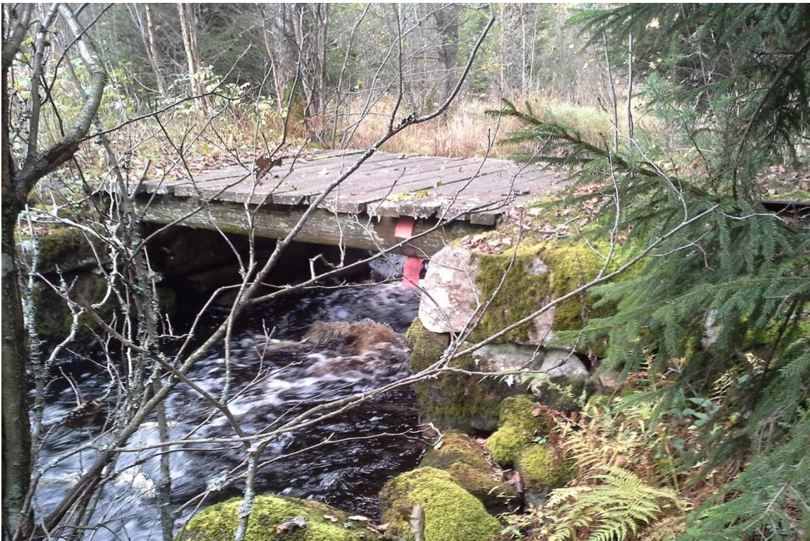
Figur 26. Nuvarande öppning i dammvallen, Objekt Helge å 13.
