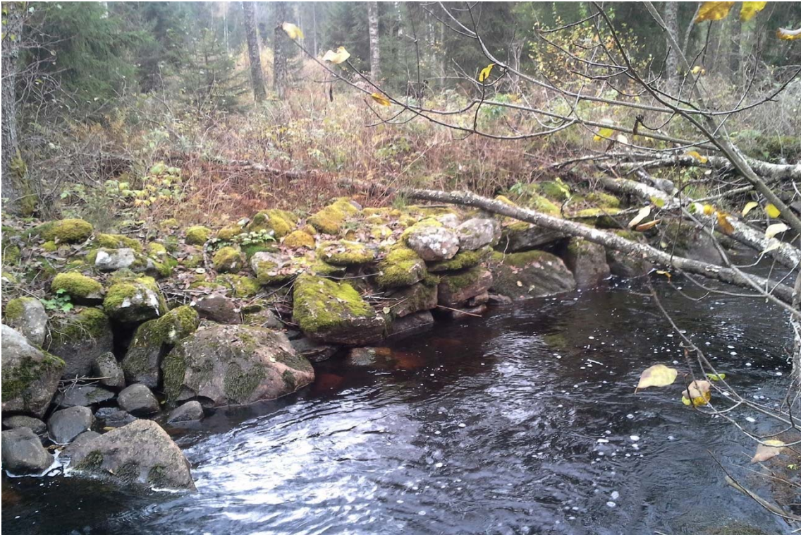
Figur 33. Del av Objekt Helge å 15, på åns östra sida.
