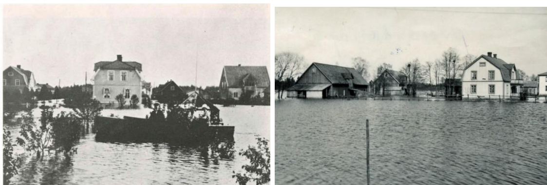
Foto 1. Till vänster: Översvämning 1927 i Värnamo, Tolls Trädgård vid Lasarettsgatan 3 . Till höger: Bild från översvämningar 1951 i Kävsjö samhälle. 4
