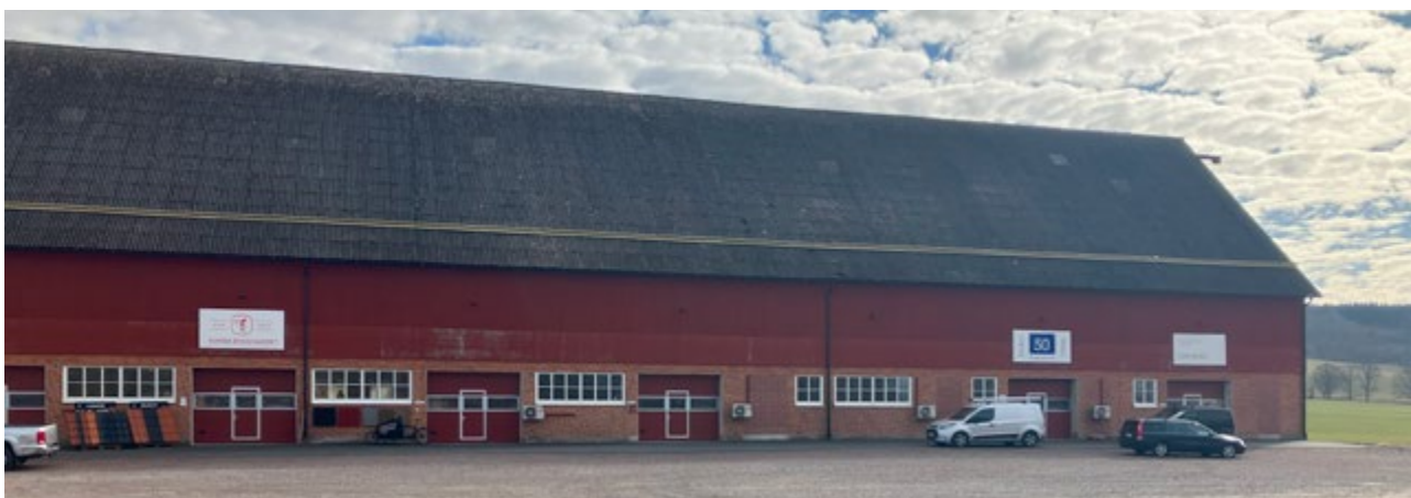
Ladugården på Lyckås f.d. säteri har ansenliga dimensioner. Lokalerna renoverades för några år sedan och hyrs nu ut till olika företag. Bland annat har Sunda Byggvaror sin butik här.
