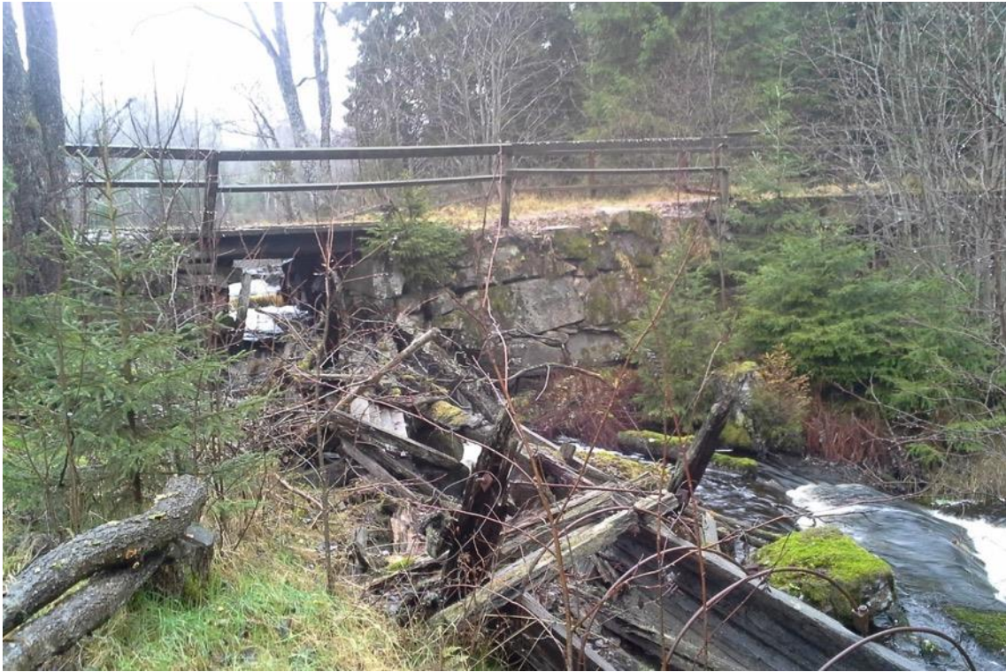
Figur 52. Dammvallen och resterna efter den trätub som försett anläggningen med vatten.
