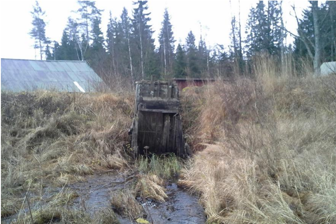
Figur 40. Den nästan helt tömda dammen vid Kyllefors snickerifabrik, sedd från insidan.
