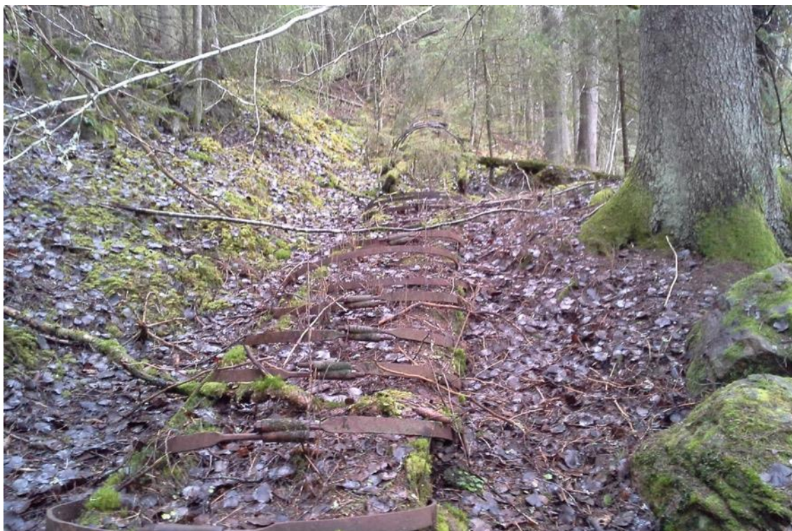
Figur 22. Resterna av den trätub som förde vattnet från dammen i Åsafors ner till massafabriken.
