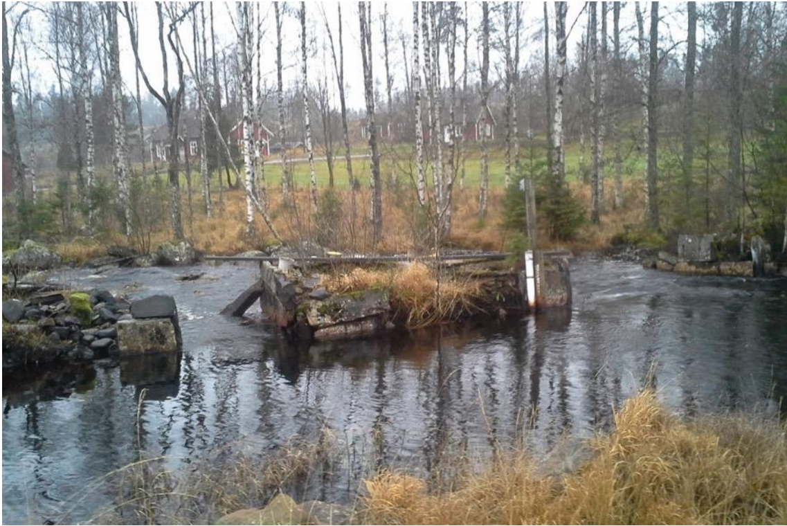
Figur 73. Vattendelaren uppströms Åby snickerifabrik.
