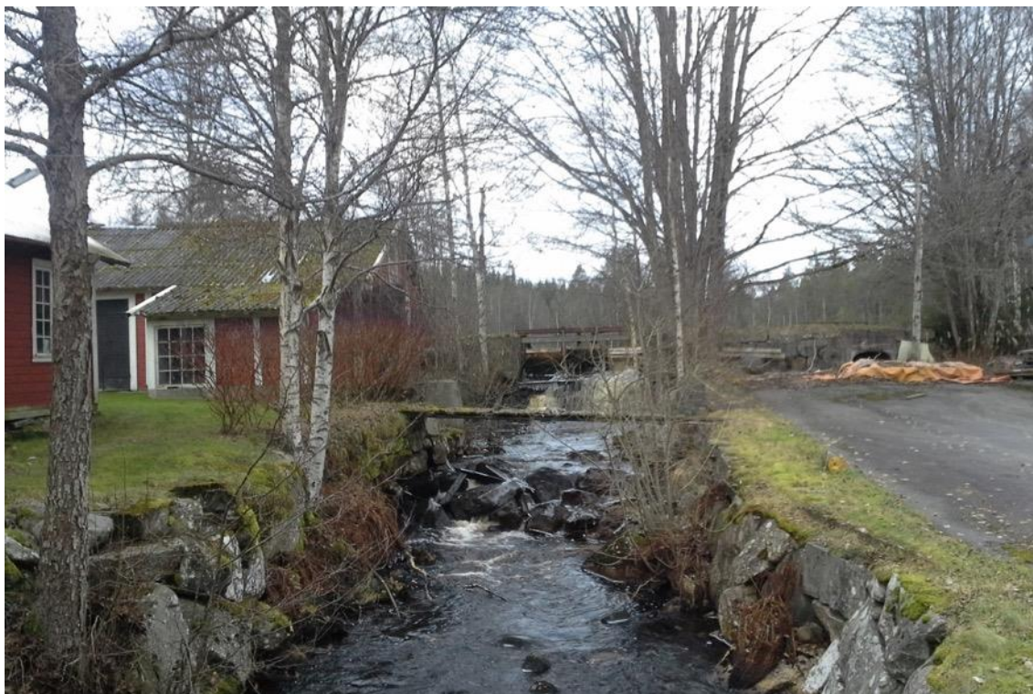
Figur 35. Del av den gamla vattenkanalen vid Bergfors snickerifabrik.
