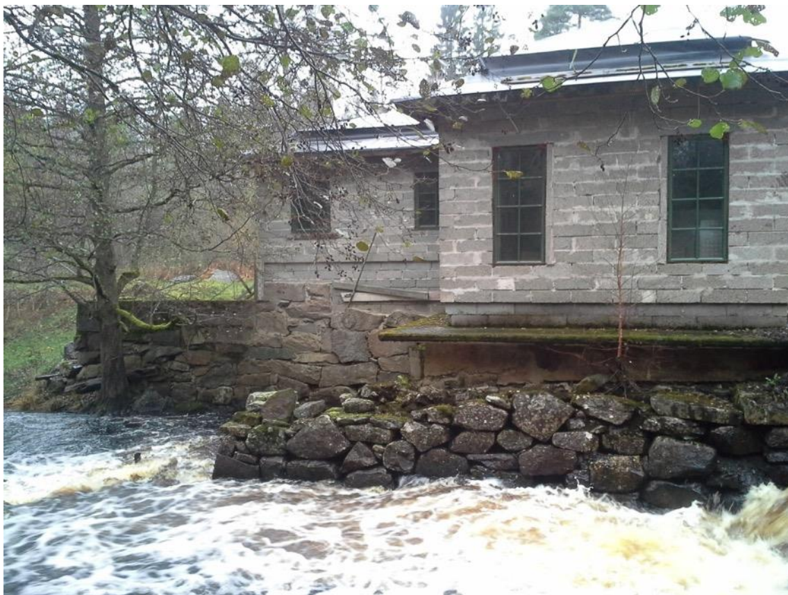
Figur 102. Hultaströms kvarn. Här syns tydligt hur den nya kraftstationen vilar på kvarnens gamla grund.
