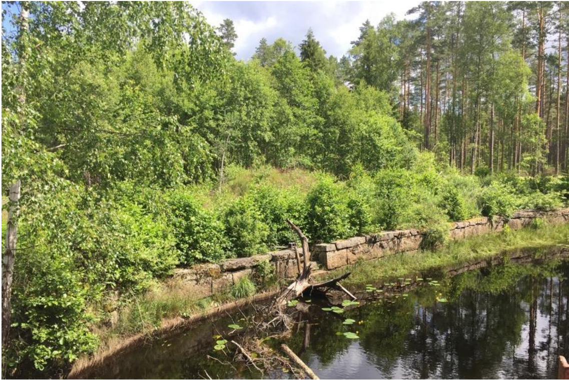
Figur 107. Den norra fördämningsvallen uppströms Hultaströms kvarn.
