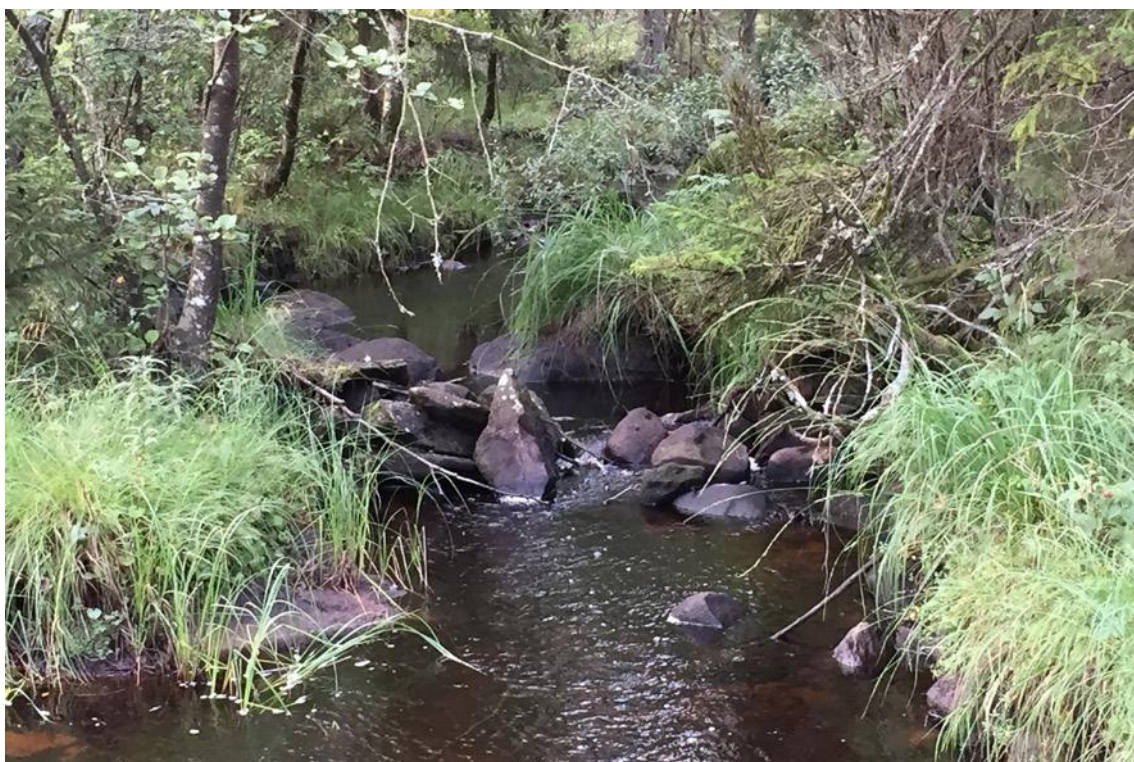
Figur 30. En av de reglerande dammarna.
