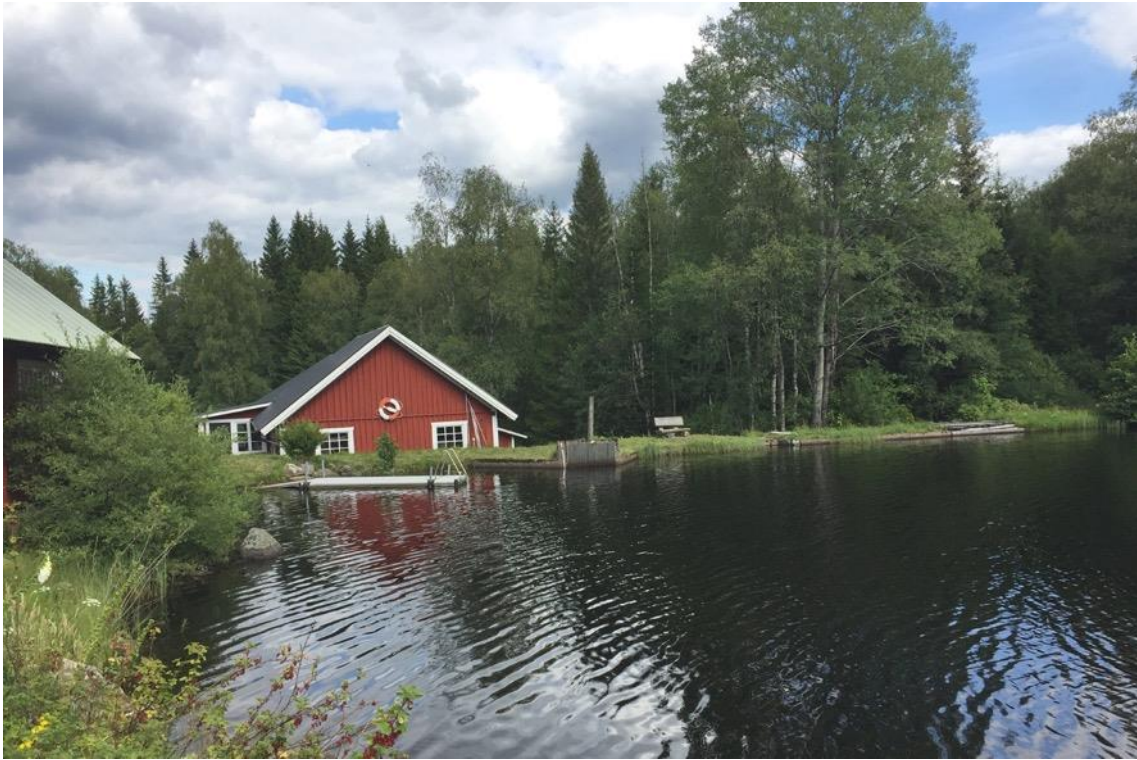
Figur 28. Hultafors sett från söder med del av dammen i förgrunden.
