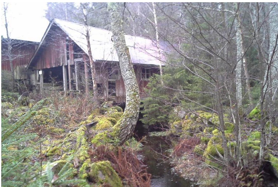
Figur 3. Sågen vid Ålaryd, Objekt Västerån 34, sedd från söder.
