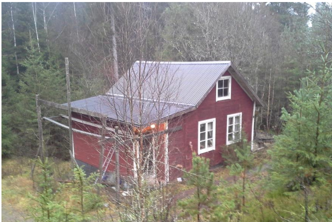
Figur 66. Åkrokens kraftstation, Västerån objekt 10.
