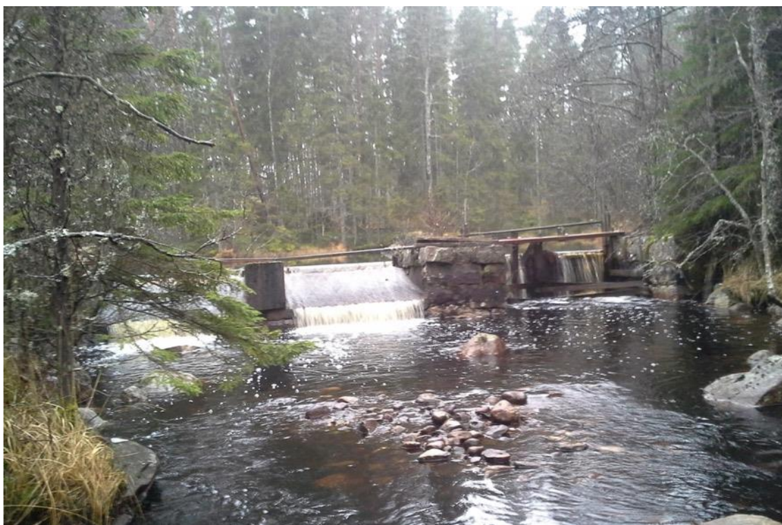
Figur 68. Dammvall med överfall för frivatten uppströms Åkrokens kraftstation.
