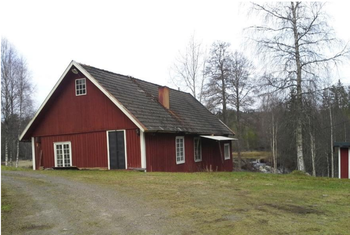
Figur 36. Ängsfors snickerifabrik, i bakgrunden syn resterna av dammvallen.
