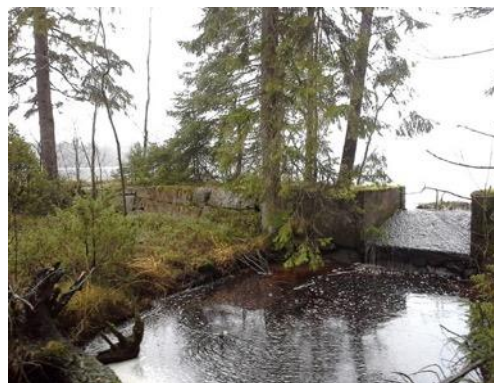
Figur 47 & 48. Dammvallen, Västerån 1, samt närbild av öppningen med överfallsfunktion.
