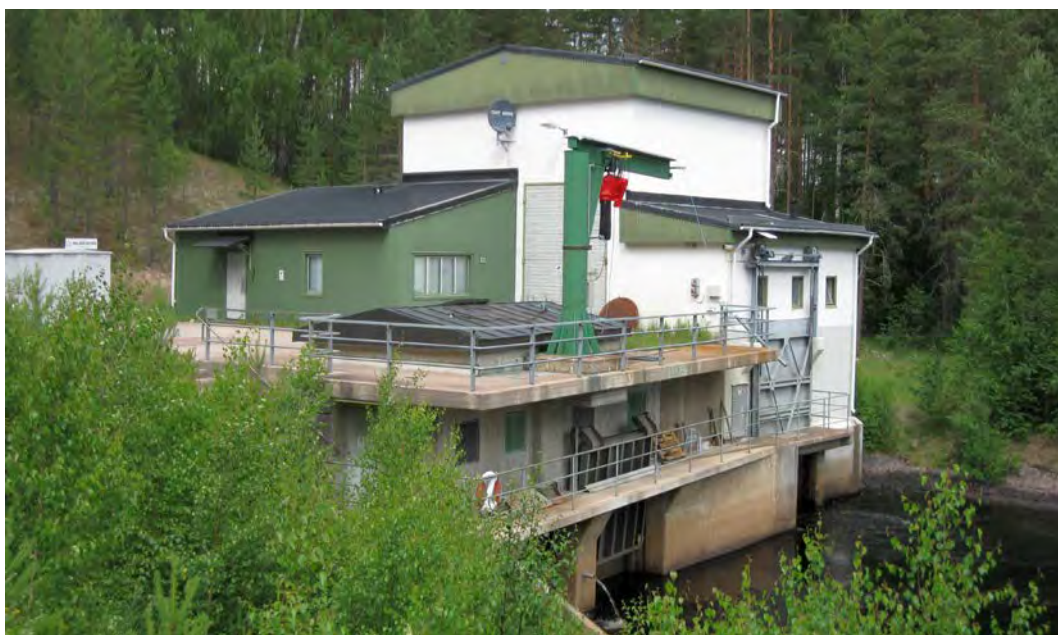
Furudal kraftverk (Foto: Anders M, Lst Dalarna 2009).
