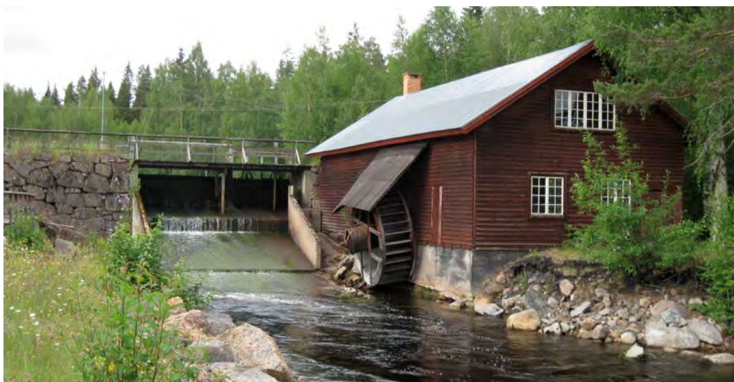
Kraftstationen brukar samma dammvall som Dådrans spiksmedja, ett byggnadsminne. Kraftstationen ligger utanför bild, till vänster (foto: Anders M, Lst Dalarna 2010).
