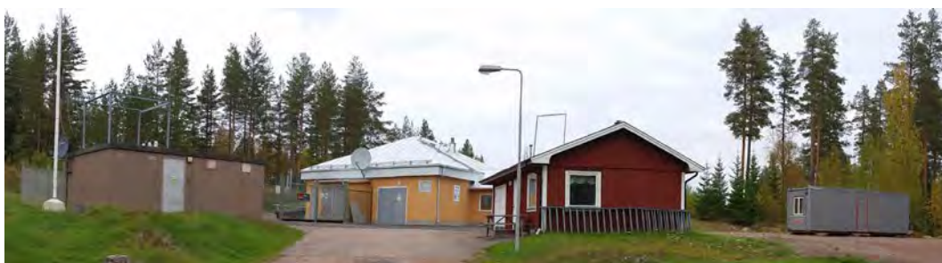
Kraftverksbyggnaderna (Foto Benedict Alexander, Lst Dalarna, 2016)
