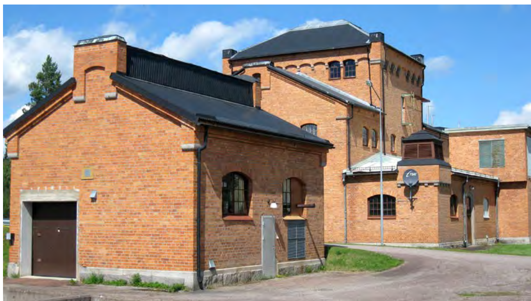
Mockfjärds gamla kraftstation. Takplåten har bytts ut efter bilden togs (Foto: Anders M, Lst Dalarna 2010).
