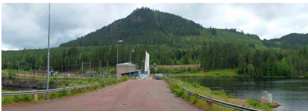
Väsa kraftverk och dammanläggning. I bakgrunden syns berget Gnupen (foto: Benedict Alexander, Lst Dalarna 2016).
