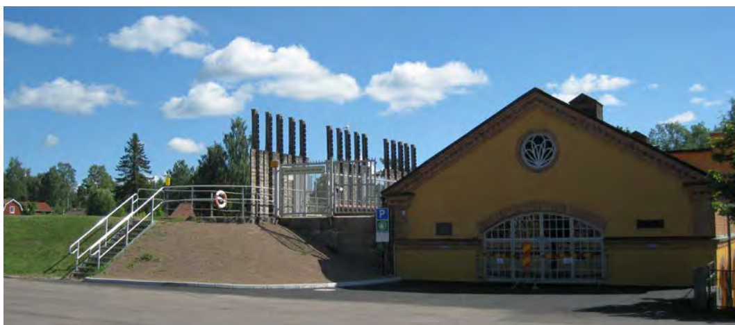
Sundborns kraftstation (foto: Anders M, Lst Dalarna 2010).
