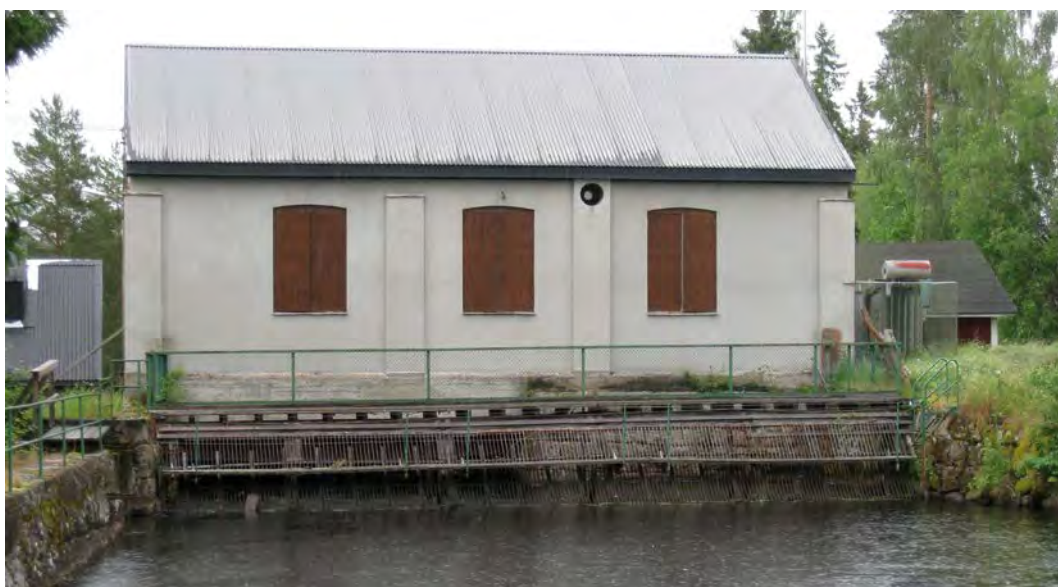
Skiffsforsens kraftverksstation (Foto: Jonas B, Lst Dalarna 2009)
