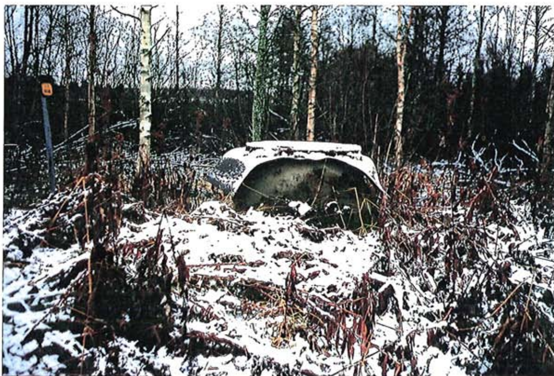
Bild 3.1.2 Höjd avloppsbrunn med tätning
