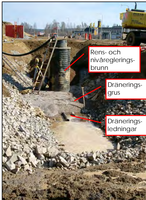
Figur 22. Anläggningsarbeten för uppsamlingsanordning vid väg 50.
