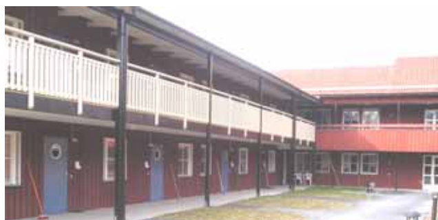
Hedemora kommun Hedbygatan 2A, 12 lägenheter totalrenoverade med Komfortavräkningsystem. Foto Hedemorabostäder
