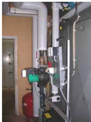
Oljepanna bytt till fjärrvärme
