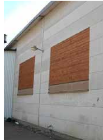
Fönster har tagits bort och isolerats för att minska värmeförlusterna
