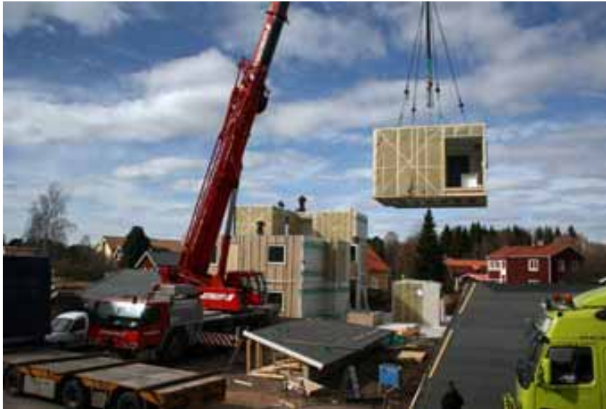
Modulerna ställs på plats i kv. Rättvisan
