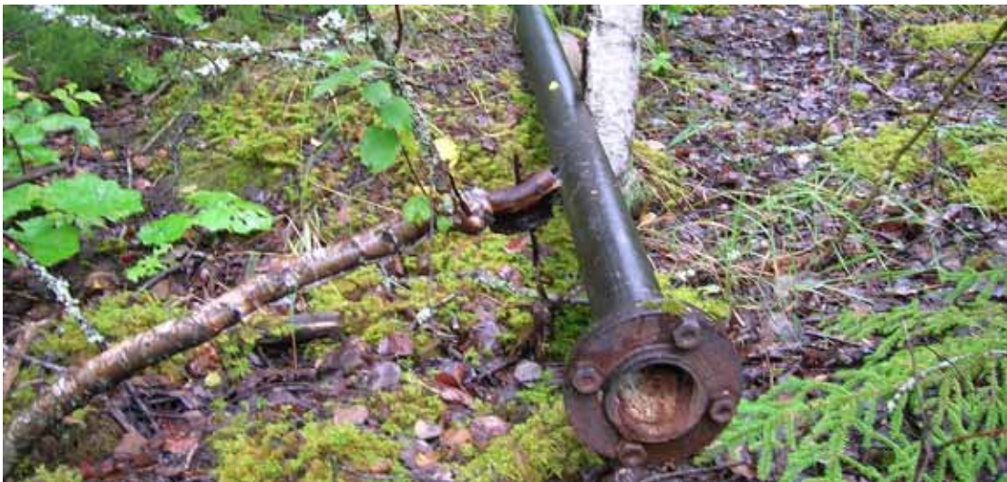
Första mesadammen. Delar av ledningen som mesan pumpades i finns kvar.
