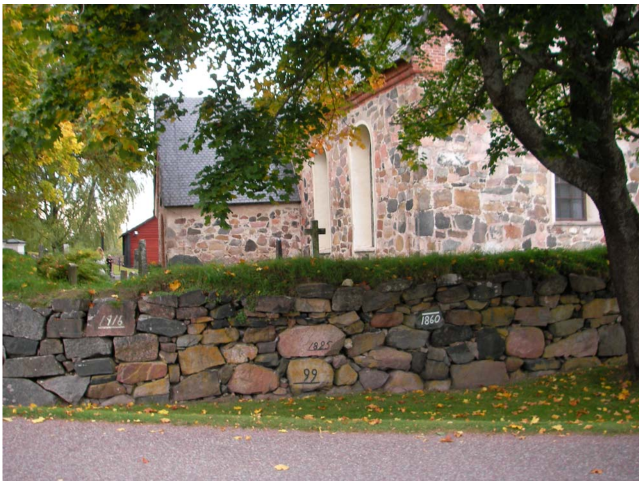
Kyrkmuren i Torsång har olika markeringar för vattennivån vid tidigare översvämningar. År 1728 låg 18 båtar förtöjda vid vapenhusdörren under högmässan, men den markeringen finns inte med på muren. Foto: Arne Ludvigsson, Borlänge Kommun
