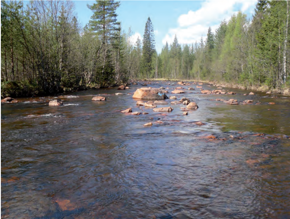
Aspvasslan efter åtgärd. Foto: Anders Bruks
