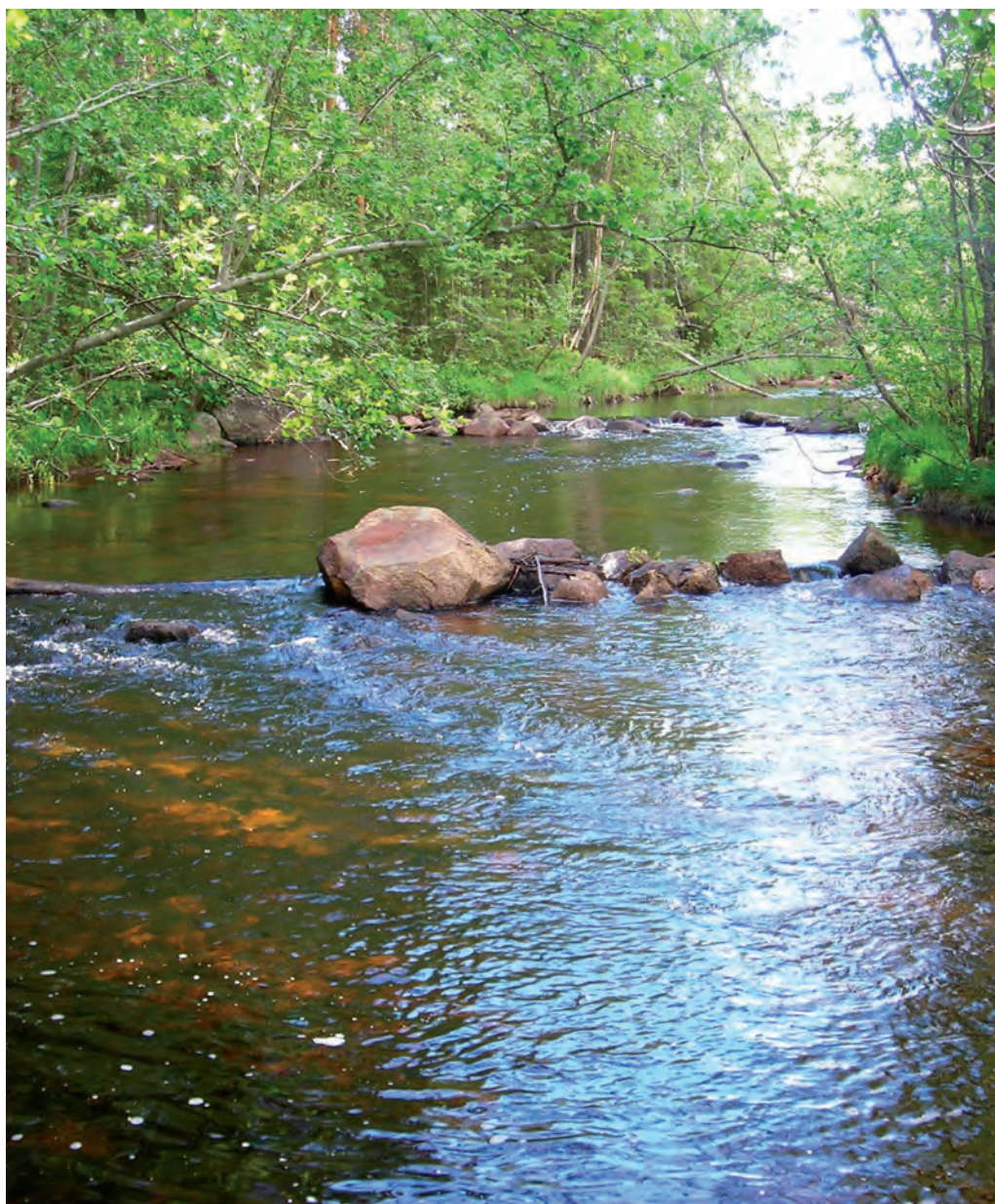
Limån, äldre felaktigt utförda åtgärder.
