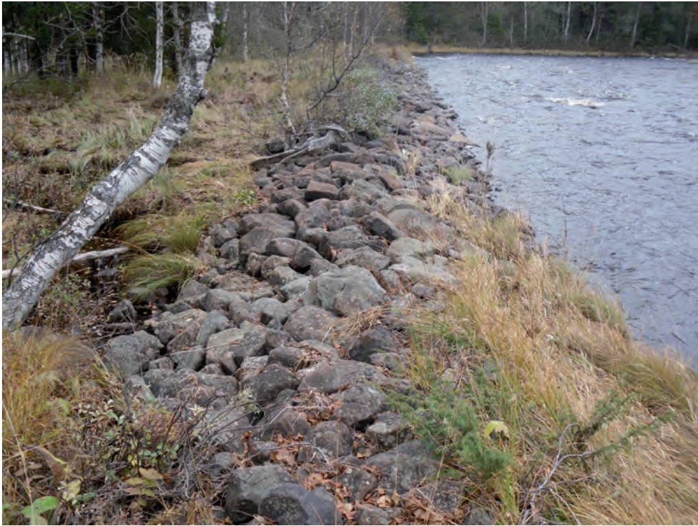
Ogströmmen uppströms Ogsjön, stort åtgärdsbehov. Foto: Anders Bruks
