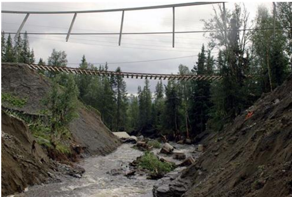
Bortspolad järnvägsbank efter skyfall vid Ånn i Jämtland 2006. Foto genom MSB.
