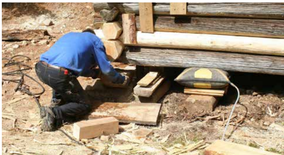
Ladan lyfts med hjälp av kuddar av armerat gummi som blåses upp med tryckluft.
