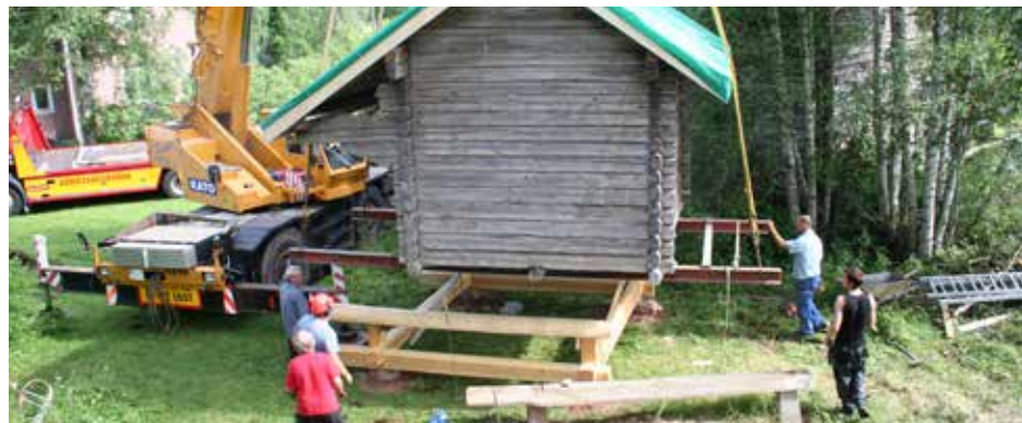
Härbre flyttas till nytt stolpunderrede
