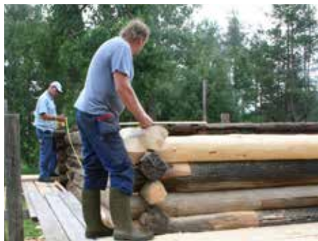
Härbre flyttas till nytt stolpunderrede
