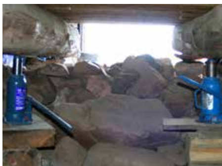
Här har man använt två små domkrafter för att lyfta byggnaden.
