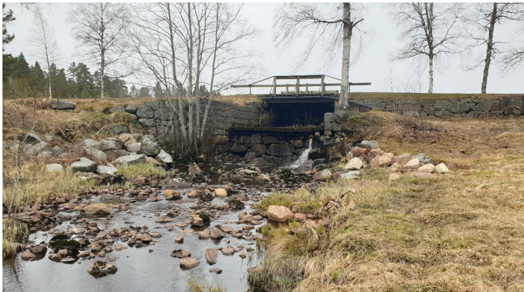
Figur 10 Dammvallen (L2000:7350) med tydliga äldre strukturer vid utskov. Foto åt NÖ.
