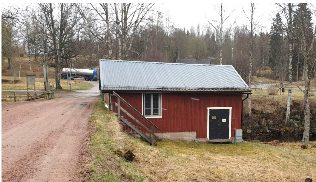
Figur 15 Kraftstationen samt dammvall (L2000:7350). Foto åt SÖ.
