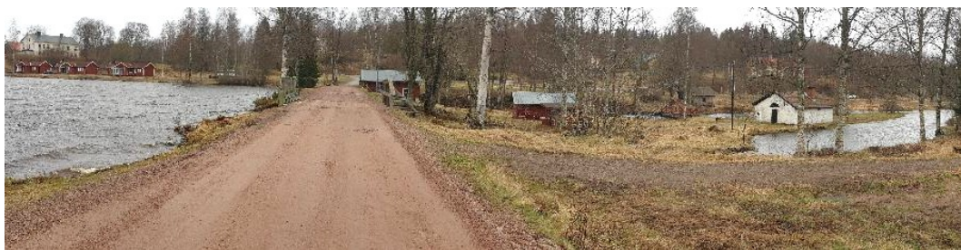
Figur 7 Panorama av bruksmiljö. Till vänster skymtas herrgården, centralt är dammvall (L2000:7350) och till höger syns bland annat kraftstationen samt smedjan.
