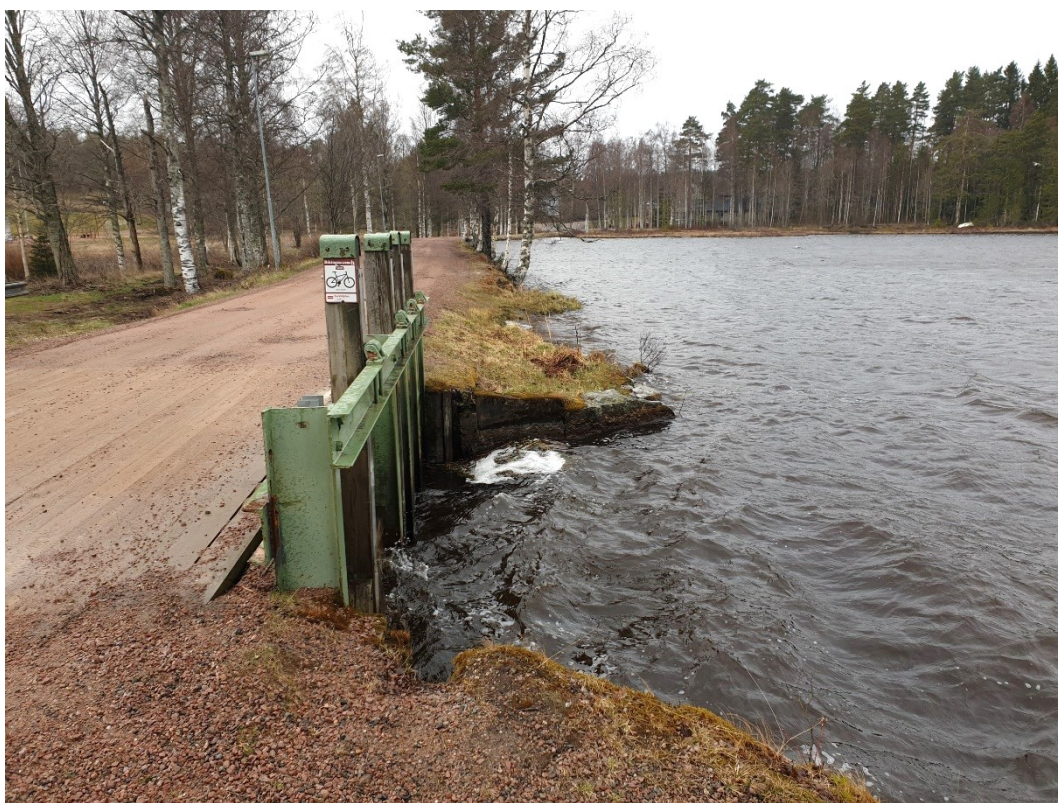
Figur 9 Dammvall (L2000:7350) med lucka. foto åt NV.
