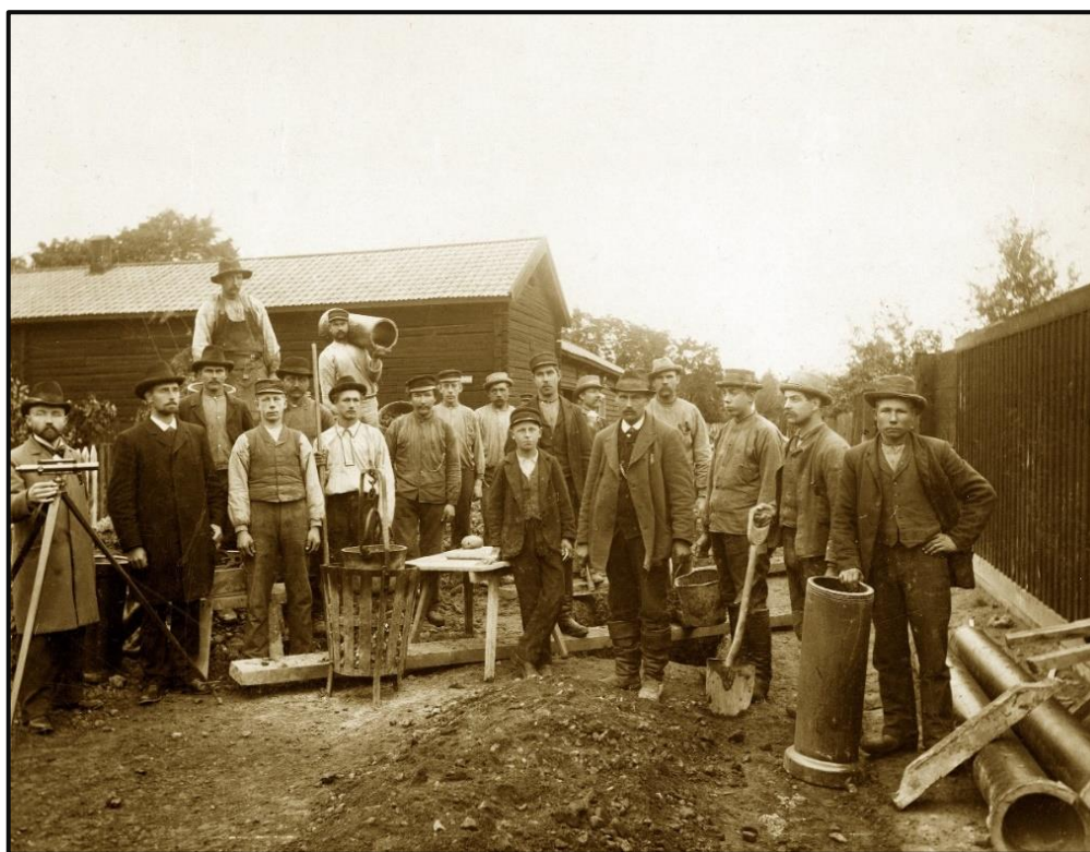
Figur 1. Anläggande av vattenledning i Falun 1889, hörnet Trotzgatan-Bergskolegränd. Foto: Märta Bohman (Dalarnas museums bildsamling).
