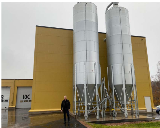
Staffan Eklöv framför silorna och ångpannecentralen.
