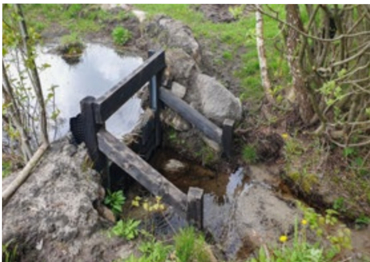
Nyanlagt reglerbart dämme vid dike i Skåne. Foto: Anette Persson
