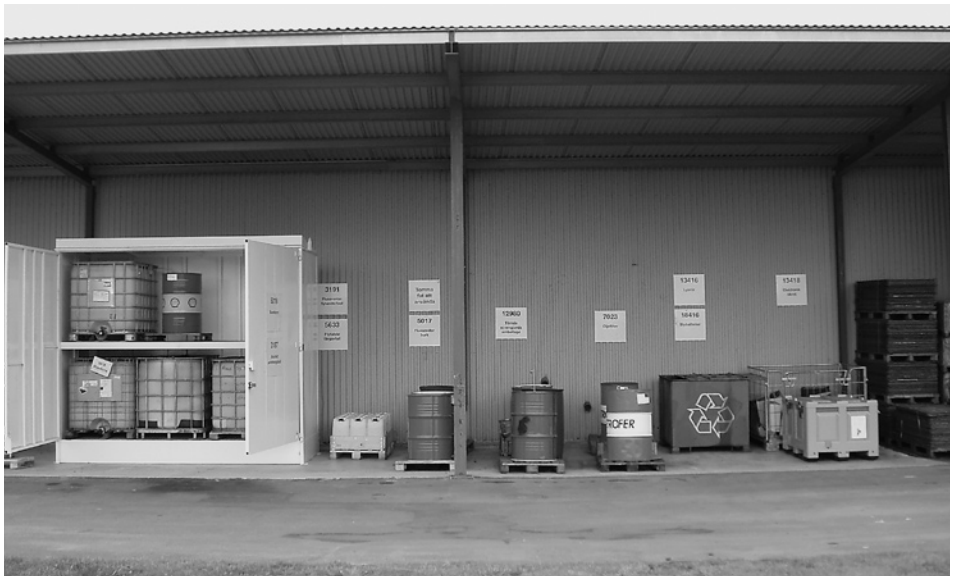
Utomhusförvaring av farligt avfall. Betongytan där avfallet förvaras på sluttar inåt. På väggen finns skyltar som tydligt visar var respektive avfall ska förvaras. Bilden är tagen hos Valeo Engine Cooling AB.
