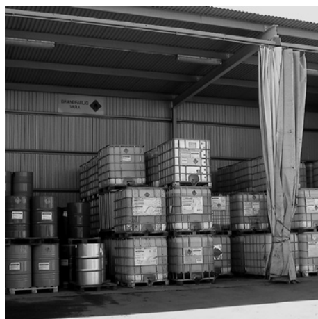
Utombusförvaring av kemikalier. Golvet är lutande inåt med uppsamlingsränna. Draperi används som skydd mot nederbörd. Bilden är tagen hos Swed Handling AB
