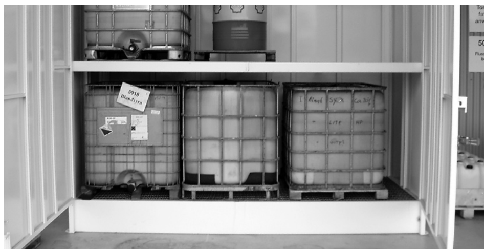
Förvaring av farligt avfall utombus i en miljöcontainer. Golvet i containern har utrymme för uppsamling av spill. Miljöcontainrar finns i flera utföranden och storlekar. Bilden är tagen hos Valeo Engine Cooling AB
