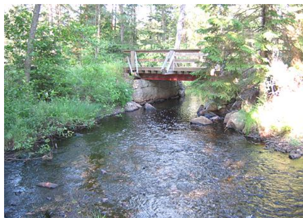
2-12 m uppströms bron.
