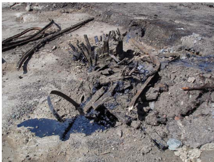
Figur 6.1. Bild från saneringsarbetet vid Fiskeby
