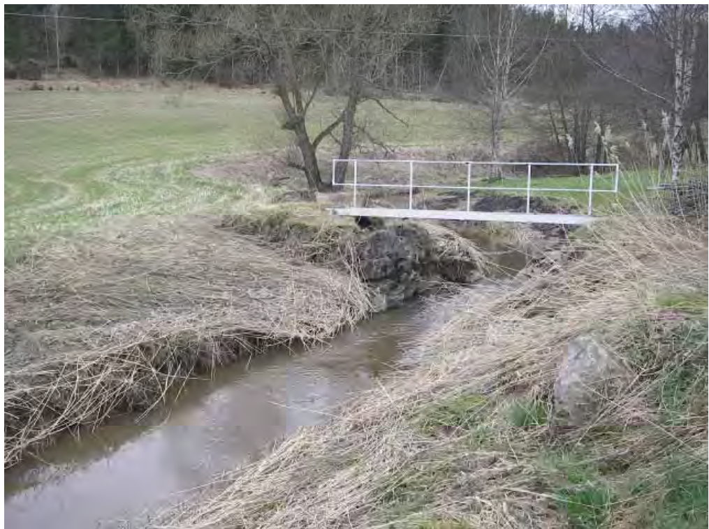
Brorest vid Ytterå ca 600m uppströms Ytterbyåns mynning i Gropviken.
