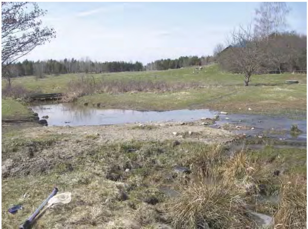
Bild 2. Bäck vid Gåsåker. Igensatt trumma (dräneringsrör) drygt 300m uppströms mynning.
