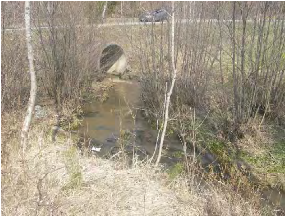
Trumma vid vägen mot Rönö, drygt 1 km uppströms Gottenviksbäckens mynning.
