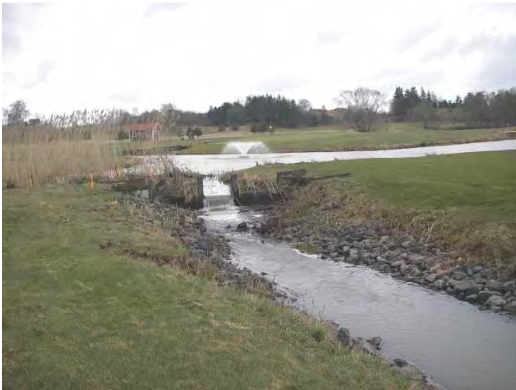
Bild 2. Bäck vid Manhem. Vandringshinder vid damm.
