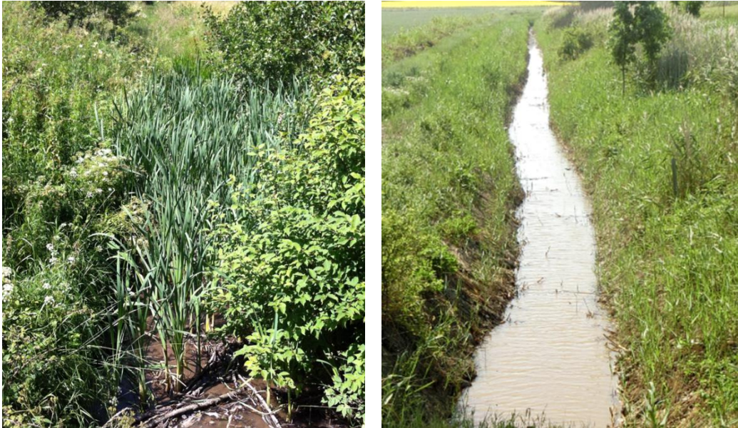
Figur 32. Exempel på kraftigt igenväxt dike och ett dike som underhållits.
