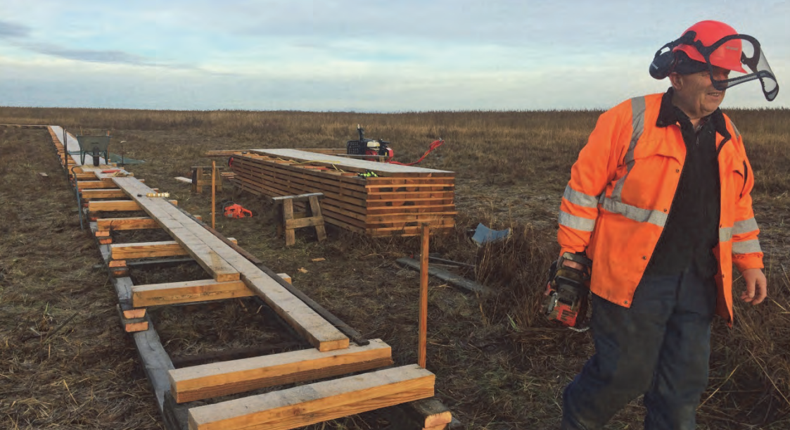
I Tåkerns naturreservat har vi restaurerat och breddat 300 meter spång. Foto: Veronica Axelsson
