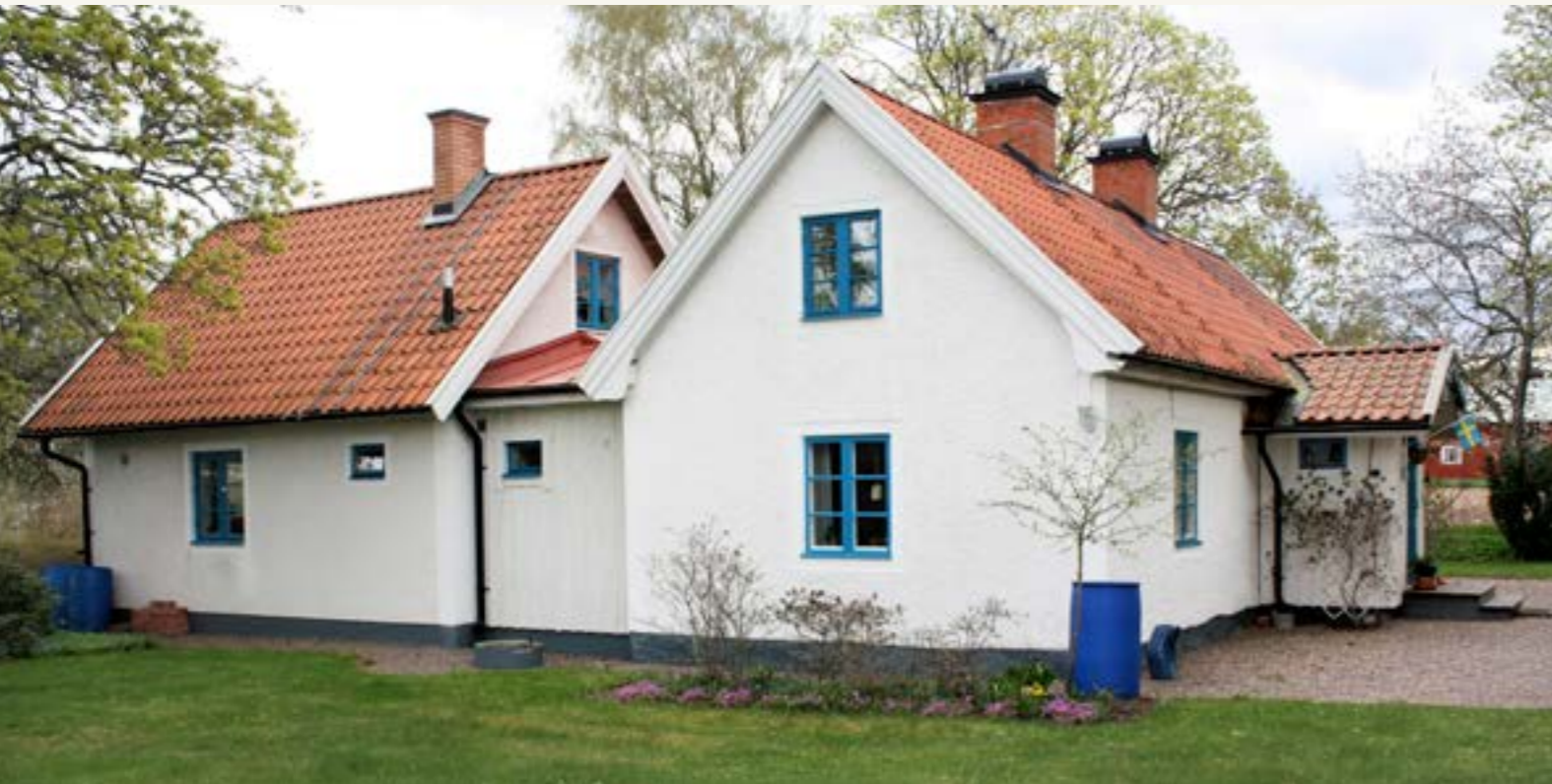
▲ Det ursprungliga huset med farstukvist ut mot vägen har byggts till med en separat mindre byggnad. De båda byggnaderna är sammanbundna med en smal förbindelse.
