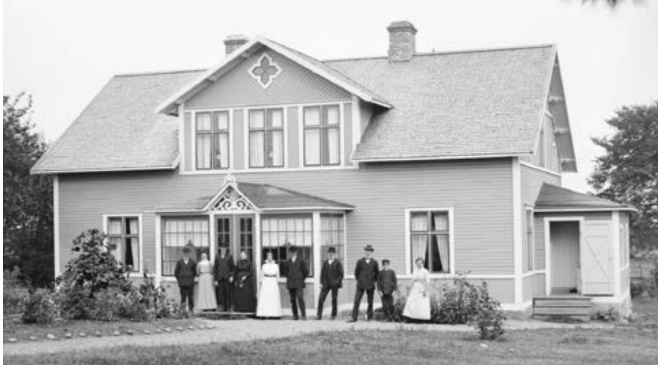
▲ Älmekulla i Västra Ryd omkring 1915. Taket är täckt med stickspån. I frontespisen syns ett vindsfönster från Landtmannabyggnader hufvudsakligen för mindre jordbruk . Foto: A C Hultgren/Östergötlands museum.
