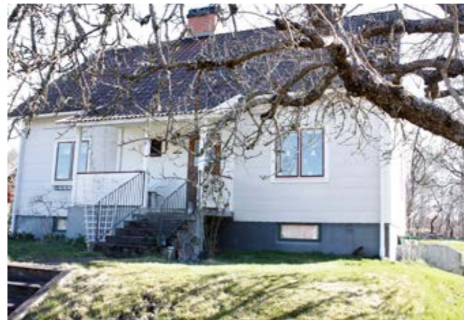
◀ Ett nytt bostadshus uppfördes 1956 vid Gatekulla i Östra Tollstad. Fasaden kläddes med eternitplattor. Även fönster och dörrar är ursprungliga.
