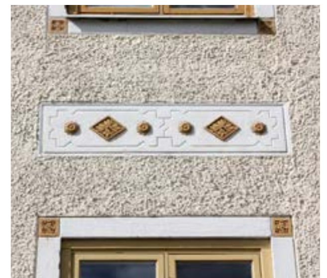
▲ Detalj från sockenstugan/skolan uppförd på 1840-talet vid Risinge nya kyrka och ritad av Abraham Nyström.
