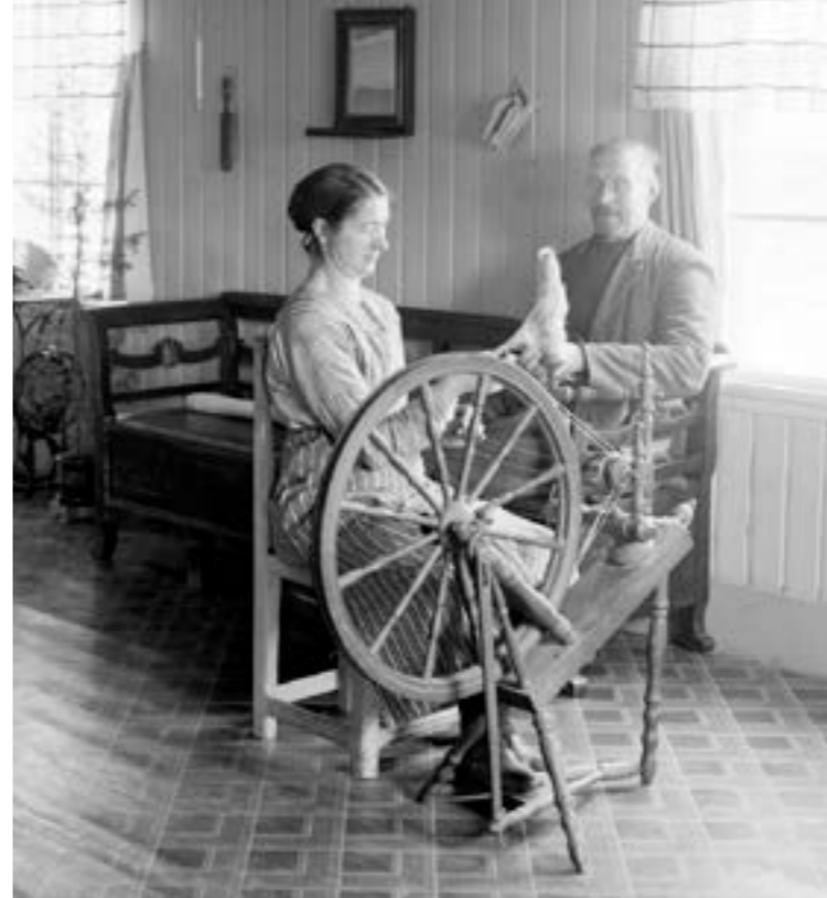
◀ Denna interiör, troligen från slutet av 1920-talet, visar pärlspontad panel på väggarna, en bred och enkel golvsöcket samt linoleummatta på golvet. Foto: A C Hultgren/Östergötlands museum.
