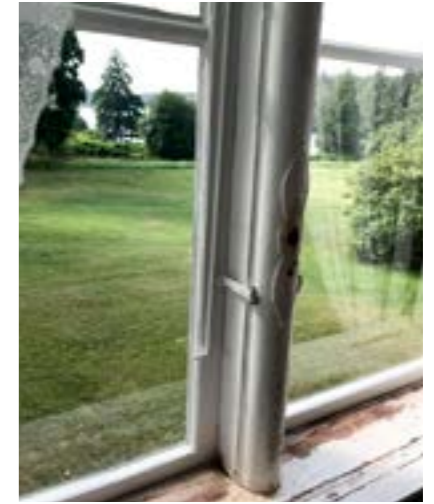
▲ Exempel på smäckra fönstersnickerier.
