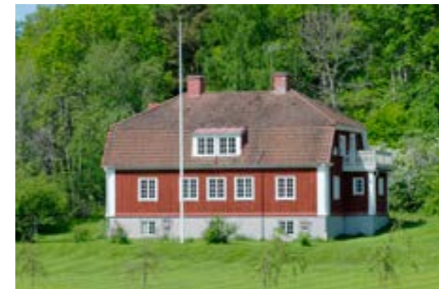
▲ Skällviks prästgård byggdes omkring 1920 med tegeltäckt brutet tak med valmade gavelspetsar. Foto: Lars Ekelund/Länsstyrelsen.
