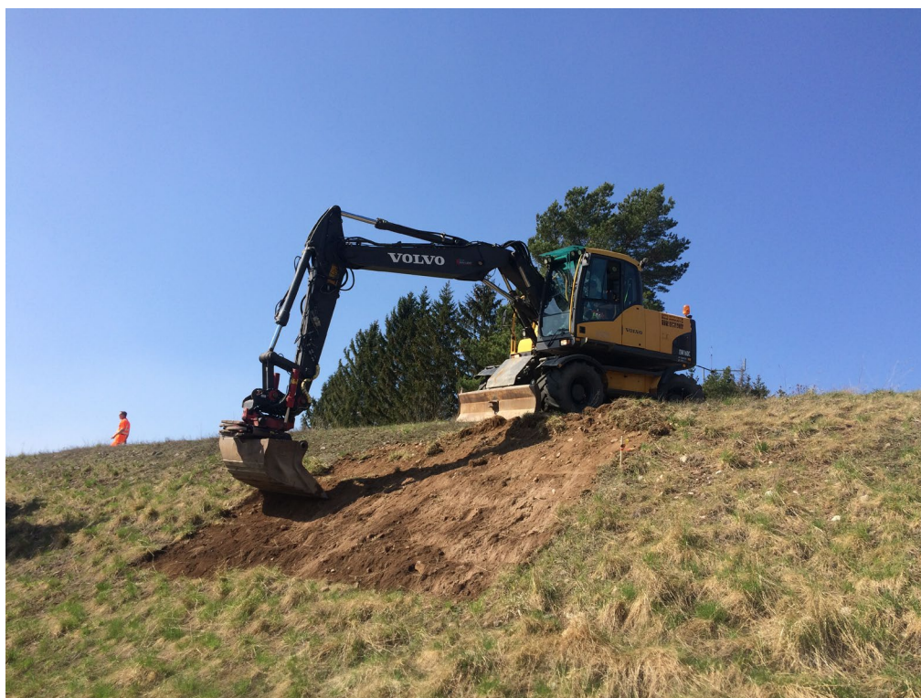
Figur 16. Schaktning vid Rosens backe (9) våren 2018. Foto: Tommy Karlsson.
