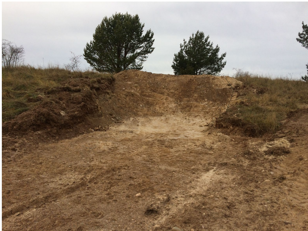
Figur 39. Nygård efter schaktning, hösten 2016. Foto: Tommy Karlsson.
