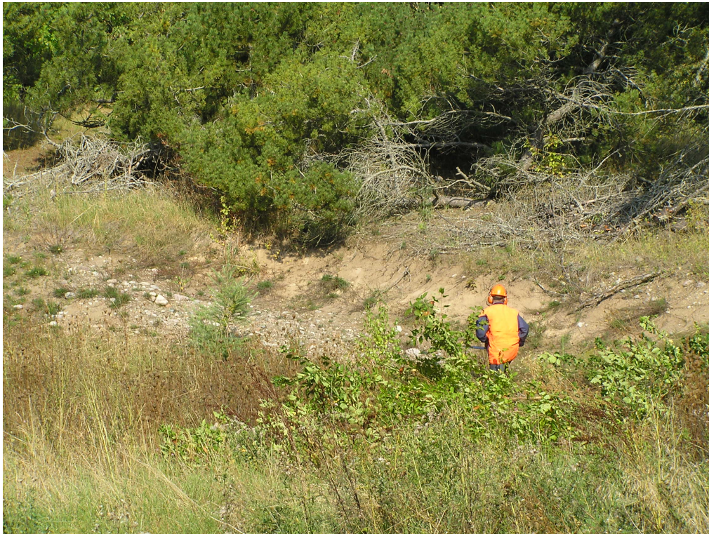
Figur 80. Alvastra rastplats under pågående röjningsarbete. Foto: Tommy Karlsson.
