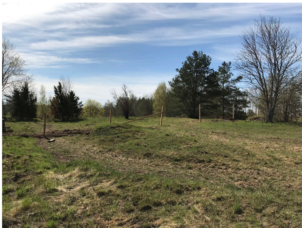
Figur 50. Pågående stängselarbete i Eketorpet våren 2020. Marken har bränts och röjts tidigare under året. Foto: Sofia Almkvist.
