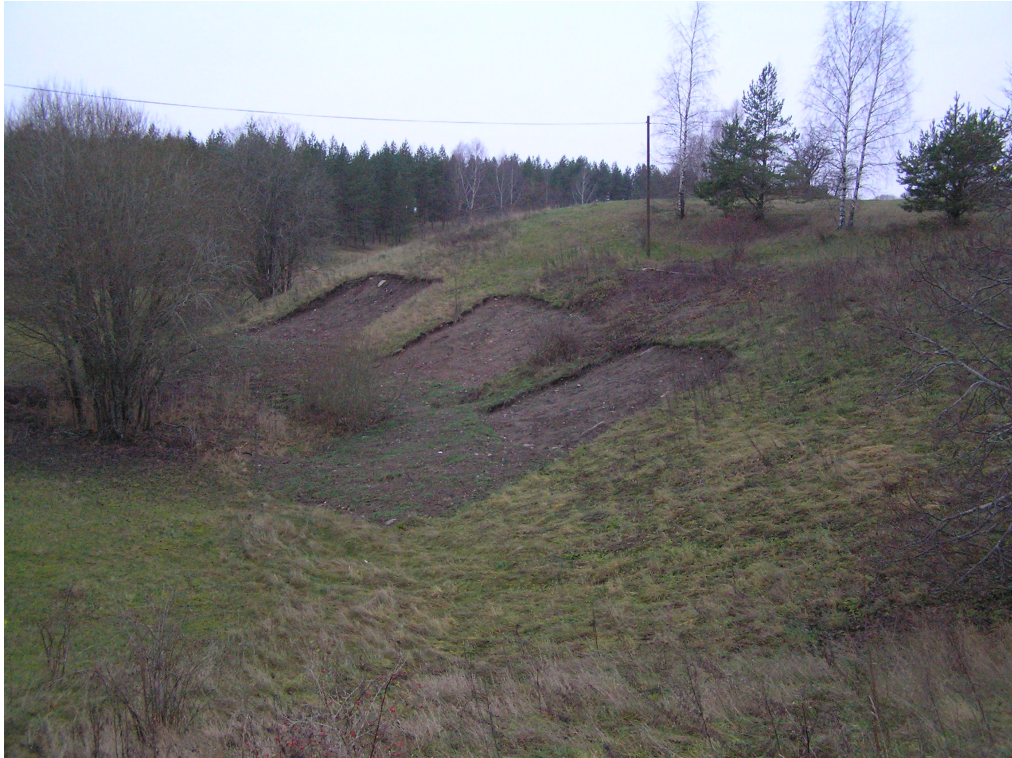
Figur 35. Schaktningar genomförda i Kärrsjö, 2014. Foto: Tommy Karlsson.
