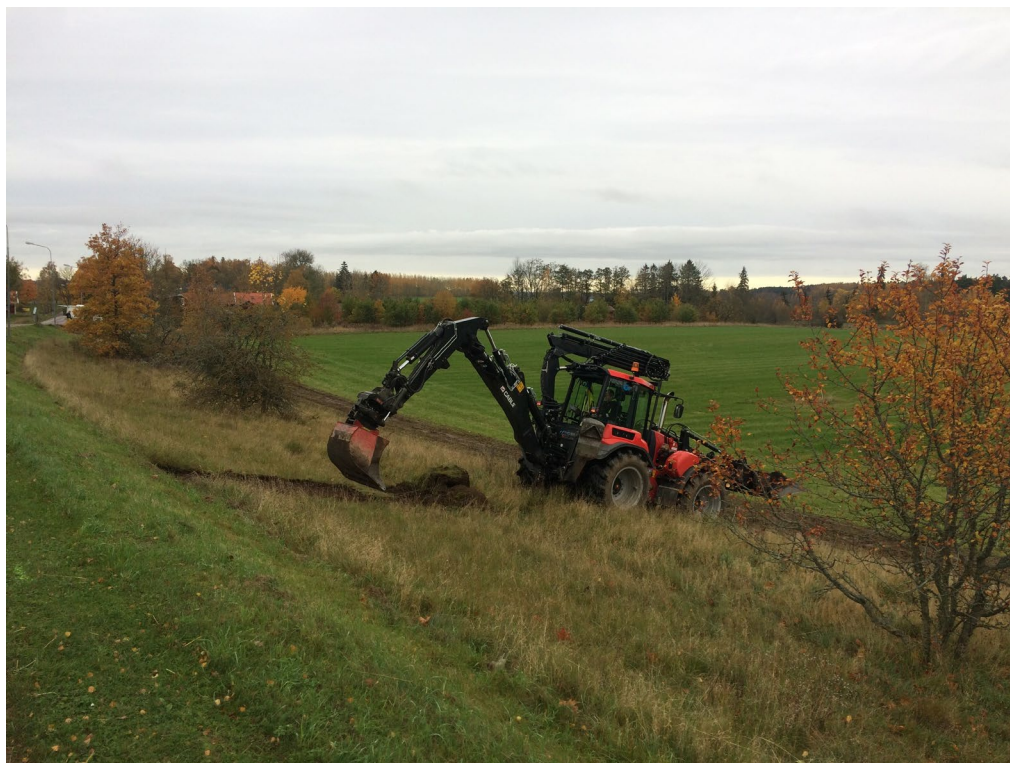
Figur 62. Normlösa väggkant, hösten 2017. Schaktningar gjordes i samarbete med Trafikverket Foto: Tommy Karlsson.
