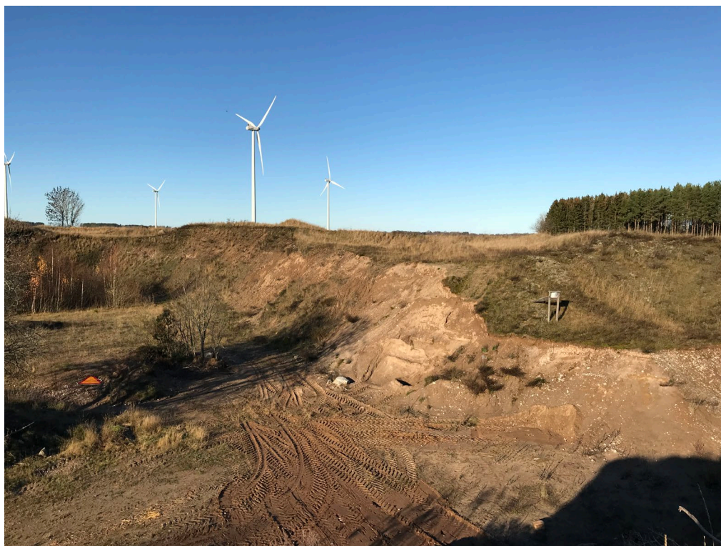
Figur 77. Styratäkten inför restaurering hösten 2019. Foto: Sofia Almkvist.
