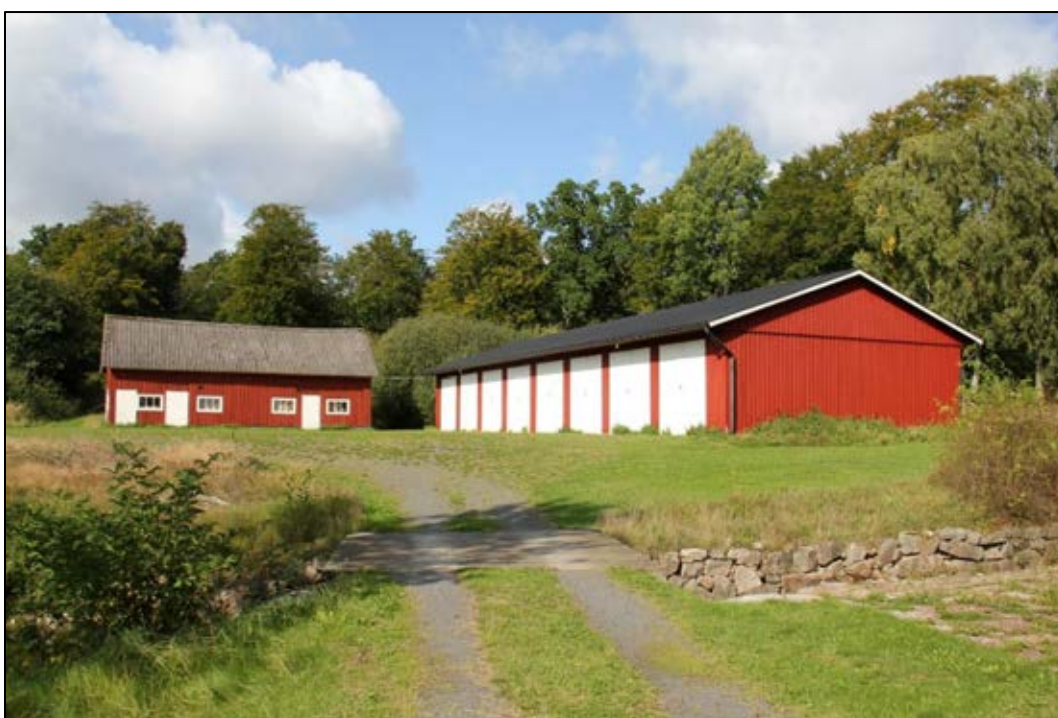
Bild 19. Mitt emot kvarnen, på andra sidan vattendraget, finns ett svinhus som är uppfört under tidigt 1900-tal samt ett husvagnsgarage med åtta fack som ersätter ett gammalt vagnslider. Bakom svinstallet finns en stentipp. Bilden tagen mot väster. Foto: Helena Lundgren
