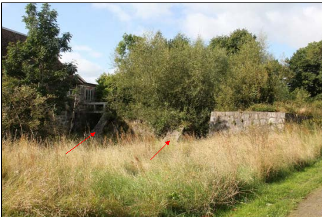
Bild 21. Dammkroppen. Här syns de två strävpelarna (markerade med pilar). Mellan dem fanns tidigare en överfallsöppning bestående av tre delar som troligen gick att stänga med hjälp av sättar. jämför med historisk bild 1. Till vänster om dem finns intagen till vattenhulets intagsränna och till höger om pelarna finns den öppning som finns i dammkroppen som idag släpper igenom vattnet och som även tidigare troligtvis reglerades med en spetlucka. Bilden tagen mot väster. Foto: Helena Lundgren
