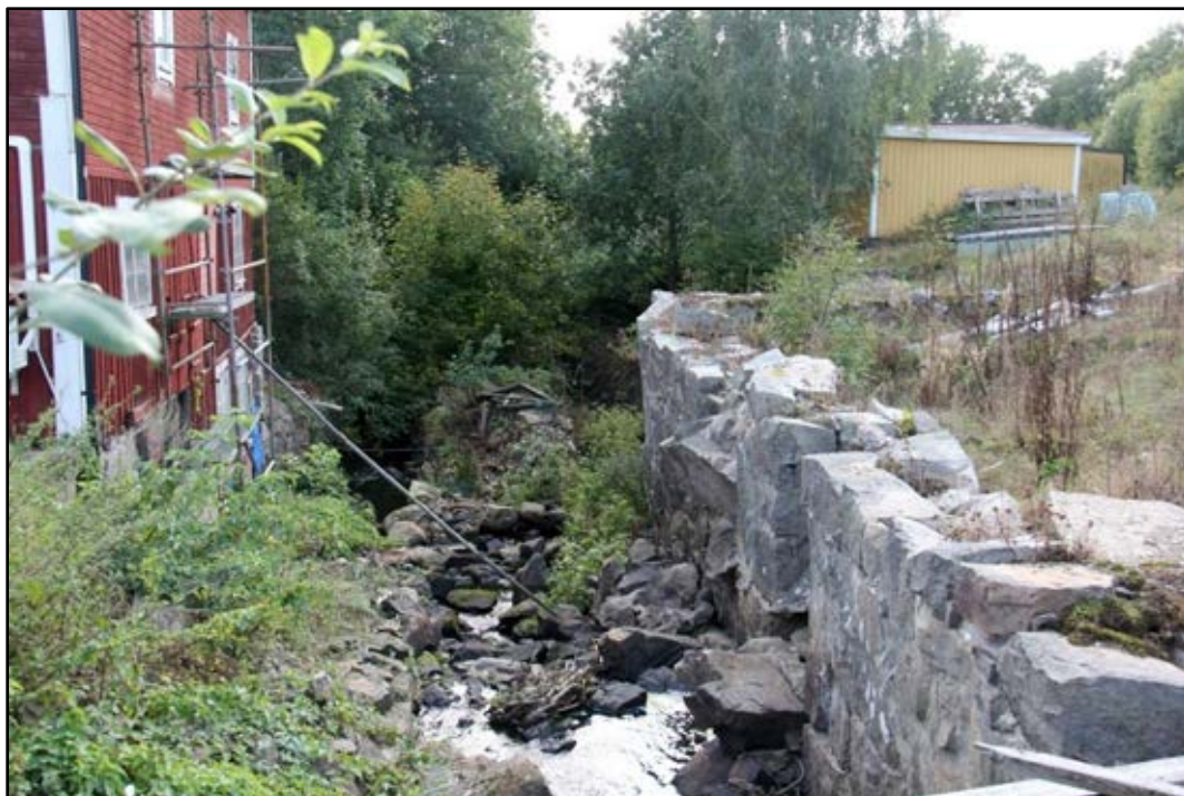
Bild 11. I vattenfåran syns avdelaren med rämnorna på var sida. Foto: Helena Lundgren
