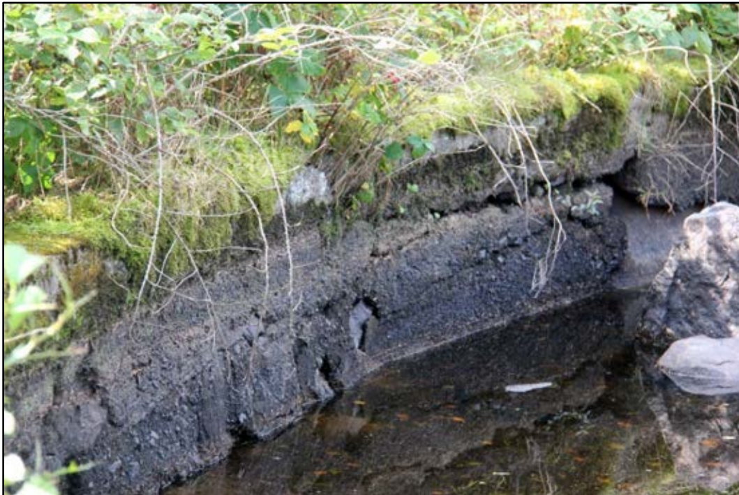
Bild 2. Bild på skoning av betong på västra sidan eller möjligen förstärkning av stenskning med betong. Foto: Helena Lundgren.
