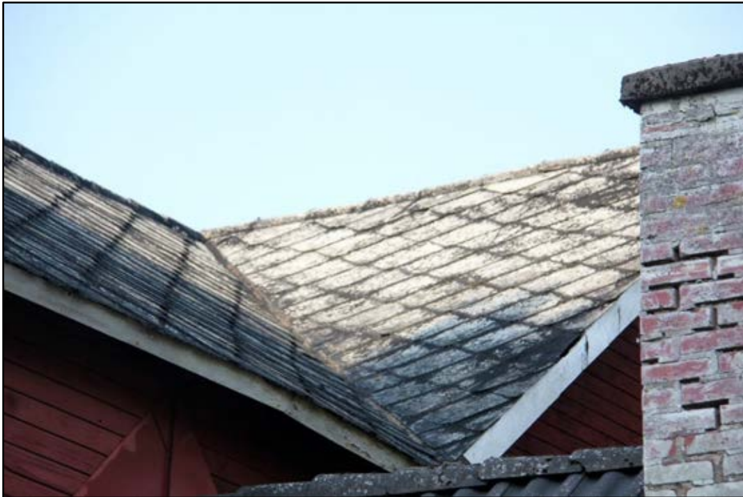
Bild 4. Svingeln i taket mellan två takfall på kvarnbyggnaden klädda med eternitplattor. T. h. syns skorstenen på tillbyggnaden. Foto: Helena Lundgren
