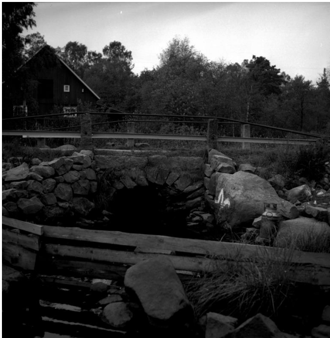
Historisk bild 4. Äldre bild på stenvalsbron som fanns i norra delen av dammen samt stenskoningar. Foto Blekinge
