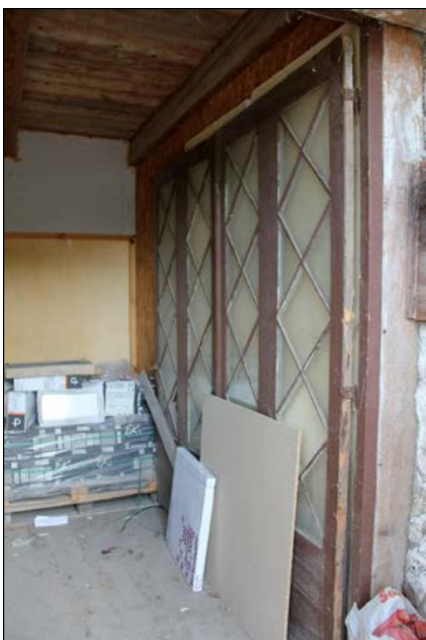
Bild 12. Innanför de kraftiga portarna på byggnadens långsida finns dessa vackra spröjsade vikedörrar som idag står öppna. Detta är mycket ovanligt att man har dubbla dörrar, både ytter och innerdörrar i en kvarnbyggnad och speciellt så arbetade dörrar som dessa. Foto. Helena Lundgren
