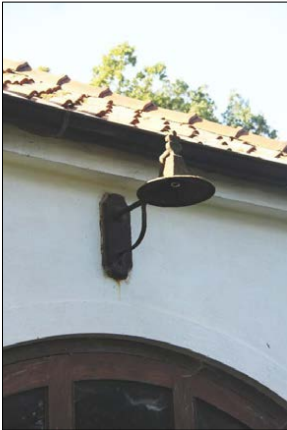
Bild 5. Dekorerad armatur ovanför pumpstationens entrédörr. Foto: Helena Lundgren
