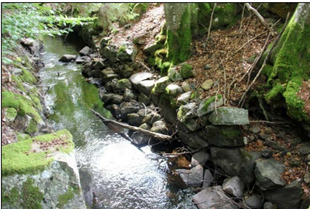
Bild 3. Åfåran är kanaliserad med stensatta kanter, som delvis rasat. Foto: Helena Lundgren
