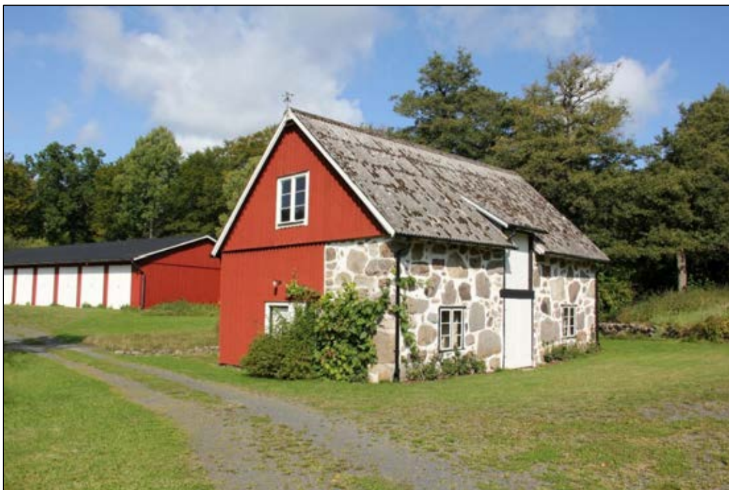
Bild 5. Kvarnbyggnadens södra gavel samt östra långsida. I bakgrunden garagelängan som uppfördes på 1930-talet. Bilden tagen mot norr. Foto: Helena Lundgren
