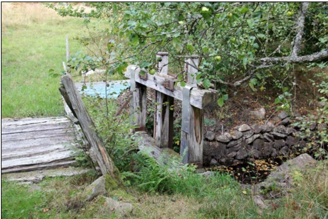
Bild 2. Det västra utloppet från sjön Orlunden regleras med hjälp av två spettluckor av trä. På bilden syns att ån är stenskodd med natursten uppströms regleringen. Bilden tagen mot nordväst. Foto: Helena Lundgren
