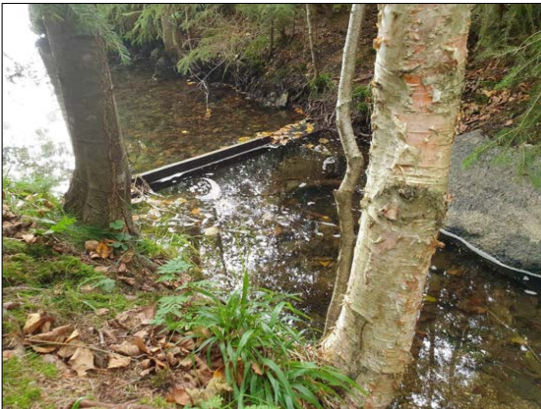
Bild 3. Regleringen bestående av två gjutna fundament med en sättbräda emellan som är ca 20 cm hög. Bilden tagen mot väster. Foto: Eva Eliasson
