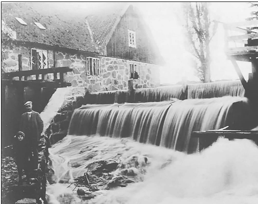
Historisk bild 1. Kvarnägare Frans Johansson tillsammans med sonen Lennart invid kvarndammens överfallsöppning. Bakom den syns tre spettluckor som användes för att reglera vattnet till vattenhjulet. Bilden bör vara tagen omkring 1925. Foto: ur Tidsbilder I, 1991, artikel om Lennart Johansson, s. 79
