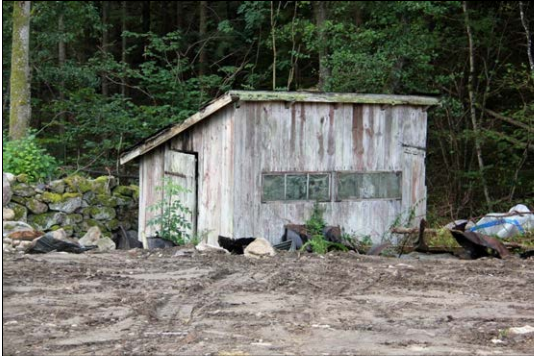
Bild 19. Kraftstationen har ett pulpettak vars konstruktion är ett papptäckt bräddtak. På framsidan finns fönsterband med handblåsta fönsterglas. Ingång är från gaveln via en enkel bräddörr. Foto: Helena Lundgren.
