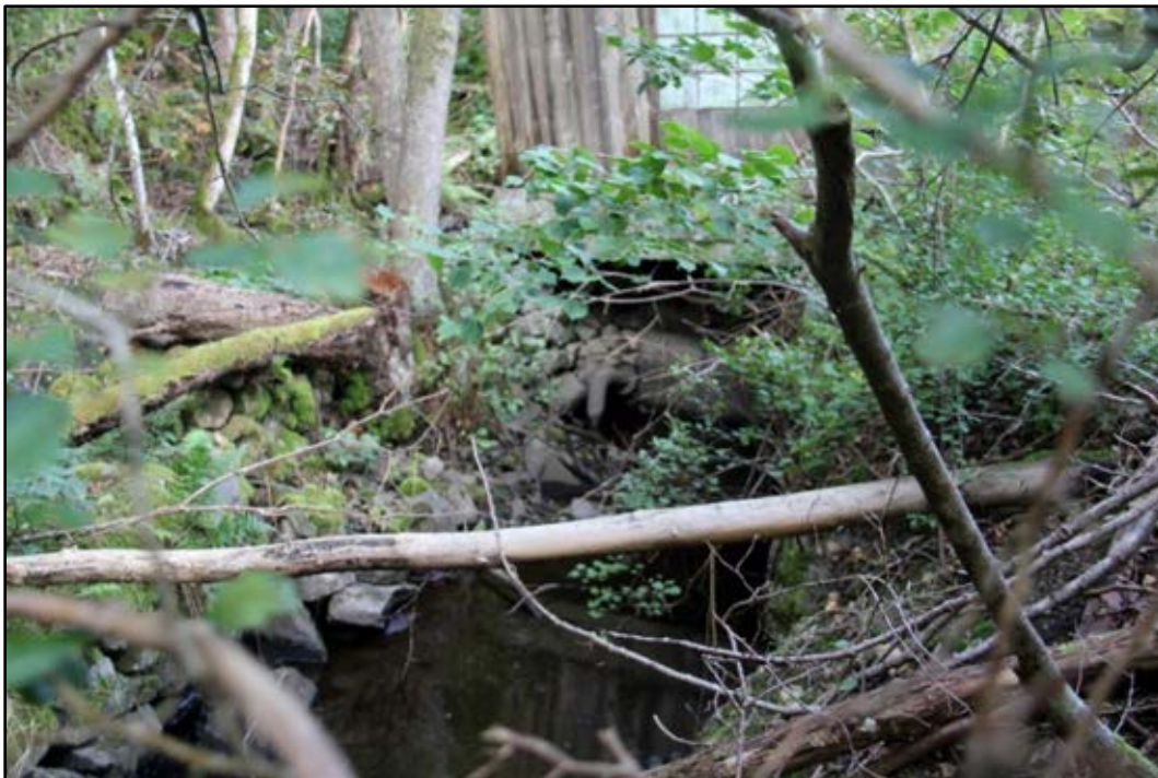
Bild 37. Bakom turbinhuset går utloppskanalen. Foto: Helena Lundgren.
