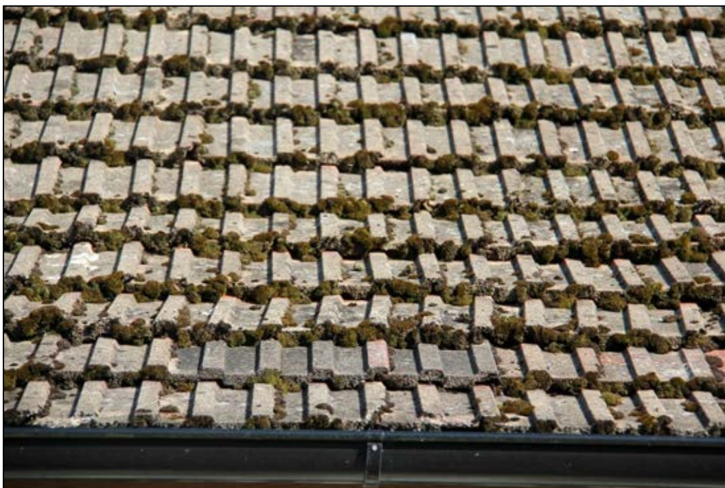
Bild 6. Kvarnbyggnaden har speciella takpannor som är tillverkade av betong. På baksidan av kvarnbyggnaden är taket klätt med enkupigt tegel på det gamla spåntaket. Foto: Helena Lundgren
