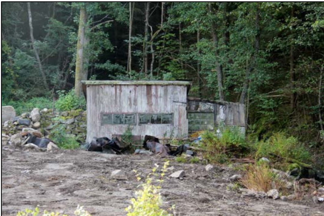
Bild 18. Byggnaden inrymmer en f.d. kraftstationen. En vägg är det enda som finns kvar av turbinhuset som legat precis intill ån. Foto: Helena Lundgren.
