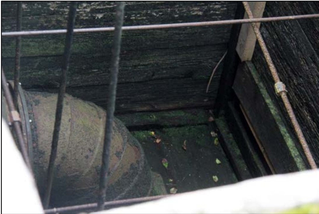
Bild 21. Sugrör till turbinerna i sumpen, i slutet på vattenrännan. Foto: Helena Lundgren.
