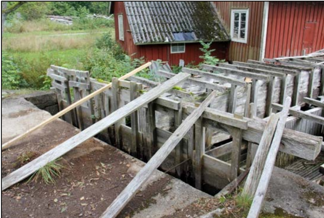
Bild 7. På bilden syns de fem luckorna som reglerar flödet från dammen. Foto: Helena Lundgren
