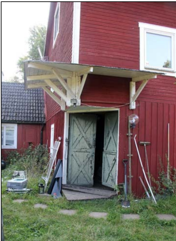
Bild 5. Den snedställda entrén till kvarnen med de ljusa grönfärgade pardörrarna med dörrblad byggda som bräddörrar. Möjligen är den högra delad i en nedre och en övre halva. Ovan entrén ett skärmtak på kraftiga konsoler. Foto: Helena Lundgren
