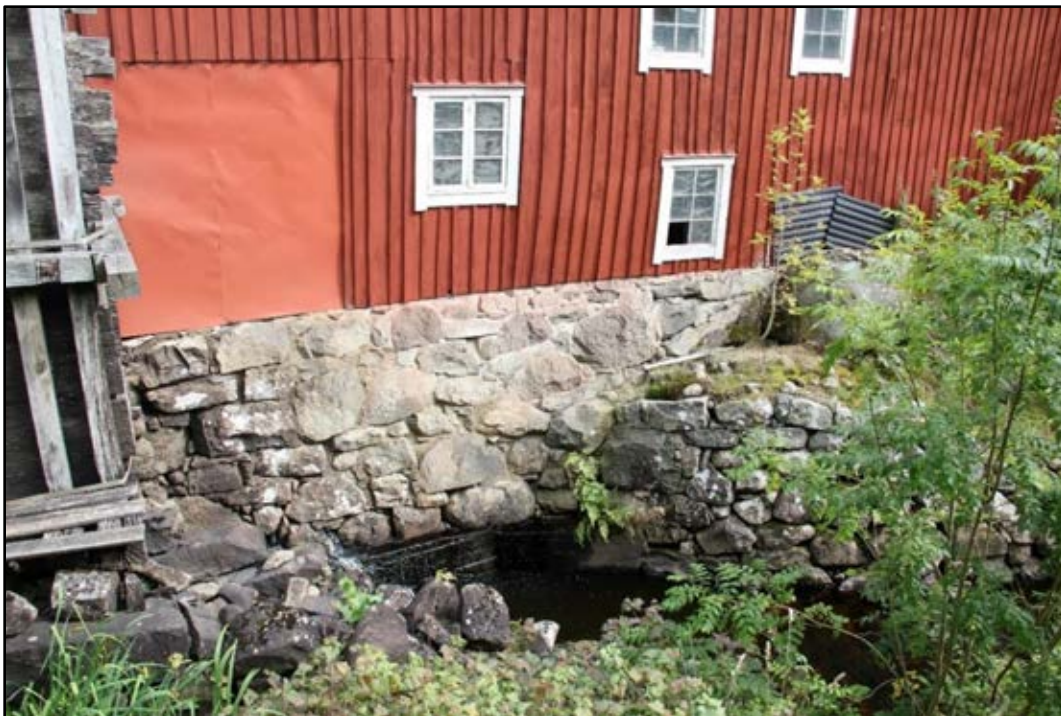
Bild 22. Del av kvarngrunden nedströms turbinsumpen är förstärkt med betong. Foto: Helena Lundgren.
