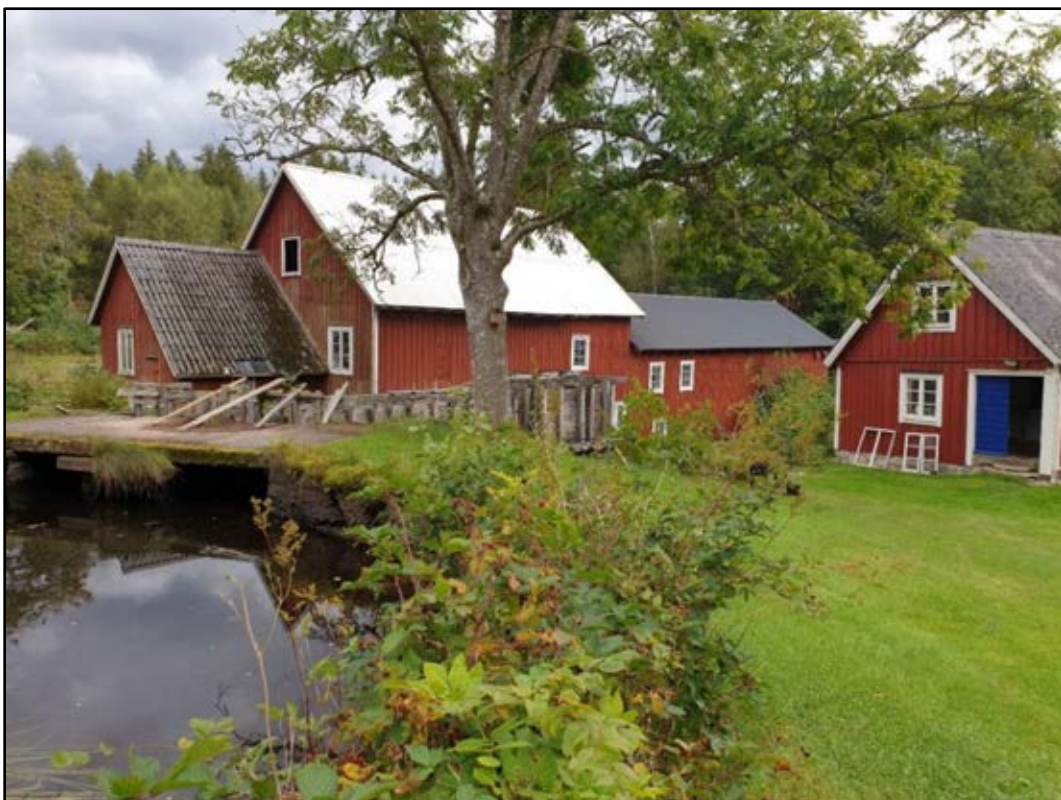
Bild 8. Östra kvarnbyggnaden med såg- och mjölkvarn t.v. och en del av västra kvarnen t.h. Foto: Eva Eliasson
