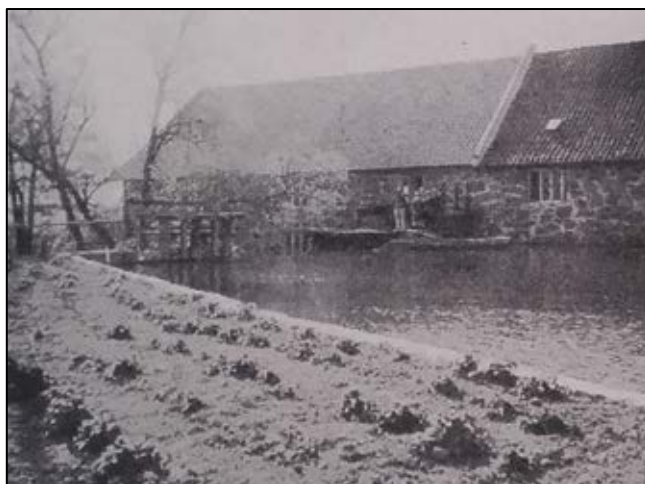
Historisk bild 3. Kvarnen sedd mot sydost. På dammkroppen, invid kvarnbyggnaden, står två personer. Till vänster i bild syns huvudfårans reglering och till höger syns den byggnad som brann och där sågen sedan uppfördes 1937. Bilden bör därmed vara tagen före 1937. Foto: ur Svenska kvarnar 1940, s. 375
