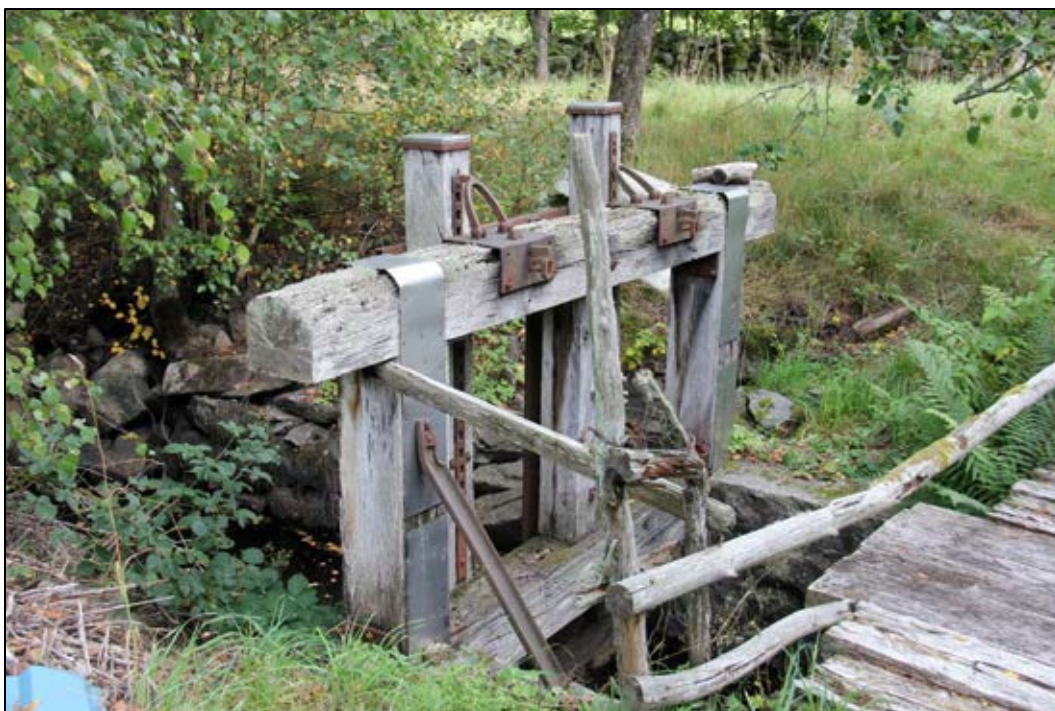
Bild 3. Spettluckornas träställningen är förstärkt med metallband. Utskovets sidor består av stora huggna stenar. Ett träräcke vid bron har delvis rasat. Bilden tagen mot nordost. Foto: Helena Lundgren
