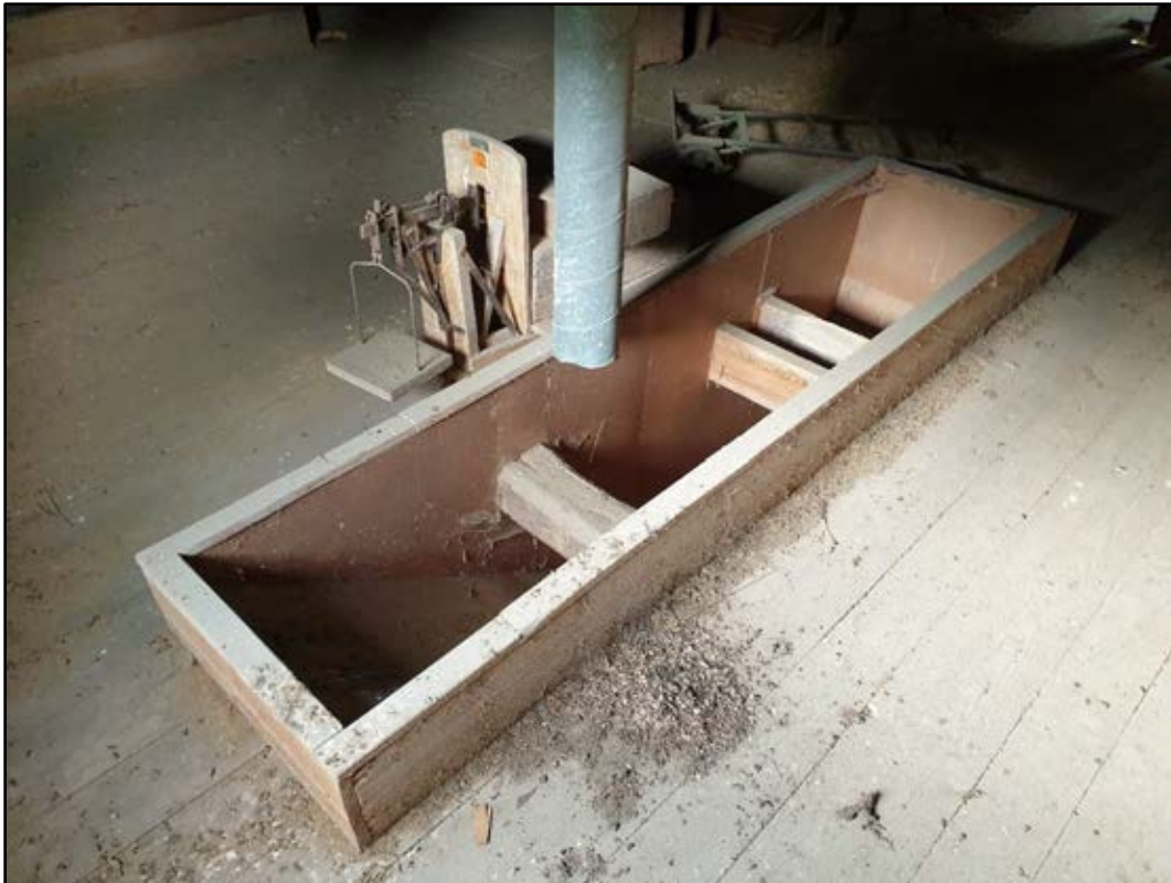
Bild 29. Genom kvartratten i golvet hälldes säden ner till kvarnen när det skulle malas. Foto: Eva Eliasson
