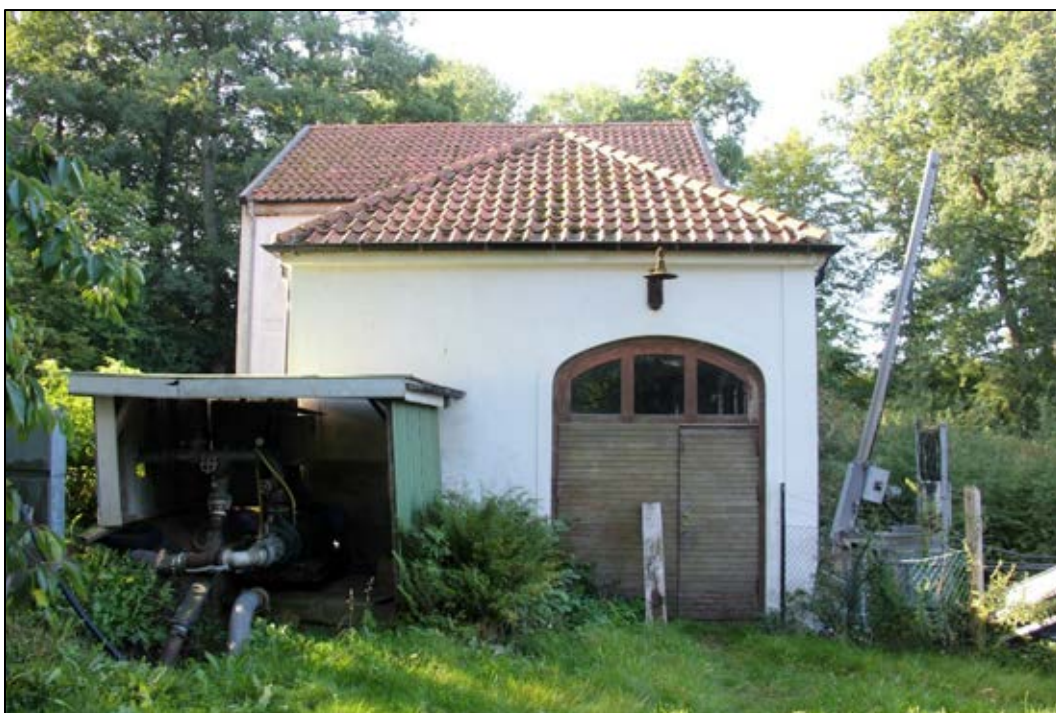
Bild 4. Pumpstationens norra fasad där ingången till byggnaden finns. Till vänster om ingången, i det lilla plåtskjulet, finns delar av en bevattningsanläggning som används av odlarna i området. Foto: Helena Lundgren
