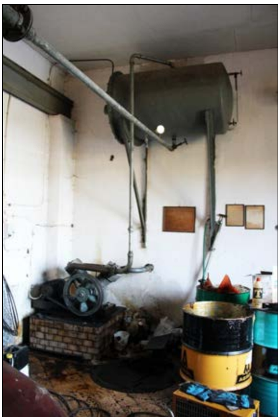
Bild 25. Längst in i det sydöstra hörnet står en kompressor som används vid uppstart av pumparna. Foto: Helena Lundgren
