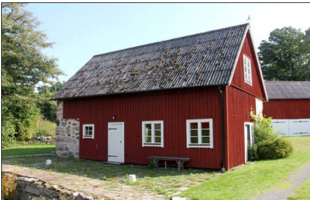
Bild 6. Kvarnbyggnadens västra långsida som är vänd mot vattendraget. Här består byggnaden mestadels av trä och det är här som vattenhjul och turbin tidigare funnits. Bilden tagen mot öster. Ursprungligen fanns endast det lilla fönstret till vänster, dörren och de två fönstren till höger har nuvarande ägare satt in. All yttre brädklädsel är ny förutom på den norra gaveln. Foto: Helena Lundgren
