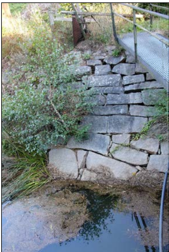
Bild 13. Närmast byggnaden är kanterna stenskodda. Bilden tagen mot norr. Foto: Helena Lundgren
