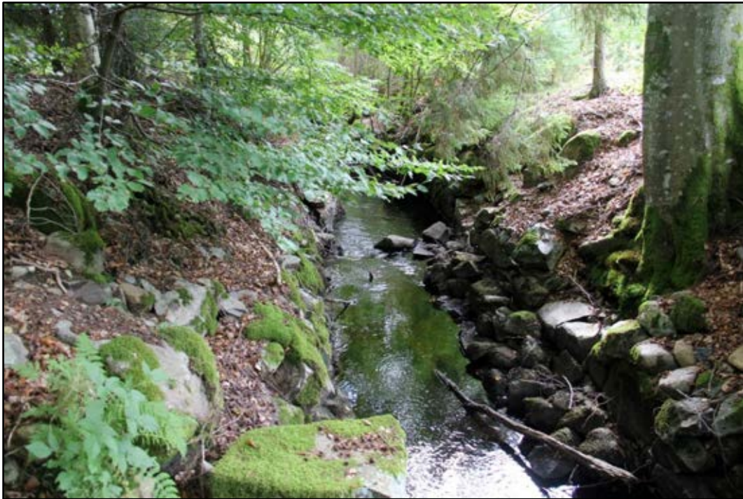
Bild 4. Kanaliserad åsträcka med nedfallna stenar. Foto: Helena Lundgren
