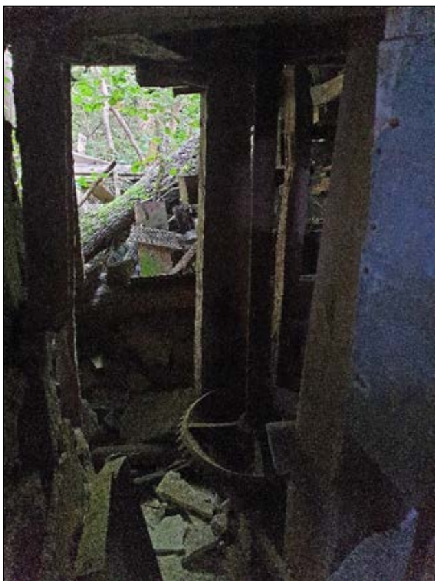
Bild 13. Del av kvarnverket nere på kvarnens nedre botten. Här ser vi även ut till det som en gång var turbinsumpen. Foto: Eva Eliasson
