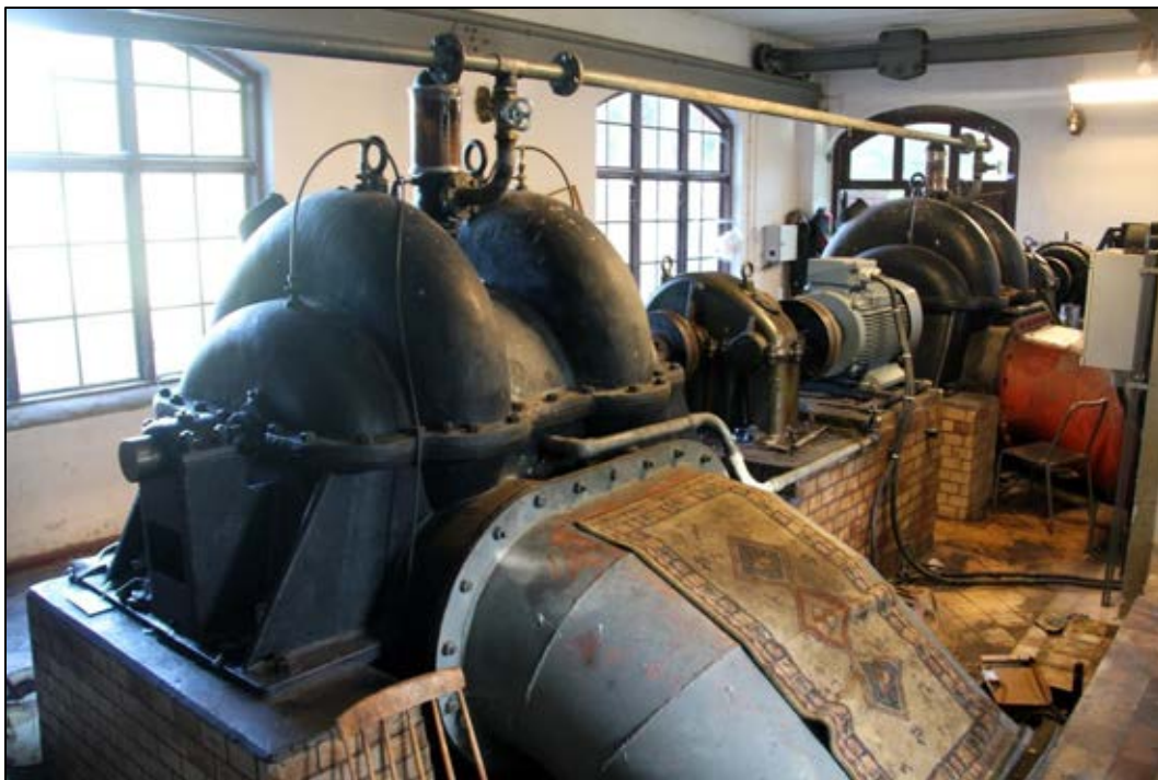
Bild 28. De två originalpumparna sedda mot nordväst. Röret som syns med en matta på, är det rör där det uppumpade vattnet från Vesankanalen pumpas ut till dammen utanför. Mattan som ligger på röret är lagd där för att pumpmästaren inte ska halka. Foto: Helena Lundgren
