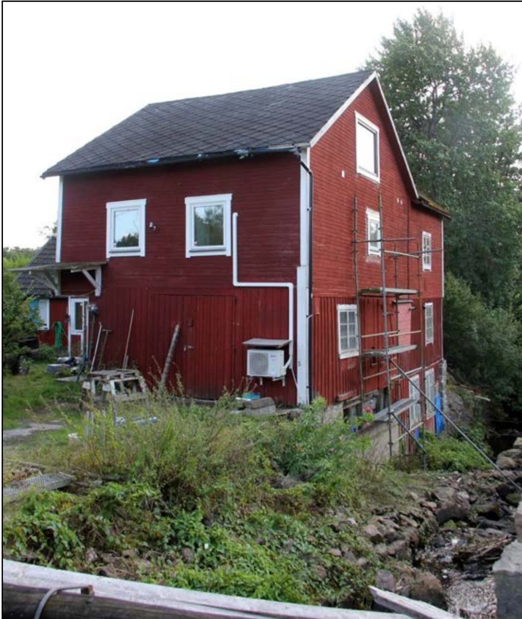
Bild 1. Kvarnbyggnaden sedd från bron. Här syns att flera av de äldre fönstren nyligen bytt ut. Foto: Helena Lundgren
