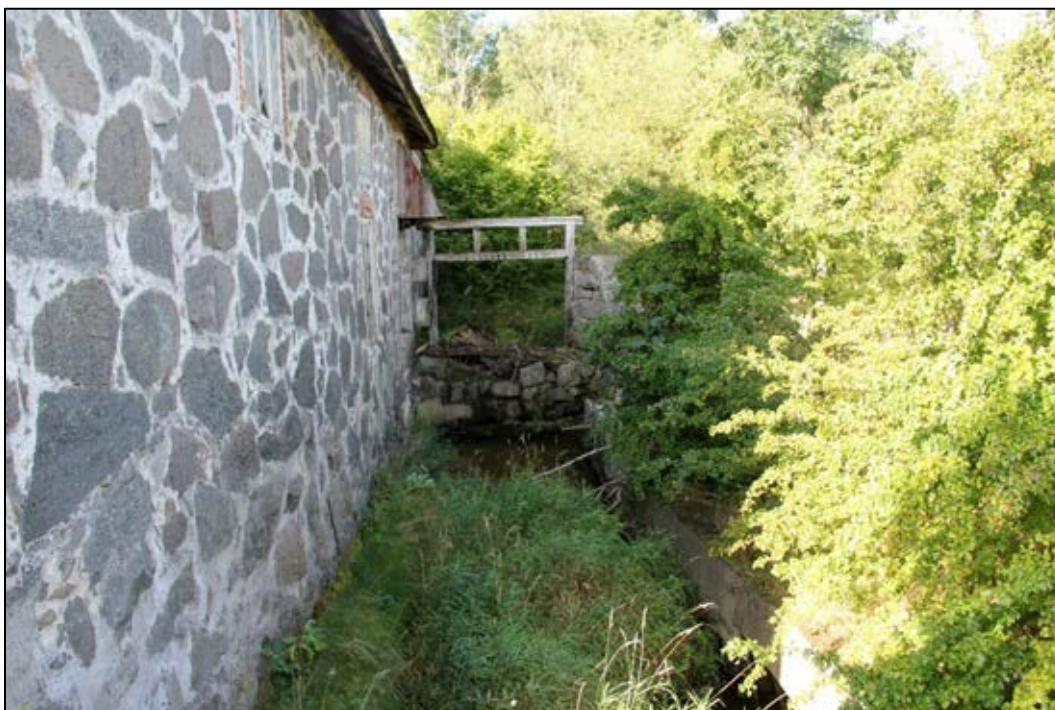
Bild 26. Längst bort i bilden syns den gamla hjulgraven samt öppningen där intaget till vattenhjulet, och sedan turbinen, från dammen fanns och som reglerades med hjälp av tre spettluckor. Bilden tagen mot väster. Foto: Helena Lundgren
