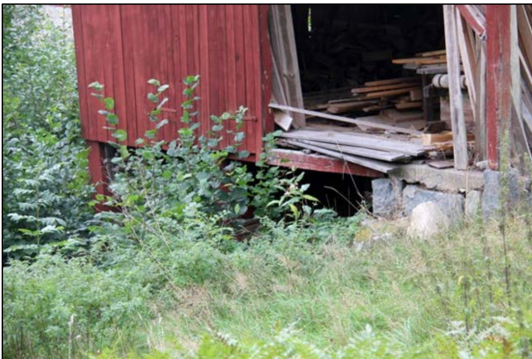
Bild 46. Vid sågens gavel syns att grunden delvis är en stolpkonstruktion och endast mot framsidan vilar på en stenar och gjuten betongklack. Foto: Helena Lundgren
