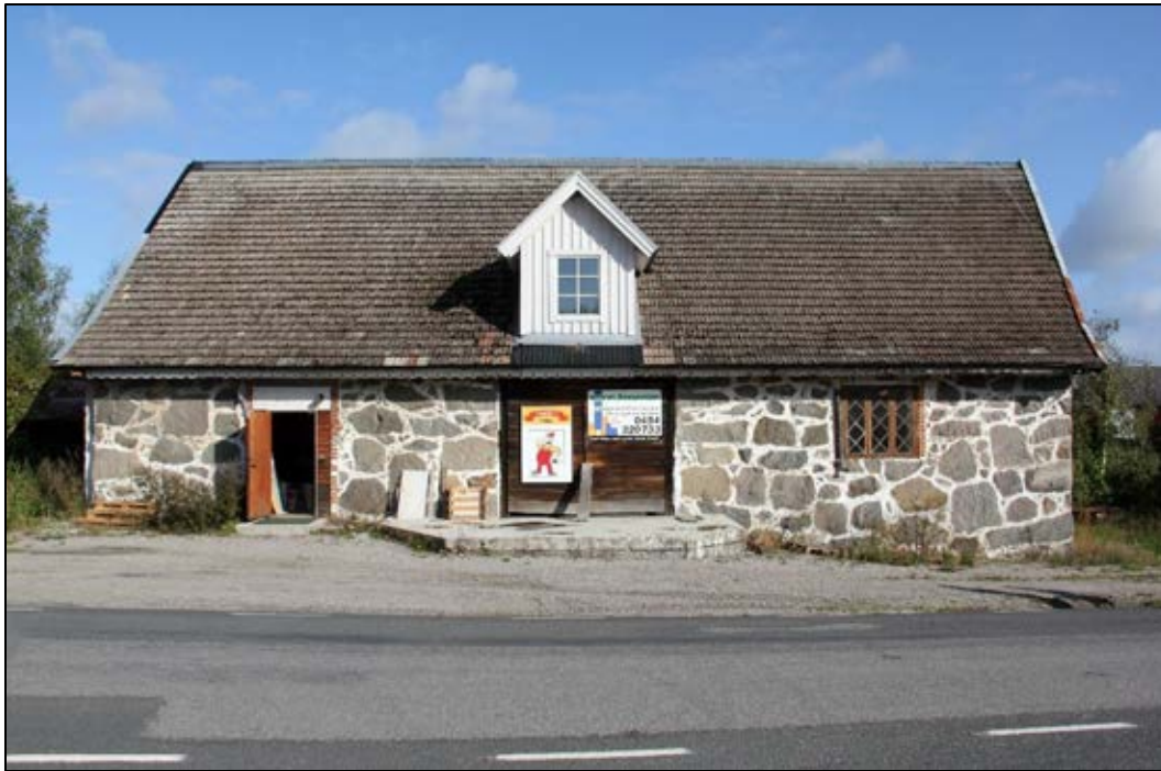
Bild 5. Kvarnbyggnadens södra långsida. På äldre fotografi ser man att den vänstra dörren inte var en dörr utan där fanns ett fönster, jämför med historisk bild 8. Foto: Helena Lundgren
