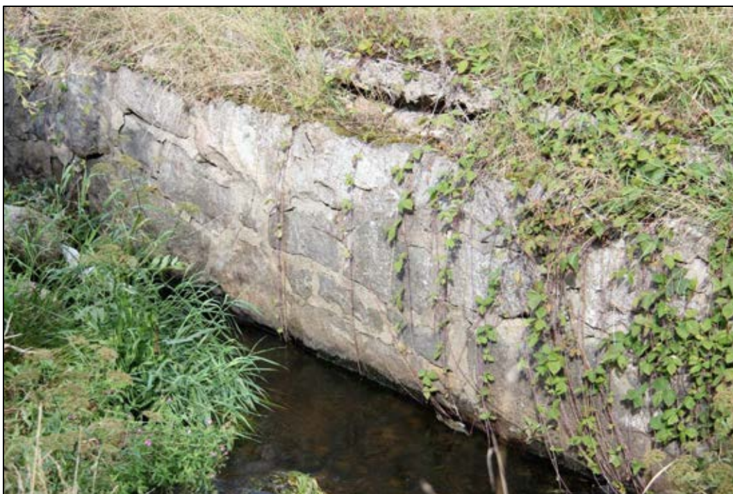
Bild 33. På kanalens norra sida är stenarna delvis fogade. Bilden tagen mot nordväst. Foto: Helena Lundgren
