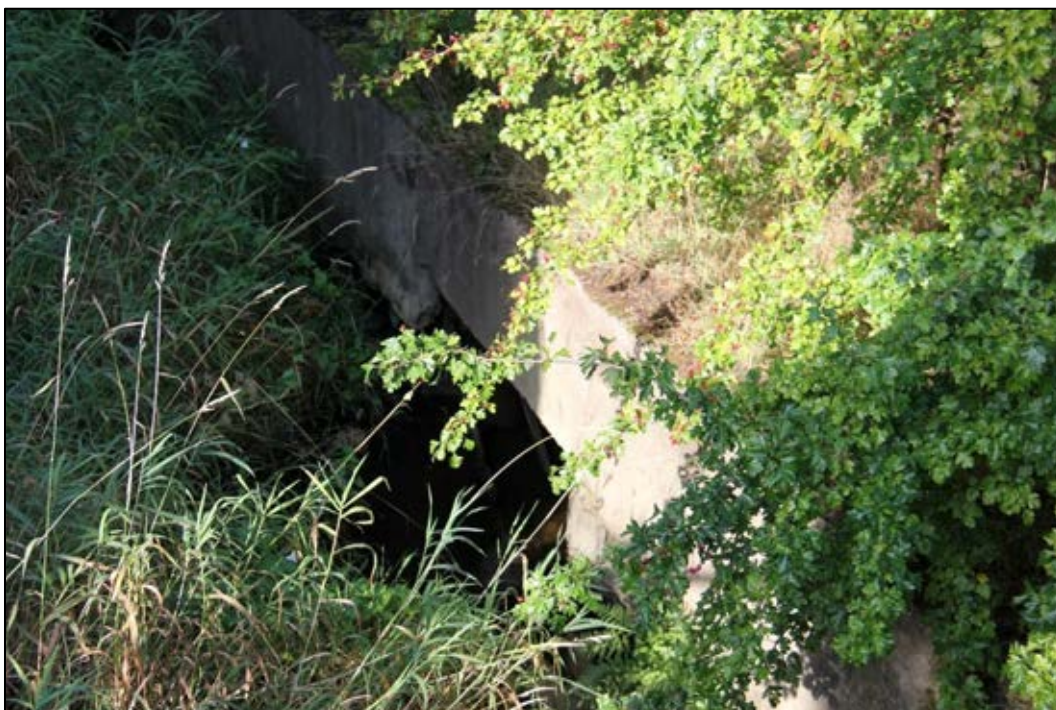
Bild 28. I kvarnrännans norra sida finns en liten öppning där vattnet försvann in. Vi såg ingen öppning i huvudfårans kanalsida så någon sammankoppling mellan kanalerna finns inte. Bilden tagen mot nordväst. Foto: Helena Lundgren
