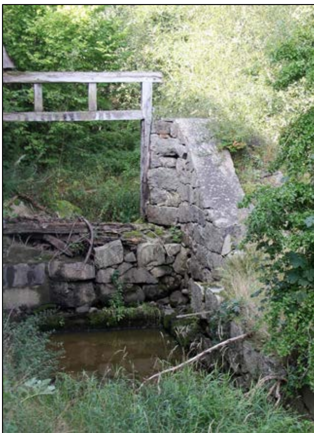
Bild 27. Hjulgraven med ställningen för intaget till vattenhjulets intagsränna samt den södra strävpelaren. Bilden tagen mot väster. Foto: Helena Lundgren
