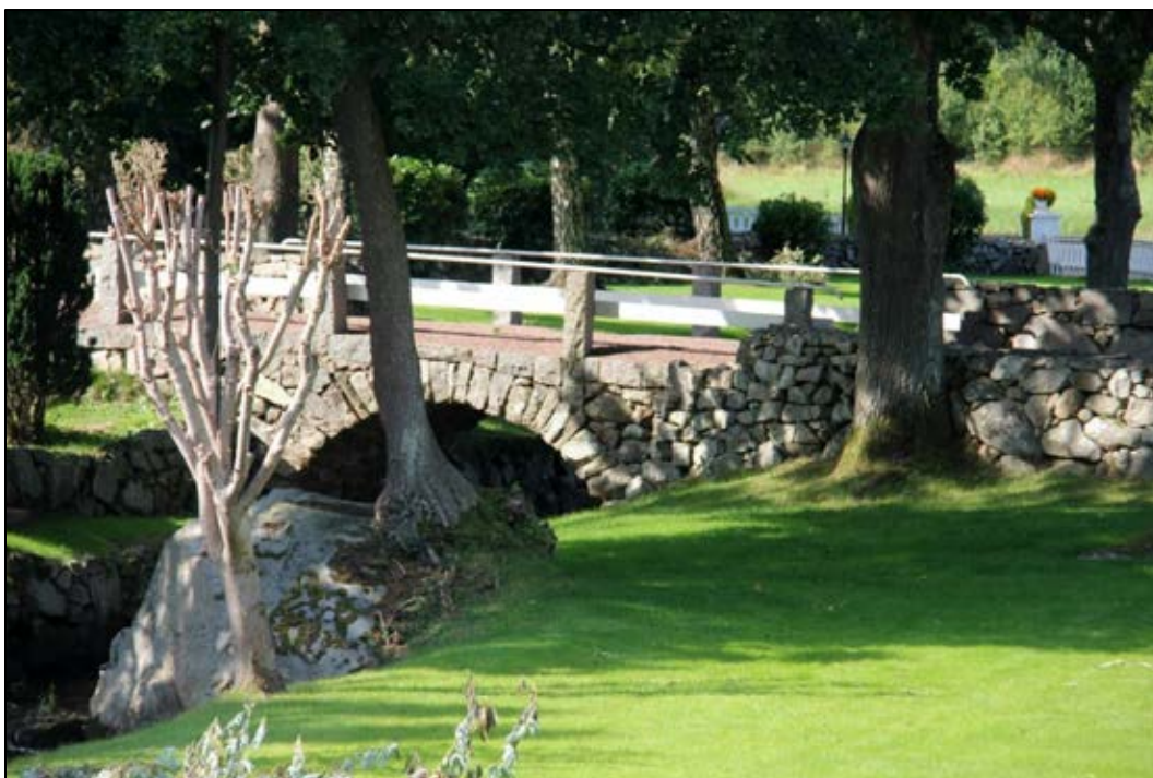
Bild 27. Stenvalsbron sedd mot sydväst. Foto; Helena Lundgren
