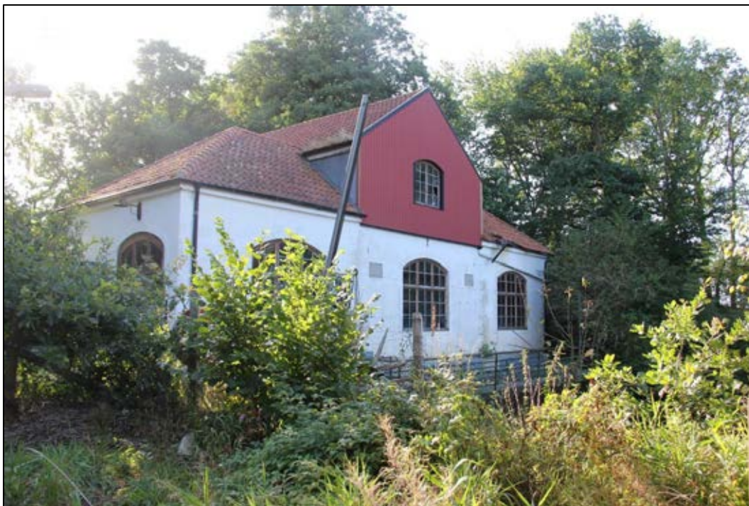
Bild 6. Pumpstationens västra fasad. På var sida om det mittersta fönstret syns två infällda tavlor. Bilden tagen mot sydost. Foto: Helena Lundgren
