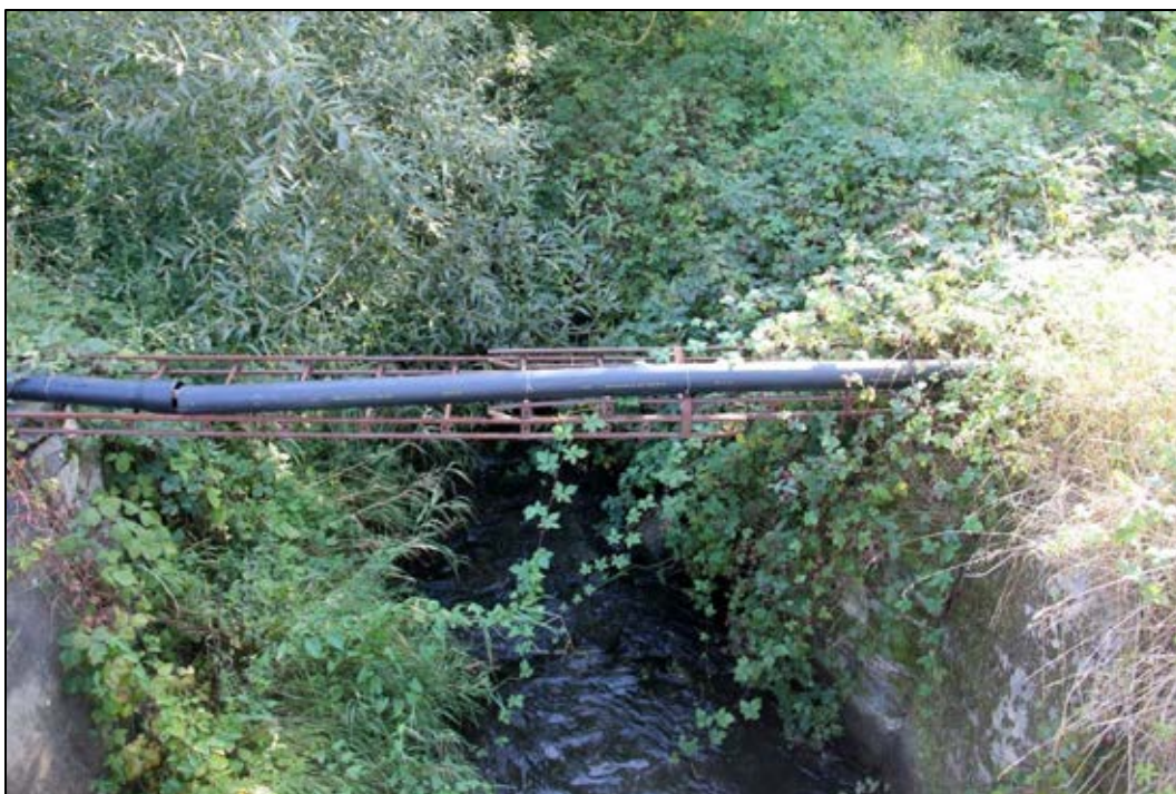
Bild 35. Huvudfårans kanal nedströms bron. Här är kanalens sidor närmast bron gjutna av betong för att sedan övergå till stenskoningar ytterligare en bit innan den går samman med kvarnens utloppskanal. Troligen finns stenskoningar under betongen. Bilden tagen mot öster. Foto: Helena Lundgren
