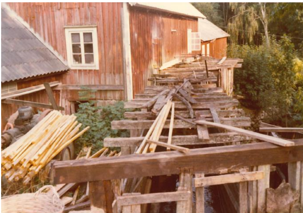
Historisk bild 7. Här syns vattenrännan bra, jämför med bild 5 ovan. Till vänster syns en tändkulemotor, den eldade man med blåslampa för att starta och den drog kvarnen på sommaren då det inte var något vatten. Foto: Blekinge läns museums arkiv.
