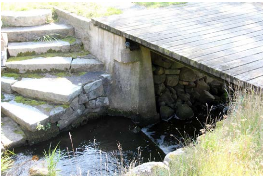
Bild 17. Mellan brofästets gjutna delar finns stenar som troligen härrör från det äldre brofästet. Foto: Helena Lundgren
