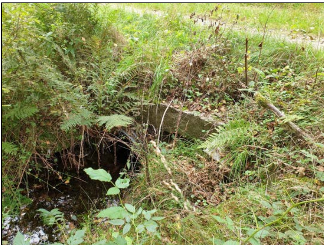
Bild 8. Vattendraget fortsätter fram till en väg där det försvinner in i ett stenvalv byggt av flata stenar och som syns på båda sidor av vägen. Foto: Eva Eliasson
