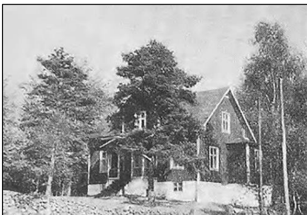
Historisk bild 3. Villabyggnad uppförd 1918 av konsul J. H. Jaeger, innehållandes sju rum, kök och badrum.
