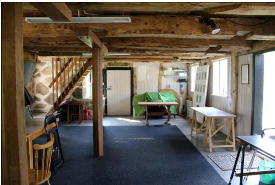
Bild 9. I byggnadens sydöstra hörn finns en mycket sliten trappa med moderna räcken upp till kvarnens övre botten. Trappan påminner om gångna tiders slit med sädessäckarna tiden innan Arkimedesskruven sattes in. Här ser vi också att halva den södra gaveln samt den västra väggen består av trä. Bilden tagen mot söder. Foto: Helena Lundgren
