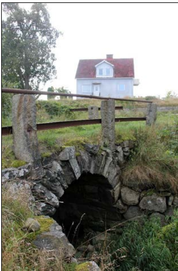
Bild 29. Stenvalvsbron som sträcker sig över kvarnrännan och som tidigare fungerade som landsvägsbro. De broräcken som idag sitter på de gamla bropelarna av sten består överst av järnrör och de nedre av järnbalk. I bakgrunden syns mjölnarbostaden från 1949. Mellan den och bron låg tidigare den första mjölnarbostaden. Bilden tagen mot sydost. Foto: Helena Lundgren
