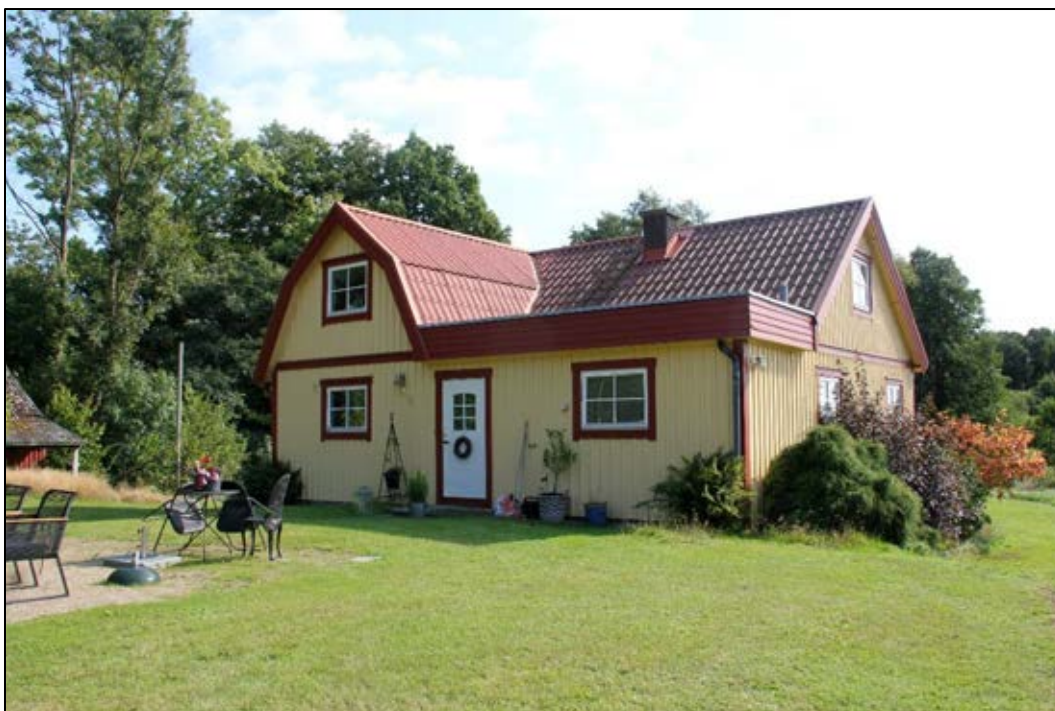
Bild 20. Mjölnarbostaden som uppfördes 1922. En tillbyggnad har gjorts i vinkeln mellan byggnadskropparna, förmodligen på 1970-talet. Även den delen med mansardtak har troligen byggts till efter 1922 men före 1970-talet. Bilden tagen mot sydost. Foto: Helena Lundgren
