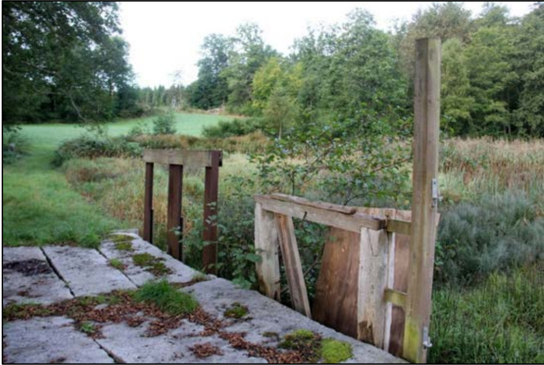
Bild 5. Stenbron och spettluckor som reglerar flödet från vattnet i dammen. Foto: Helena Lundgren.
