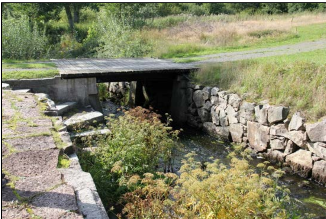
Bild 15. Sydväst om kvarnen finns en liten träbro över kanalen och som vilar på gjutna betongfundament. Bilden tagen mot sydväst. Foto: Helena Lundgren
