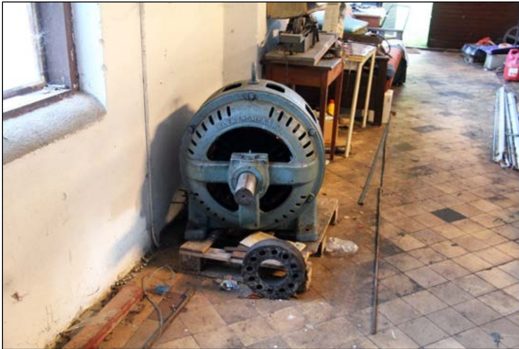
Bild 27. En äldre generator som är tagen ur drift, märkt Elektromekano. Foto: Helena Lundgren
