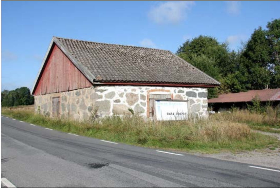
Bild 1. Den södra delen av den vinkelbyggnad som tidigare låg sammanbyggd med kvarnbyggnaden. Till höger i bild skymtar taket till sågen. Bilden tagen mot nordväst. Foto: Helena Lundgren
