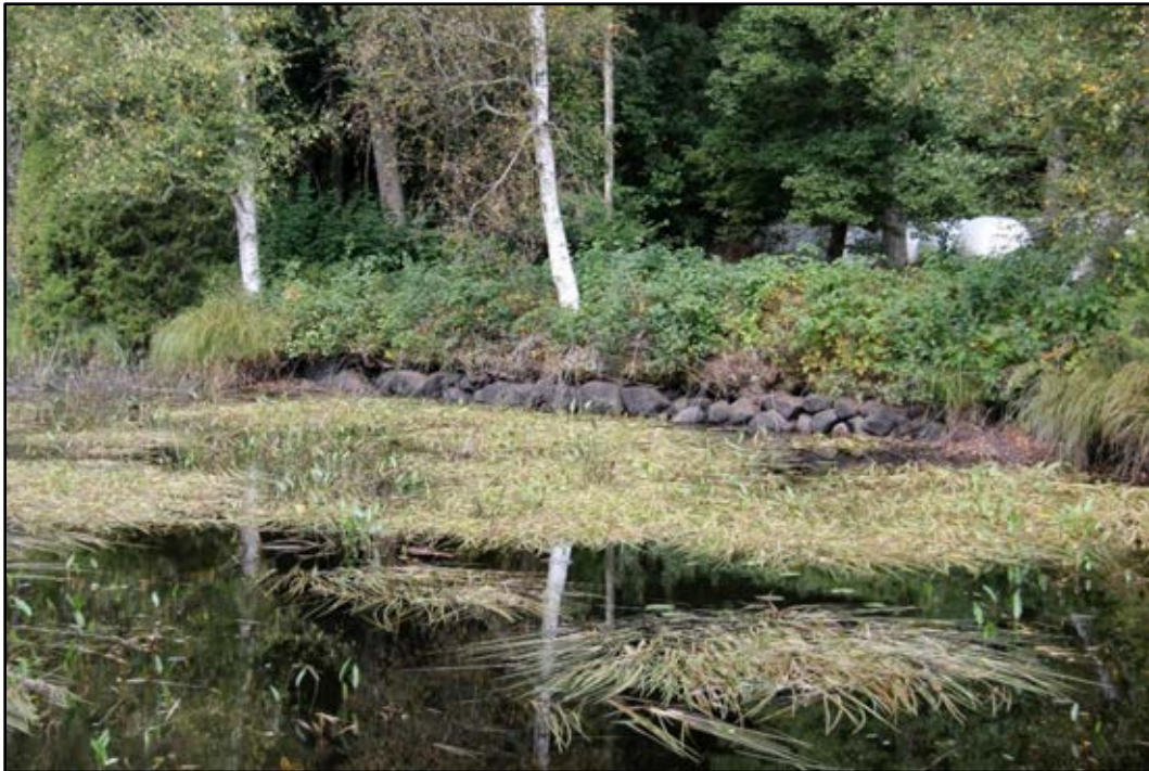
Bild 3. Östra sidan av dammen skodd med sten. Foto: Helena Lundgren.
