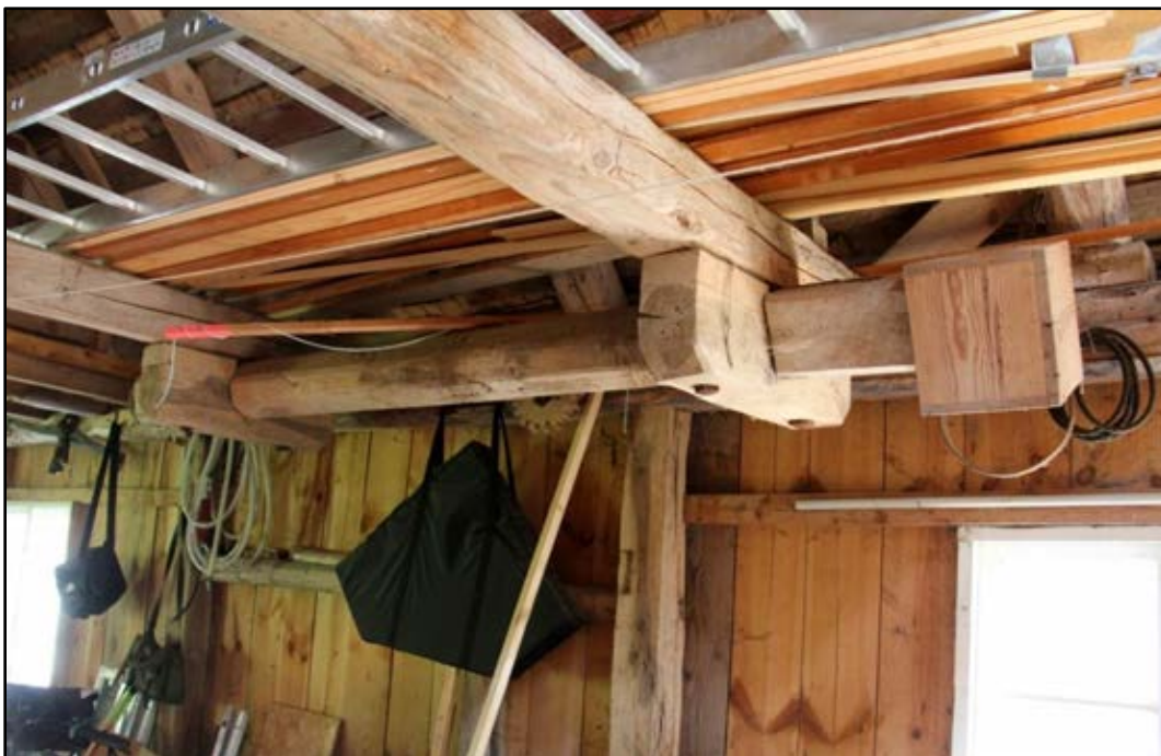
Bild 16. Annordning för att hissa upp kvarnstenarna när de skulle hackas om. Foto: Helena Lundgren.
