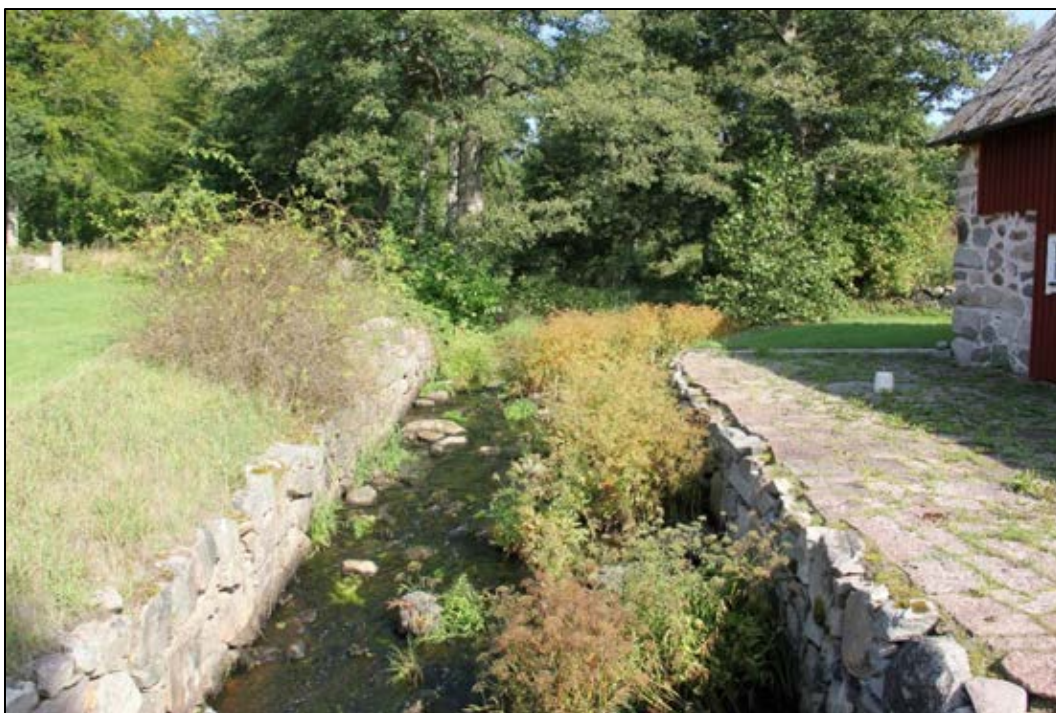
Bild 14. Den stenskodda kanalen sedd mot dammen. Till höger i bild skymtar en del av kvarnbyggnaden. Bilden tagen mot norr. Foto: Helena Lundgren
