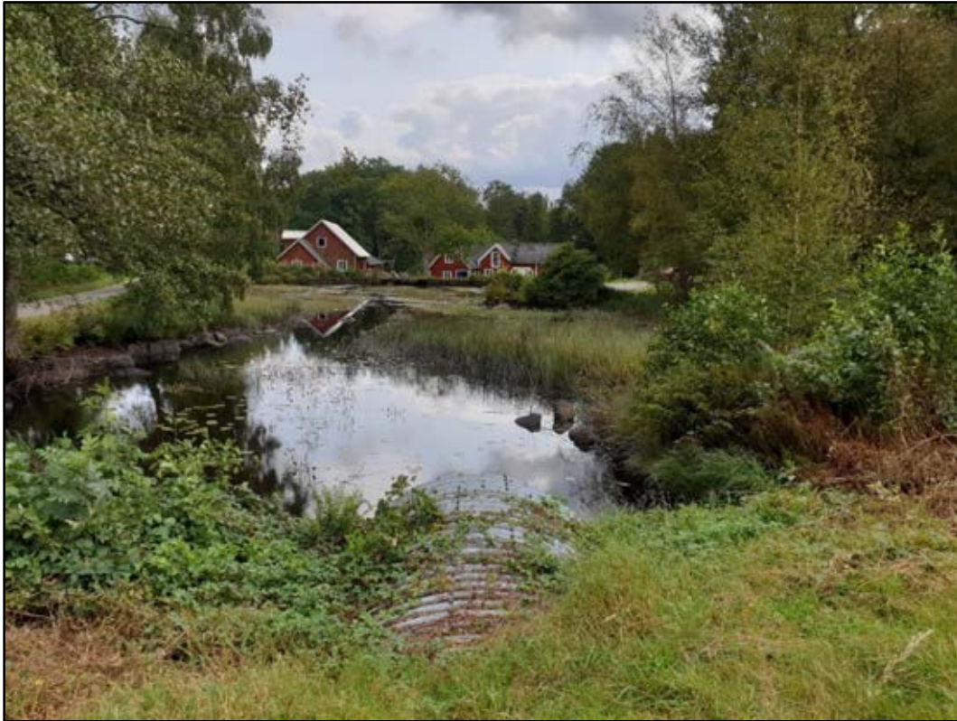
Bild 1. Kvarnmiljön i Åkekvarn där dammen är skodd med sten på östra sidan och med betong på västra. Inloppet i förgrunden genom ett kulvert. Foto: Eva Eliasson
