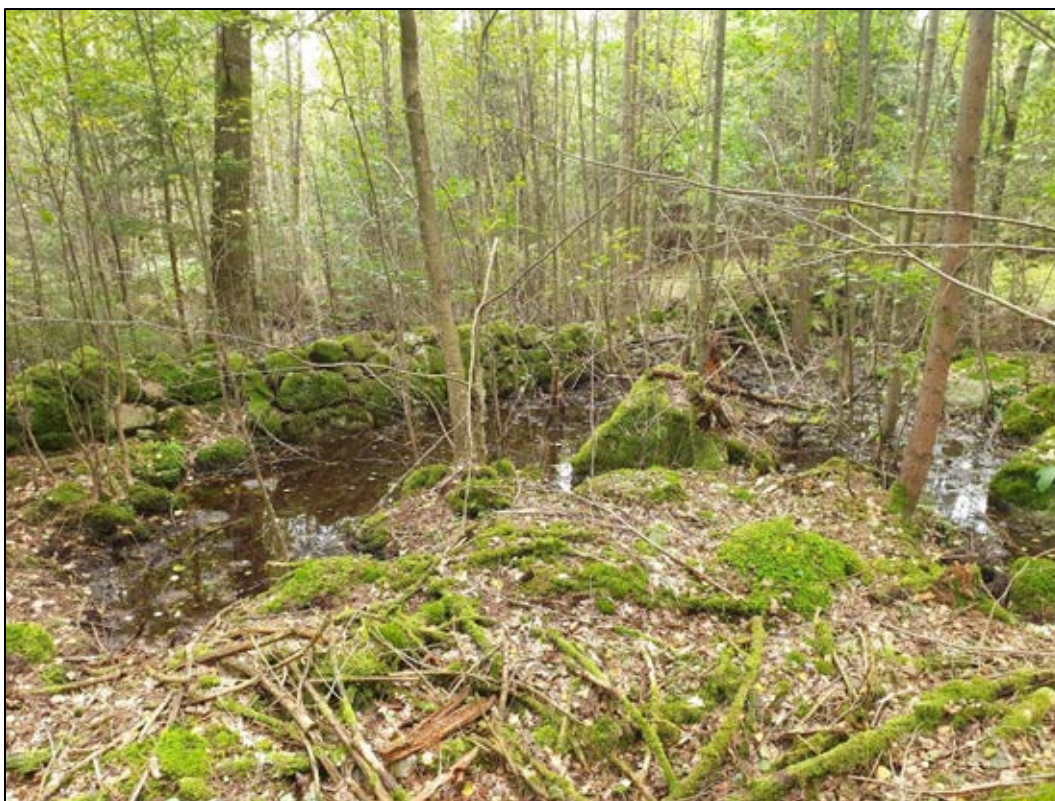
Bild 6. En bit nedströms går en mur rakt över vattendraget. Det är oklart vad den haft för funktion. Det finns inga öppningar utan vattnet tycks ta sig fram under muren. Bilden tagen mot sydost. Foto: Eva Eliasson
