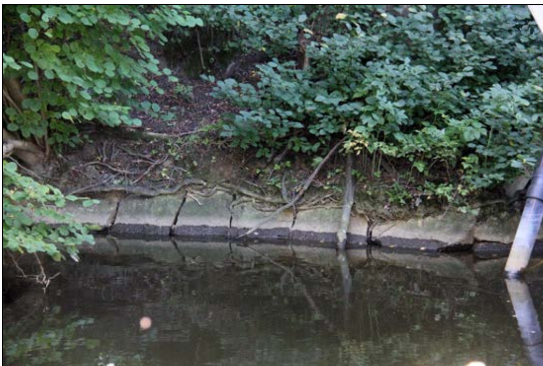
Bild 19. Dammens stenskodda södra sida. Foto: Helena Lundgren
