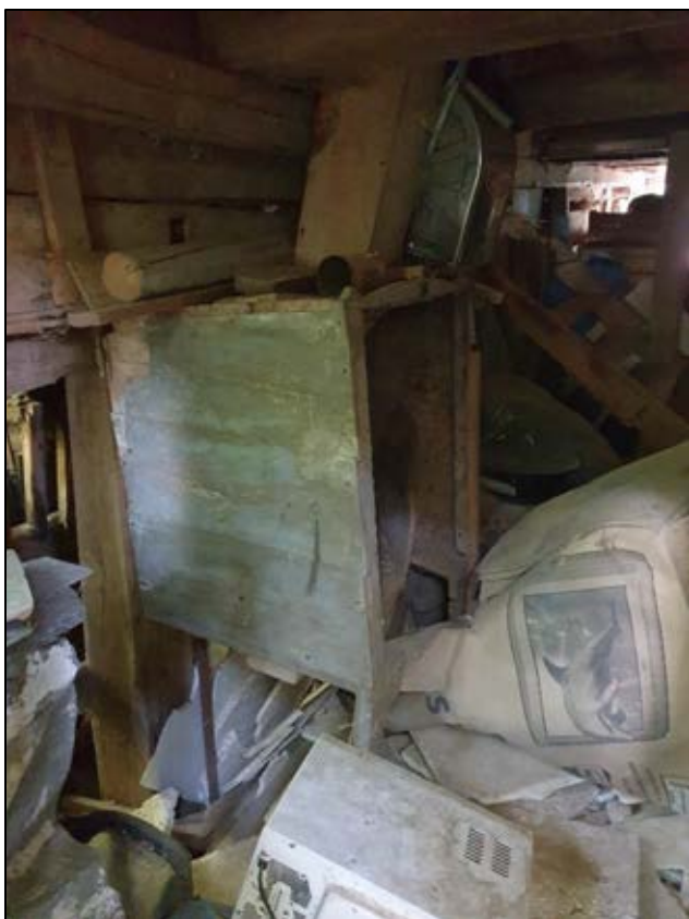
Bild 12. På nedre kvarnbotten kommer det ner ett fyrkantigt rör från den övre kvarnbotten. Trappen längst bort i bild leder upp till kvarnstenarna. Bilden är tagen mot sydost. Foto: Eva Eliasson.
