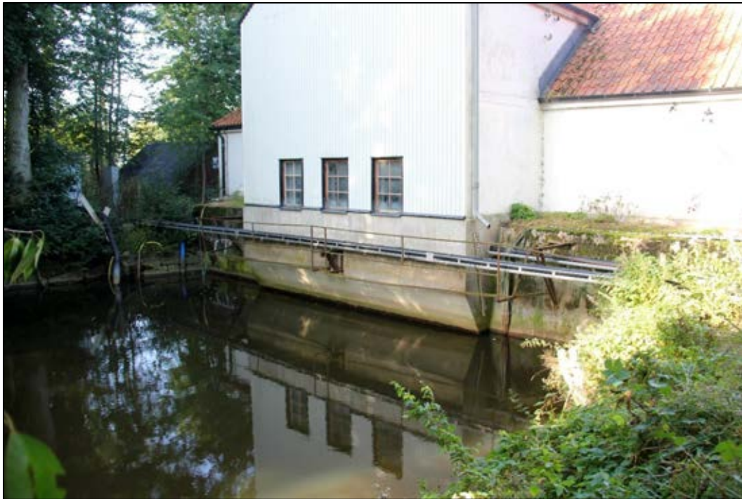
Bild 17. På pumpstationens östra sida finns dammen där det uppumpade vattnet samlas innan det rinner vidare ut i havet. Bilden tagen mot sydväst. Foto: Helena Lundgren
