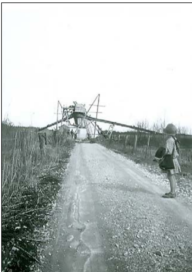
Historisk bild 2. På bilden syns det mudderverk som inköptes till arbetet. Foto: från informations-tavla vid pumpstationen
