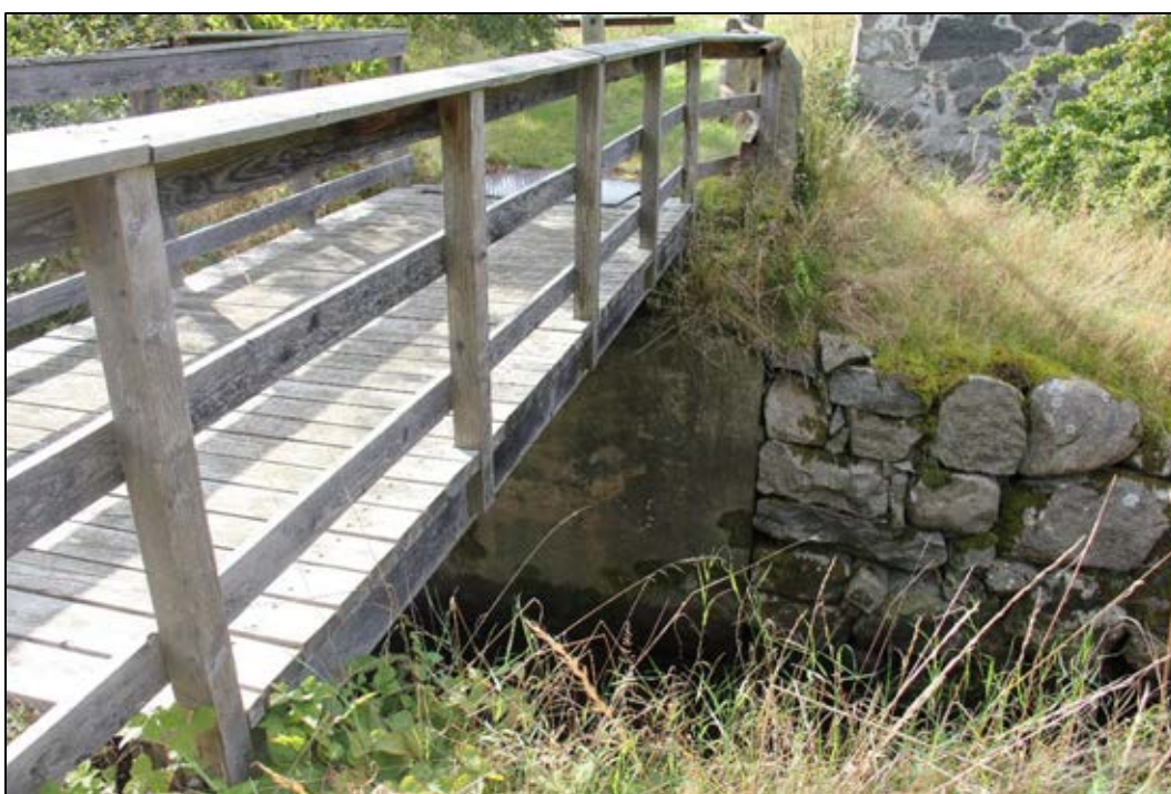
Bild 34. Stenvalvsbrons norra valv är utbytt mot en träbro som vilar på betongfundament. Bilden tagen mot söder. Foto: Helena Lundgren
