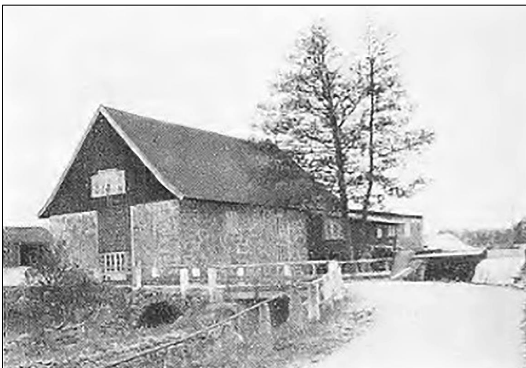
Historisk bild 4. Möllebjörke kvarn ca 1946. På bilden syns att den hitre delen av bron inte består av ett stenvalv. På bilden har ett turbinhus av trä tillkommit. Bilden är tagen mot sydväst. Foto: ur Sveriges bebyggelse Landsbygden Blekinge län del 1, 1945-1948, s. 121
