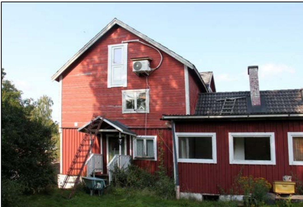
Bild 3. Kvarnbyggnaden sedd från baksidan. T.h. en del av tillbyggnaden som troligen tillkom 1942. Foto: Helena Lundgren
