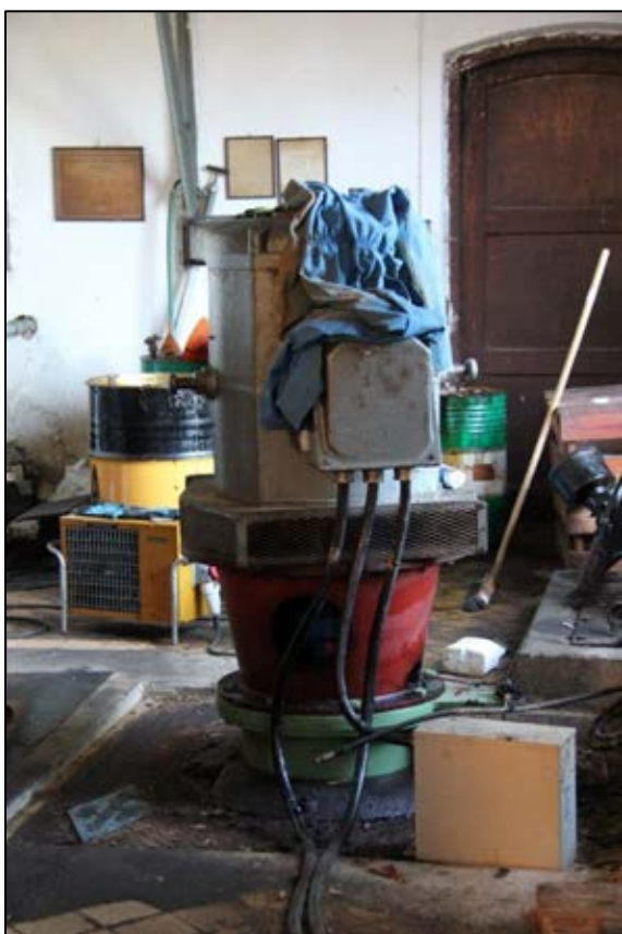
Bild 23. Längst in i byggnaden och längst söder ut stod den tredje pumpen, idag bara delar kvar av den samt dess fundament. Till höger syns den nya pumpen. Foto: Helena Lundgren
