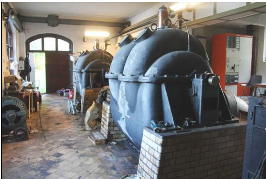
Bild 26. Pumpstationens maskinhall sedd mot norr. Foto: Helena Lundgren
