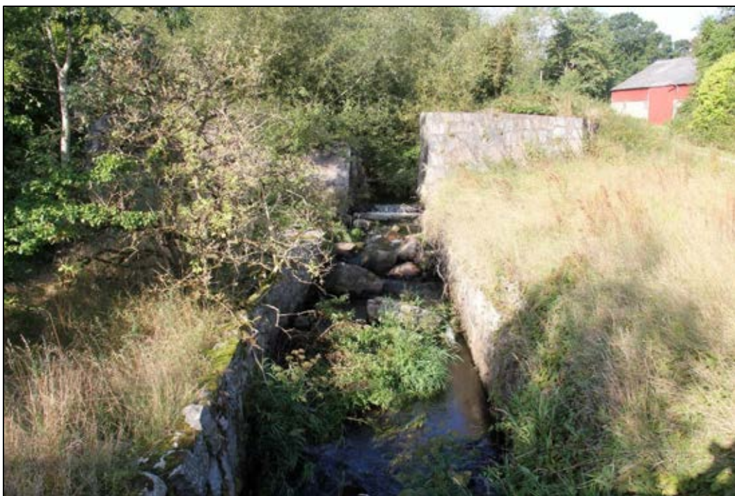
Bild 31. Huvudfårans kanal släppte förbi överskottsvatten. Dammkroppen med sitt utskov syns längst bort i bild. Bilden tagen mot väster. Foto: Helena Lundgren
