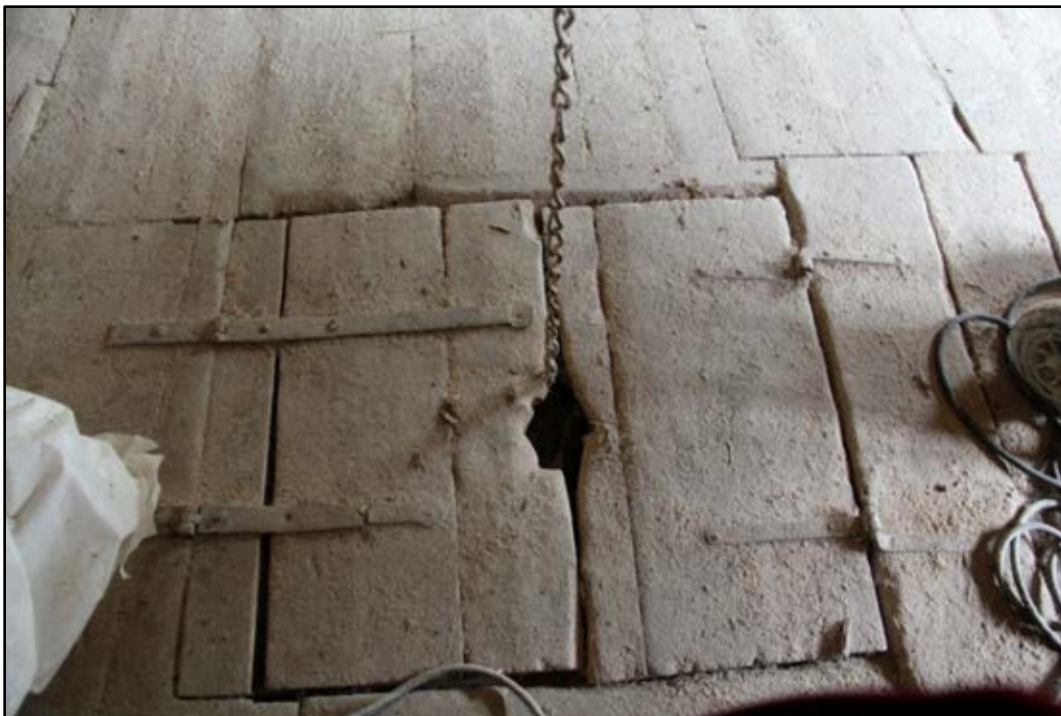
Bild 35. Inne i kvarnen finns också en lucka mellan våningarna för att hissa upp och ner säckar med säd och mjöl. Foto: Helena Lundgren
