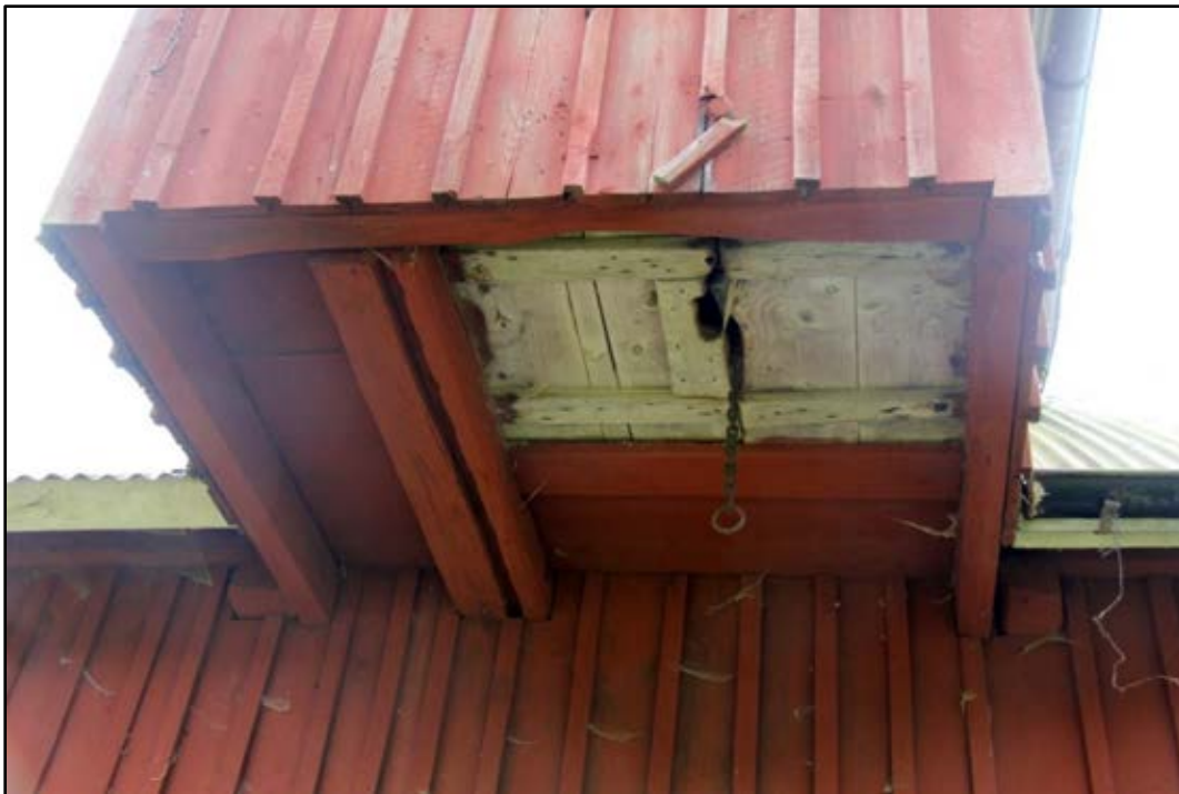
Bild 26. Lucka i utbyggnaden med kedja för att hissa upp säckar. Foto: Helena Lundgren.
