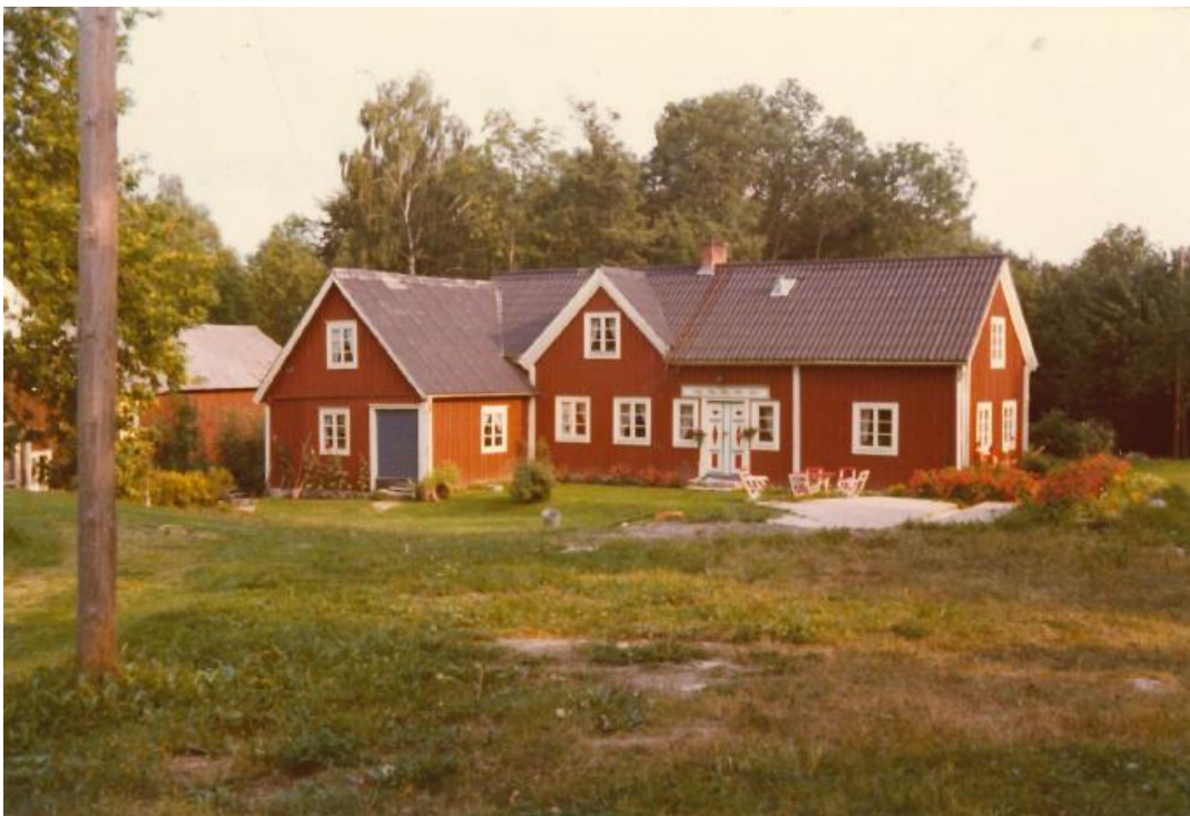
Historisk bild 6. Syns hur kvarnen/bostadens utseende utvecklats från den svartvita bilden från museet till dagens utseende. Dörrarna är utbytta till en annan typ av pardörr och har sedan bytts igen till dagens utseende med en enkeldörr. Även fönstret på övervåningen är utbytt av nuvarande boende. Foto: Blekinge läns museums arkiv.
