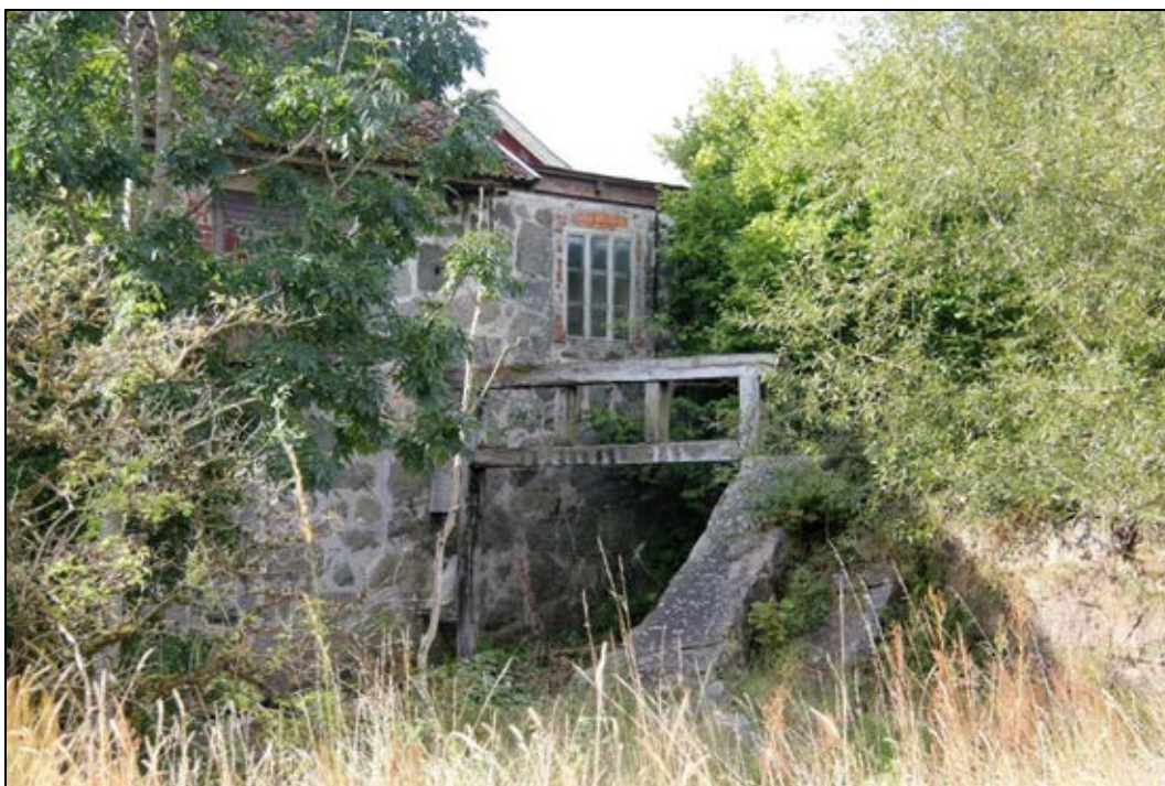
Bild 23. Här fanns tidigare intaget till vattenhjulet intagsränna av trä som skymtar på historisk bild 1. Fönstret på bilden finns på den del av byggnaden som delvis brann ned, stenväggen mot vattendraget klarade sig och fungerar idag som sågbyggnadens norra vägg. Bilden tagen mot sydväst. Foto: Helena Lundgren
