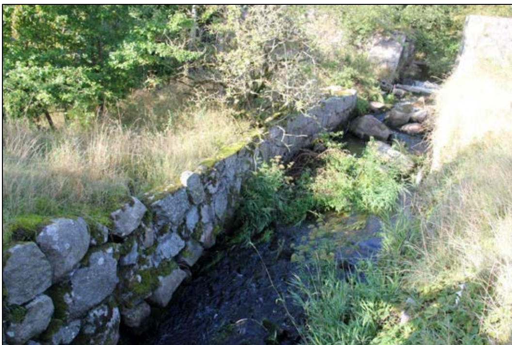
Bild 32. Huvudfårans kanalsidor är stenskodda med både huggen sten och natursten. Bilden tagen mot sydväst. Foto: Helena Lundgren
