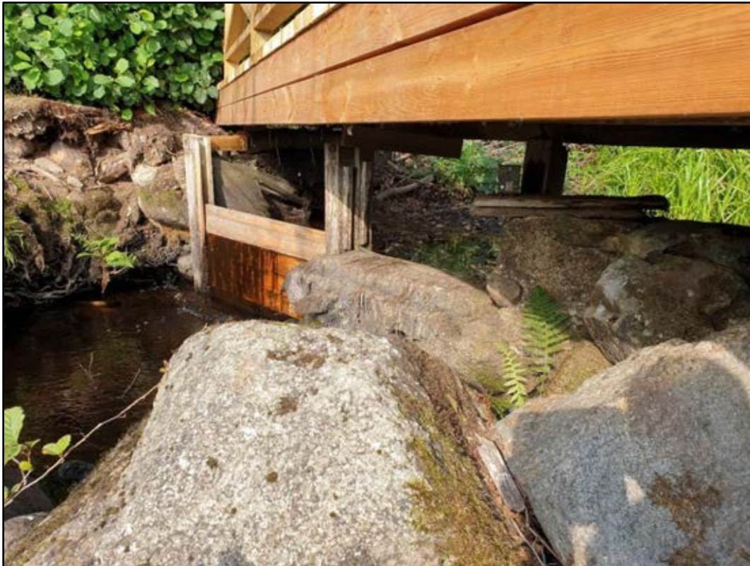
Bild 9. Regleringen består av en lucka som kan höjas och sänkas. Foto: Eva Eliasson
