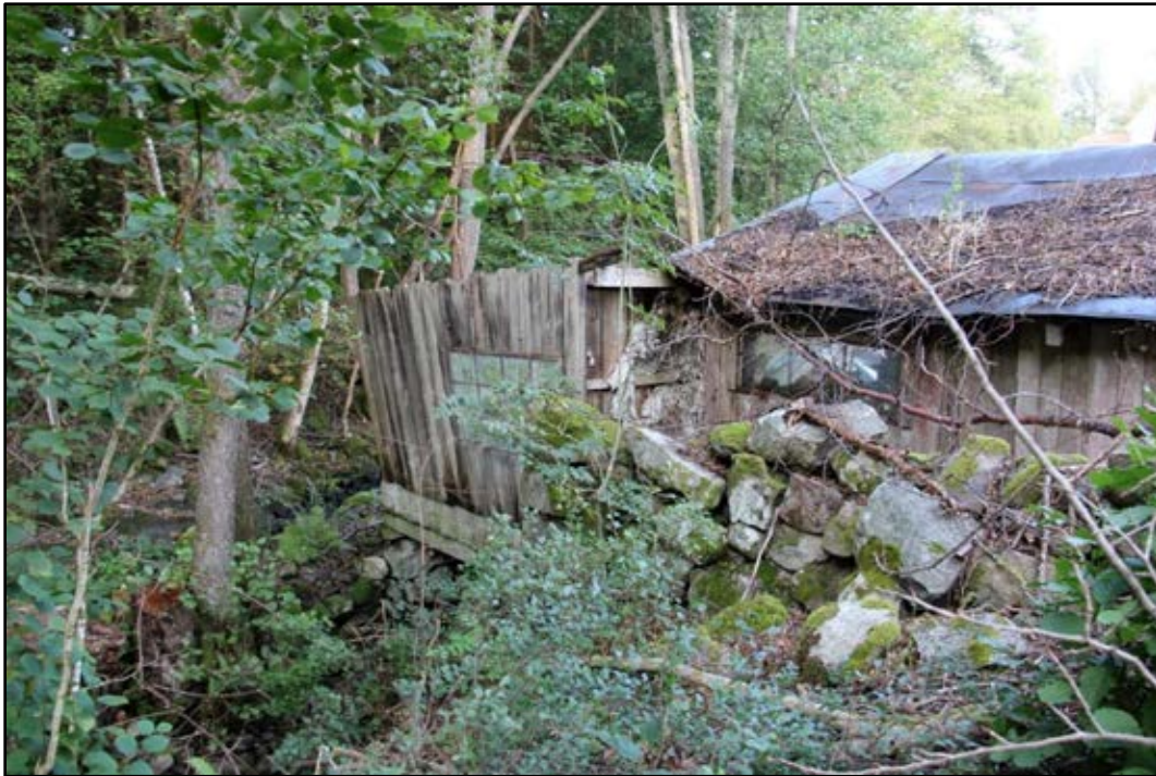
Bild 21. På kraftstationens baksida finns ett liggande fönster med tre spröjs mellan de tre rutorna. Papptaget har förbättrats med plåt mot ena gaveln. Turbinhusets vägg har ett större småspröjsat fönster och står på en betongplatta. Foto: Helena Lundgren.
