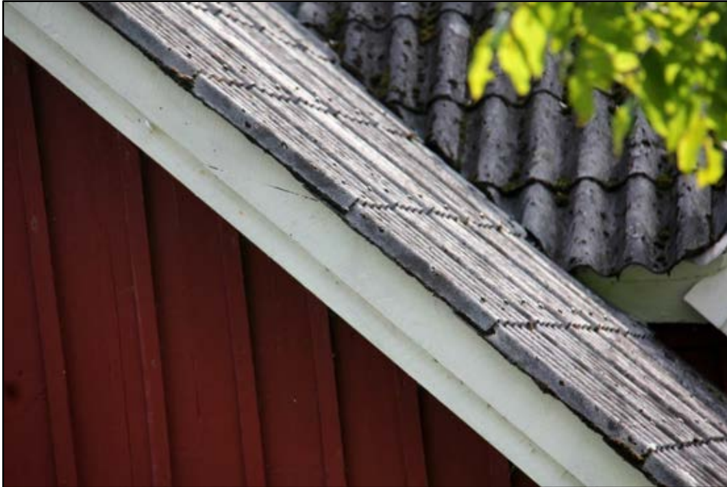
Bild 11. Både kvarndelen och bostadsdelen är täckta med korrugerade pannor i eternit. Foto: Helena Lundgren.
