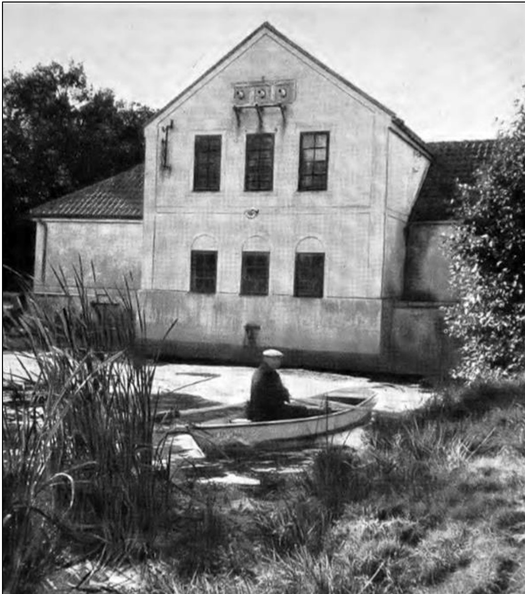
Historisk bild 5. Pumpstationen omkring 1945. Foto: ur Sveriges Bebyggelse Landsbygden Blekinge län Del 1, 1945, s. 882
