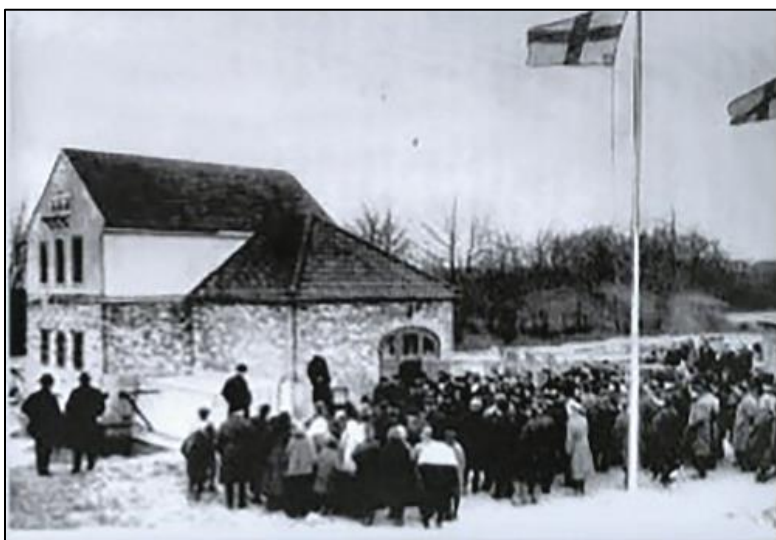
Historisk bild 3. Invigning av pumpstationen den 27 februari 1927. På bilden syns att det bara var den övre delen av byggnaden som var putsad vid tillfället. Foto: ur Vesan runt, avsnitt 6
