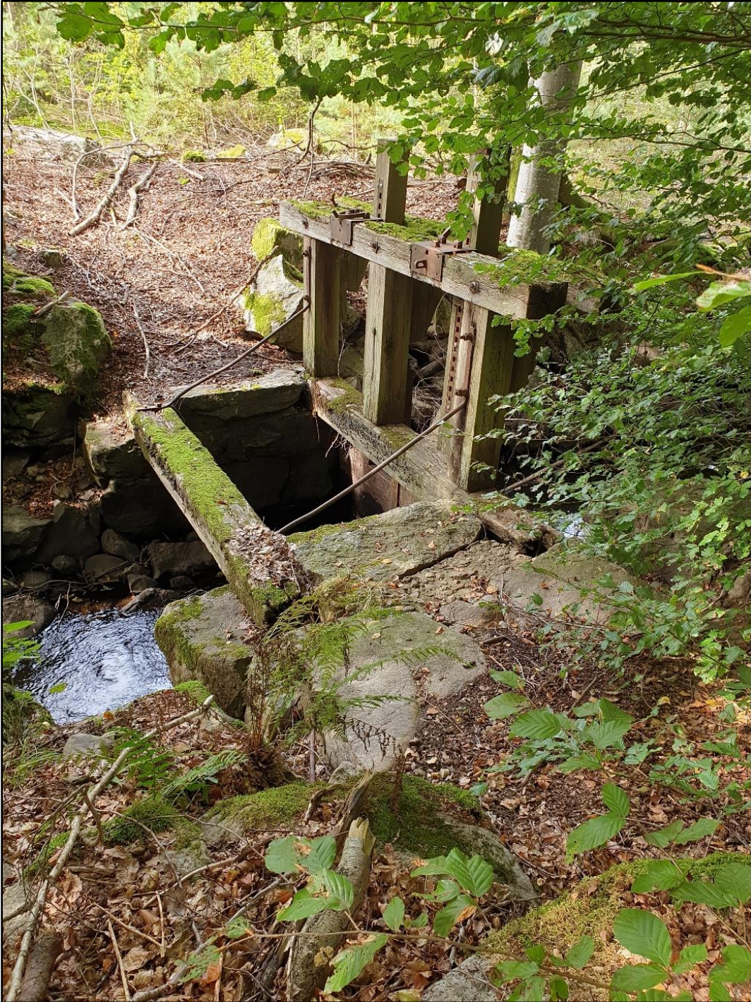
Bild 1. Flödet regleras med två spettluckor. Foto: Eva Eliasson
