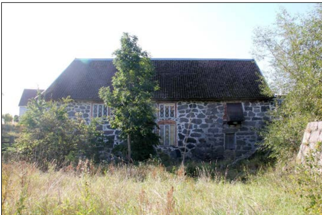
Bild 24. Kvarnbyggnadens norra sida där tidigare vattenhjul och sedan turbin fanns. Foto: Helena Lundgren
