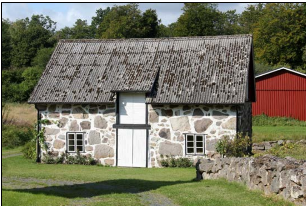
Bild 3. Kvarnen i närbild. Bilden tagen mot väster. Foto: Helena Lundgren
