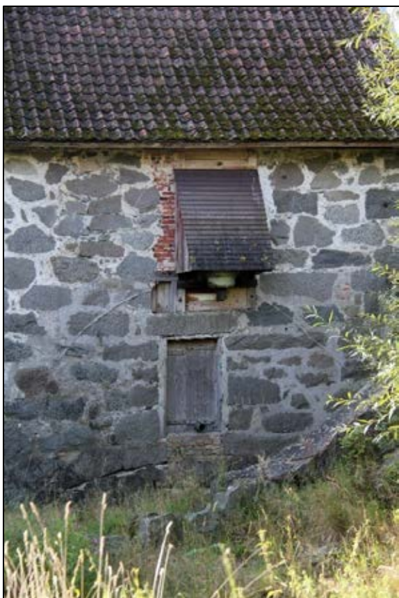
Bild 25. Här har tidigare vattenhjulet och sedan turbinen varit placerade. Bilden tagen mot söder. Foto: Helena Lundgren
