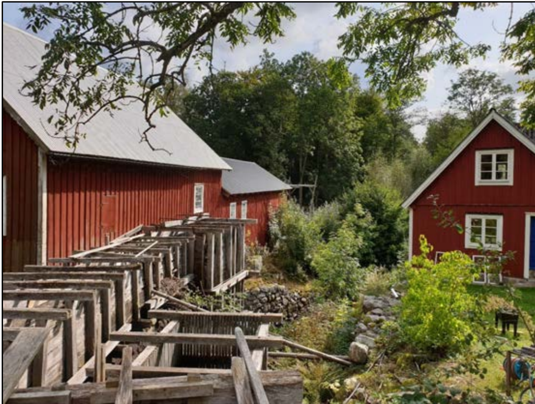
Bild 5. Träränna som leder vatten från dammen till turbinsumpen i den östra kvarnen. Foto: Eva Eliasson
