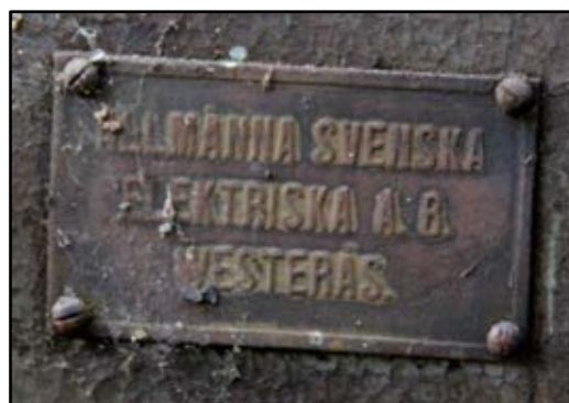
Bild 30, 31 och 32. Generatorns olika delar kommer från olika verkstäder och förmodligen även olika årtal, att döma av typsnitten: Luth & Roséns Elektriska Aktiebolag (1885–1968), Allmänna Svenska Elektriska A.B. (1883-1987) bytte namn till ASEA 1977 och SKF, Svenska Kullagerfabriken (1907-). Foto: Helena Lundgren.
