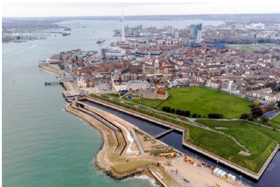
Konstruerade skydd mot översvämning. Portsmouth, England.
