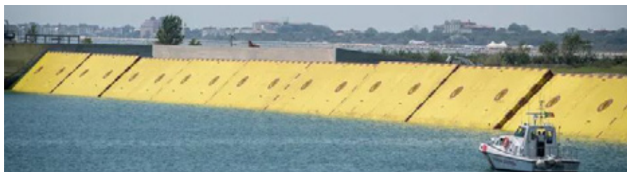
Tillfälligt uppfällda stormflodsportar utanför Venedig.
