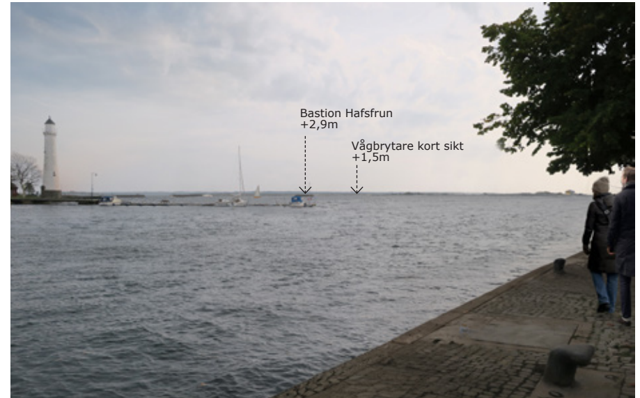
Vågbrytare med höjd cirka 1,5 meter.
