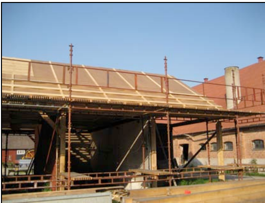
060927 Mellan svallet och pannplåten läggs masonit för att förhindra kondens
