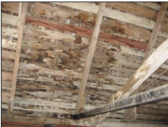
060913 Fuktskada på svallet på södra delen. Det beslutades att även denna del av taket skulle renoveras.
