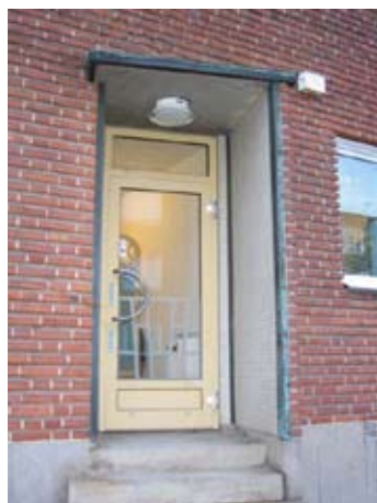
Entré mot Slättagårdsvägen
