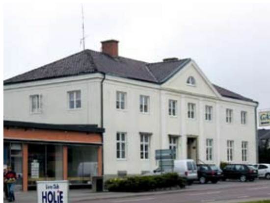
Före detta sparbankshuset
