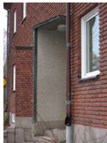
Entré mot Slättagårdsvägen
