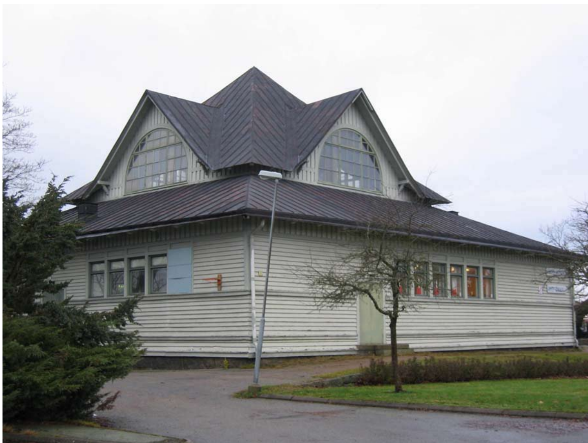
Byggnad från Malmöutställningen 1896
