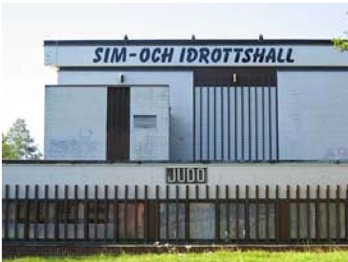
Sim- och idrottshall i Olofström från 60-talets början
