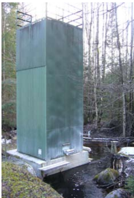
Spridning av kalk i vattendrag med hjälp av kalkdoserare. Foto: Roger Johnsson.
