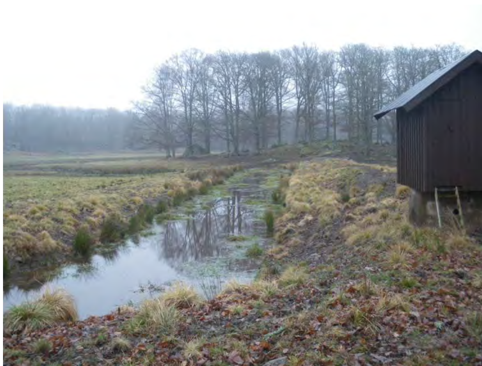
Figur 19. Eriksbergs invallningsföretag. Vy mot öster från det sydvästra hörnet, med dike, vall och pumphus
