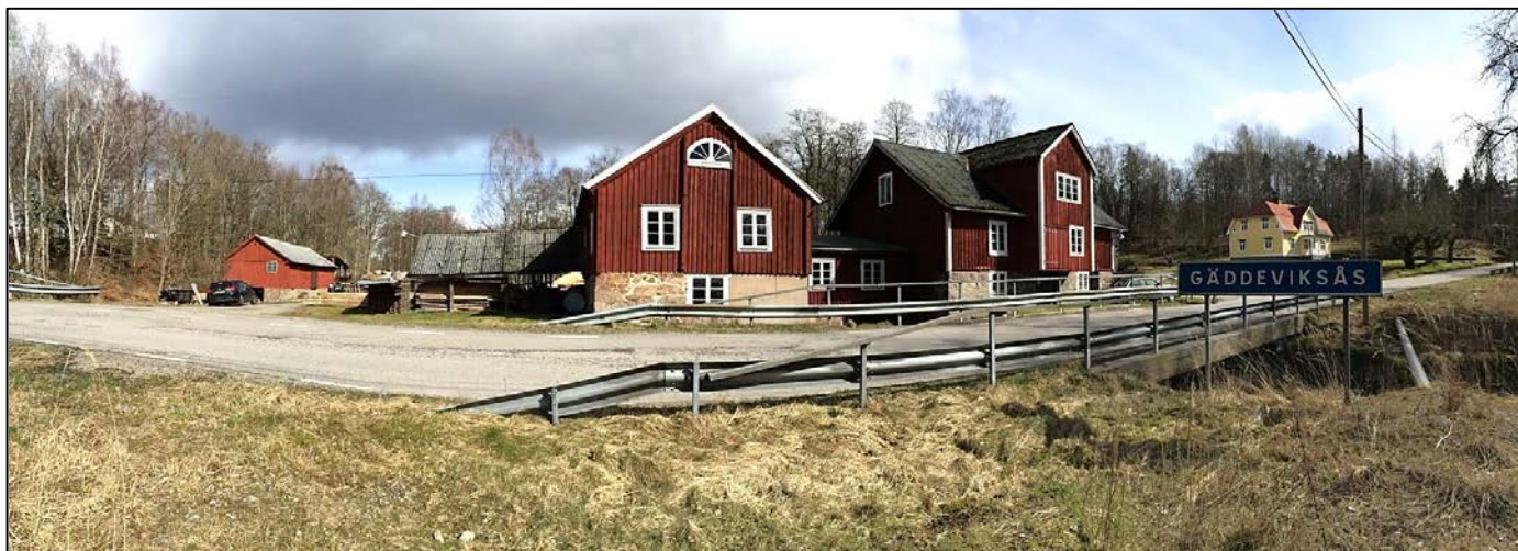
Bild 1. Från höger är Gäddeviksås kvarnbyggnad, därefter den sammanlänkande kraftverksbyggnaden, Midingsbråtes kvarn och längst till vänster den äldre sågverksbyggnaden.
