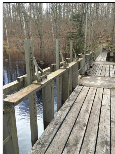
Bild 16 och 17. Den östra utskovsdammen uppförd 1910.
