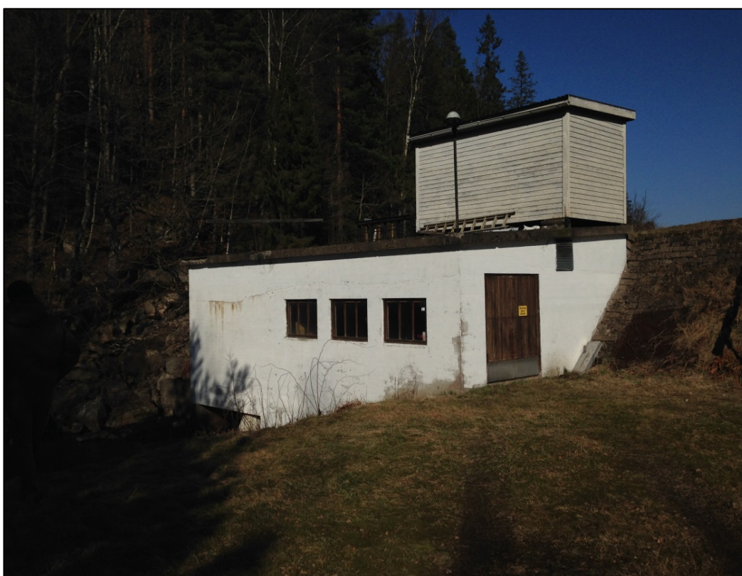
Bild 6. Kraftverket bakifrån. Den vita träbyggnaden ovanpå innehåller kombinerat kontor/maskinrum. Den mäktiga dammvallen syns till höger om kraftverket. Här syns också den kraftiga stenskoningen.
