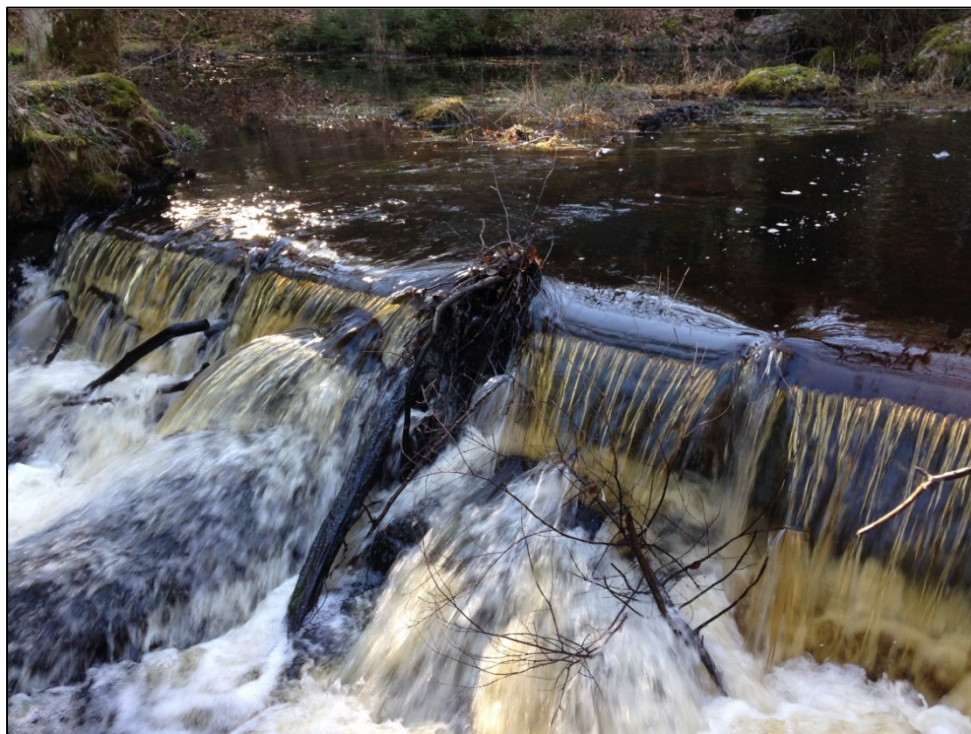
Bild 2. Närbild av öppningen i dammvallen.
