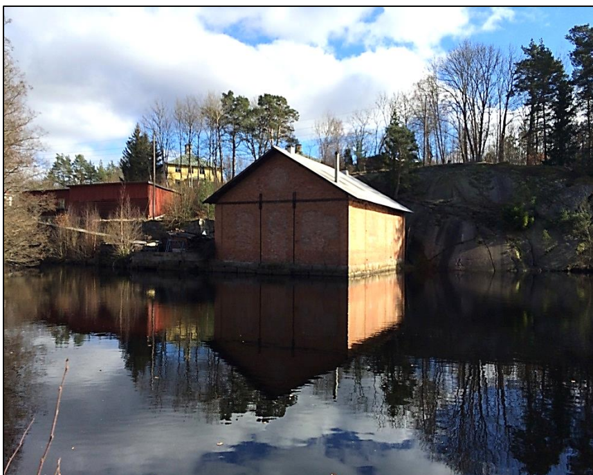
Bild 3. Asksmältan. Fönsterna är idag igenmurade. På samma sida vattendraget ska tidigare ha legat både smedja och stampverk.
