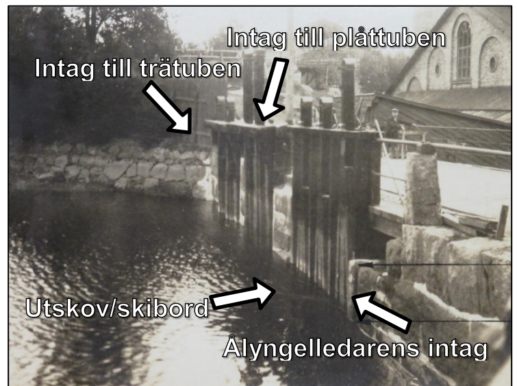
Historisk bild 6. Utskov och intag i den nedre dambyggnaden. Söderbygdens Vattendomstol 1923.
