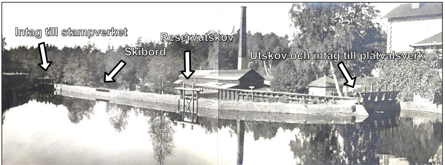
Historisk bild 3. Dammbyggnaden vid det övre bruket. I bakgrunden syns valsverksbyggnaden och kontorsbyggnaden. Söderbygdens vattendomstol 1923.
