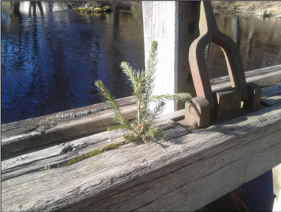
Bild 1. Detaljbild av spettluckan längst i öster. Underhållet har så pass stora brister att en liten gran slagit rot i luckan.
