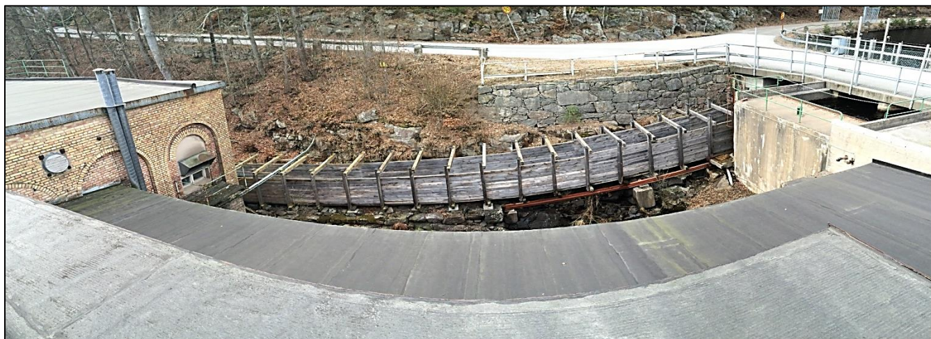
Bild 4. Hitom vattenrännan satt tidigare en trätub som försåg kraftverket med energi.
