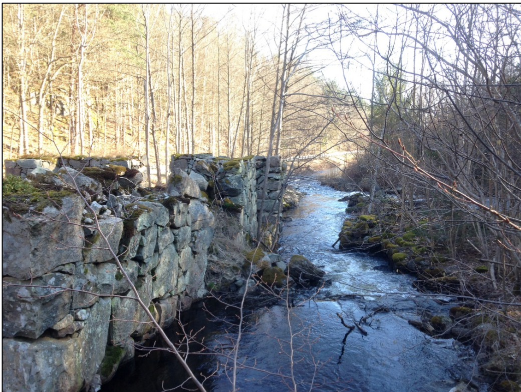
Bild 5. Berggrens smedja med vattenvägen. En del av murverket har raserats och fallit ut i ån. Röjningsåtgärder har vidtagits vid ruinen inte allt för länge sedan.
