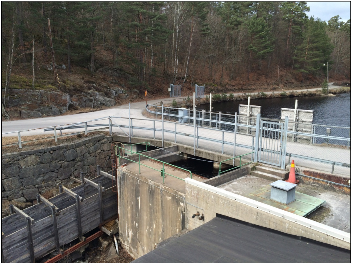
Bild 5. Skalmursdammen vid Granefors nedre bruk är uppförd år 1890 med två intag och ett utskov.
