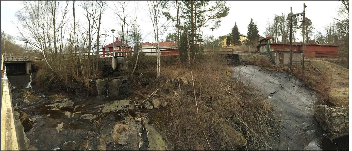
Bild 5. Dambyggnad vid övre bruket från nedströmssidan.
