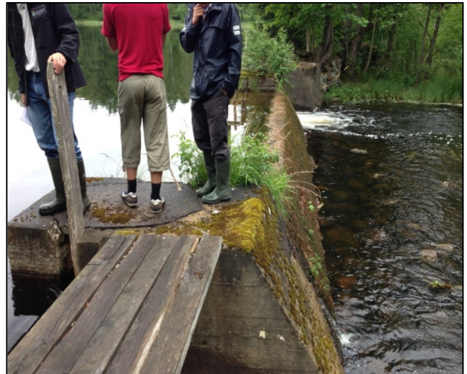
Bild 13. Före utrivningen av dammkroppens skibord.
