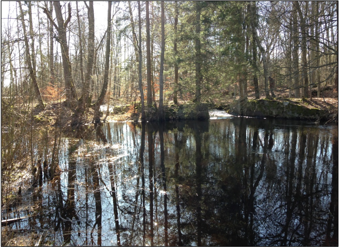
Bild 3. Översiktsbild av dammvallen norrifrån.
