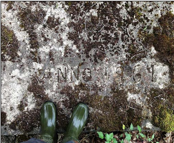
Bild 12. Dambyggnaden renoverades sista gången 1964.
