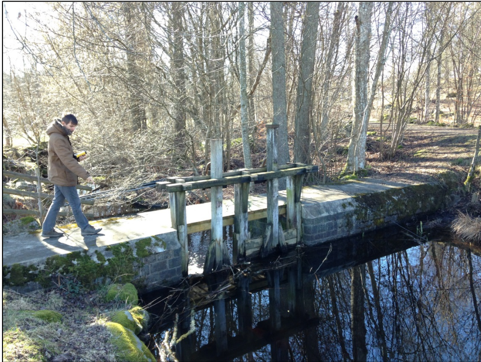
Bild 7. Dammvallen i vikens östra del. Den huggna stenen tyder på tidigast andra halvan av 1800-talet. Troligen rör det sig dock om 1900-talets första hälft.
