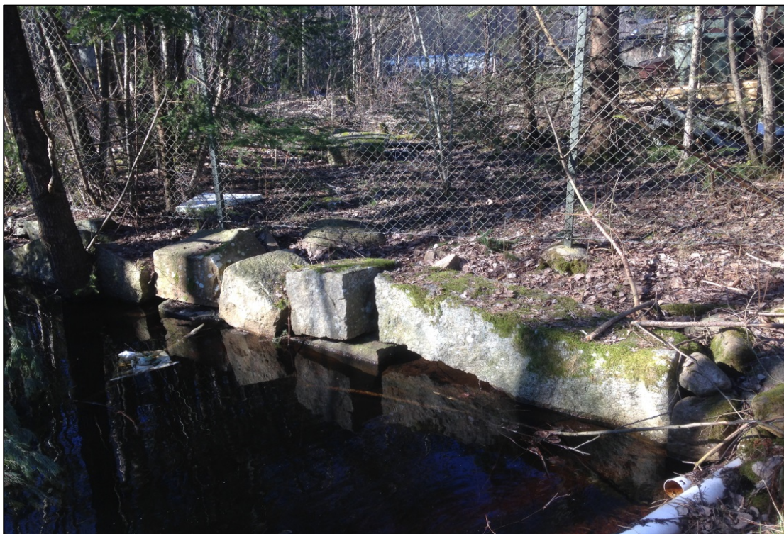
Bild 2. Den gamla åfåran genom sågen är nu igenfylld. Där den mynnar är den igenlagd med stora huggna stenblock.
