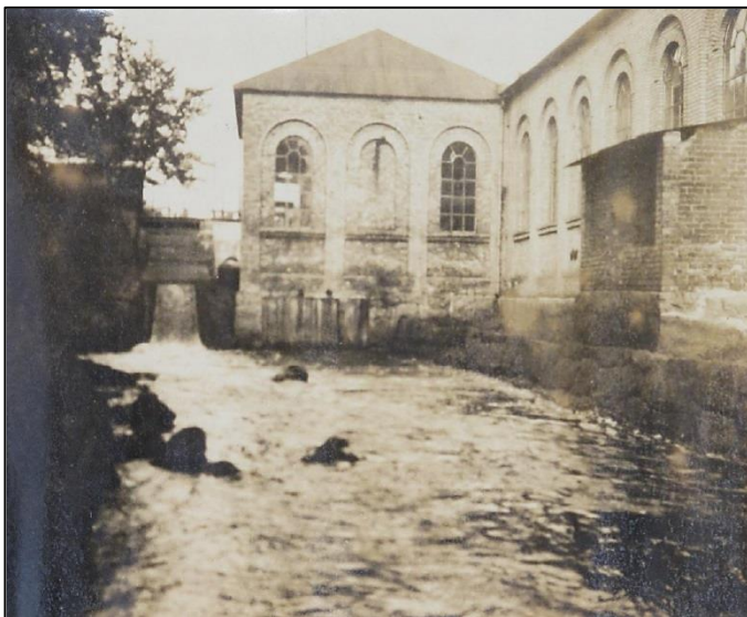
Historisk bild 3. Kraftstationen vid Granefors nedre bruk. Söderbygdens Vattendomstol 1923.
