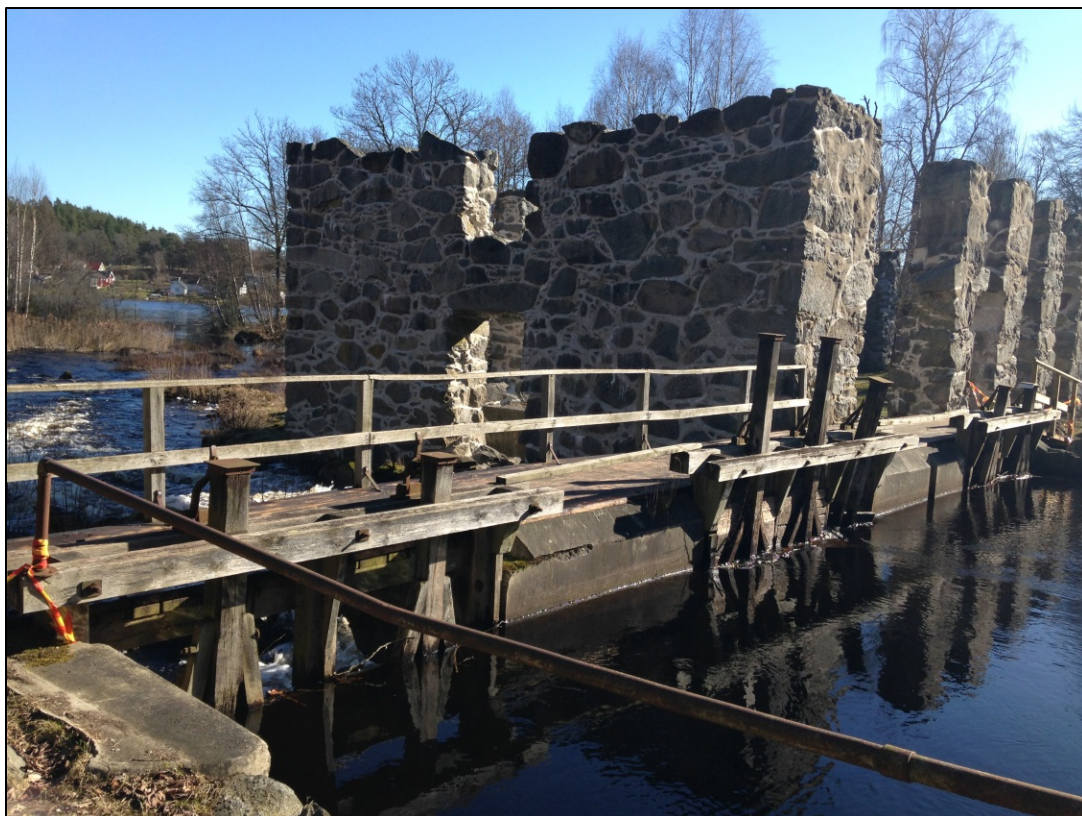
Bild 5. Bild på dammvallen med dess utskov. Som synes är det en skillnad i vattennivå på ömse sidor dammvallen.
