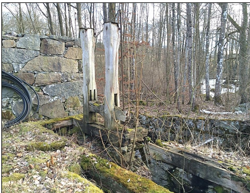
Bild 8. Trädelar finns bevarade från kvarnverket. I graven närmast stod stjärnhjulet – en av kvarnens mest vitala delar.
