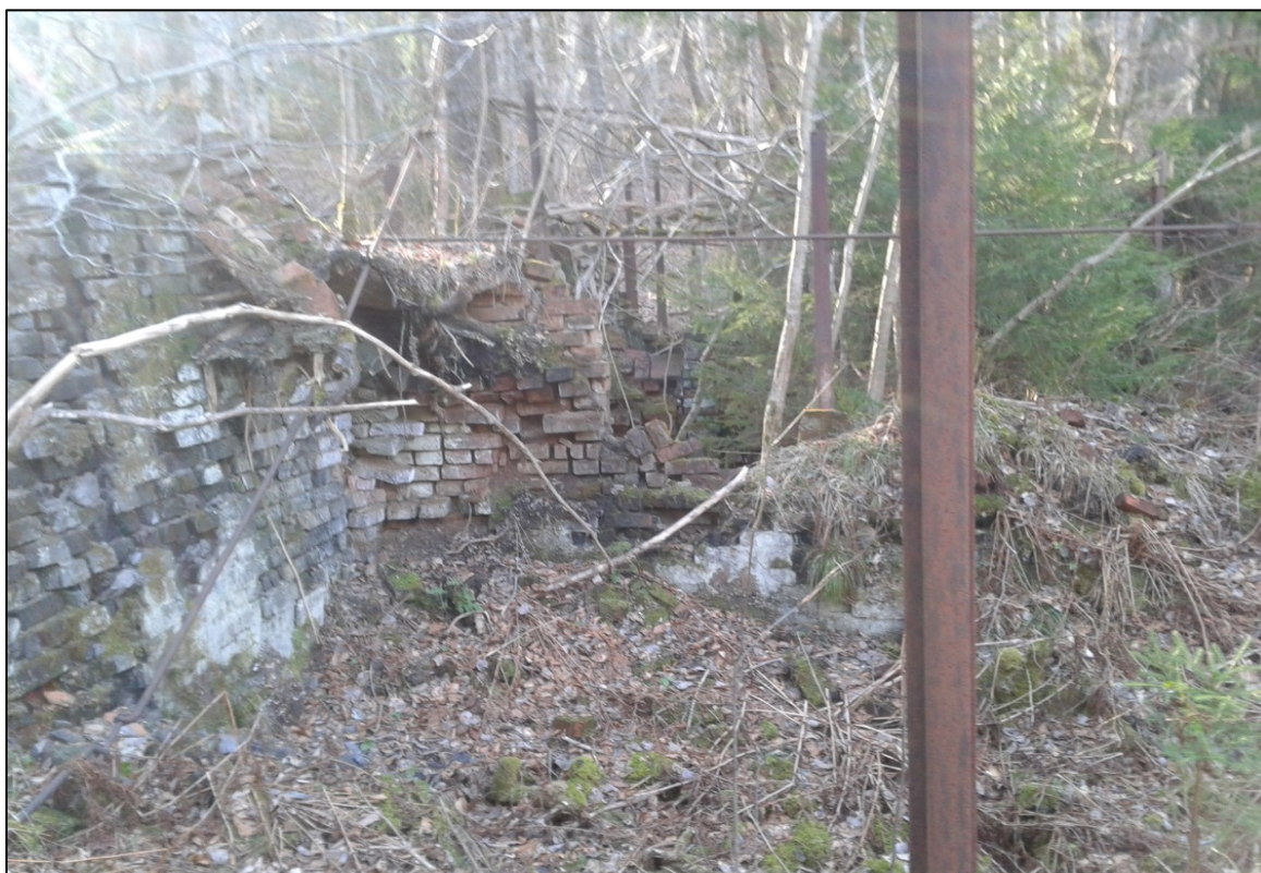
Bild 2. Lämningarna av kolningsugnarna är i ett rätt dåligt skick.
