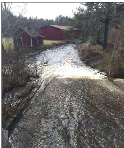
Bild 5. Det mellersta utskovet regleras med ett skibord.
