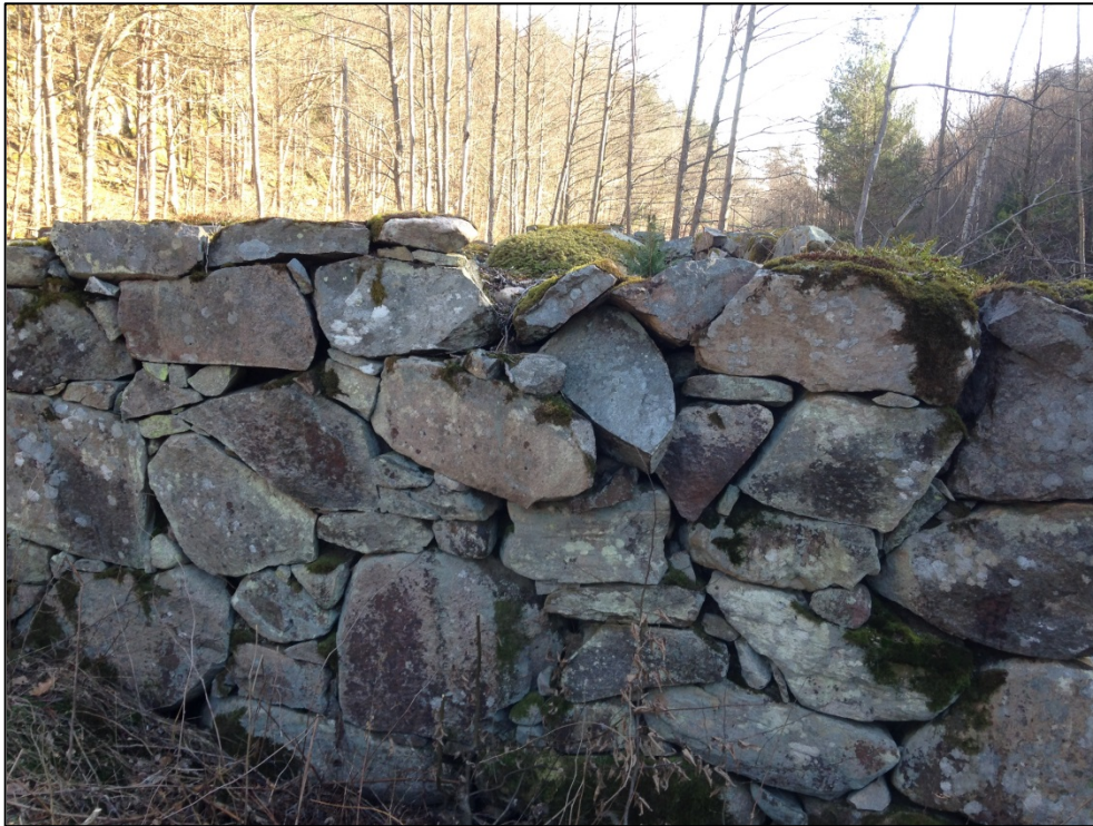
Bild 6. Närbild på murverket. Mindre stenar har skolats in bland de större. Dock inga spår efter murbruk.
