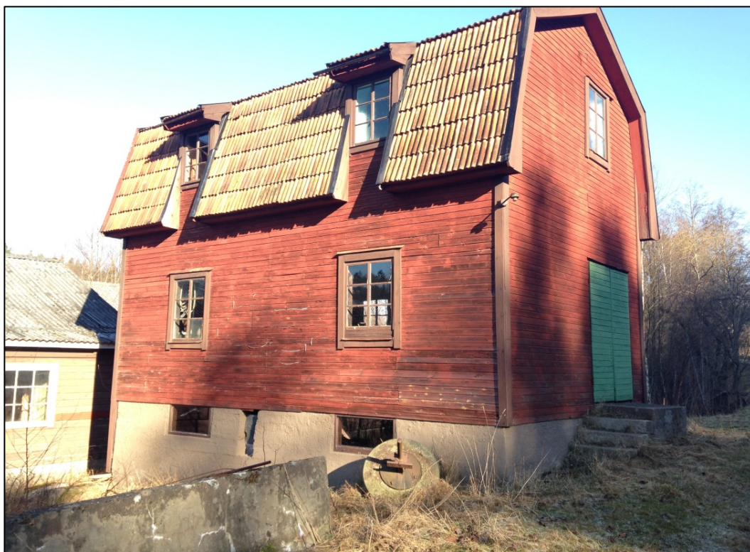
Bild 2. Dalfors kvarn byggdes 1928 utan lov inuti en befintlig kvarn som sedan revs.
