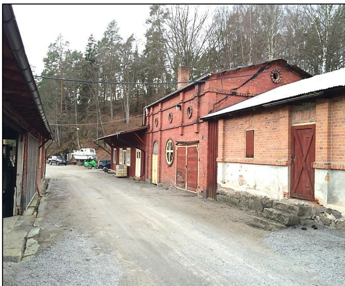
Bild 2. Bruksgatan. Gasverksbyggnaden intill snickeriet.
