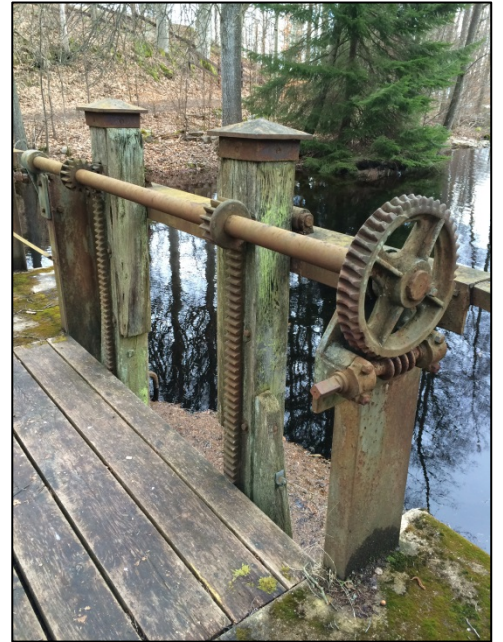
Bild 14. Det östra utskovet i den västra utskovsdammen regleras med spel och vevanordning avsedd för flottning.
