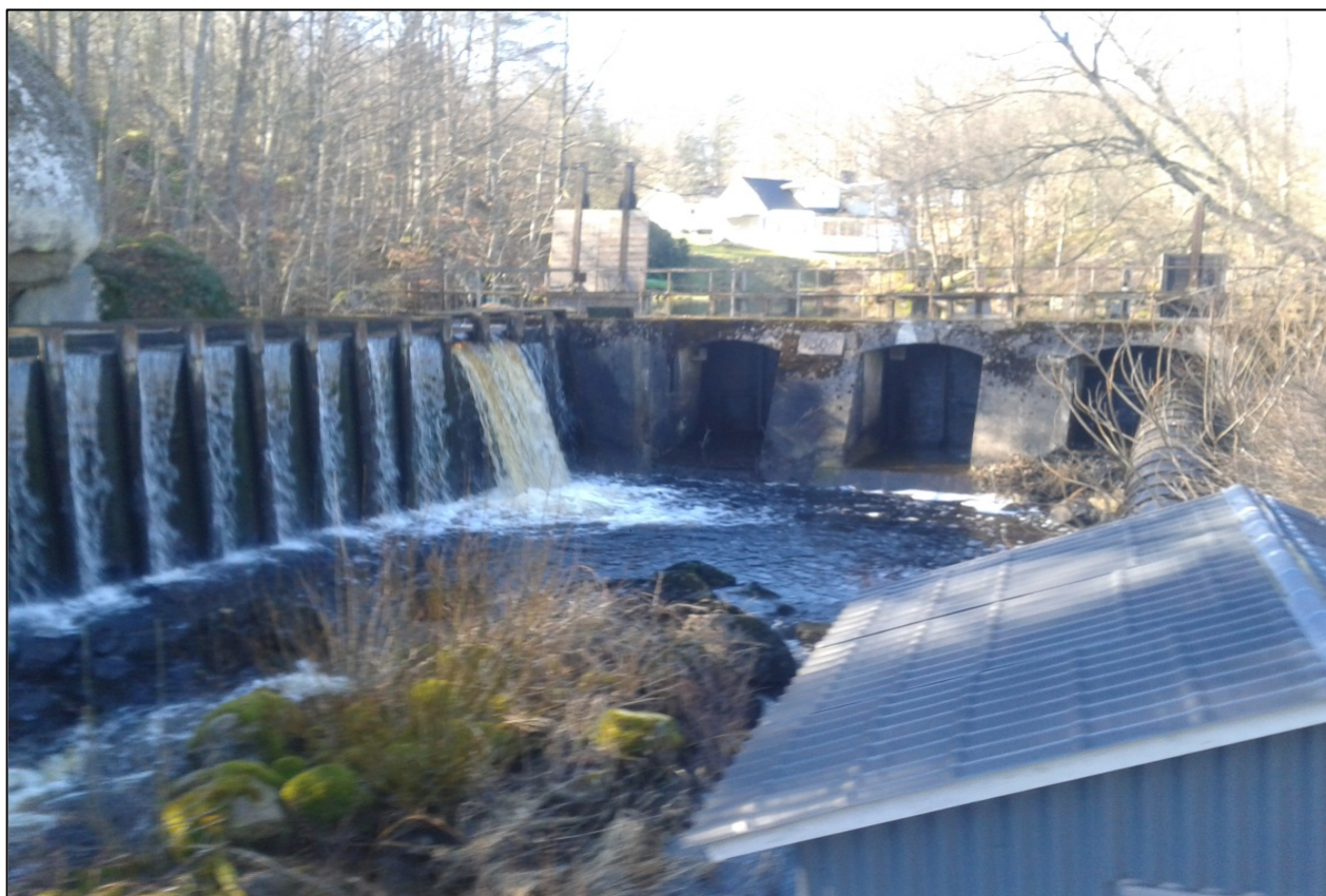
Bild 5. Dammvallen från 1904 är välbevarad. Förutom att utgöra en värdefull kulturmiljö är den dessvärre också ett vandringhinder för fisk och andra vattenlevande organismer.
