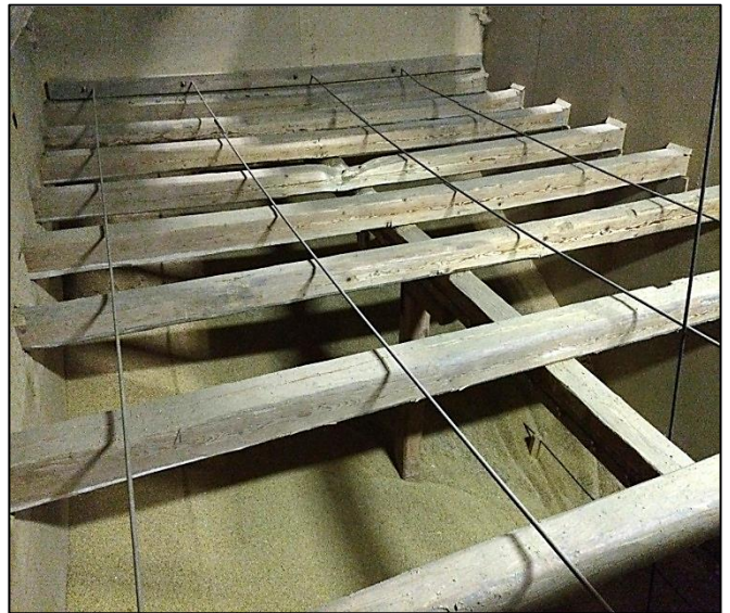
Bild 7. Spannmålslager i tröskverksbyggnaden.
