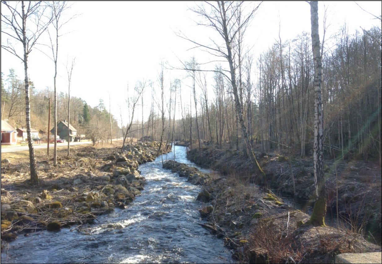
Bild 4. Huvudfåran till vänster och utloppskanalen till kraftverket till höger.
