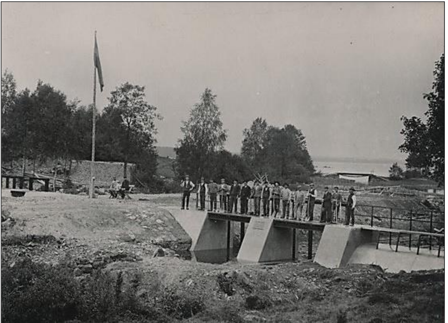
Historisk bild 5. Dammbyggnaderna vid Gäddeviksås och Midingsbråte kvarnar står färdiga år 1911. Fotografiet ägs av Rune Nilsson.
