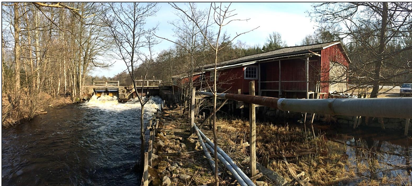
Bild 1. Panoramavvy över Jeppshoka Såg och dammkropp. I förgrunden syns stenkistan.
