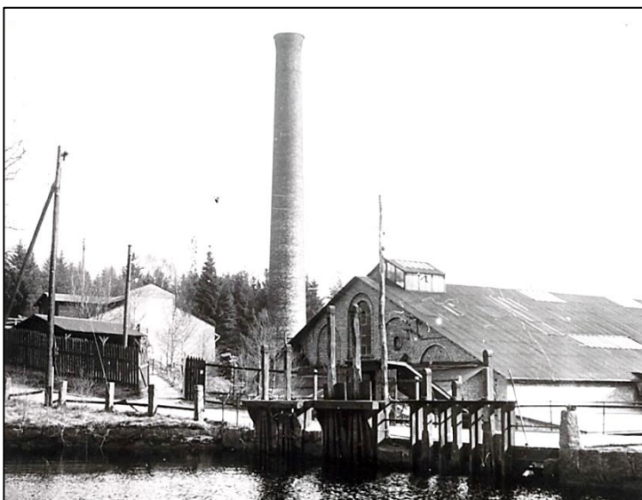
Historisk bild 5. Tidigare reglerades dambyggnaden med spettluckor i trä. Fotografiet ägs av Karlshamns kommun.
