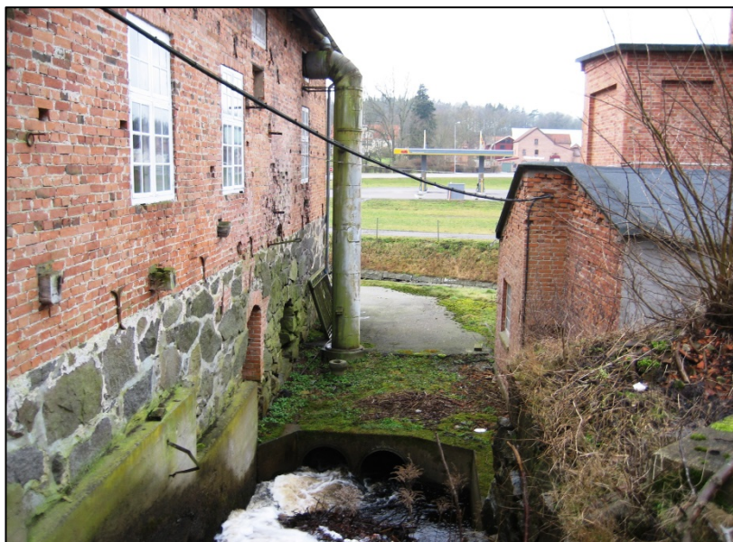
Bild 13. Kraftverksbyggnaden och den kulverterade hjulgraven intill kvarnbyggnaden. Foto Petra Stråkendal 2009.
