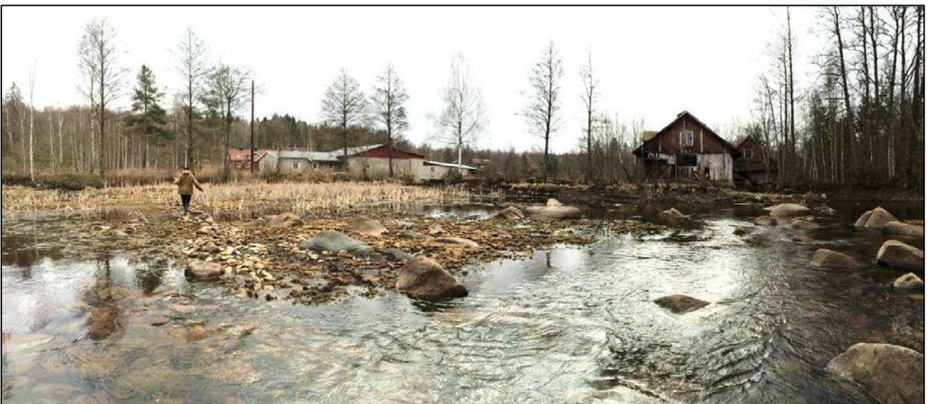
Bild 4. Vy mot Hakafors sågverksbyggnad och de modernare industribyggnaderna i området.
