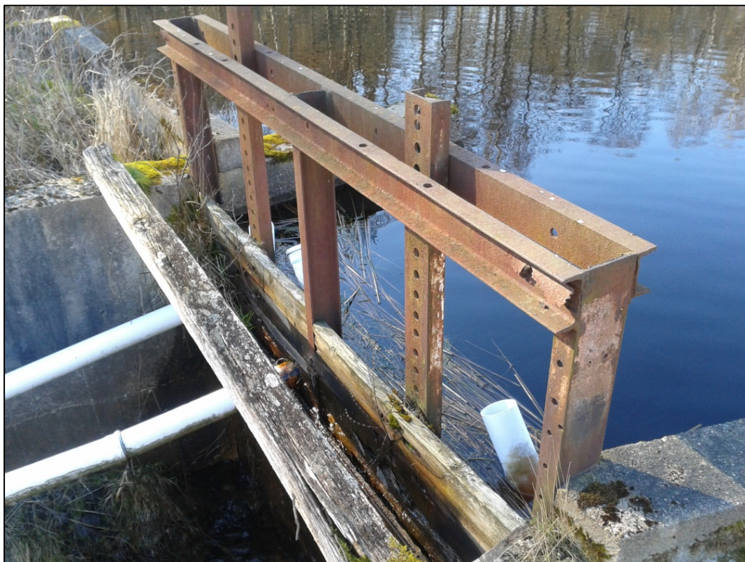
Bild 4. Närbild på intaget med två luckor.
