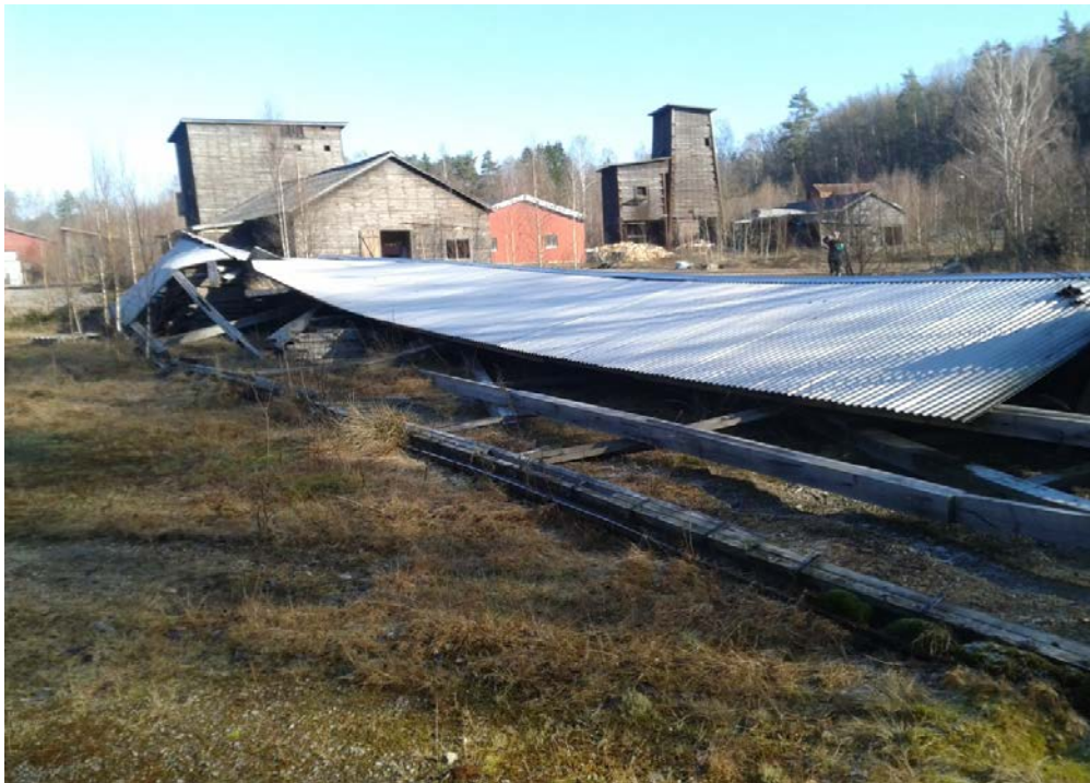
Bild 4. Översiktsbild från sydväst. I förgrunden ligger det raserade virkesskjulet. Precis bakom ligger hyvleriet med kutterspånsförrådet. Till vänster i bildens kant skymtas ett modernt magasin. Precis till höger om hyvleriet ligger ett magasin i röd plåt. Till höger om detta syns sågverket med sina torn. Bakom sågverket skymtar taket på kvarnen.
