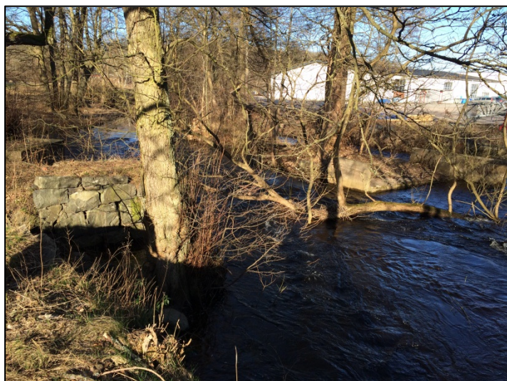
Bild 1. Dammfästen och betongskoningar är några få beståndsdelar som är bevarade vid Store mölla.
