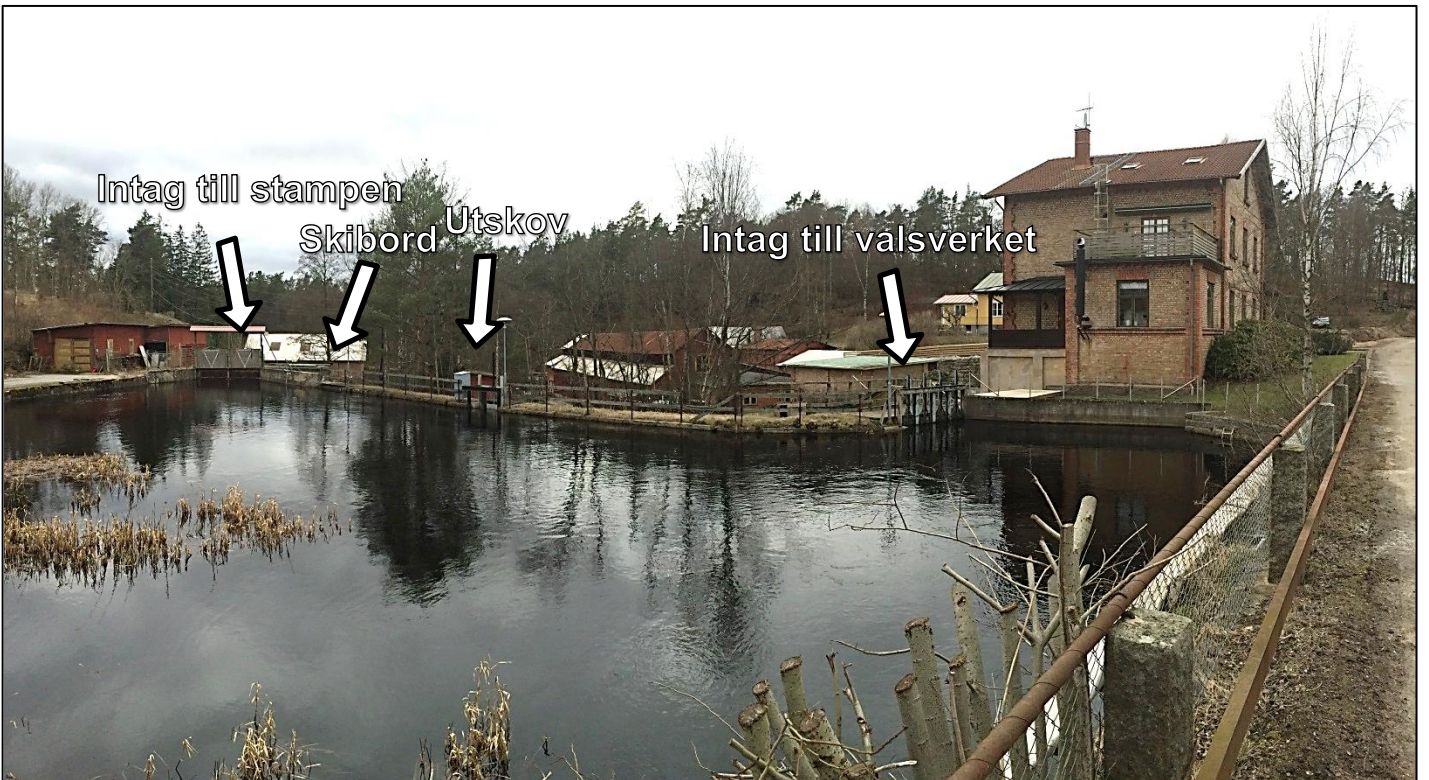
Bild 6. Dambyggnad vid övre bruket vid uppströmssidan.
