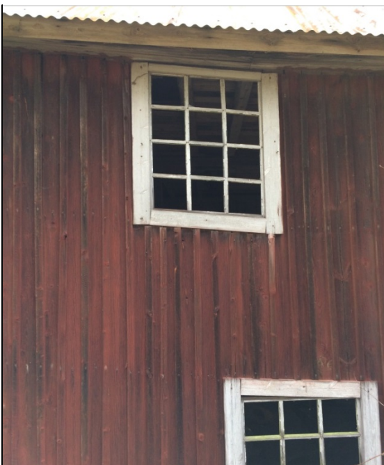
Bild 8. Småspröjsade enluftsfönster i den västra fasaden.
