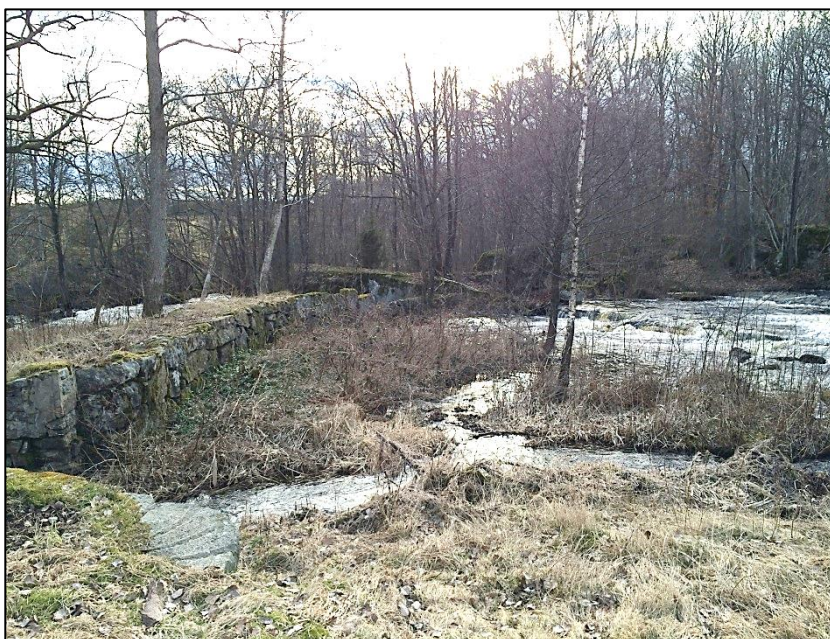
Bild 9. Dammbyggnaden vid Tararps kvarn löper tvärs över Mieån. Utskoven är dock utrivna.
