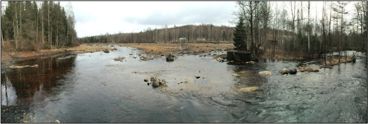
Bild 5. Vy över Hakafors damms utseende efter utrivningen.
