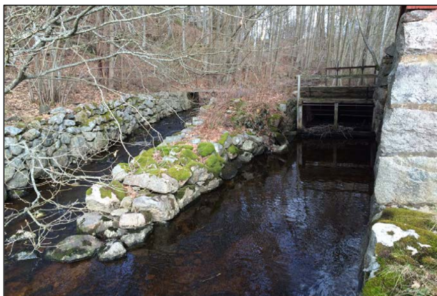
Bild 11. Den västra åfåran vid den äldre sågverksbyggnaden är stenskodd med hjulgrav och dammkropp. T.h. syns ålkistan.
