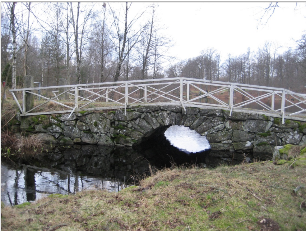
Bild 10. En vacker stenvalvsbro. Liggande mellan den östra dammvallen och viken. Foto: Petra Torebrink
