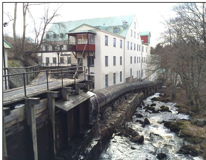
Bild 2. Trätuben till kraftverket. I bakgrunden är den äldre spinneribyggnaden.
