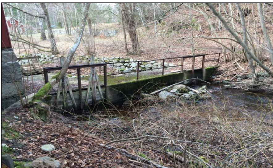
Bild 12. Utskovsdammen vid den äldre sågverksbyggnaden. Med intag till ålkista.
