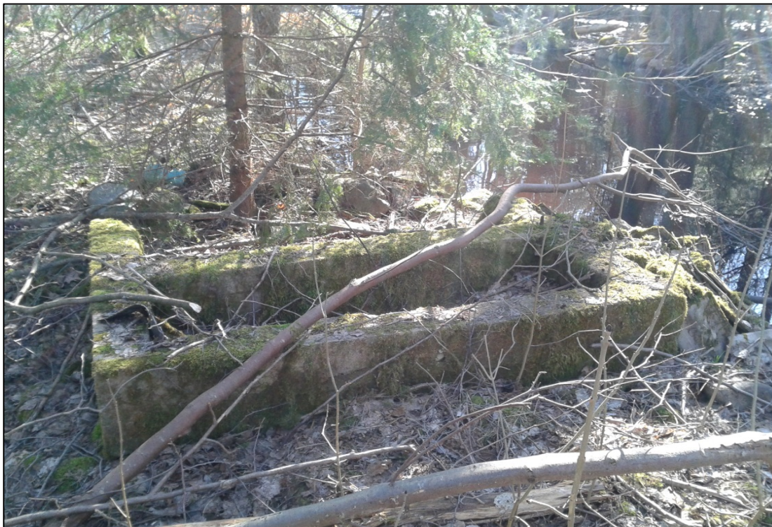
Bild 1. Grund efter en liten anläggning söder om inhägnaden, invid Mieåns östra strandkant. Troligen efter ett pumphus eller annat litet verk. Av cement ca 2 x 1,5 meter stor.
