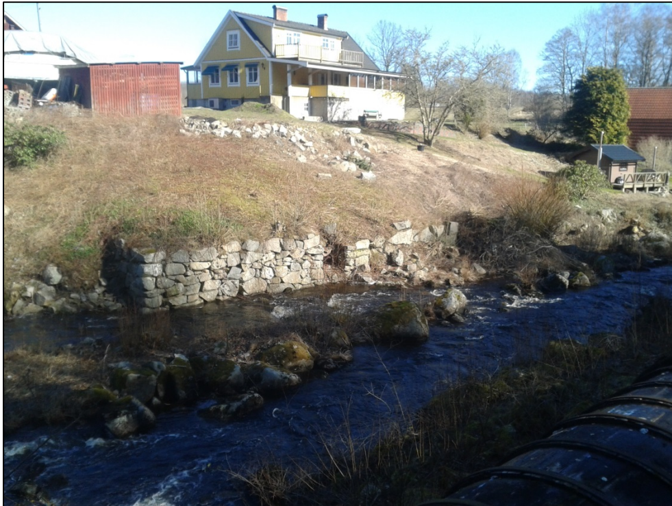
Bild 3. Troligen har det legat ännu en kvarn här, mitt emot kraftverket. Hålet i stenskoningen skulle kunna vara ett hål för en axel. Framför grunden går en ränna, som är fortsättningen på rännan till kvarnen som legat längre västerut.
