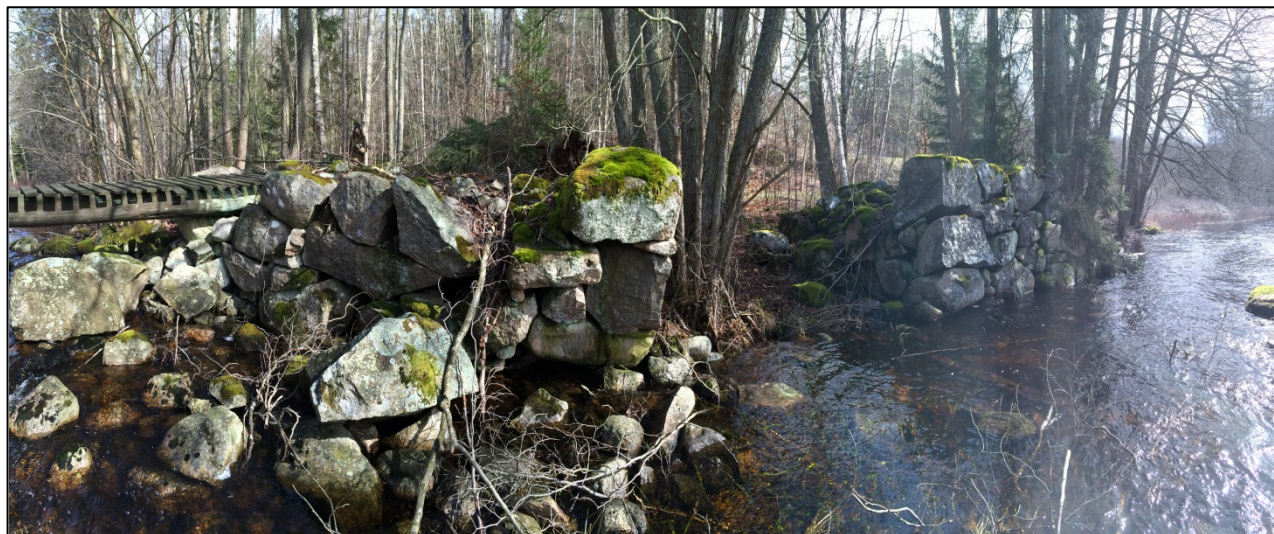
Bild 1. Vy över byggnadslämningen vid Agdasågen. T.v. syns även delar dammkroppen som rasat ut i vattnet.
