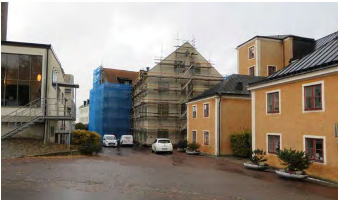
Marinens centrala beklädnadsverkstad sedd från norr och inklädd i byggnadsställningar hösten 2016. Byggnaden, som bland annat innehöll en skofabrik, är sedan 1990-talet ombyggd till lägenheter. I förgrunden till höger Kronobageriet.
