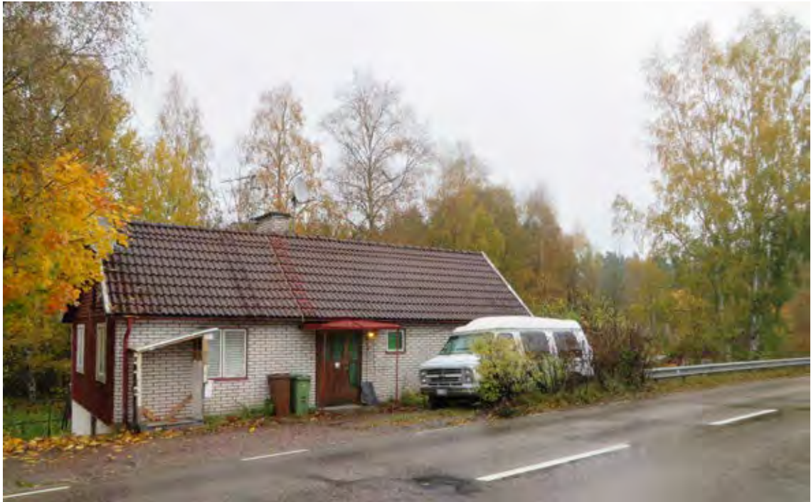
Bostadshuset som idag ligger på garveri/snickeritomten har gamla anor men har genomgått många förändringar under andra hälften av 1900-talet.
