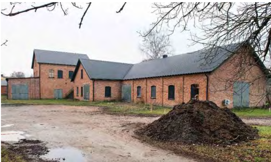
Så sent som 2015 fanns fabriksbyggnaden kvar, innan man rev och började bygga den nya skolan på tomten. Foto: Mattias Mattisson, Sydöstran.
