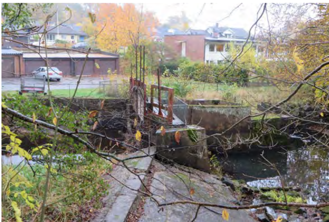
Del av dammen och dammluckorna.
