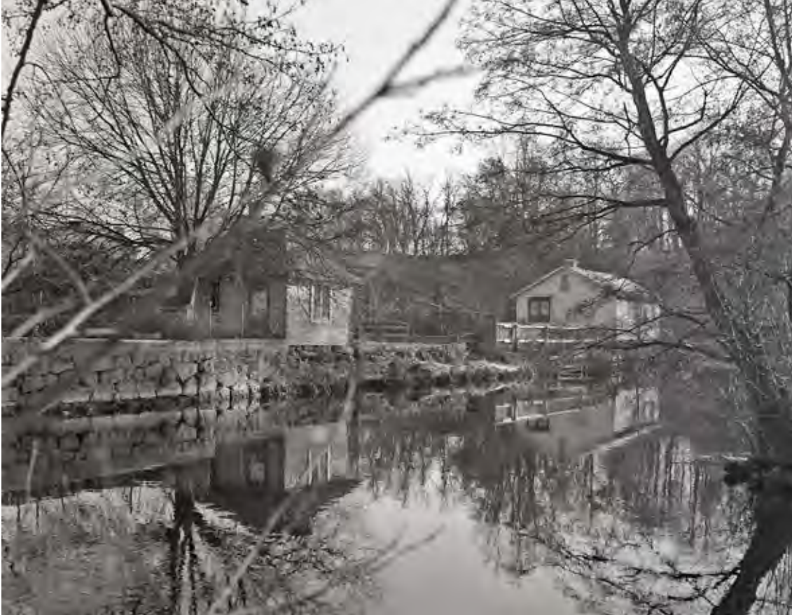
Lusthuset tillhör (No 7) Rosengatan 7. Tomten därefter innan planket är (No 8) Rosengatan 5. Fotot taget 19-11-1956. Foto: Kallinge museum.
