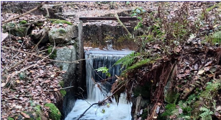
Figur 7: Den första regleringsluckan vid dammen innan kraftverket som utgjorde ett
