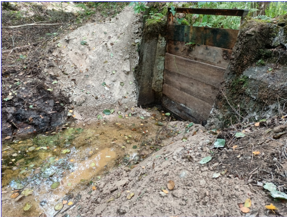
Figur 3: Vattenföringen från Sågdammen till nästa regleringslucka innan kvarndammen var vid karteringstillfället minimal och denna lucka var också nästintill helt stängd.
