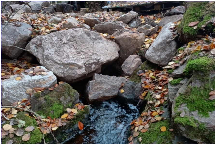
Figur 5: I samband med ombyggnation har block lagts över och i fåran.
