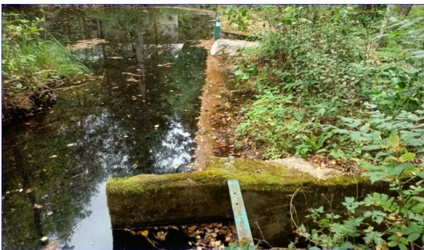
Figur 8: Dämningen till sågdammen har två utlopp/luckor som utgjorde definitiva hinder
