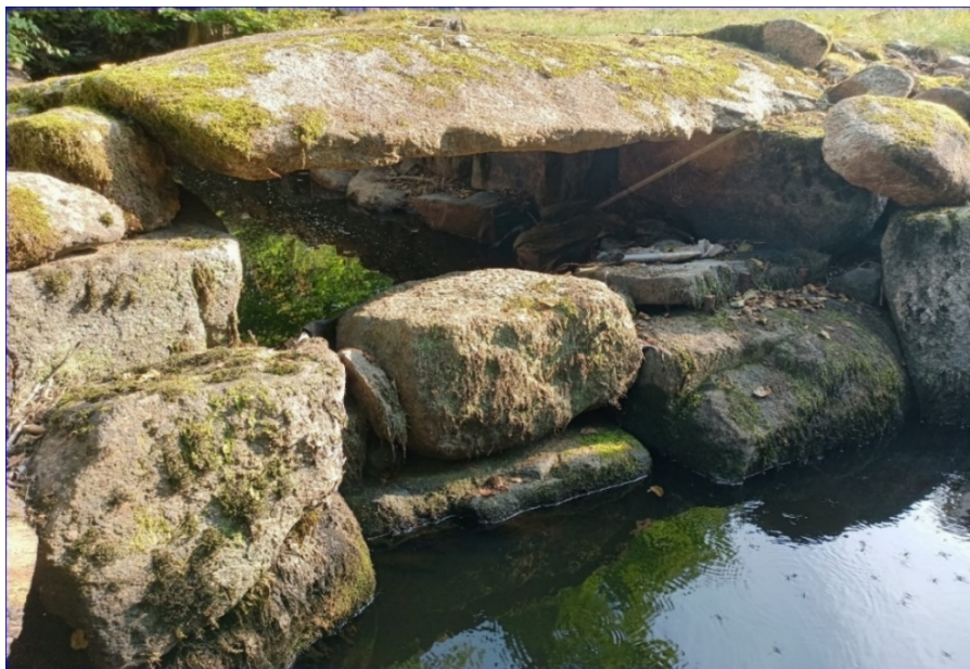
Figur 17: Dämmande block har lagts i vattendraget.
