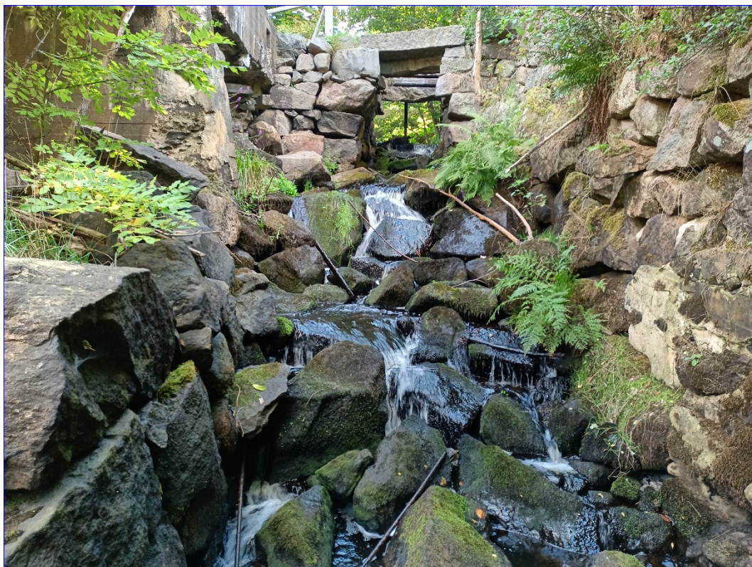
Figur 15: Fåran upp till utloppet där dammluckorna tidigare varit belägna saknar pooler och eventuellt hade mindre justeringar med omfördelning av block och sten kunnat möjliggöra en passage för öring.
